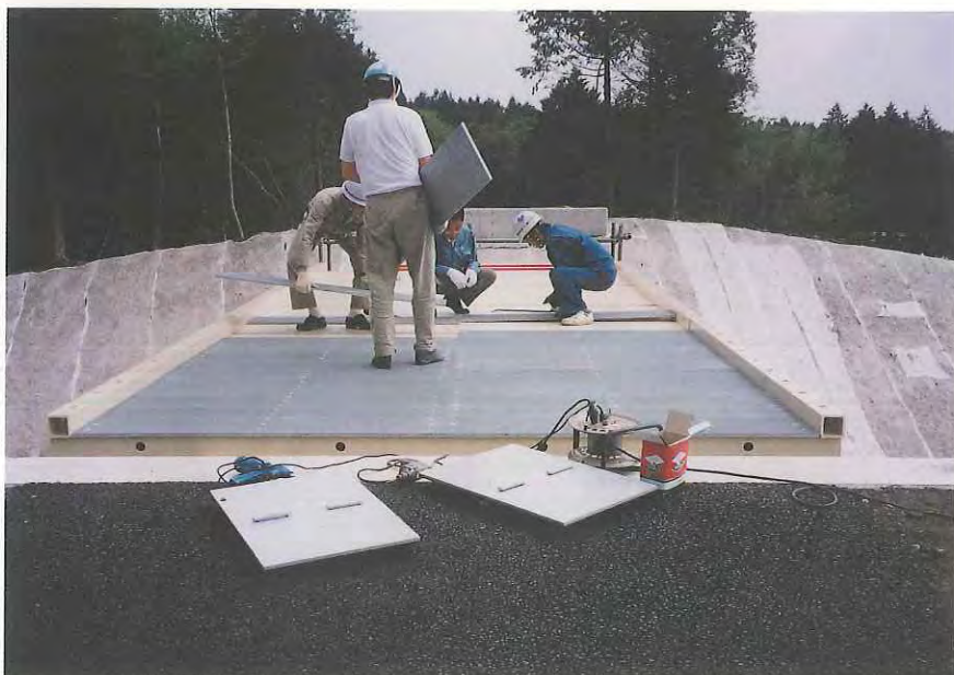
滑り止め板 敷設
