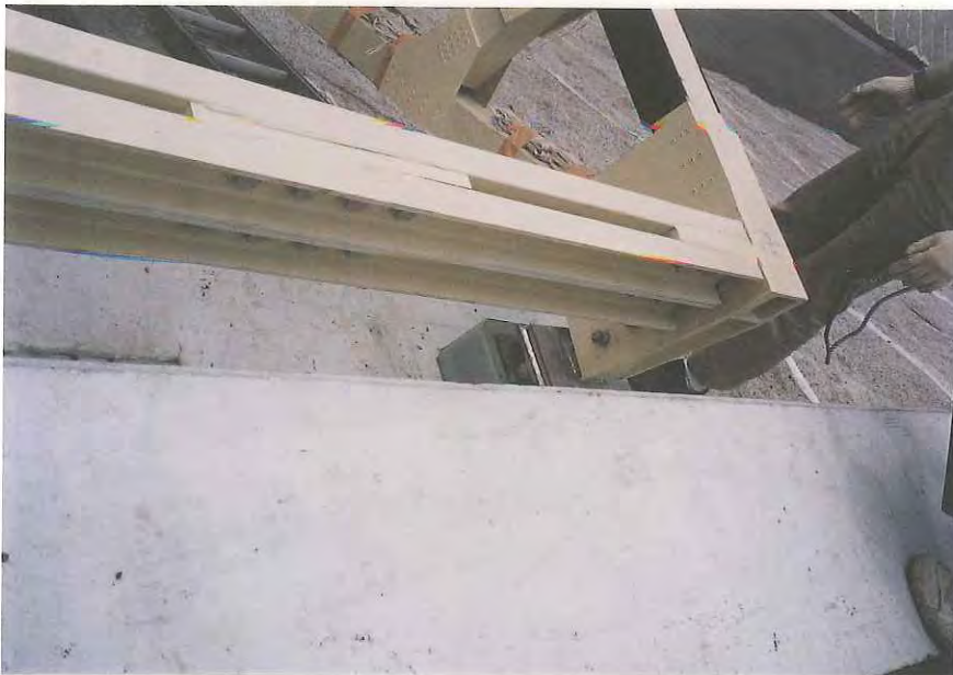
主構 橋台側支承部
