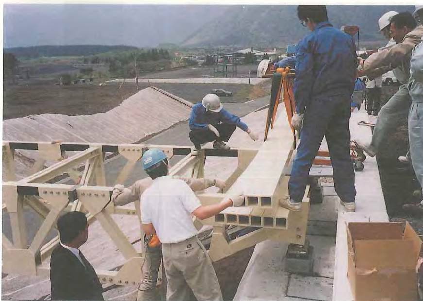
主構 ハンドリフト による敷設
