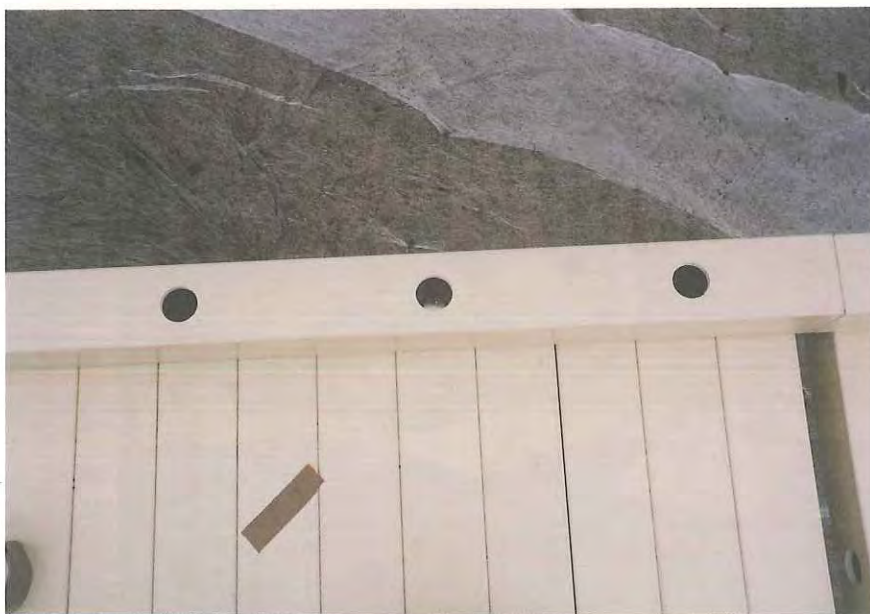
床版 地覆を上から 観る
