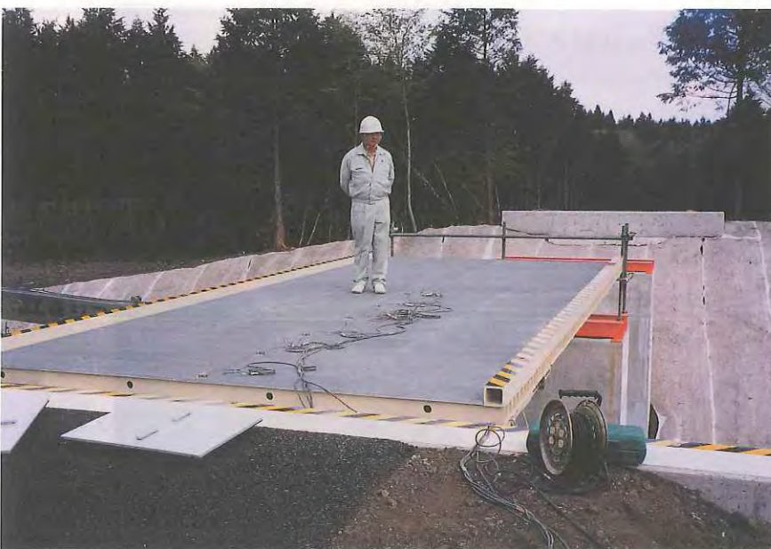
応急橋架設終了
