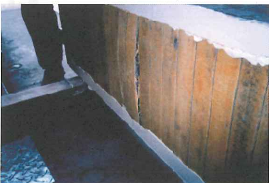
写真—6.4.6 超軽量モルタル充填（下面）
