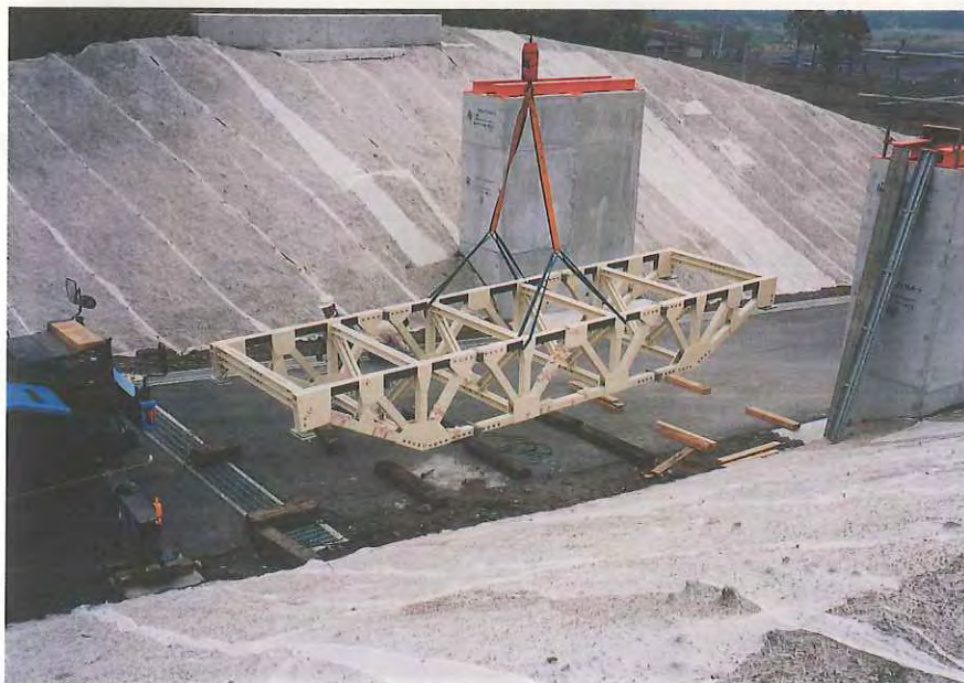
主構 吊り上げ
