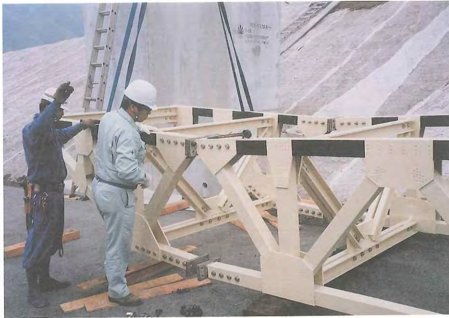
主構 クレーンによ る組立て
