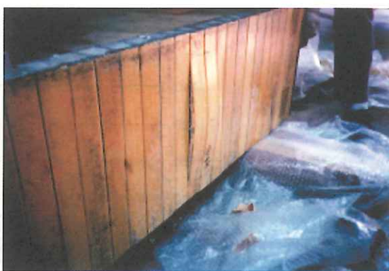
写真—6.4.4 普通モルタル充填（下面）
