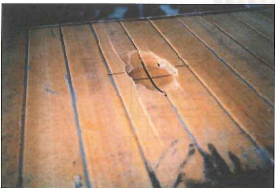
写真—6.4.5 超軽量モルタル充填（上面）
