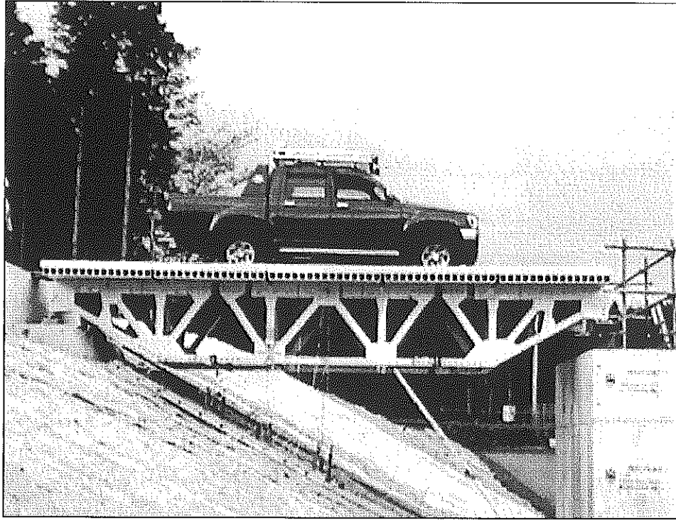
(a) 応急車道橋全景
