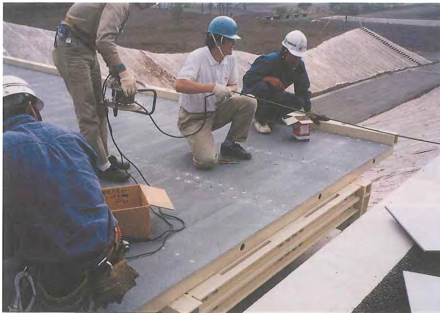
滑り止め板 リベットによる固定
