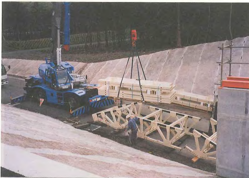
床版 荷降ろし
