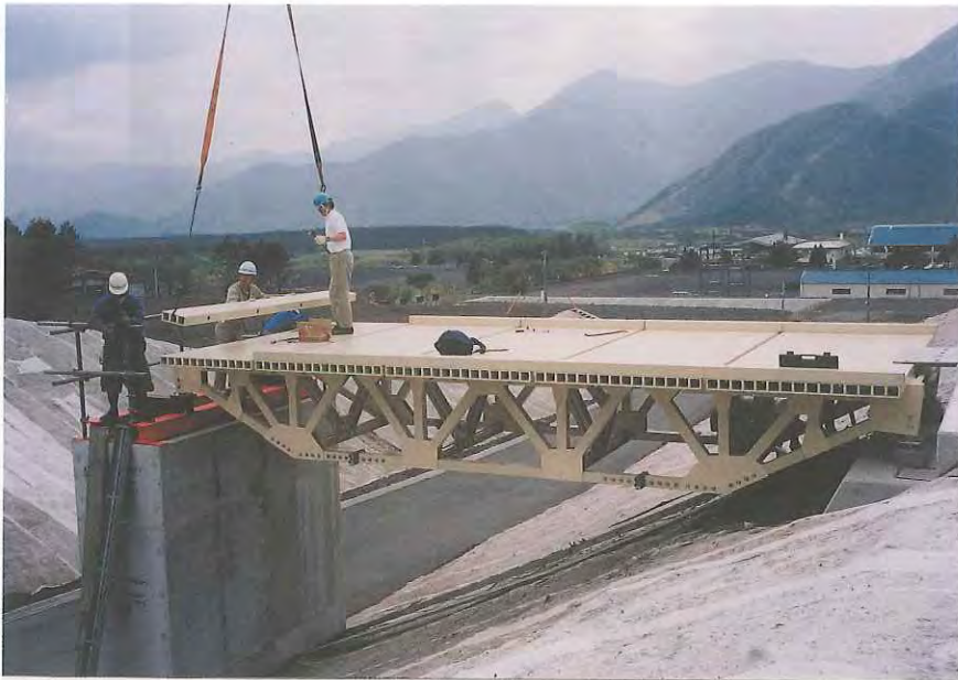
床版 クレーンによる 敷設
