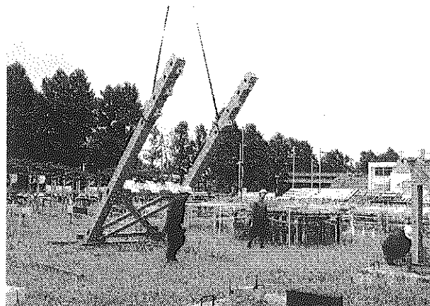
解体作業 (タワー)
