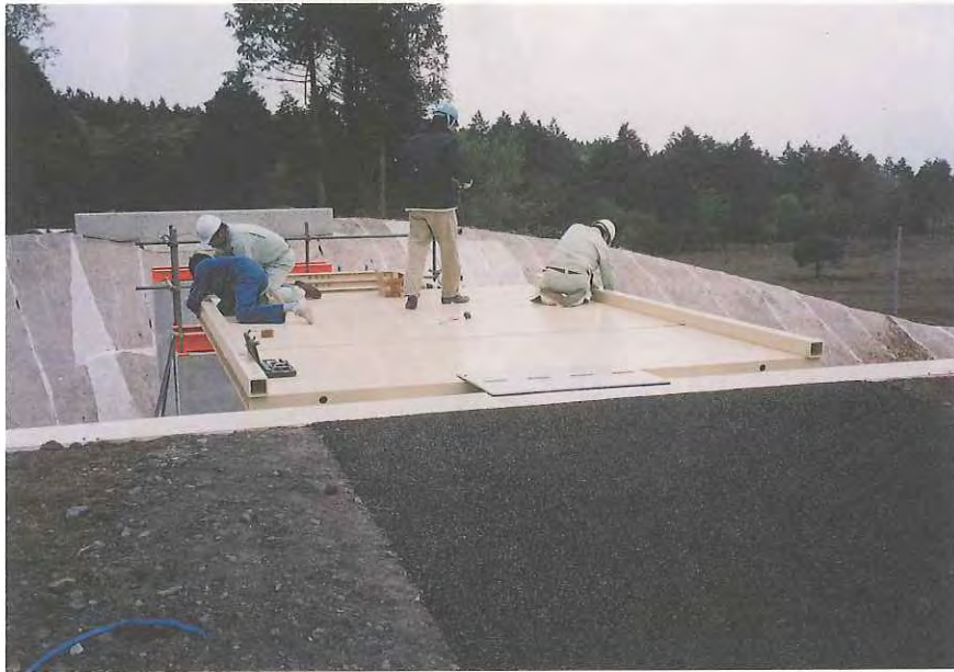
床版 地覆取付け
