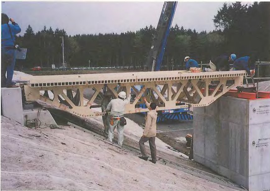
床版 敷設終了
