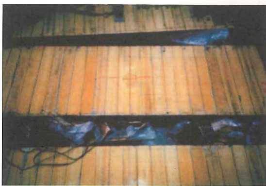
写真—6.4.3 普通モルタル充填（上面）
