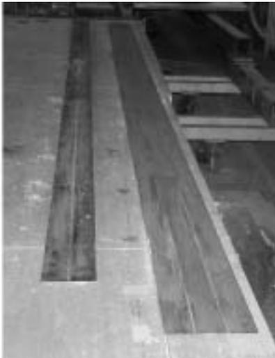
図 3.1.5 フランジ部の CFRP + GFRP の接着
