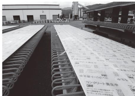
付写真-11 保水養生テープを用いた封緘養生
