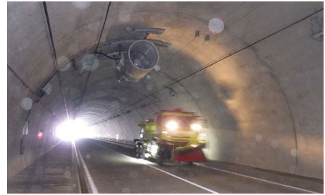
写真 3-3 重量物運搬車通行状況
