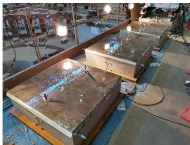
下地材の塗布
