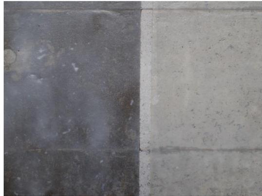
図-1 コンクリート表面への透明塗料の塗装に伴う暗色化の事例（左）
