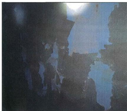
解説 写真-3.2.1 気体の水分（水蒸気）の結露が要因となり発生した塗膜の剥離〔被〕
