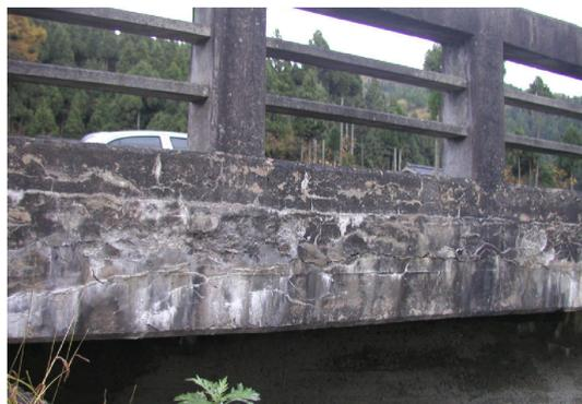
解説 写真-2.2.4 雨掛かりのある箇所でのアルカリシリカ反応による劣化事例
