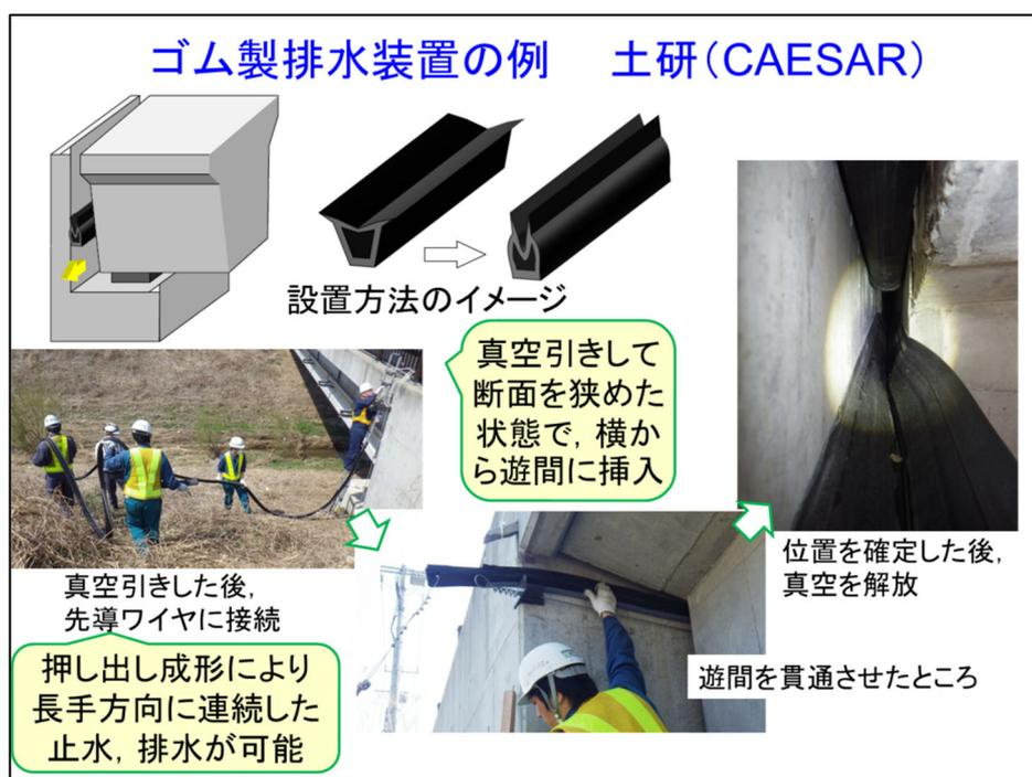
解説 図-2.3.2 橋梁の桁端における樋の設置（資料提供：土木研究所 CAESAR）
