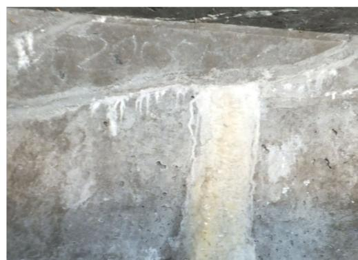
ひび割れ充填後（約1年後）の析出物
