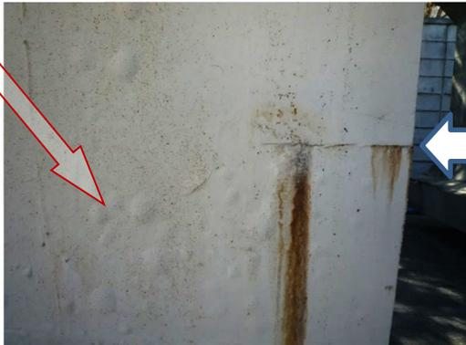
断面修復部とコンクリートの境界に沿って、ひび割れと漏水跡、その延長上に局所的な膨れが発生
