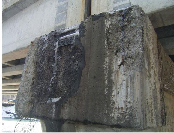
解説 写真-2.2.3 橋面排水が流下する箇所の凍害による劣化事例
