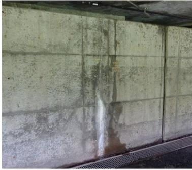
解説 写真－3.1.1 ひび割れ修復工法の施工後に発生した変状の例
