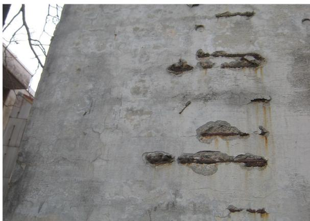
解説 写真-2.2.2 かぶりの薄い箇所における中性化による劣化事例
