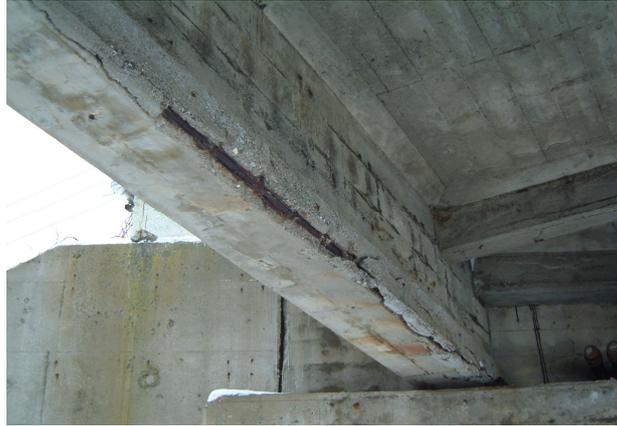
解説 写真-2.2.1 桁の下面における塩害による劣化事例
