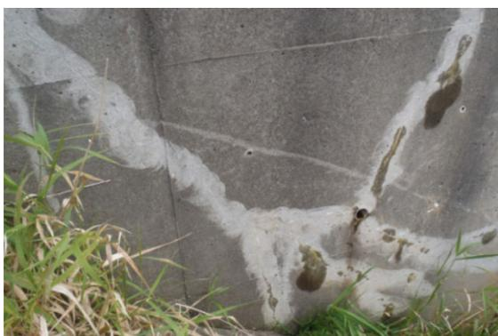
ひび割れ注入後（10ヶ月後）の漏水と析出物
