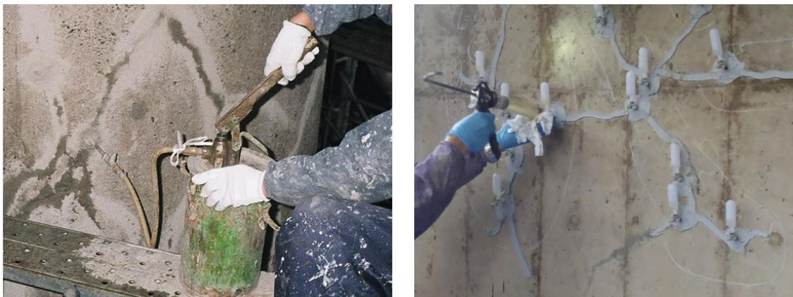
解説 写真-2.3.1 ひび割れ注入工法の施工例
