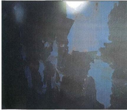
解説 写真-3.1.2 結露が要因となり発生した塗膜の剥離
