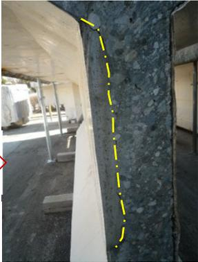
桁の切断面（断面修復部が見える）
