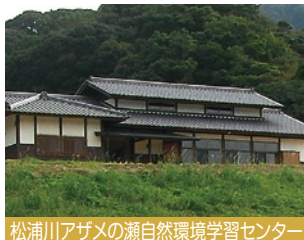
松浦川アザメの瀬自然環境学習センター
