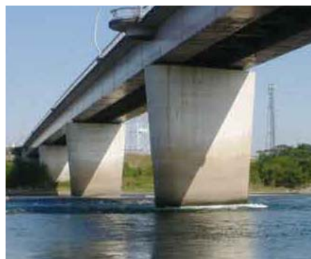
木曽川 平成川島橋 橋脚
