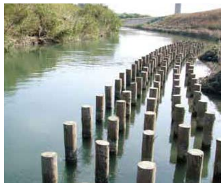
砂鉄川(岩手県)木杭群
