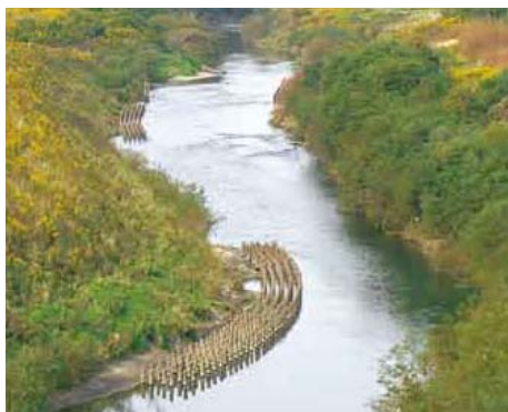
砂鉄川(岩手県)木杭群
