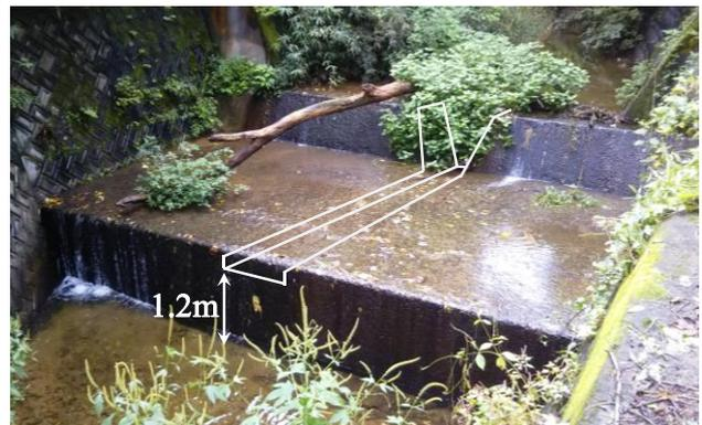
図-5 切欠き魚道の設置イメージ図
