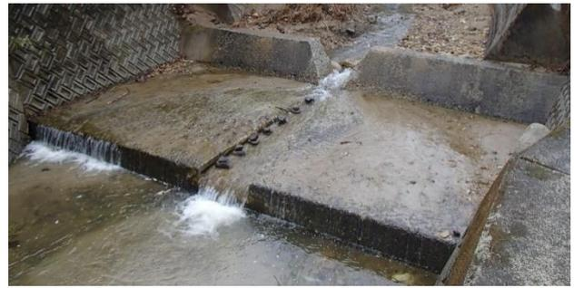
図-6 切欠き魚道の完成
