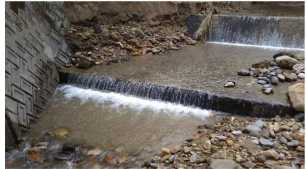
図-7 台風19号2週間後の土砂堆積による段差解消状況（令和元年10月25日撮影）
