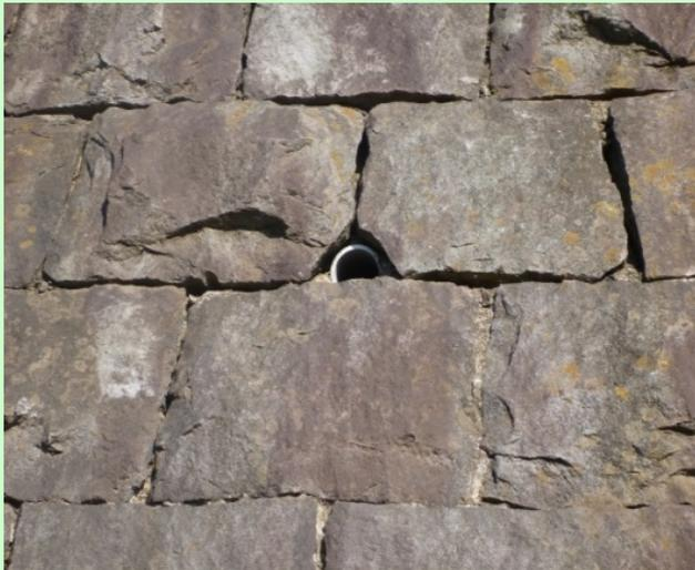
※ 石積みの水抜き処理
