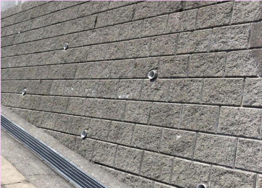
水抜きパイプが表面に飛び出ているため、目立っている
