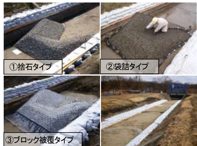
写真-2 各タイプの外観と設置状況
