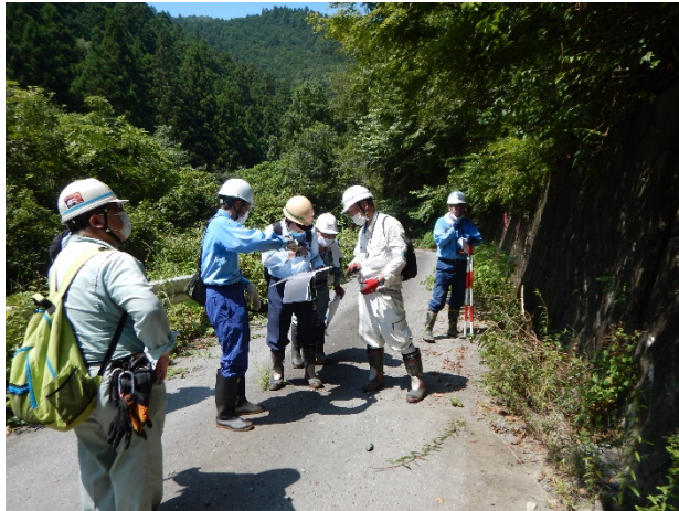
道路周辺の変状の確認
