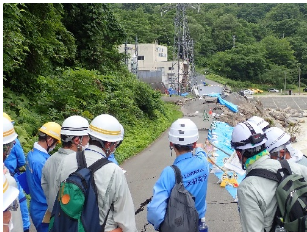
緊急的な現地調査
