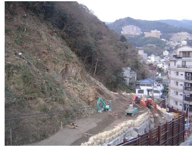
応急対策工事
