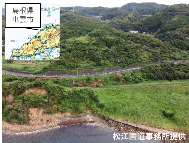
松江国道事務所提供 災害全景写真
