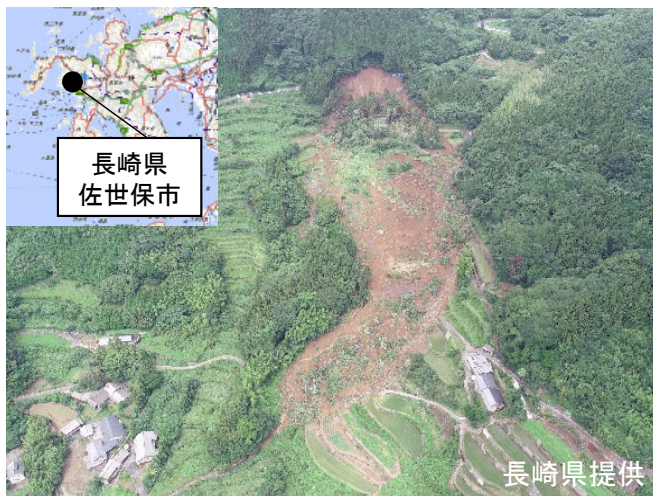
発災直後のUAV写真(7月13日撮影)
