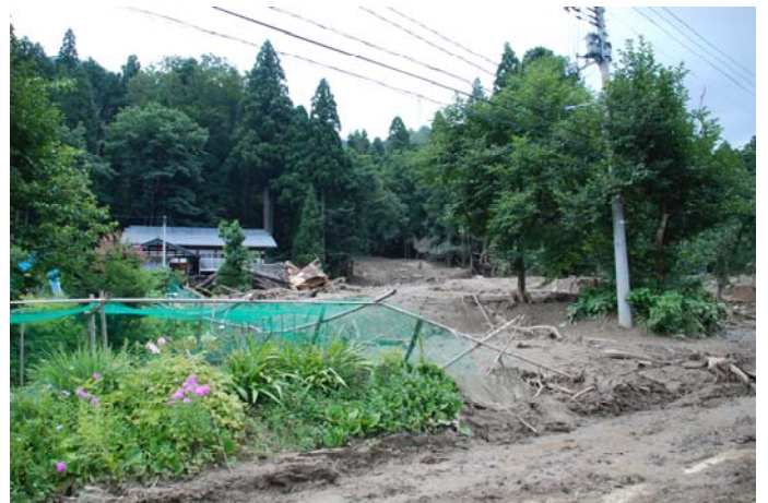
写真-21 小川 土石流堆積域の堆積物（粘性が高い）
