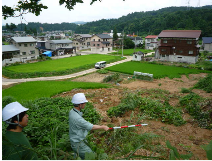
写真-10 斜面下部の状況
