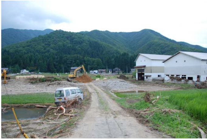
写真-13 破堤箇所（写真左側）と工場窓枠に残った流木（写真右側）
