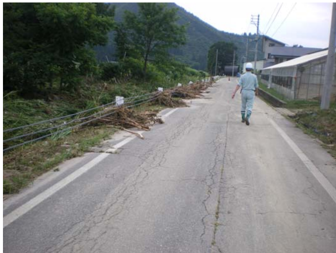
写真-15 ガードケーブルに絡んだ流木
