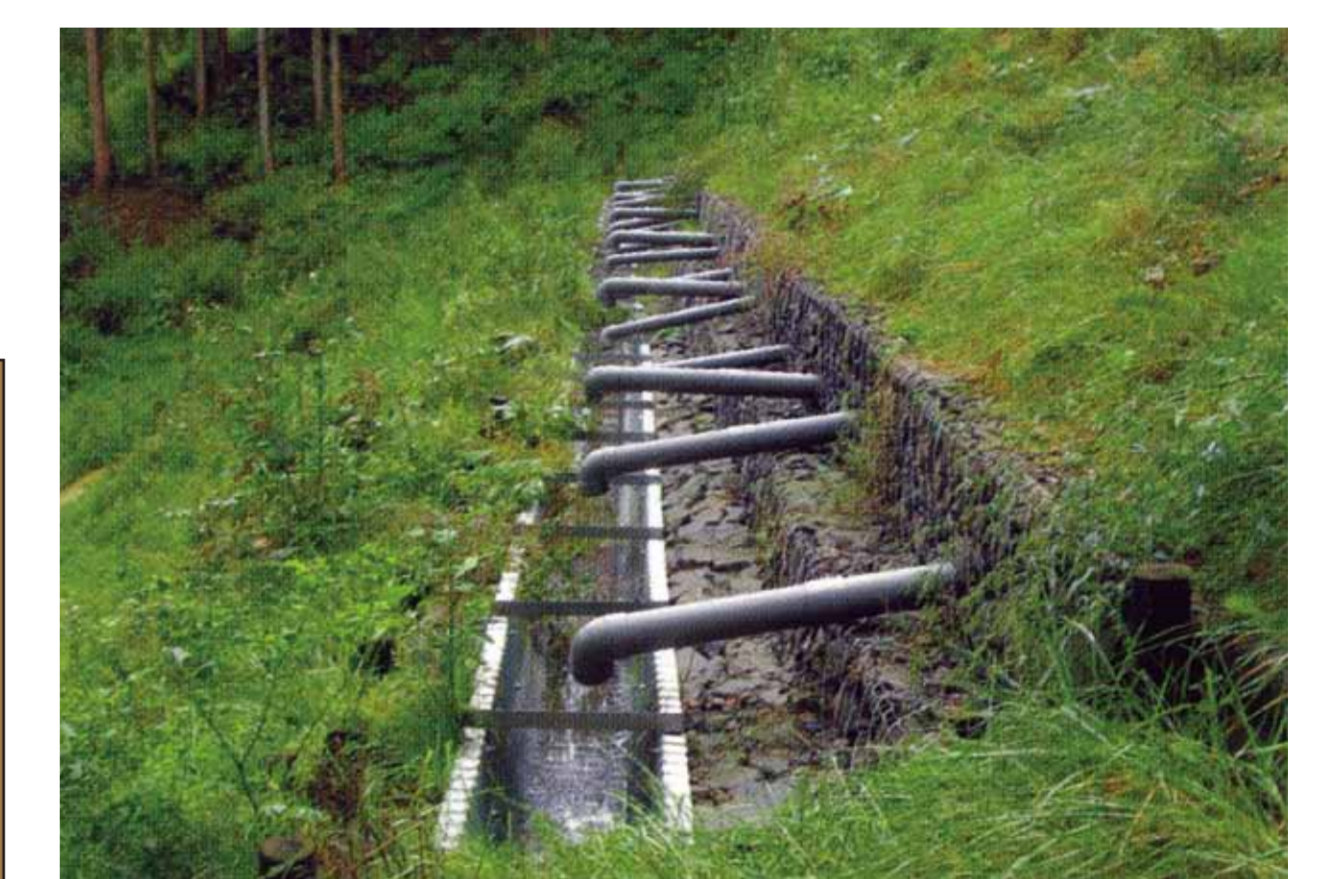
▲横ボーリング工 Lateral boring works
