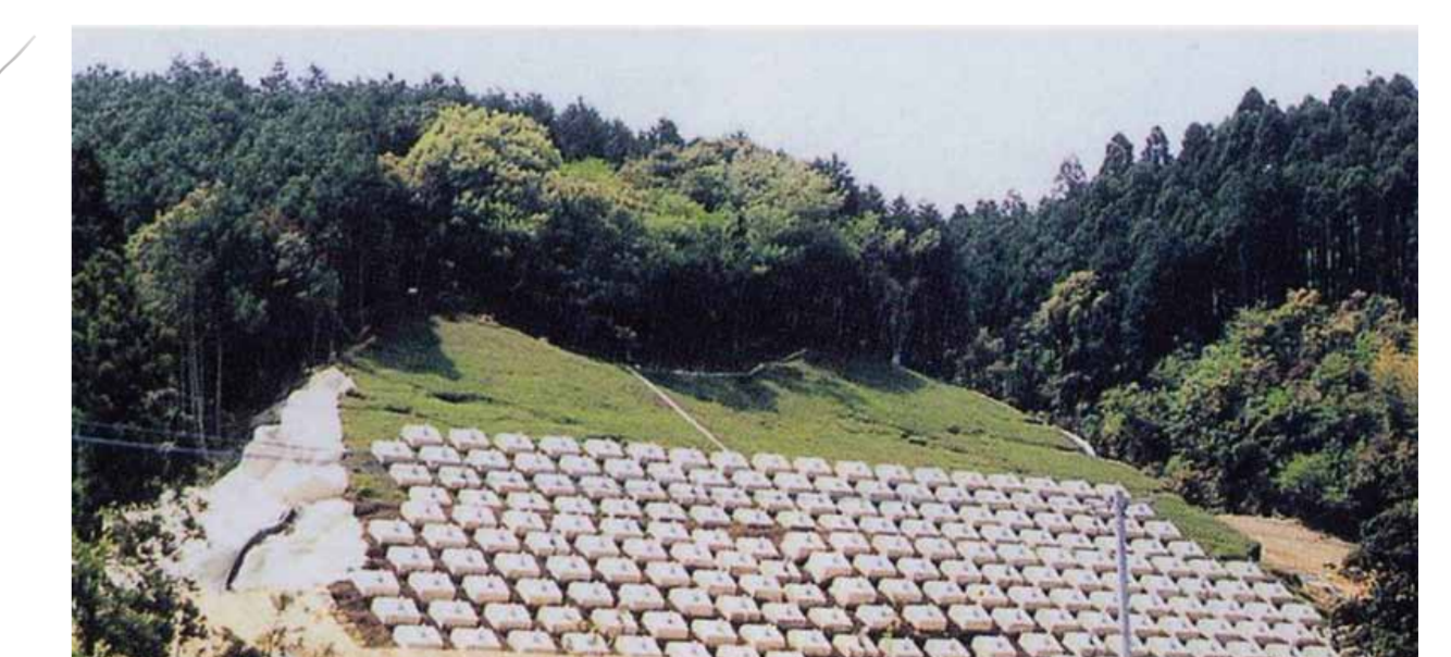
▲アンカー工 Anchor works
