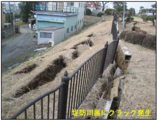
図-2.9.3 調査位置図および 2011 年東北地方太平洋沖地震による被災状況（佐原イ）（関東地整資料を基に作成）
