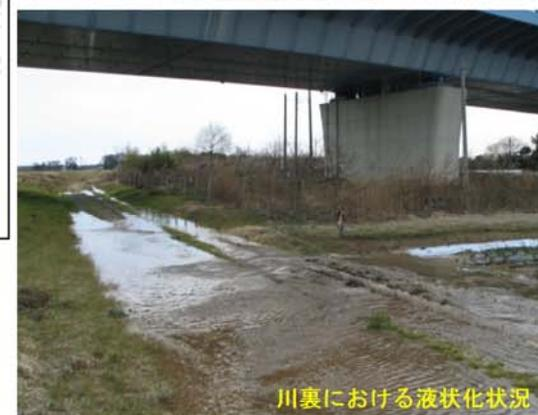
図-2.12.3 調査位置図 2011年東北地方太平洋沖地震による被災状況(下大野)(関東地整資料を基に作成)
