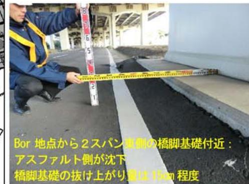
図-2.16.3 調査位置図および2011年東北地方太平洋沖地震による被災状況(舞浜)(関東地整資料を基に作成)
