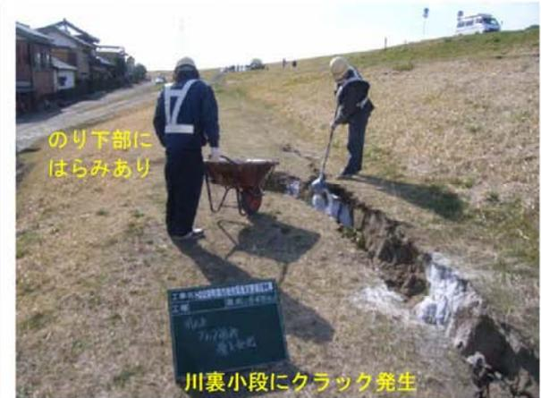
図-2.8.3 調査位置図および2011年東北地方太平洋沖地震による被災状況(請方)(関東地整資料を基に作成)
