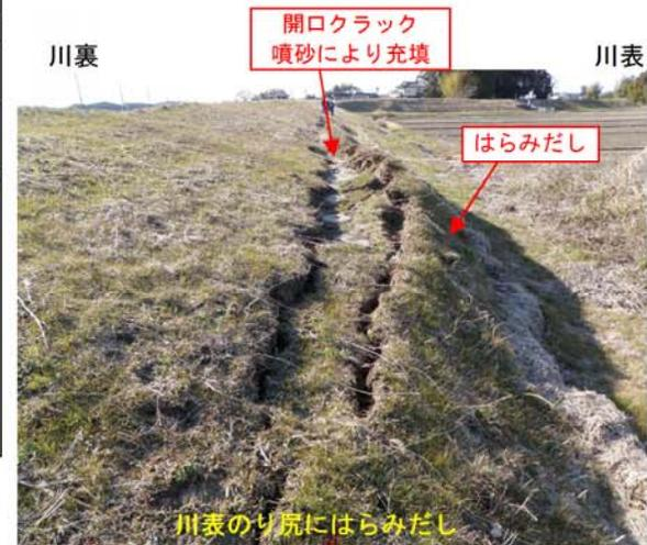
図-2.11.3 調査位置図および2011年東北地方太平洋沖地震による被災状況（本米崎）（関東地整資料を基に作成）
