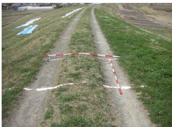
写真-11.2 対策・無対策区間の境界付近に発生した横断亀裂(手前が対策区間。横に伸びる複数の白線が亀裂)<sup>2)</sup>
