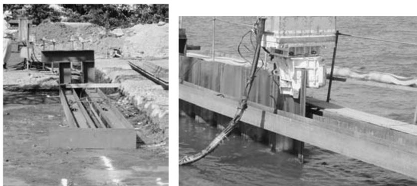
写真-10.5.1 導枠工の例
