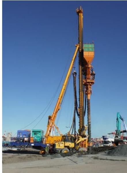
(b)静的締固め砂杭工法 施工機
