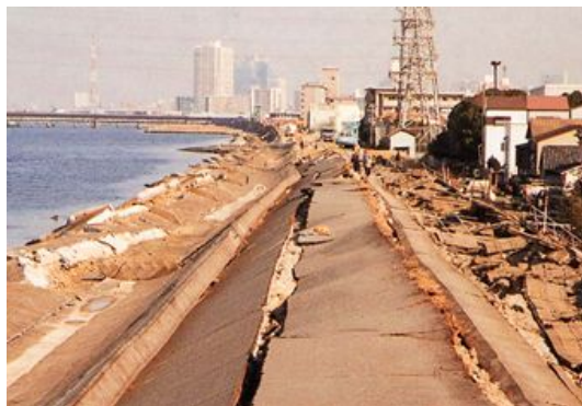
図 2.3.1 基礎地盤の液状化（1995年兵庫県南部地震・淀川） 7)
