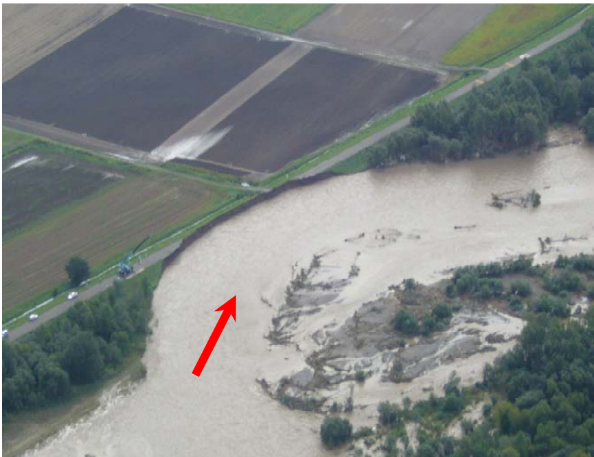
図 2.2.1 侵食による被災 (H23.9・音更川)
