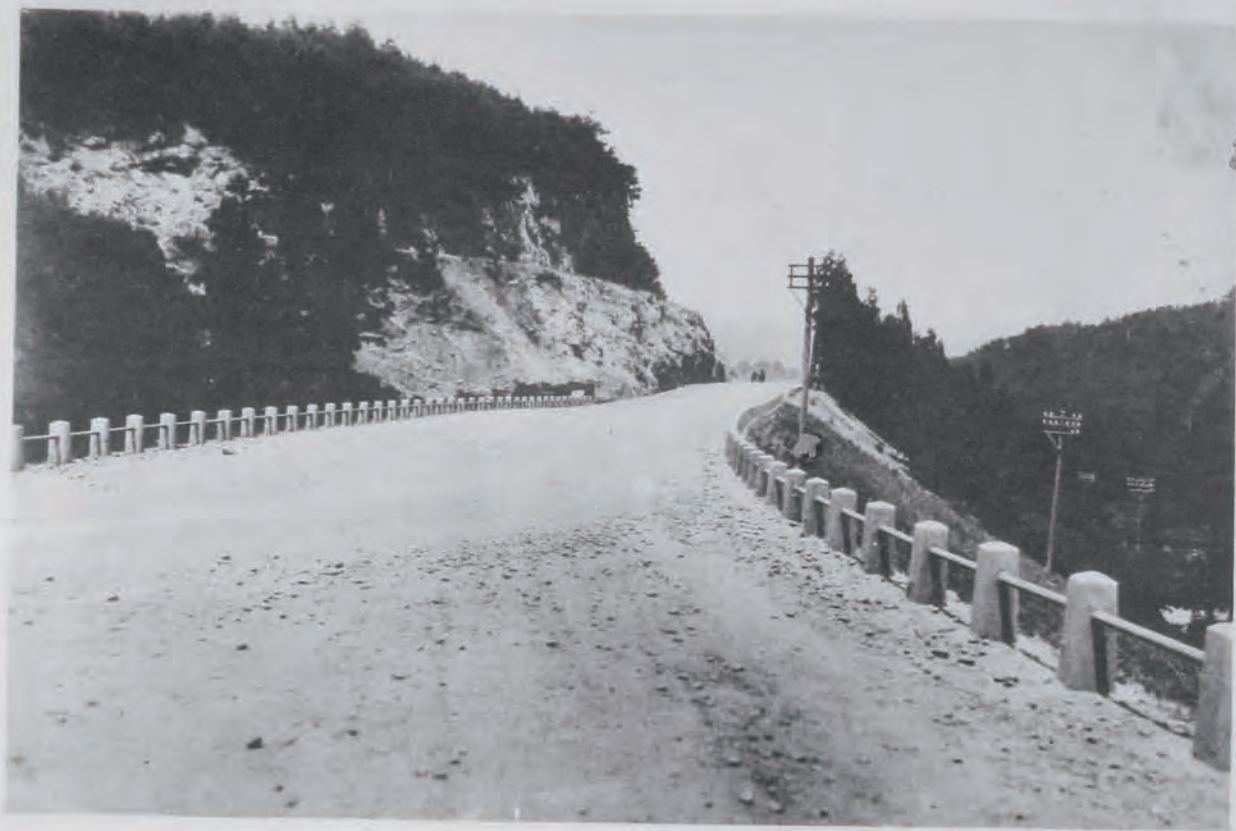
(28) 國道四號線(福島)砂利道竣工 (福島縣信夫郡妻村大字清水町ヨリ舊村大字伏拝ニ至ル工事) 有効幅員七米五乃至九米
