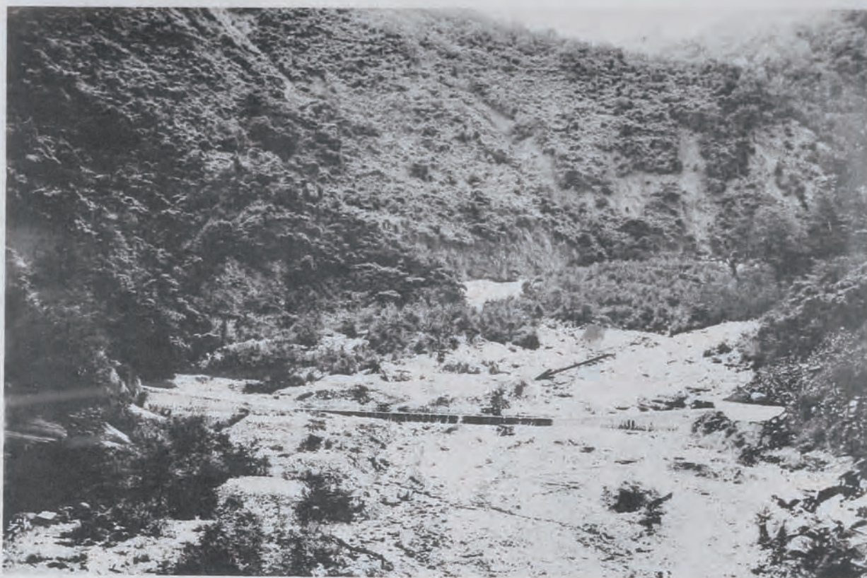
(22) 河内川左支東澤川筋第二床固工事 (神奈川県足柄上郡三保村地先) 延長六十九米六、床固堰堤高四米、天幅二米
