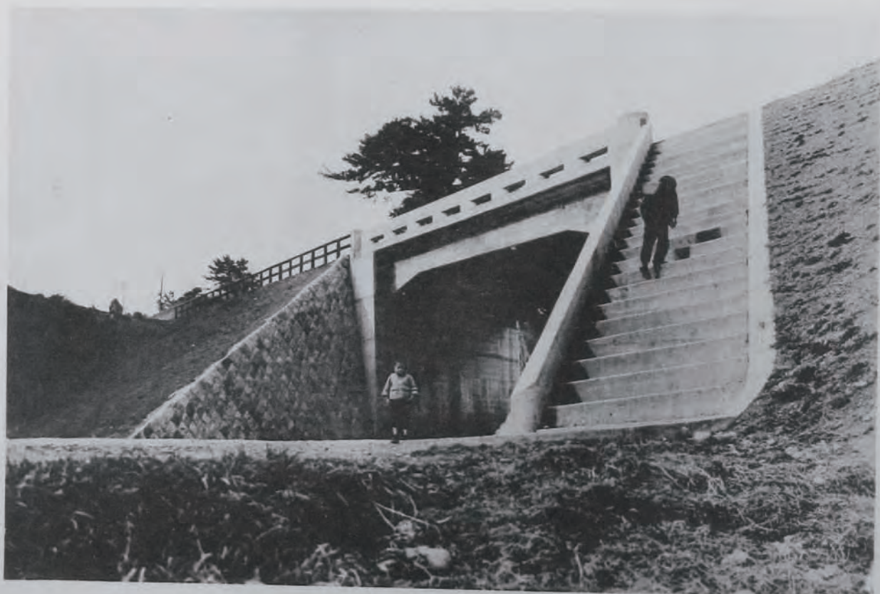
(25) 國道三號線(八屋)跨道橋竣功狀況 (福岡縣築上郡菟田村大字御腰掛地内新舊國道交叉箇所)
