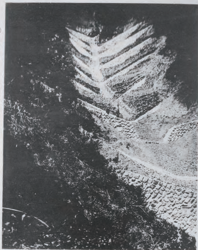
(8) 信濃川水系砂防品庄澤山腹工 (右岸下流ヨリ望ム)
