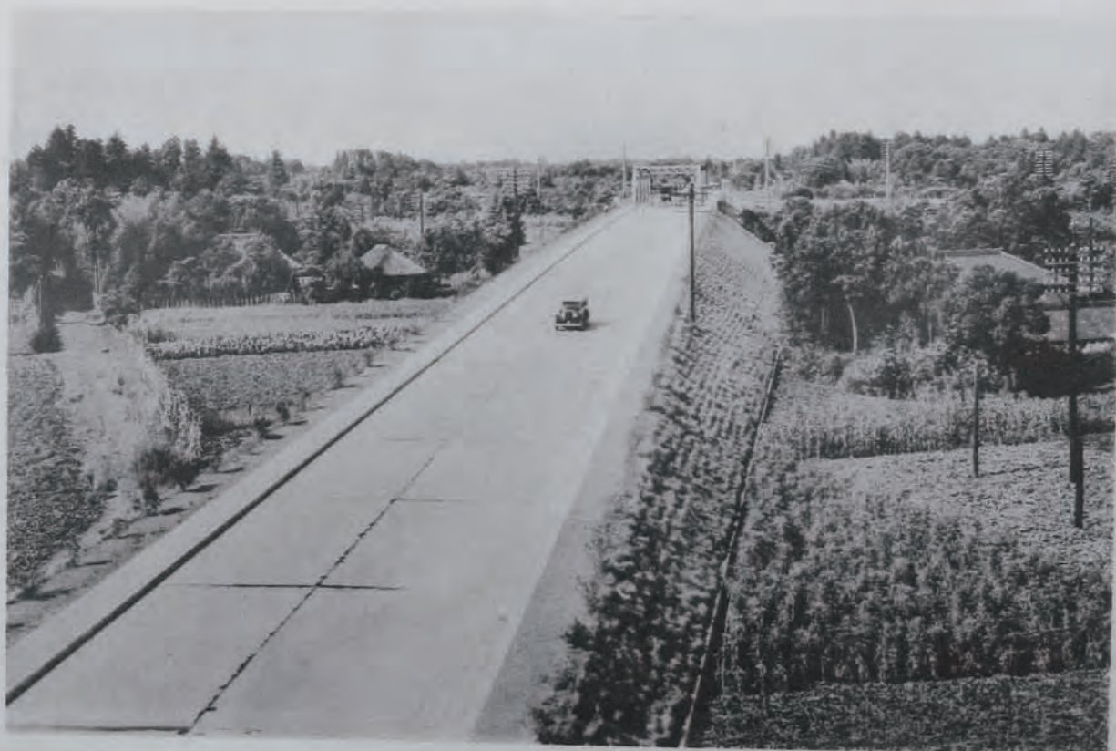
(33) 國道九號線(大宮)竣功セル大成橋正面及取付道 (埼玉縣北足立郡日進村地内)
