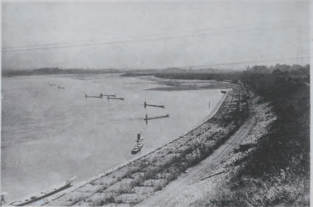
(4) 神通川改修工事百塚護岸 (富山縣婦負郡草島村大字松ノ本地先) 上流部根固工事竣功狀況
