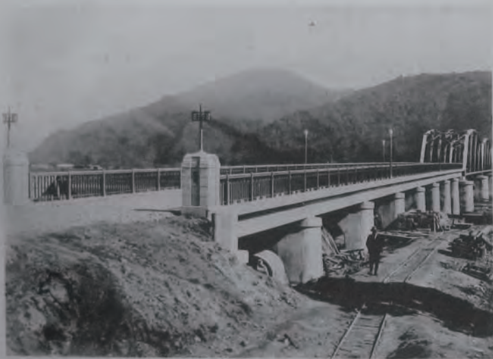
(2) 最上川上流改修工事長井橋繼足工事竣功状況 (山形縣西置賜郡長井町大字小出地内)
