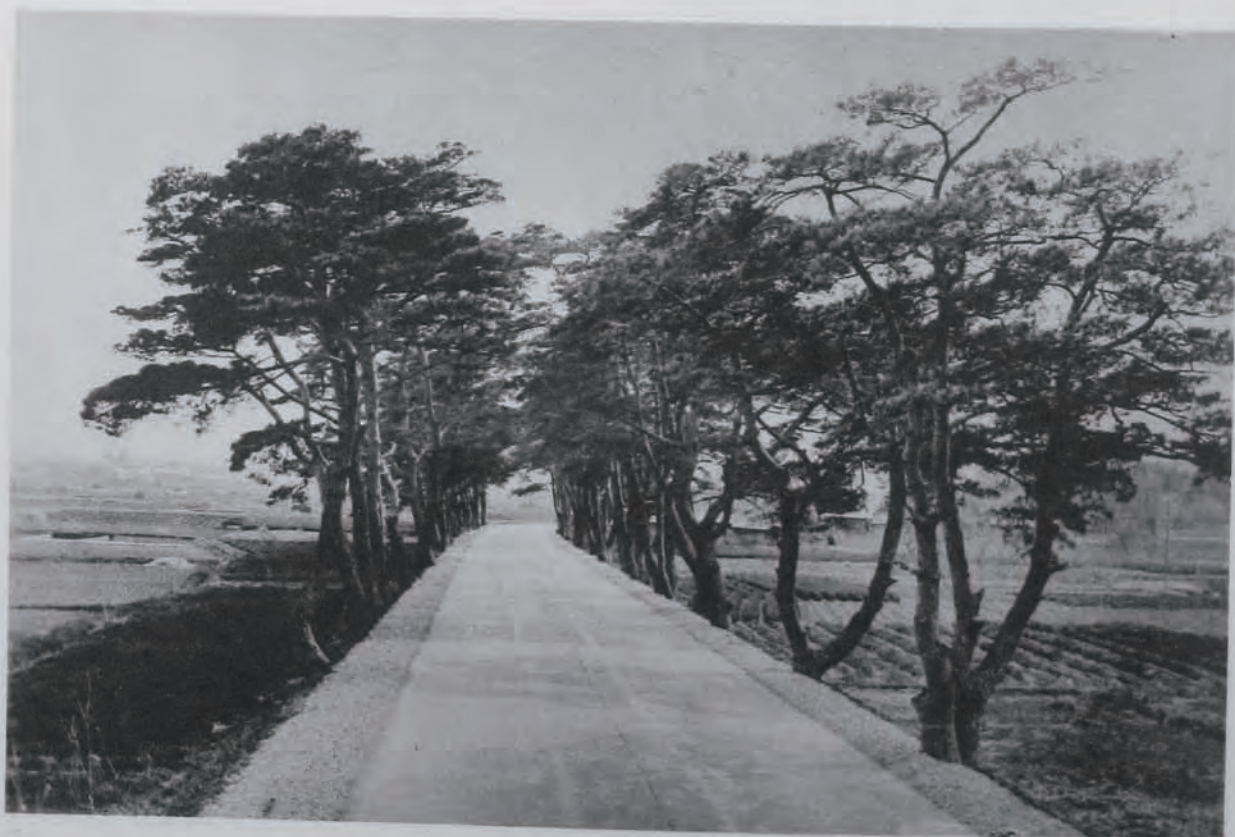
(29) 國道四號線(宮城)混凝土鋪裝竣工 (宮城縣刈田郡福岡村大字長袋地内) 有効幅員七米五、鋪裝中央六米
