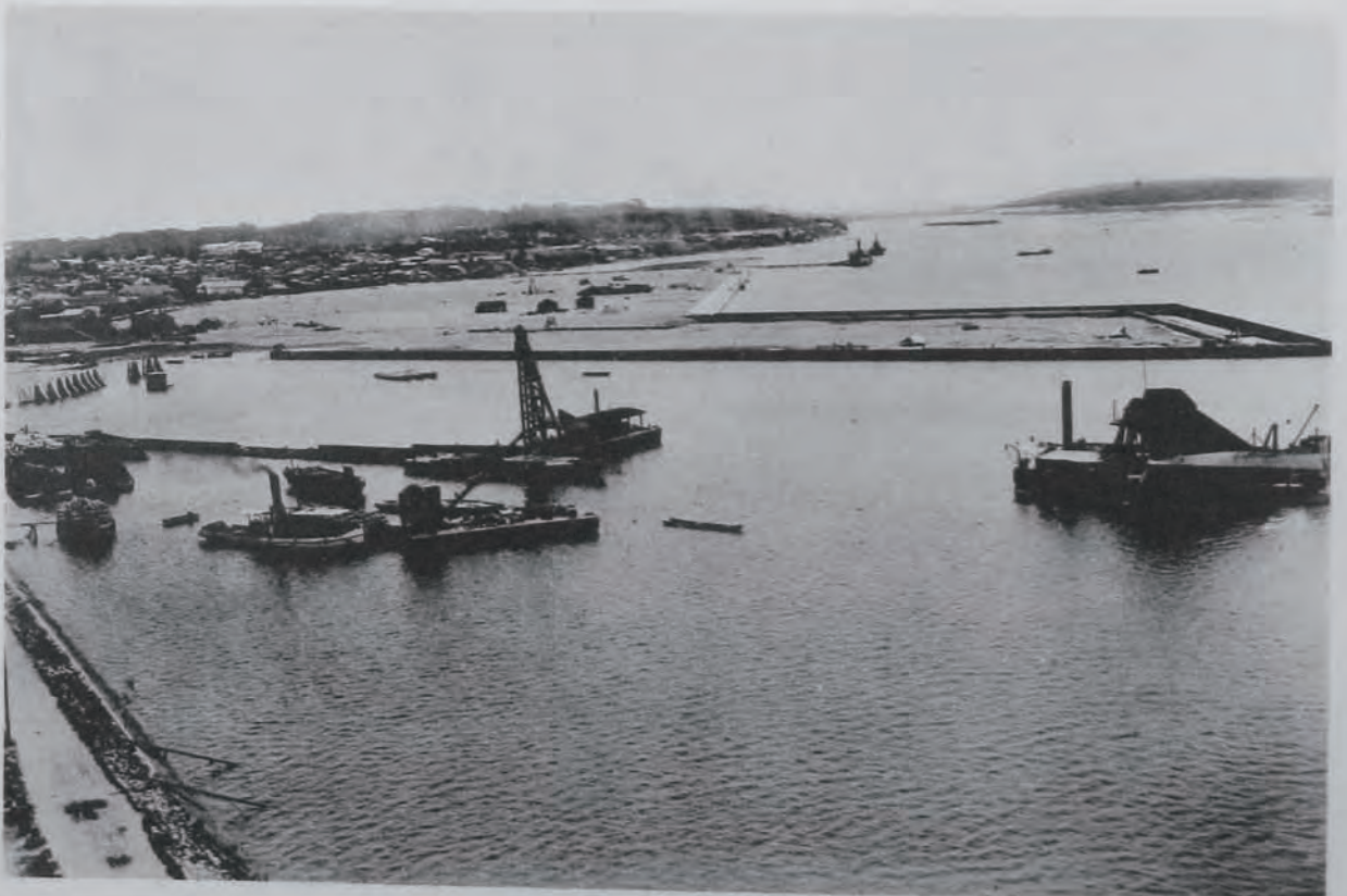
(15) 土 崎 港 修 築 工 事 中 狀 況
