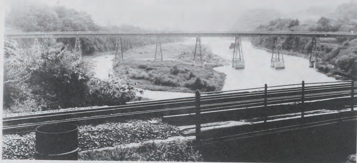
(30) 國道四號線(岩手)竣成セル青岩橋 (岩手縣二戸郡金田一村大字釜澤ヨリ青森縣三戸郡留崎村大字日時ニ至ル工事) 馬淵川下流ヨリ望ム
