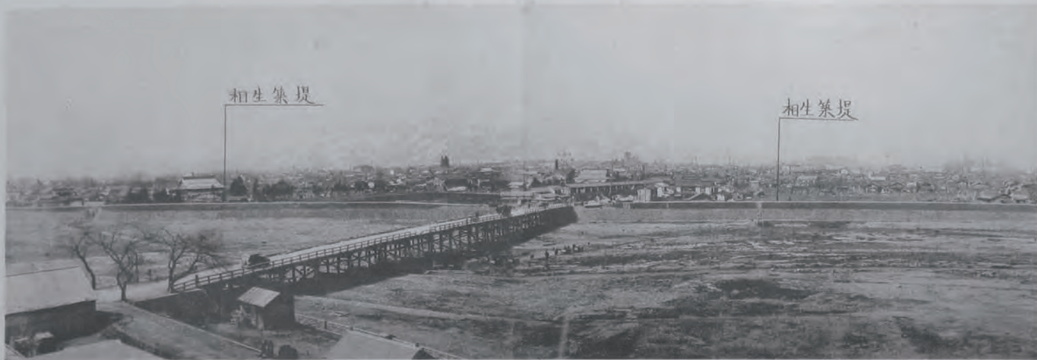
(1) 最上川上流松川改修工事 (米澤高等小學校屋上ヨリノ展望)
