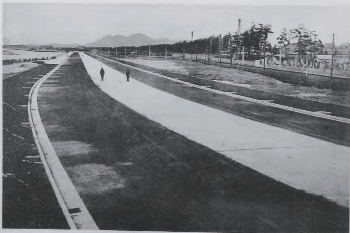
(23) 国道二號線(博多)路面工事 (福岡市大字堅粕地内測點第六十五附近ヨリ起點ヲ望ム)
