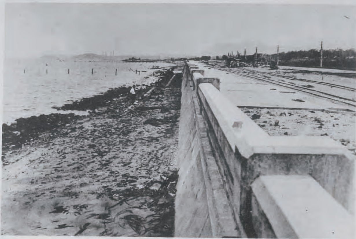
(24) 國道二號線(博多)岸壁工事 (福岡市大字堅粕地内測點第五十號附近海岸ヨリ望ム)
