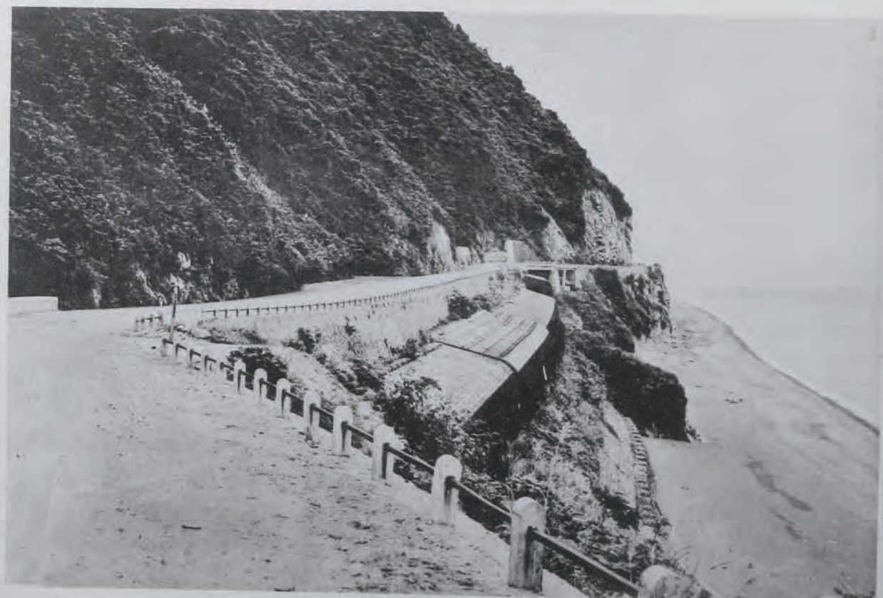
(39) 國道十一號線(親不知)竣功セル深太跨線橋附近道路 (新潟縣西頸城郡青海町大字歌外波地内) 構造物ハ手前ヨリ勝山溝橋、深太跨線橋、深太棧橋
