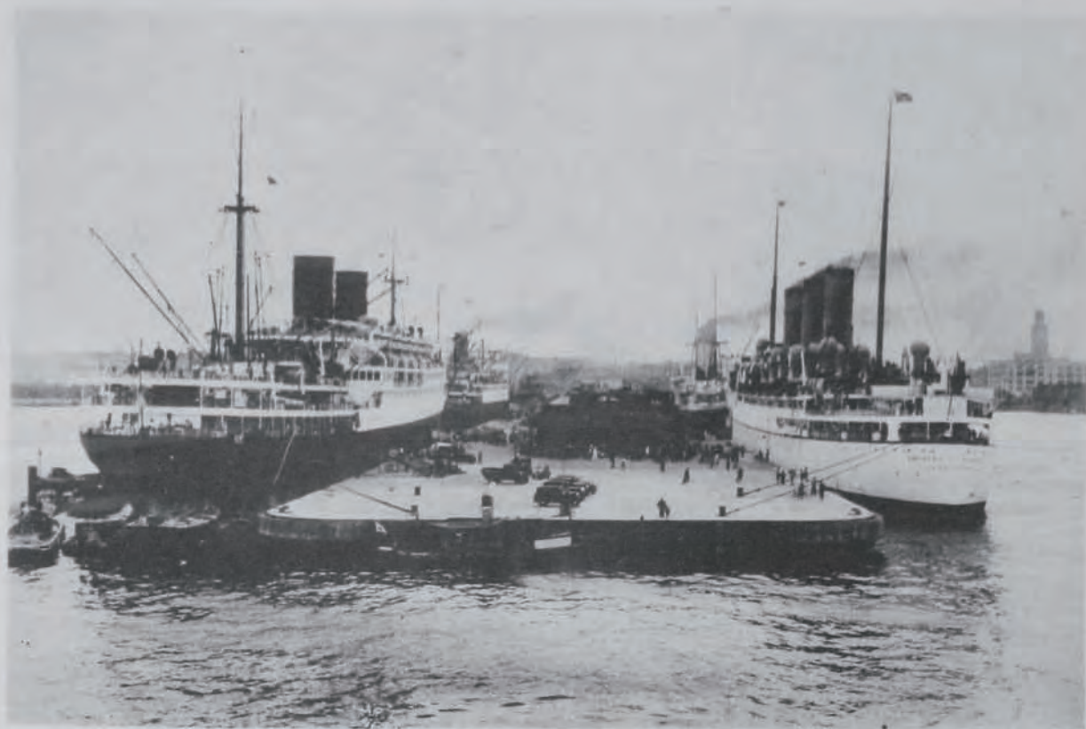
(12) 横濱港修築増補工事 竣工後ノ山下町棧橋ノ頭部
