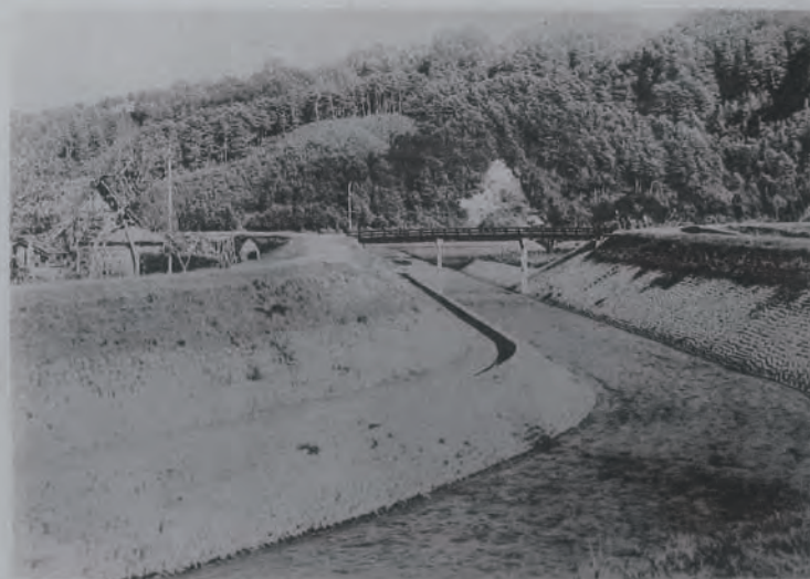
(3) 最上川改修工事福田川河口整理事竣功状況 (山形縣西置賜郡豊田村大字泉地先)
