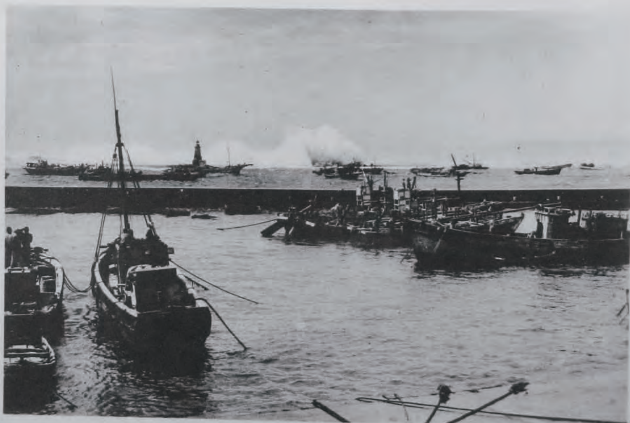
(17) 小名濱港修築工事防波堤 防波堤ニ當ル波浪ノ狀況
