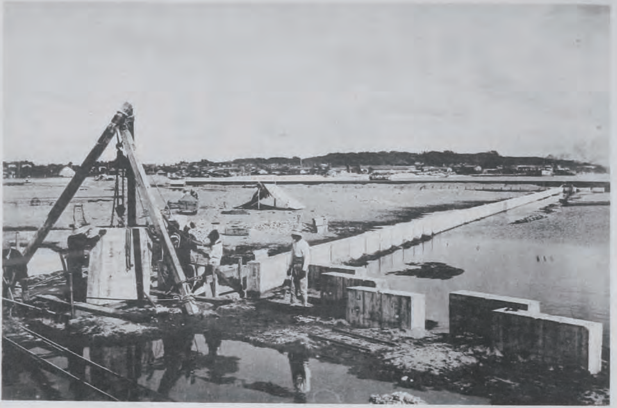
(14) 土 崎 港 修 築 工 事 岸 壁 四 米 六 岸 壁 錨 定 板 据 付
