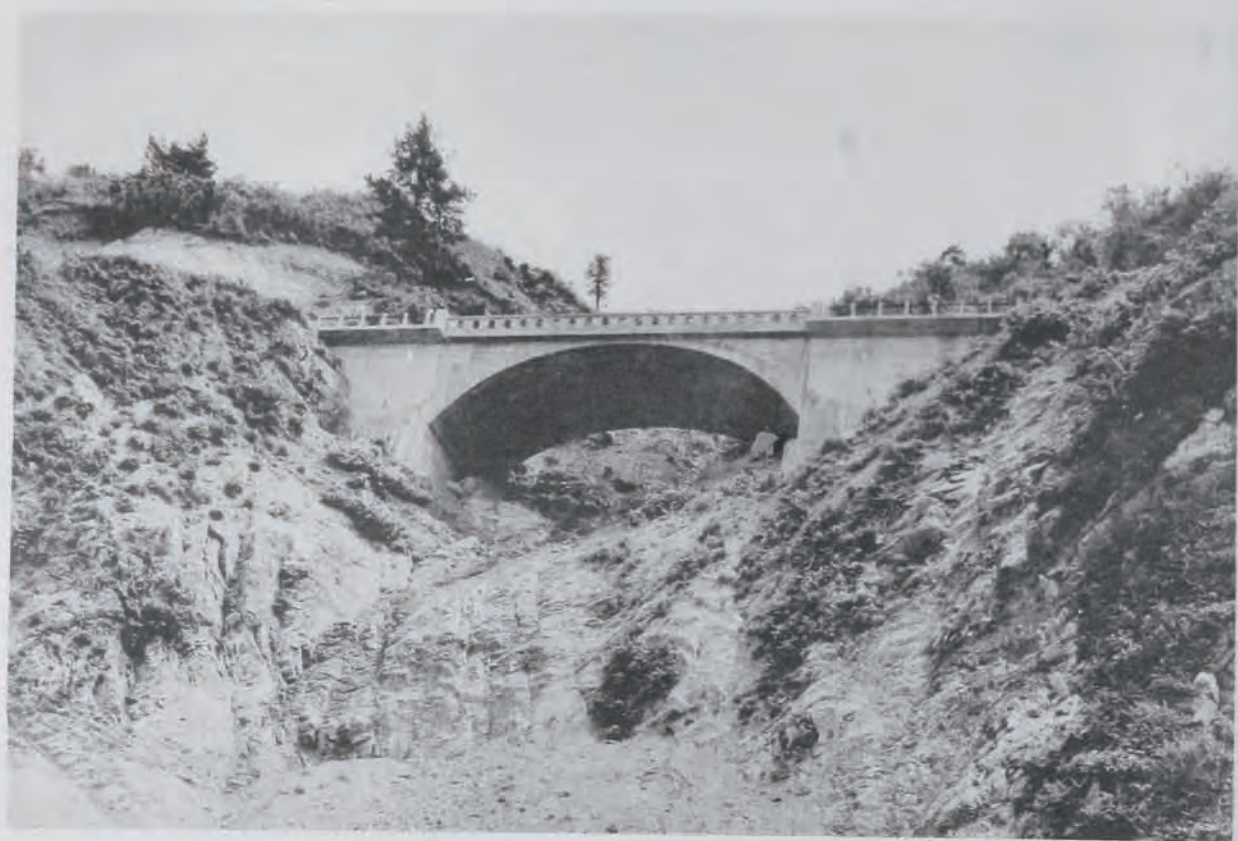
(38) 國道十一號線(親不知)竣功セル立岩橋 (新潟縣西頸城郡青海町大字歌外波地内)
