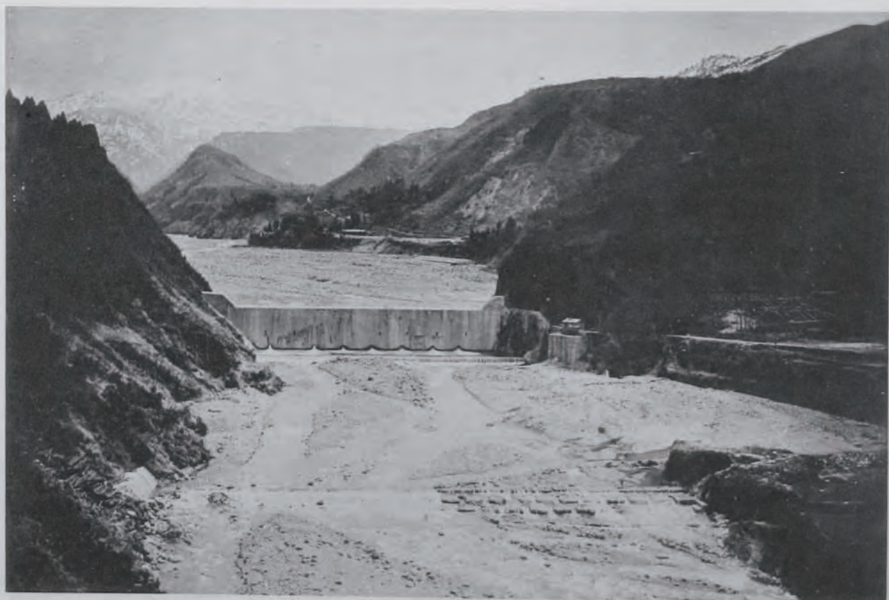
(22) 常願寺川砂防工事本宮堰堤全景 (富山縣上新川郡大山村大字本宮地先)
