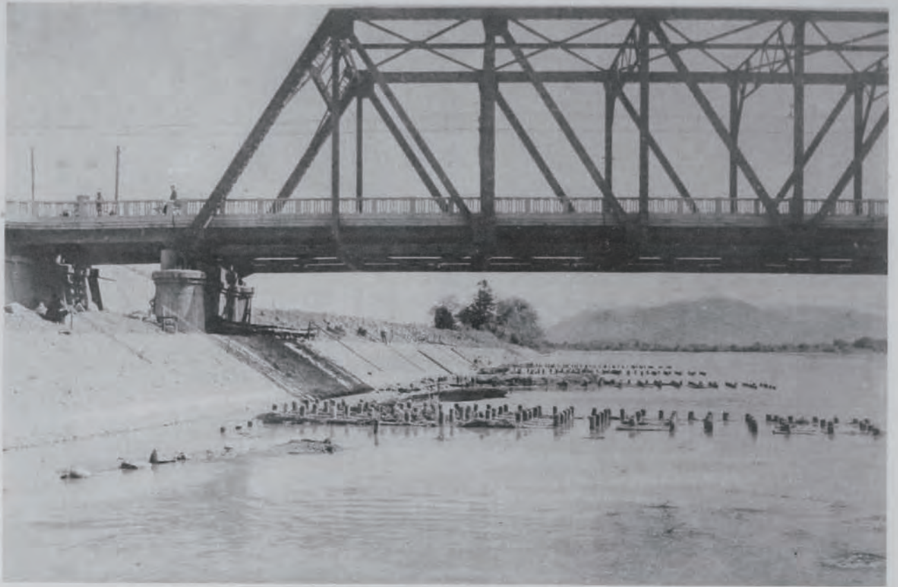
(5) 千曲川改修村山第二護岸工事全景 (長野縣上水内郡柳原町大字村山地先)
