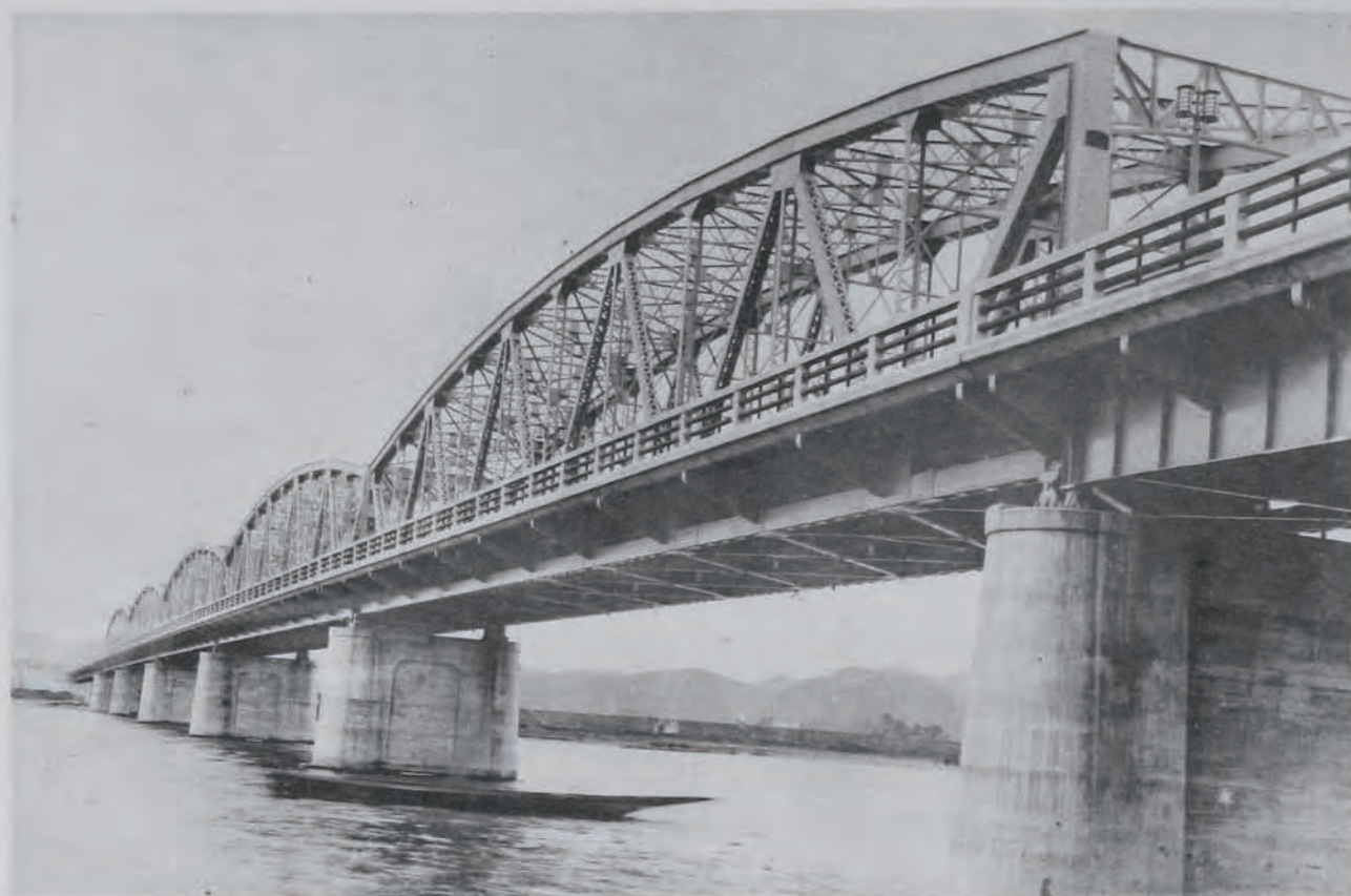
(35) 國道十六號線改良工事北島橋鋼構桁及高欄 和歌山縣海草郡野崎村大字北島和歌山市杉ノ馬場五丁目立會紀ノ川架設 (由良要塞司令部檢閱済)
