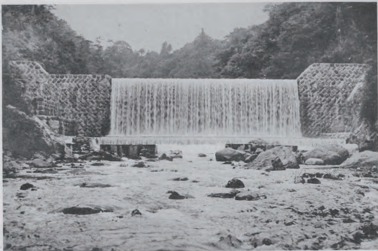
(23) 相模川流域道志川筋笹久根堰堤 堰堤延長四十五米 (山梨縣南都留郡道志村下流ヨリ望ム)
