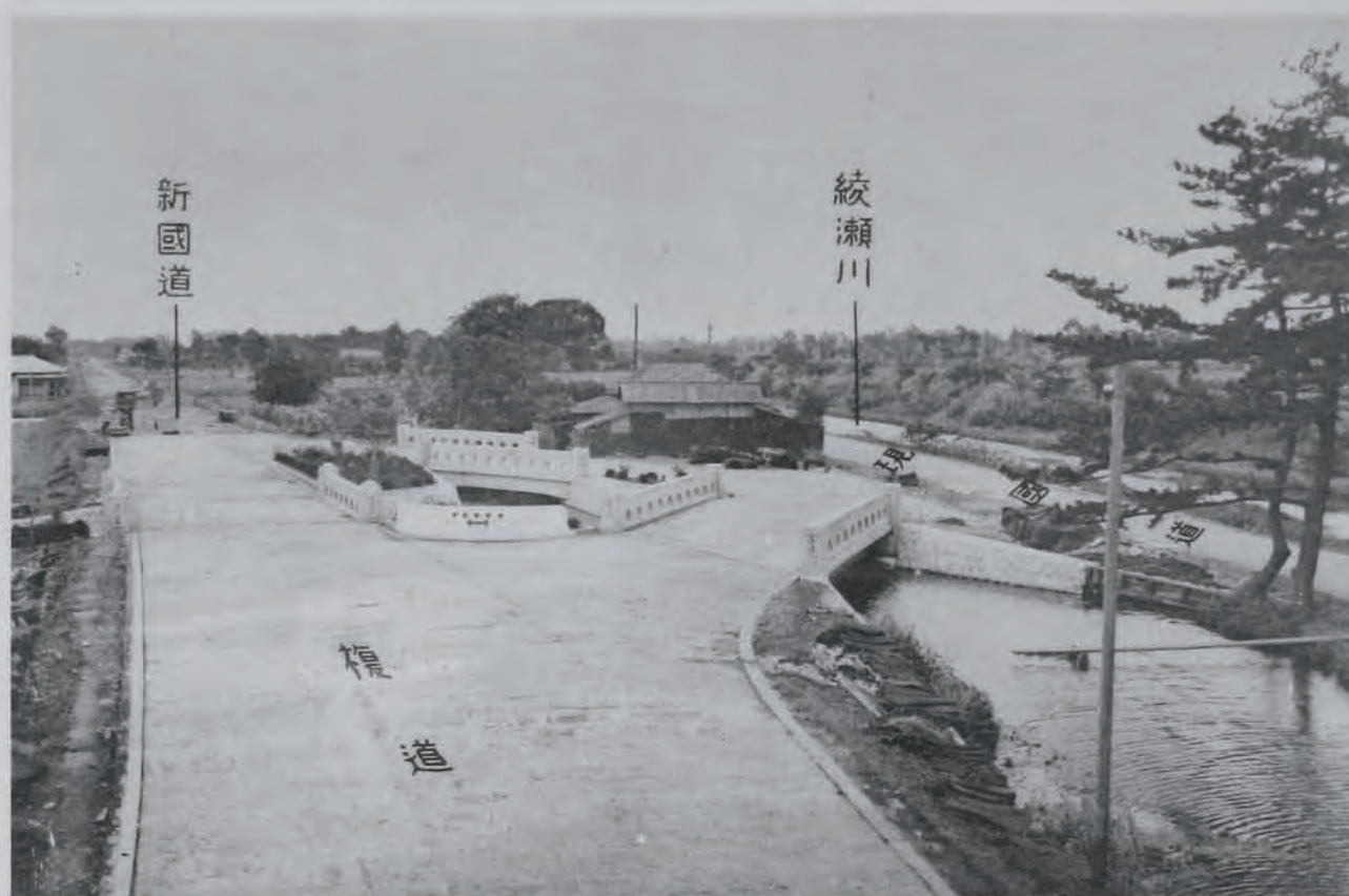
(31) 國道四號線改良工事竣功セル三ツ橋 (埼玉縣北足立郡草加町及新田村境界附近)
