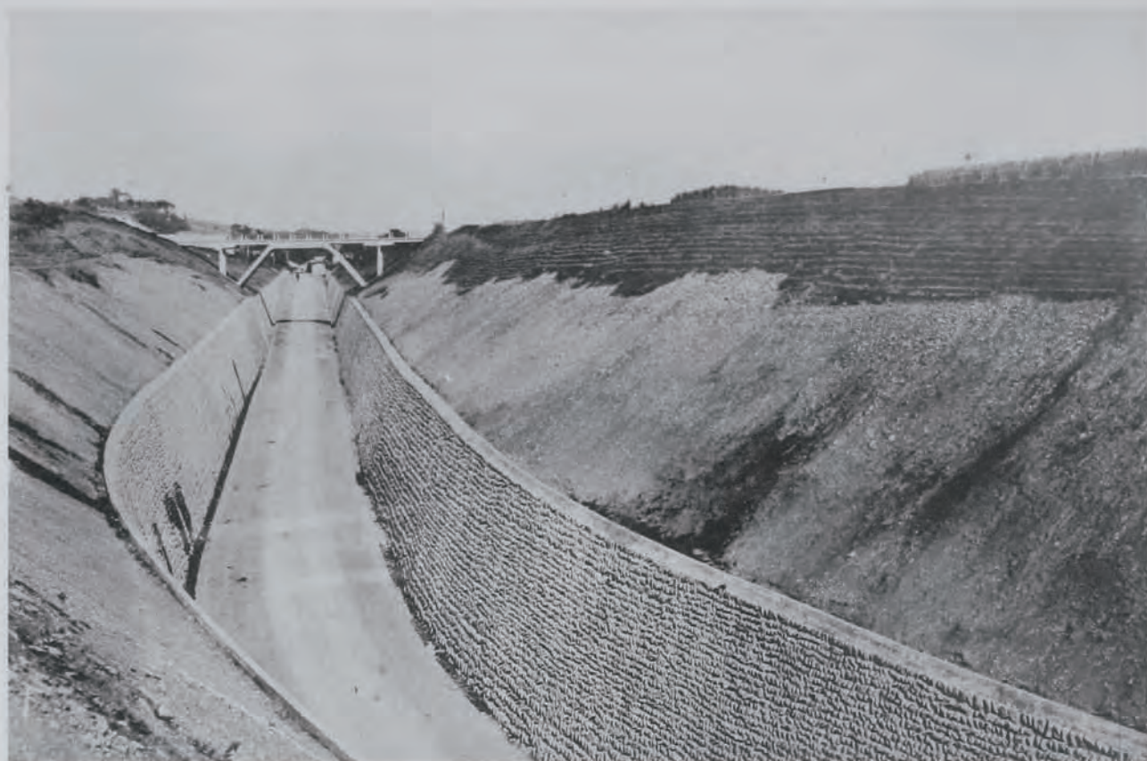
(33) 國道八號線改良工事竣功セル大間々擁壁 (山梨縣北都留郡上野原町地内)
