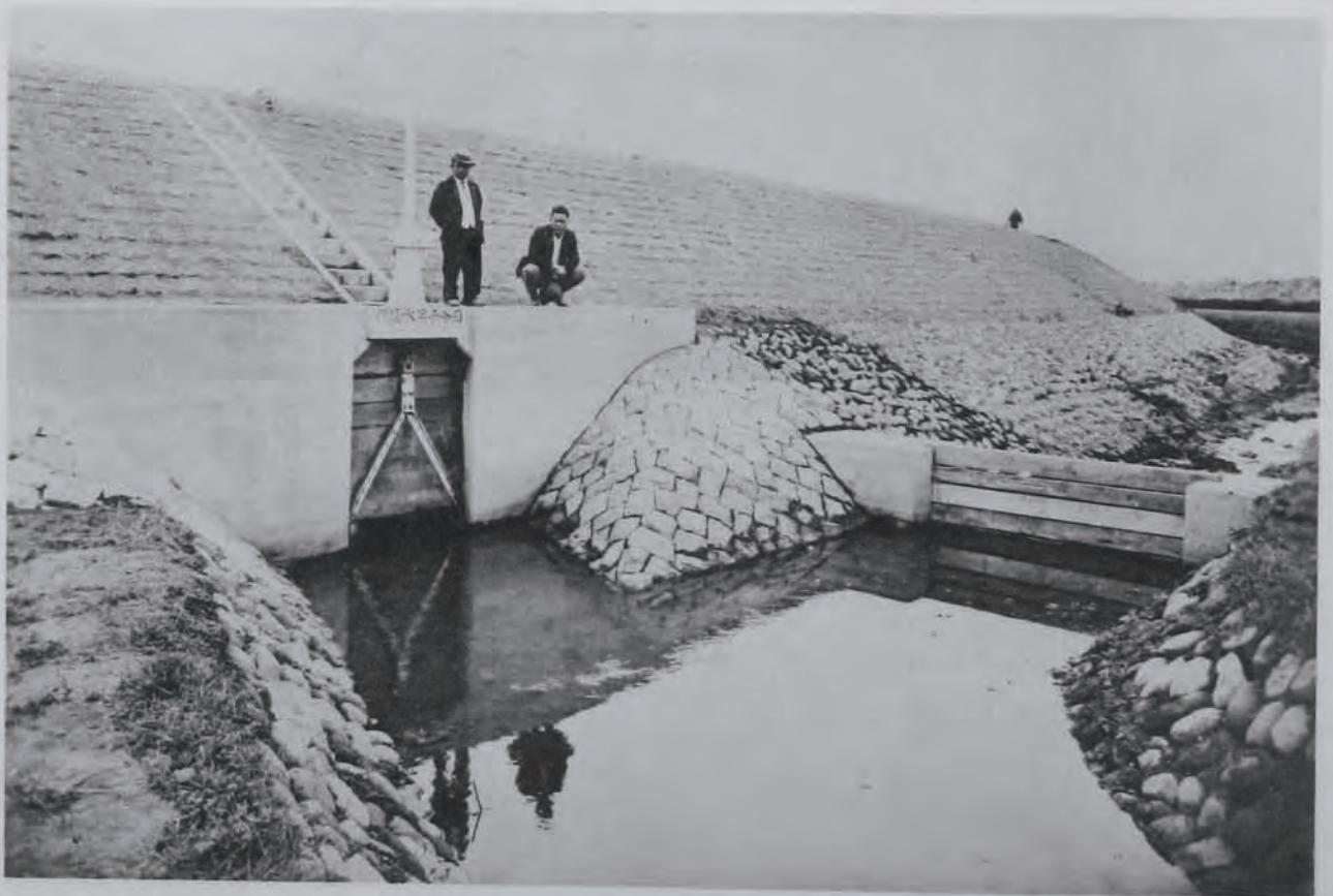
(18) 天神川改修工事用水樋門竣功狀況 (鳥取縣東伯郡社村地内國府川筋左岸國分寺用水)
