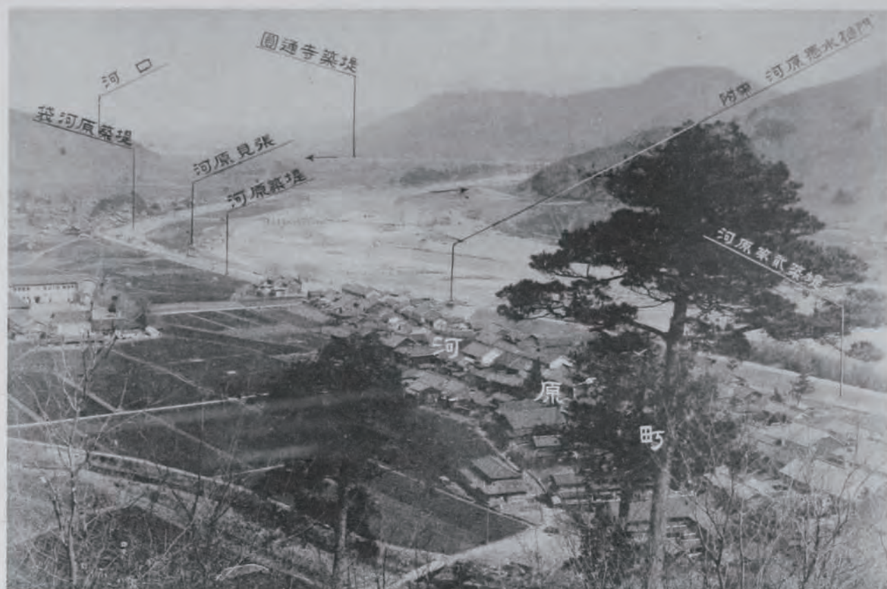
(9) 千代川改修工事左岸上流ヨリ遠望
