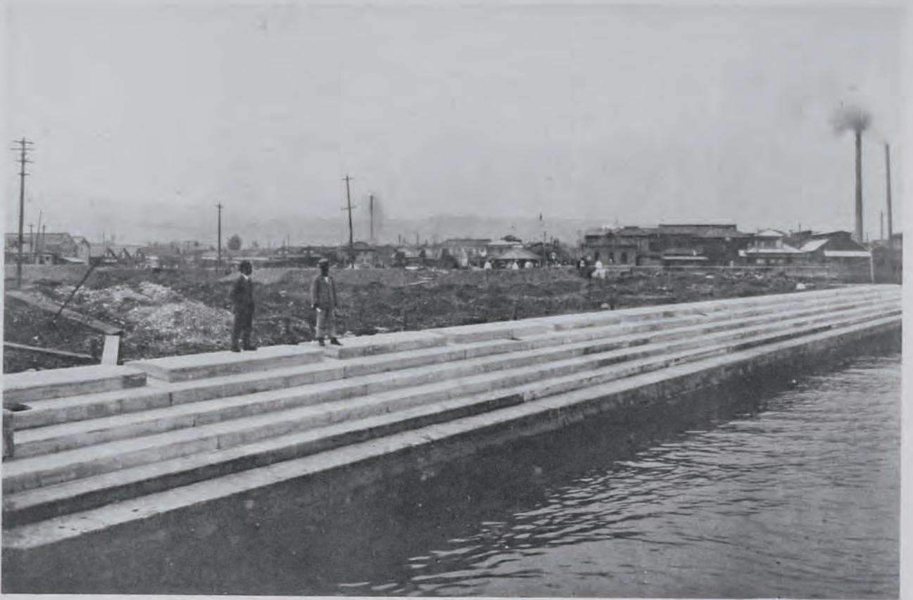
(25) 清水港修築工事竣功近キ追加護岸
