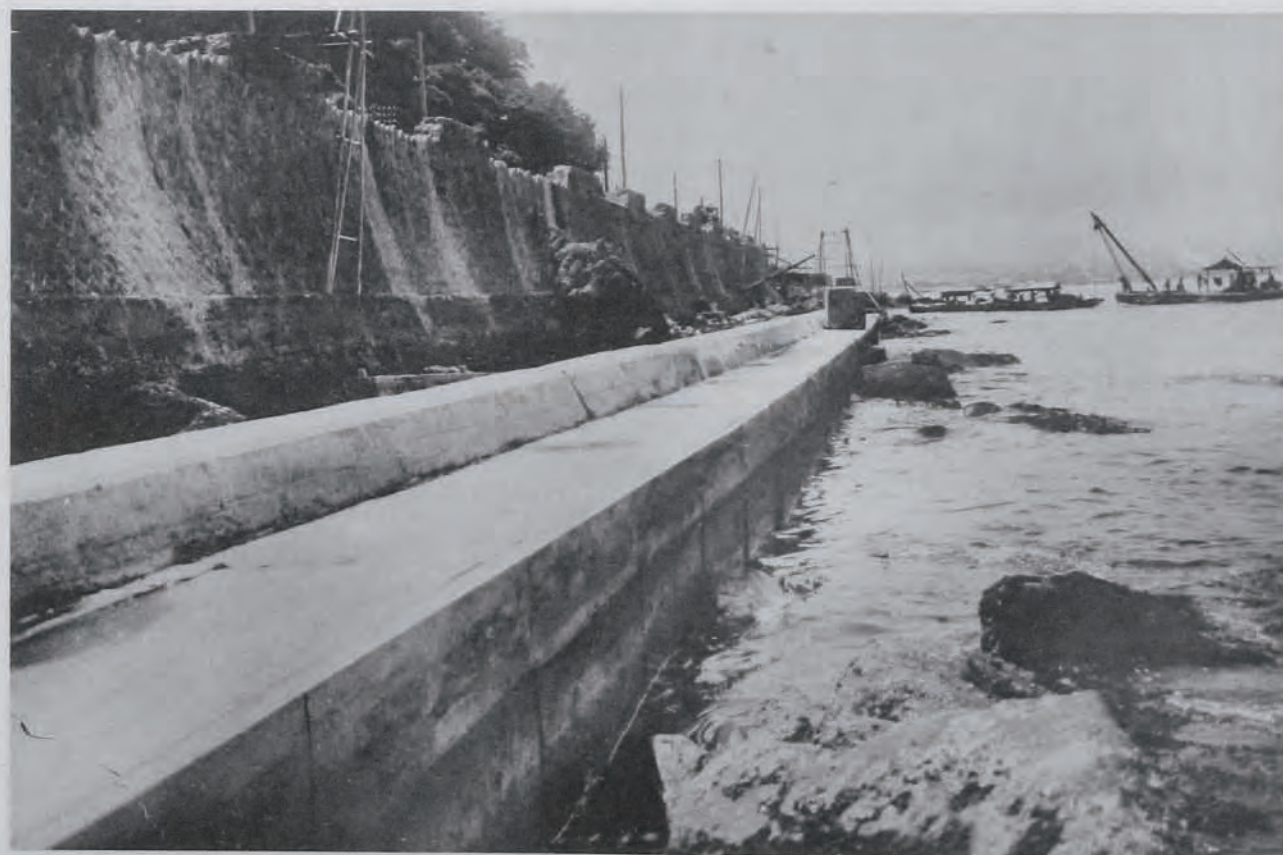
(30) 國道三號線改良工事現況 測點二十三號ヨリ三十三號附近
