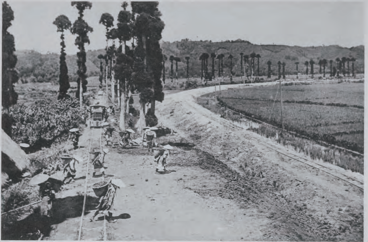
(17) 小矢部川改修工事長江築堤及掘鑿 築堤並同人力掘鑿工事範負作業 (高岡市長江地先右岸ヨリ下流ヲ望ム)
