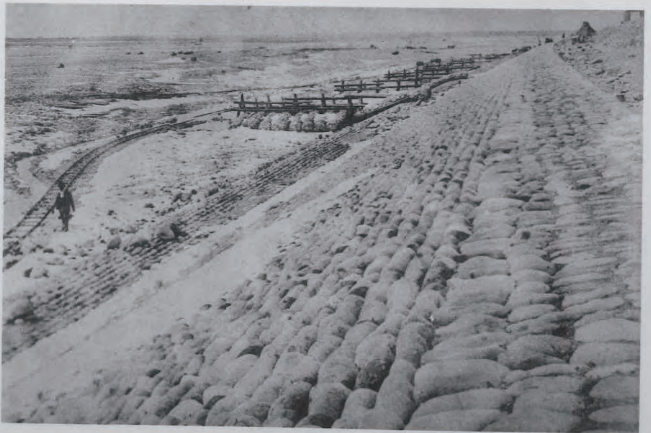
(16) 手取川改修工事床掘及沈床 右岸權正寺護岸床掘及沈床布設
