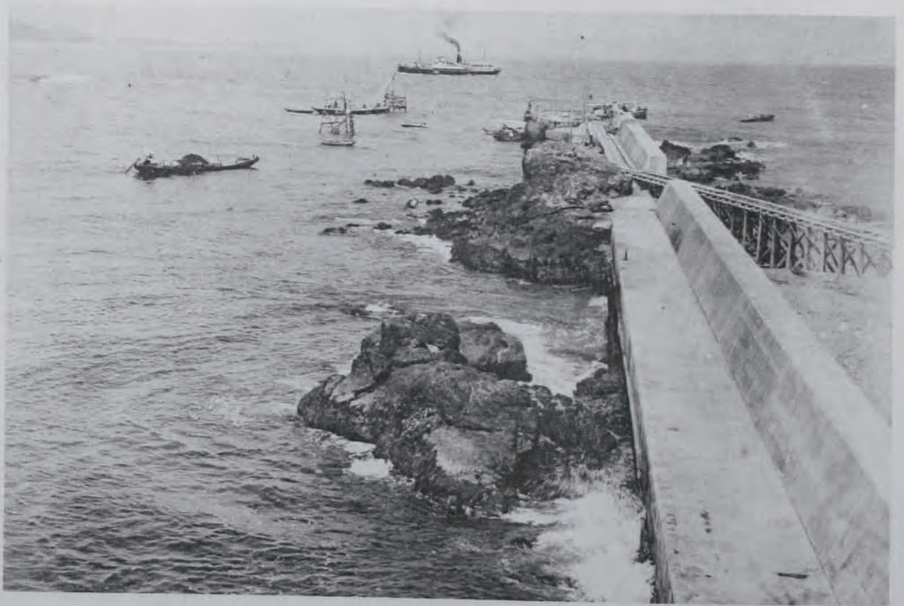
(26) 浦戸港修築工事甲部防波堤既成部状況
