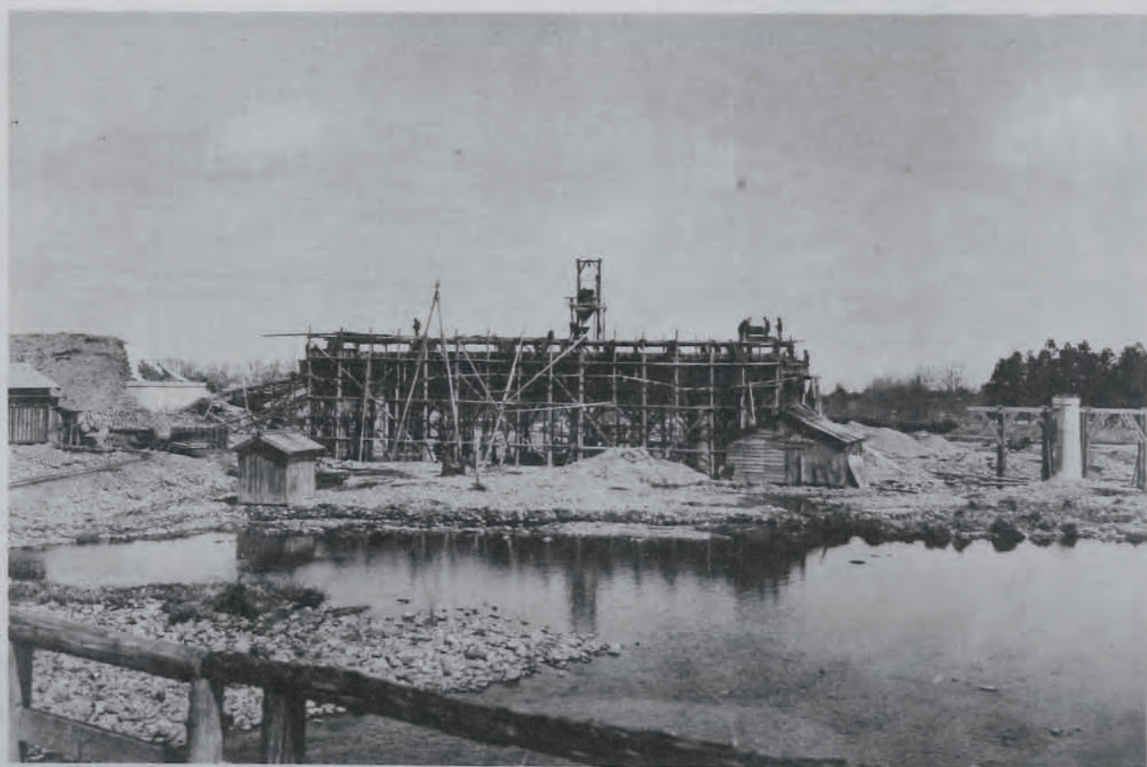
(32) 國道五號線改良工事吾妻橋新設工事狀況 (山形縣南置賜郡萬世村地内)
