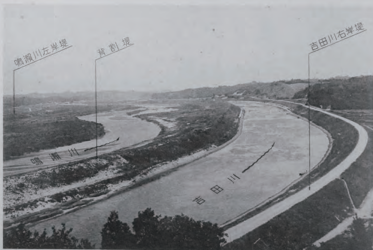
(4) 江合、鳴瀬兩川改修工事遠望 吉田川及鳴瀬川下流ヲ望ム (宮城縣宮城郡松島町字前浦地先)
