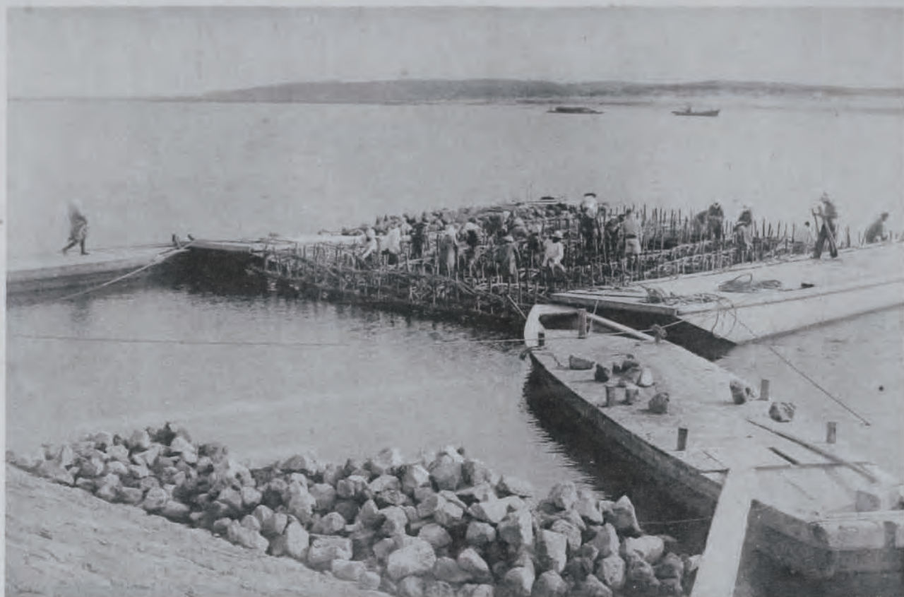
(3) 最上川改修工事沈床沈設作業(第三宮野浦護岸) (山形縣西田川郡袖浦村大字宮野浦地先)
