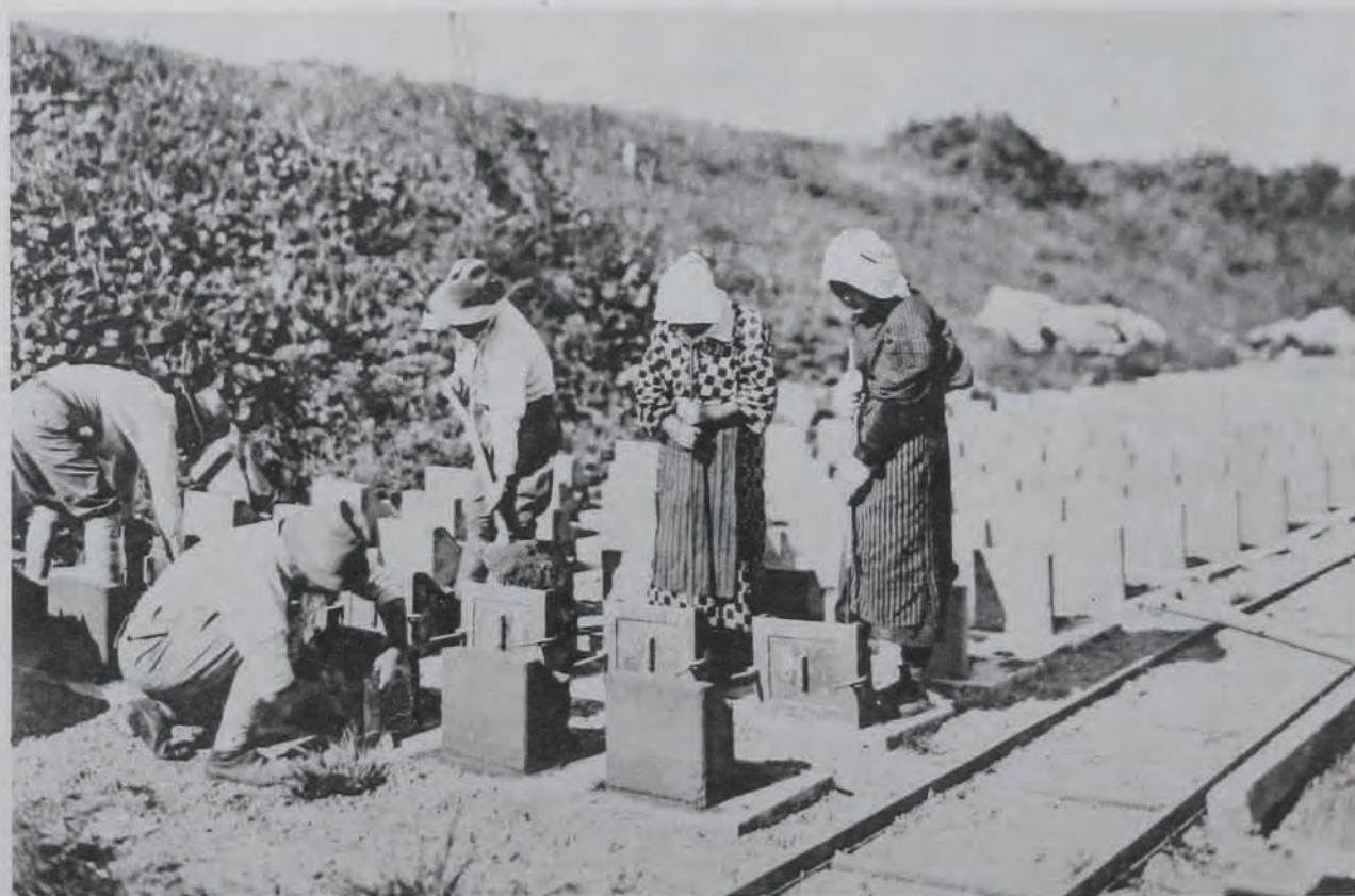
(12) 木津川改修工事ブロック製作 左岸築堤裏法護岸用混凝土ブロック製作状況 (京都府綴喜郡八幡町地先)
