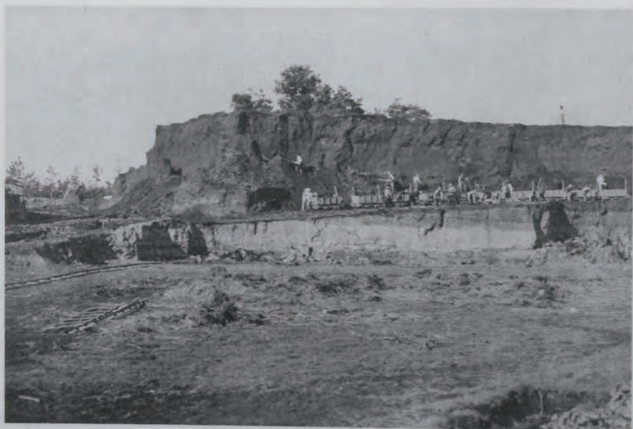
(36) 國道三十六號線改良工事池上土工土取場ノ狀況 (東京市大森區馬込町西二丁目地先)
