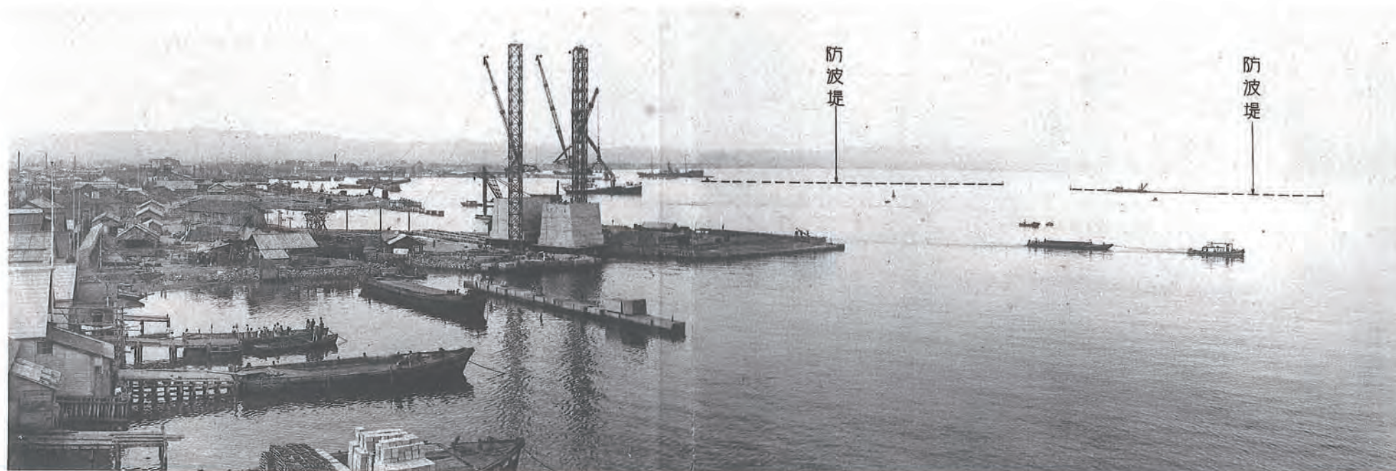
(2) 青森港修築工事全景 (青森市新濱町地先)
