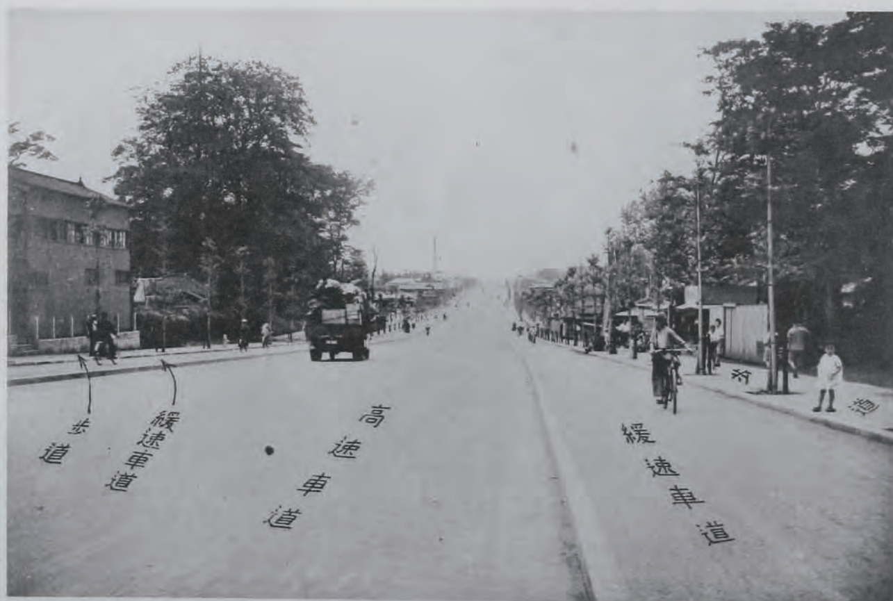
(34) 國道九號線改良工事高速、緩速兩車道高低分離竣功 高速車道十二米、緩速車道各三米五〇、歩道各三米 (東京市板橋區板橋町八丁目地先)
