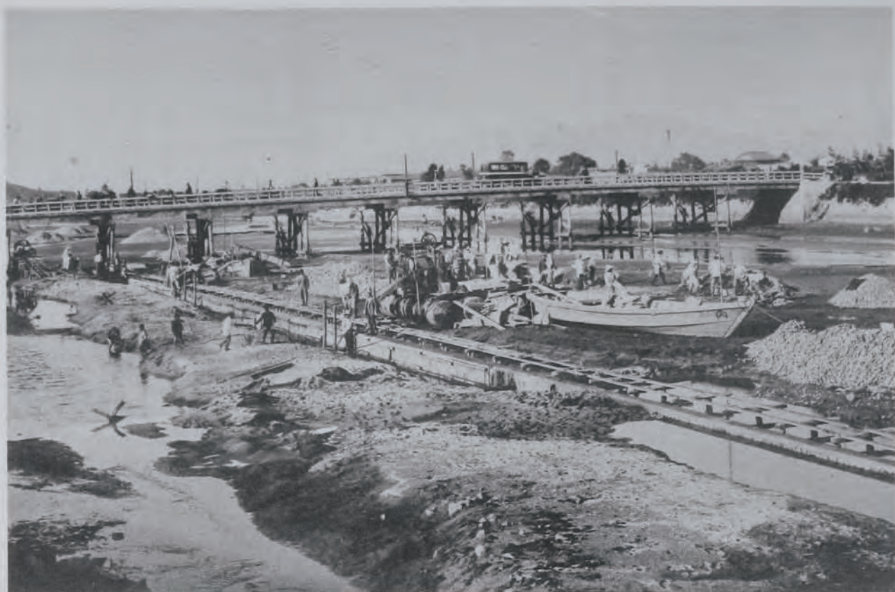
(13) 太田川改修工事護岸混凝土施行實況
