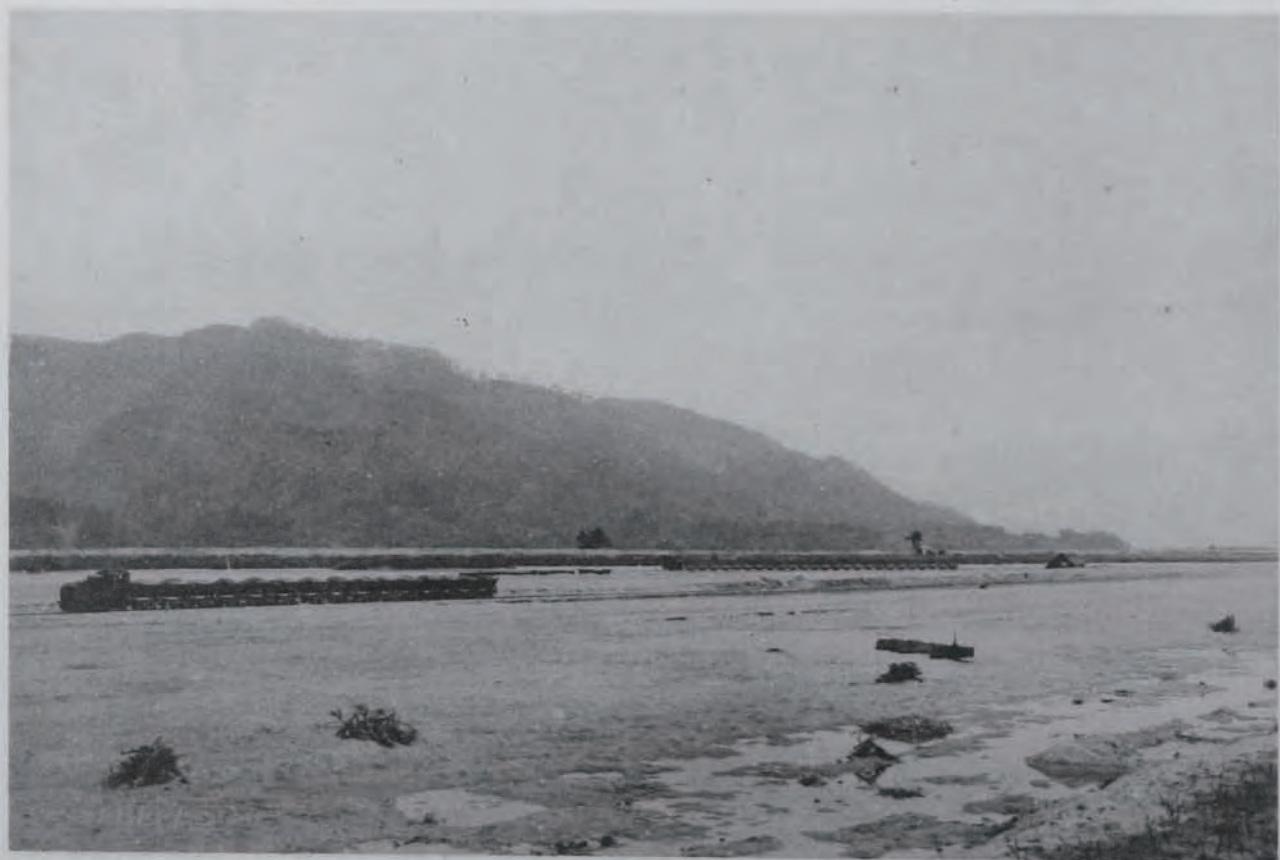
(8) 斐伊川改修工事人力掘鑿新堤敷捨土狀況
