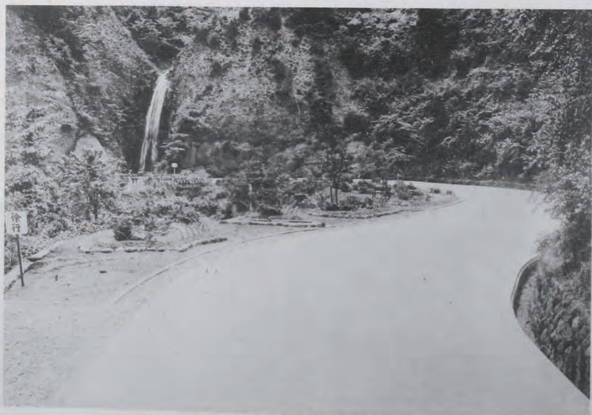
(22) 國道一號線(箱根)改良工事竣功セル鋪装 (神奈川県足柄下郡温泉村大字大平臺地内蛙ノ瀨附近)
