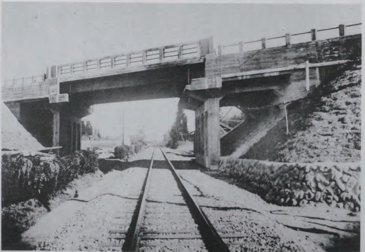
(24) 國道四號線(栃木)改良工事竣功セル薄葉橋 (栃木縣那須郡野崎村地内)
