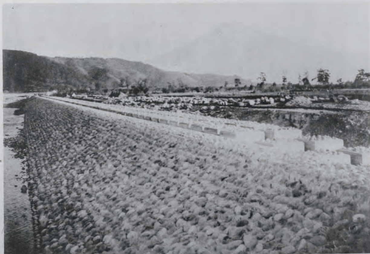
(4) 富士川改修工事堤外護岸 (静岡縣富士郡岩松村地内) 玉石張護岸延長四百四十米、混凝土ブロック Aハ長一米六、 幅一米六、厚八十厘米 Bハ長一米六、幅一米六、厚六十厘米
