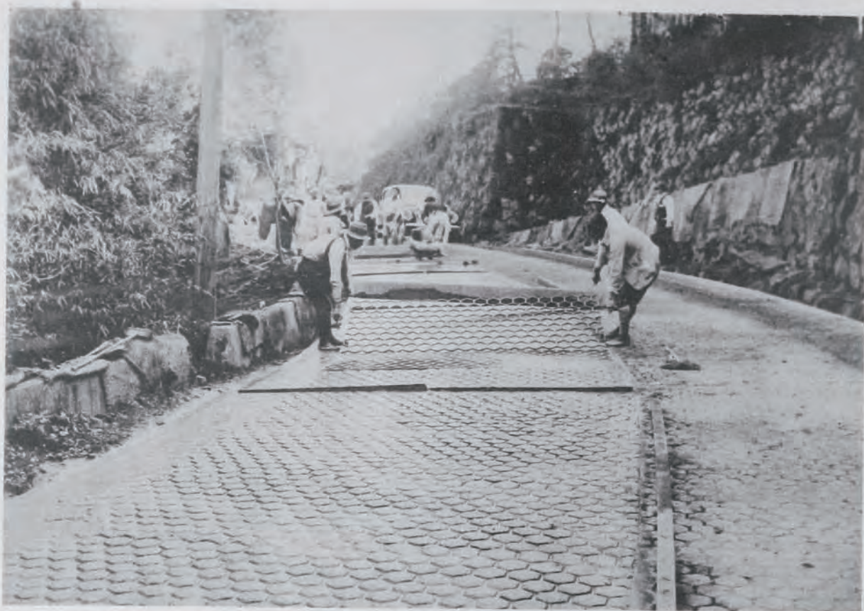
(21) 國道一號線(箱根)改良工事施行中路面工 (神奈川県足柄下郡温泉村大字大平臺地内) セメント、混凝土鋪装滑止(龜甲型)
