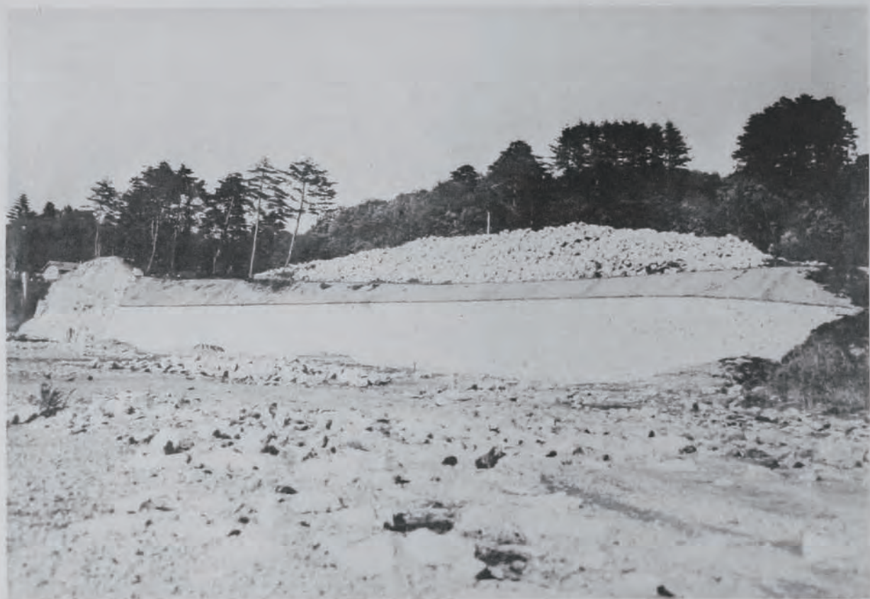
(7) 阿武隈川改修工事小和瀧護岸 (福島縣田村郡逢隈村地内) 幹川筋右岸空石積施工
