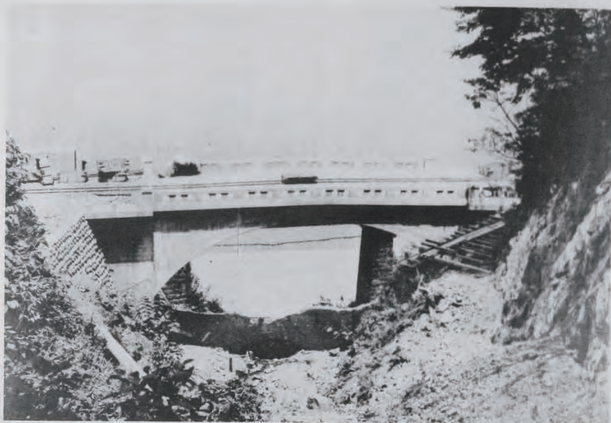
(27) 國道十一號線(親不知)改良工事竣功セル宗尻川橋 (新潟縣西頸城郡市振村地内)
