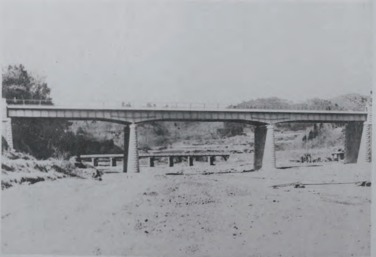
(26) 國道八號線(山梨)改良工事竣功セル舊川橋 (山梨縣北都留郡上野原町、同巖村地内) 三徑間連續電弧熔接鋼鈑桁
