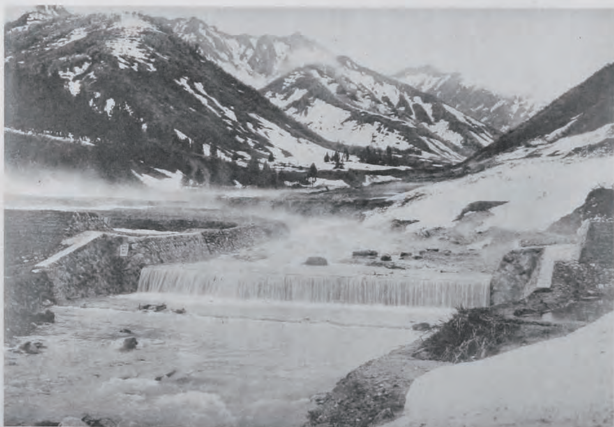
(16) 信濃川支川魚野川砂防工事竣功セル一之澤川第一堰堤 (新潟縣南魚沼郡上田村大字一之澤地内)
