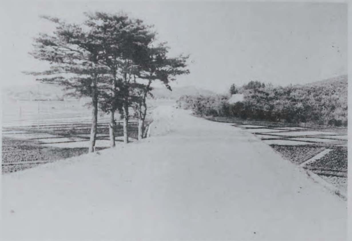
(25) 國道四號線(宮城)改良工事竣功セル混凝土舗装 (宮城縣黒川郡大街村地内) 大街村ヨリ三本木町方面ヲ望ム、有効幅七米五、舗装中央六米
