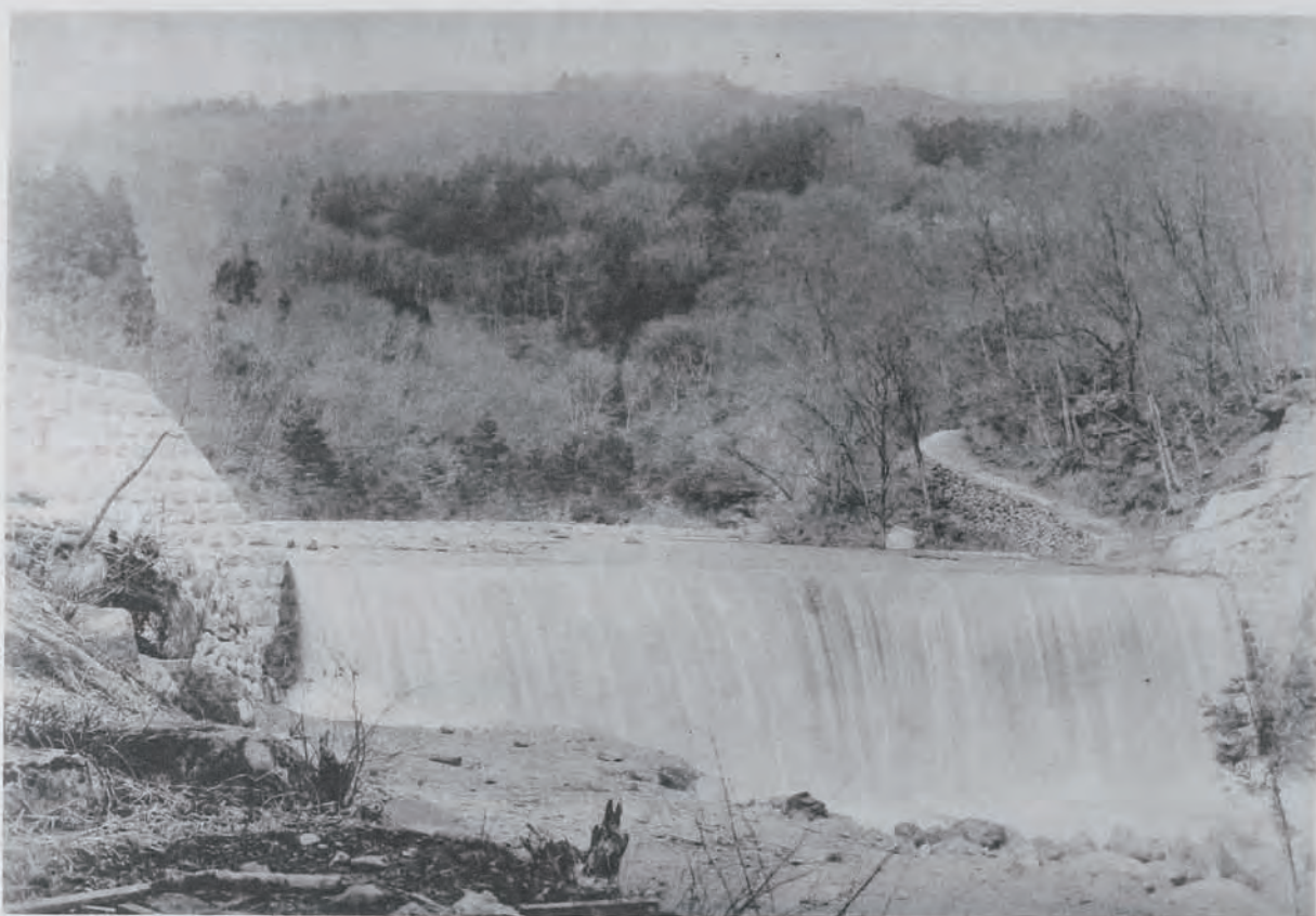
(15) 阿武隈川支川荒川砂防工事荒川第一堰堤 (福島縣信夫郡土湯村地内)
