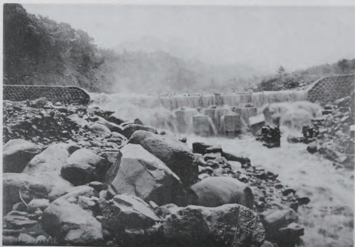
(14) 鬼怒川小支川稻荷川砂防工事天狗澤堰堤 (栃木縣上都賀郡日光町地内) 堰堤高六米、長八十六米、幅二米、根留護岸全長六十六米
