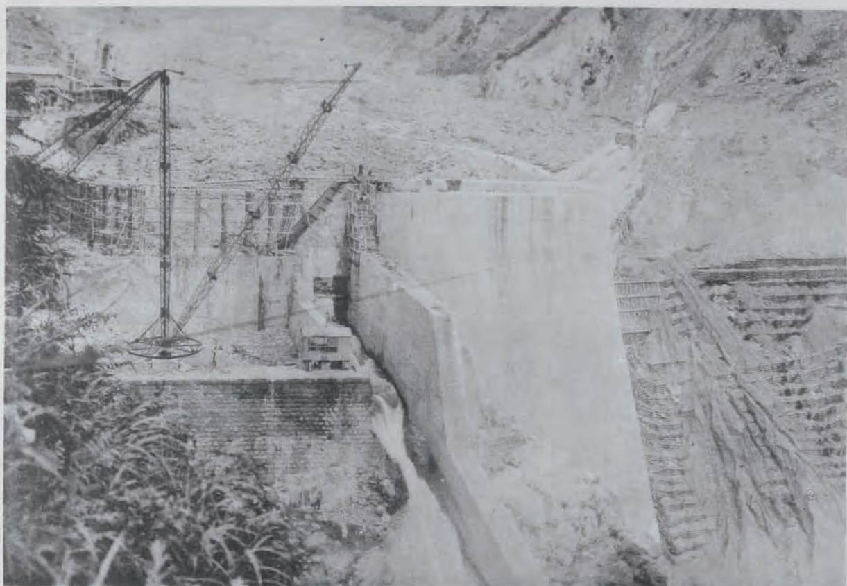
(11) 常願寺川砂防工事白岩堰堤全景 堰堤左岸袖部ト第一導水堤繼混凝土工ヲモ示ス
