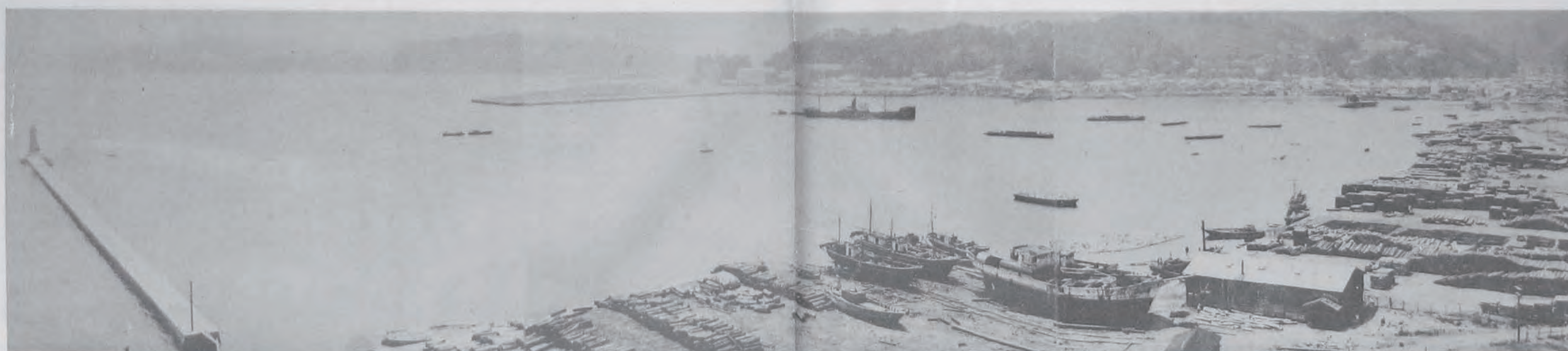
(2) 竣工セル宮古港修築工事全景 (岩手縣下閉伊郡宮古町地先)
