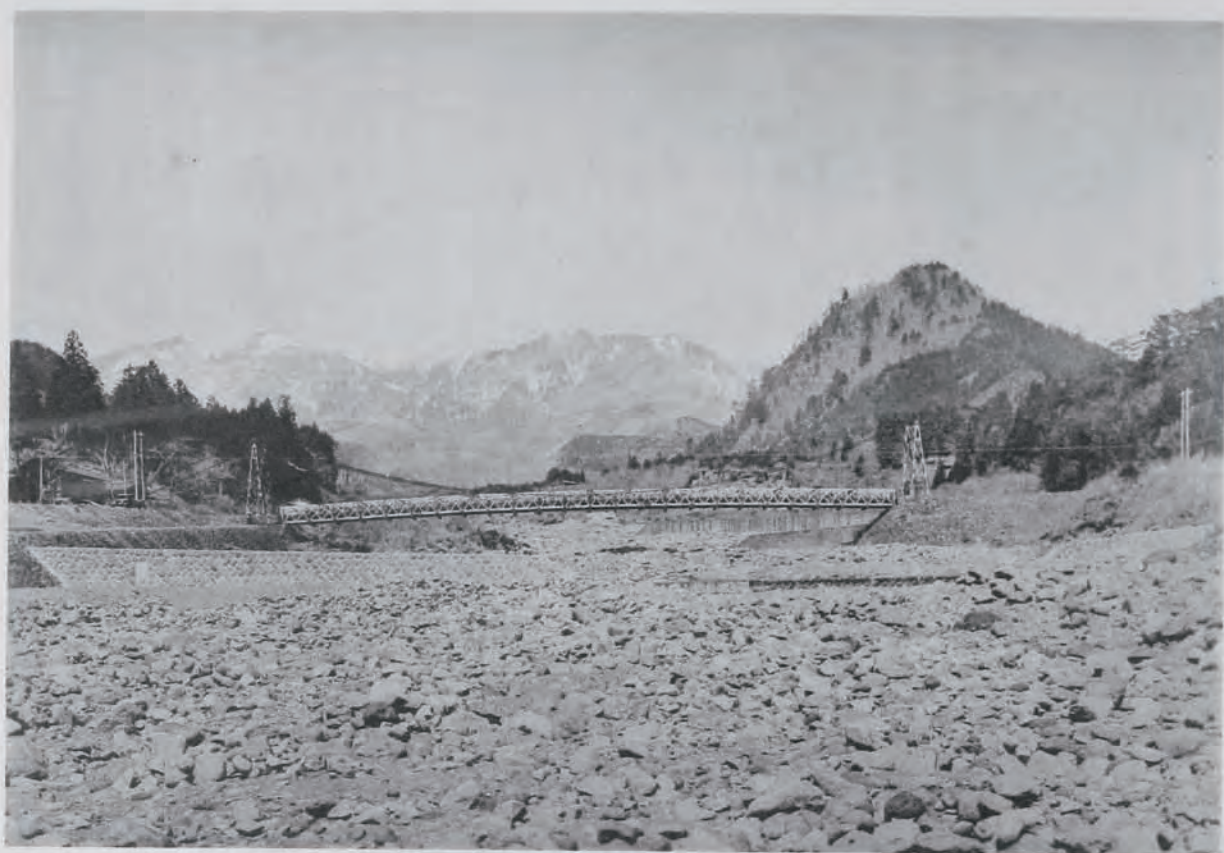
(13) 鬼怒川小支川稻荷川砂防工事第五床固 (栃木縣上都賀郡日光町地内) 床固ノ高四米、長七十八米、幅二米六、右翼三十七米
