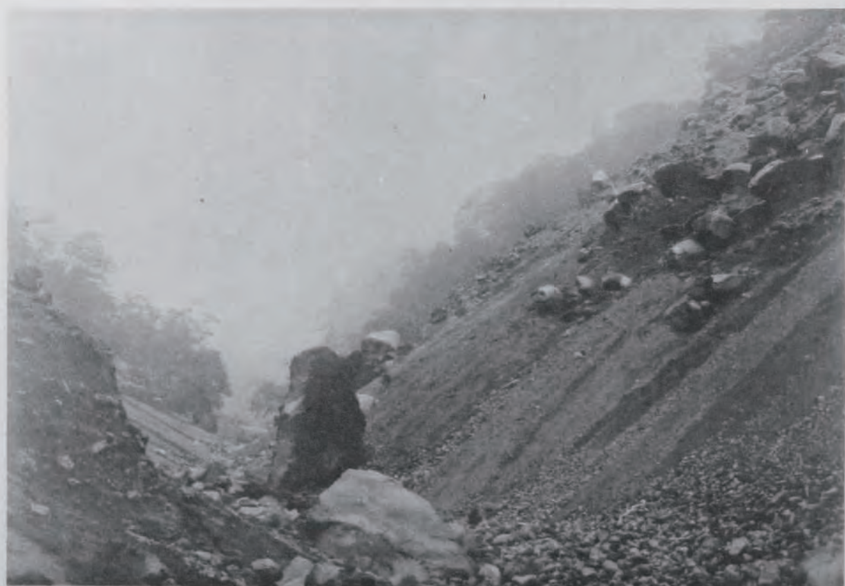
(12) 鬼怒川支川大谷川砂防工事被害状況 (栃木縣上都賀郡日光町地内深澤大薮中腹) 一雨アラバ兩岸砂礫、巨石等夥シク流出ス
