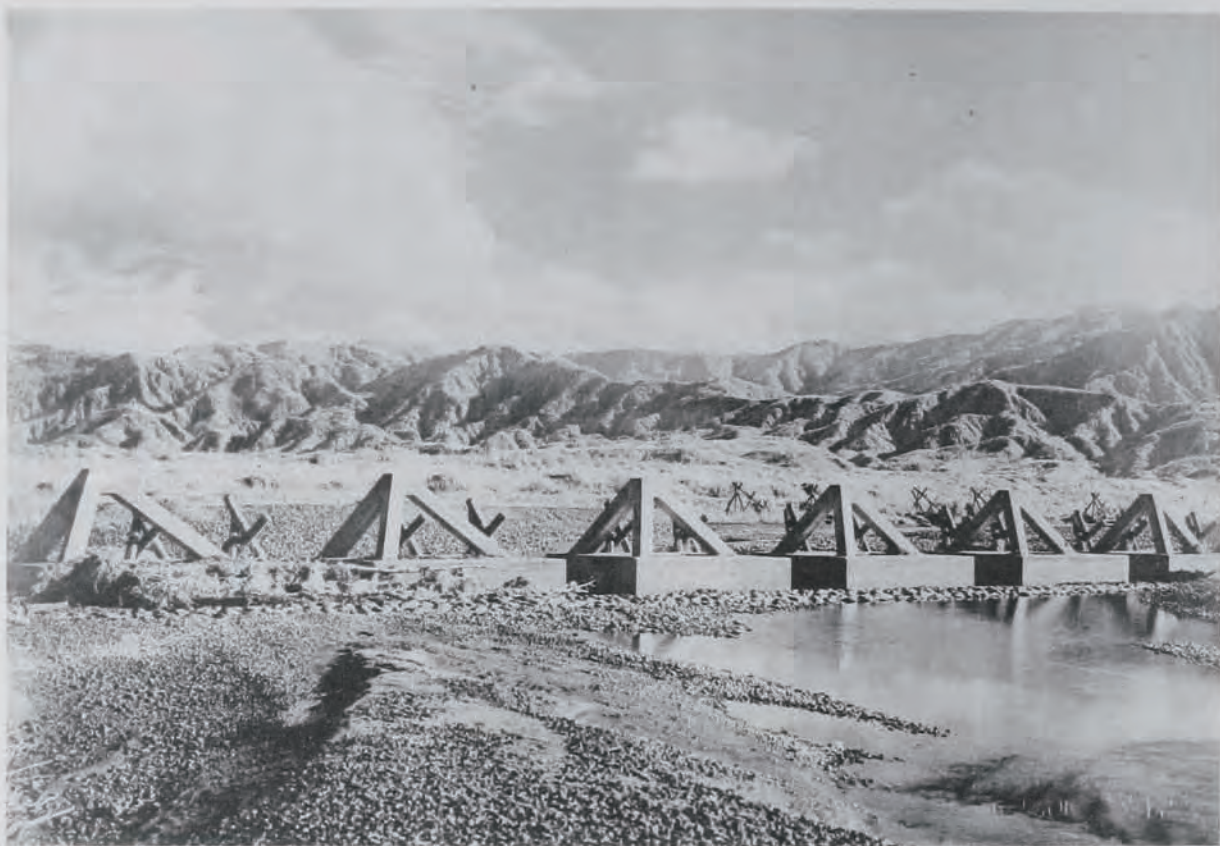
(5) 富士川改修工事白井河原水制
