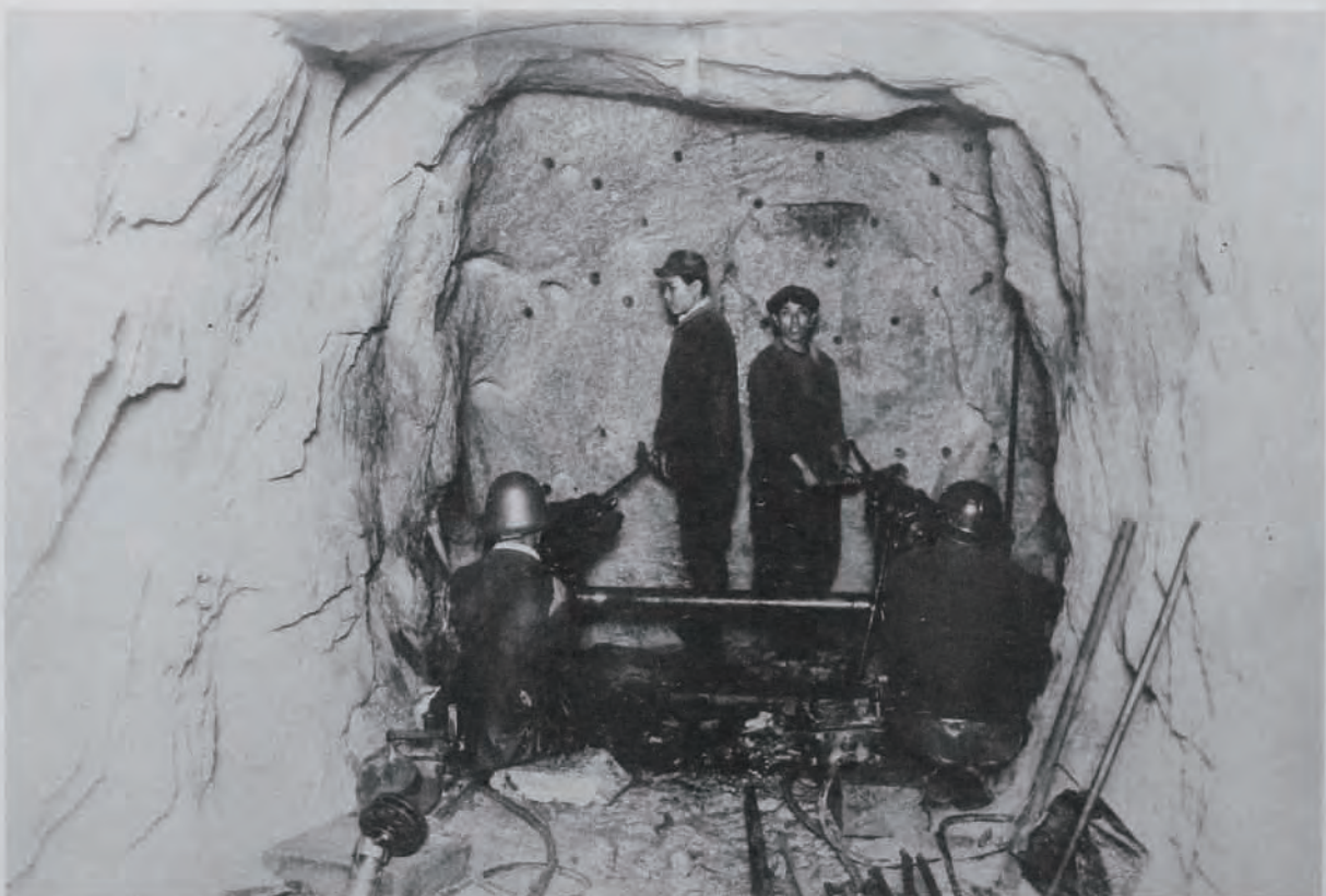
(6) 國 道 三 十 二 號 線 改 良 工 事 隧 道 工
