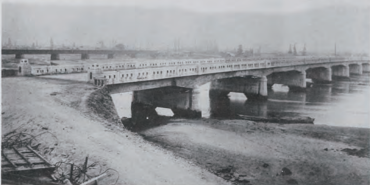
(5) 國 道 二 號 線 改 良 工 事 橋 梁 工
