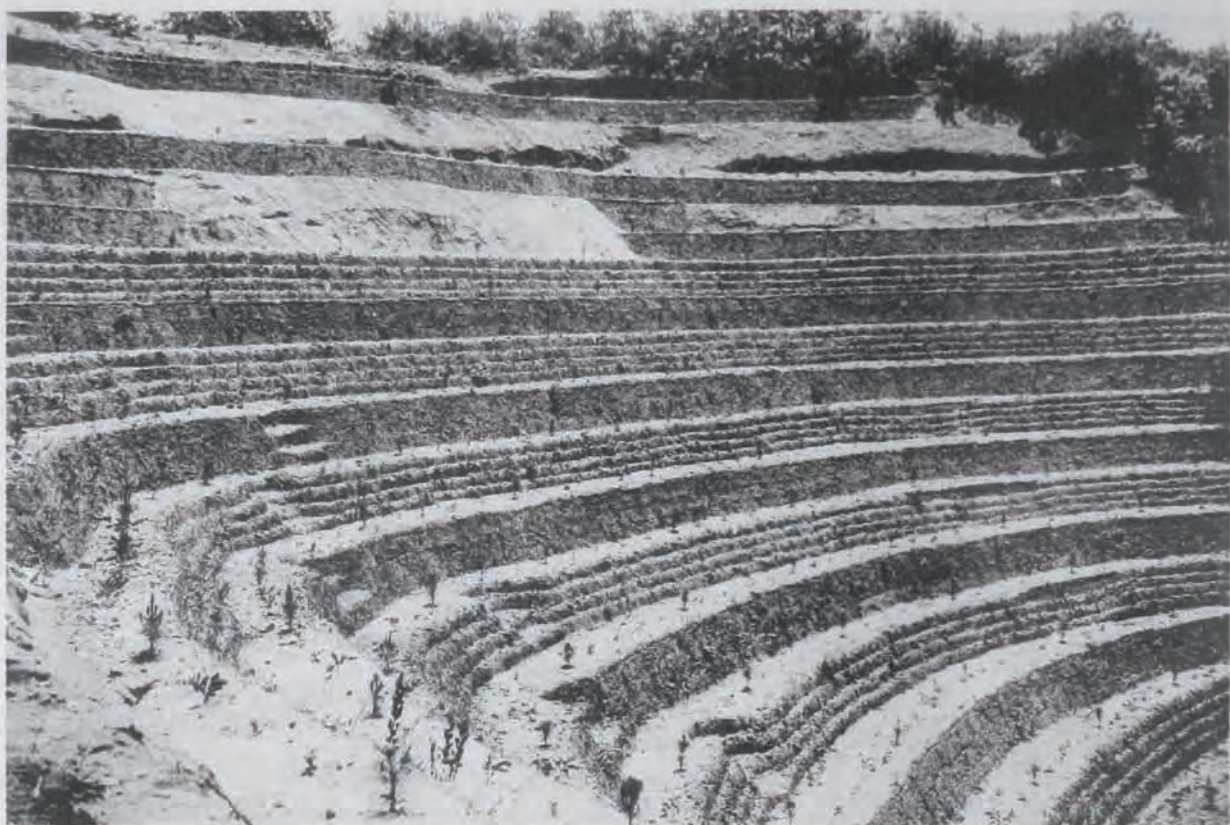
(3) 淀川流域(木津川)砂防工事山腹工
