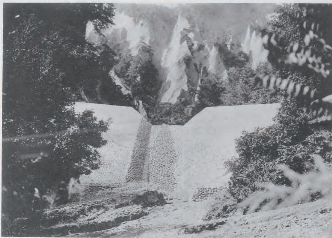
(14) 千曲川流域砂防工事木澤第十八號堰堤 (長野縣北安曇郡陸鄉村地先) 堰堤上長二十七米・下長十三米七・高九米二・水通上長六米五・下長三米五・高二米五
