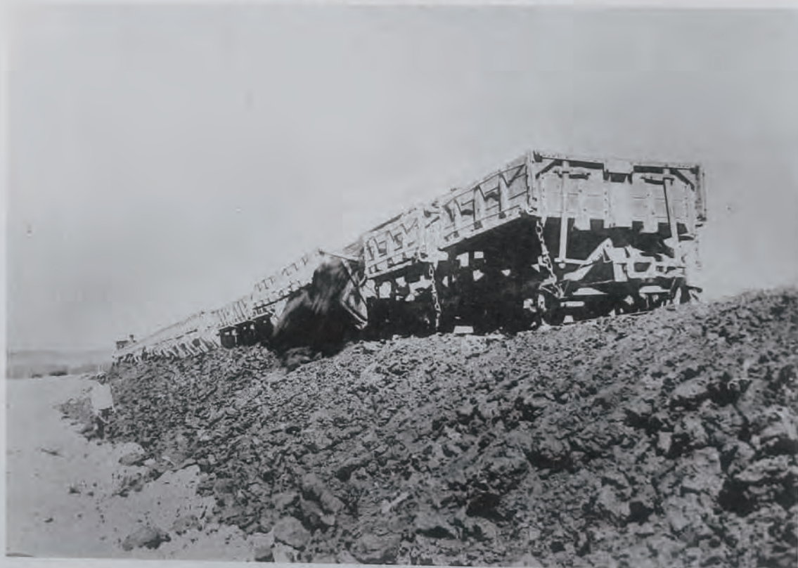
(13) 千代川改修工事機械掘鑿土捨作業 (鳥取縣氣高郡千代水村地先) 土運車ハ米國製兩側開ダンプカーニシテ容量三立方米ハ
