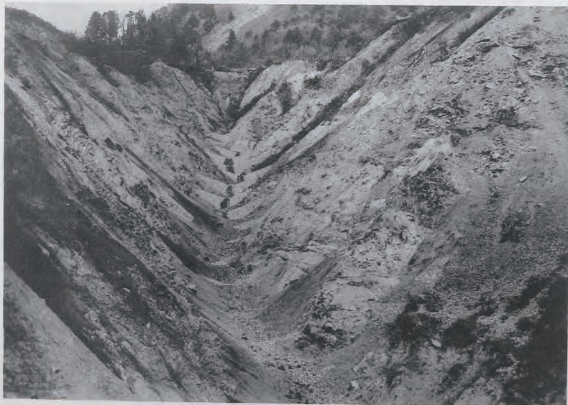
(15) 神通川流域砂防工事六郎谷石堰堤 (岐阜縣吉城郡船津町地先) 數多ノ石堰堤及谷止石積ヲ施工ス
