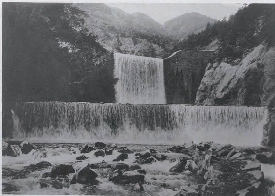
(17) 早川流域震災復舊砂防工事田山堰堤
