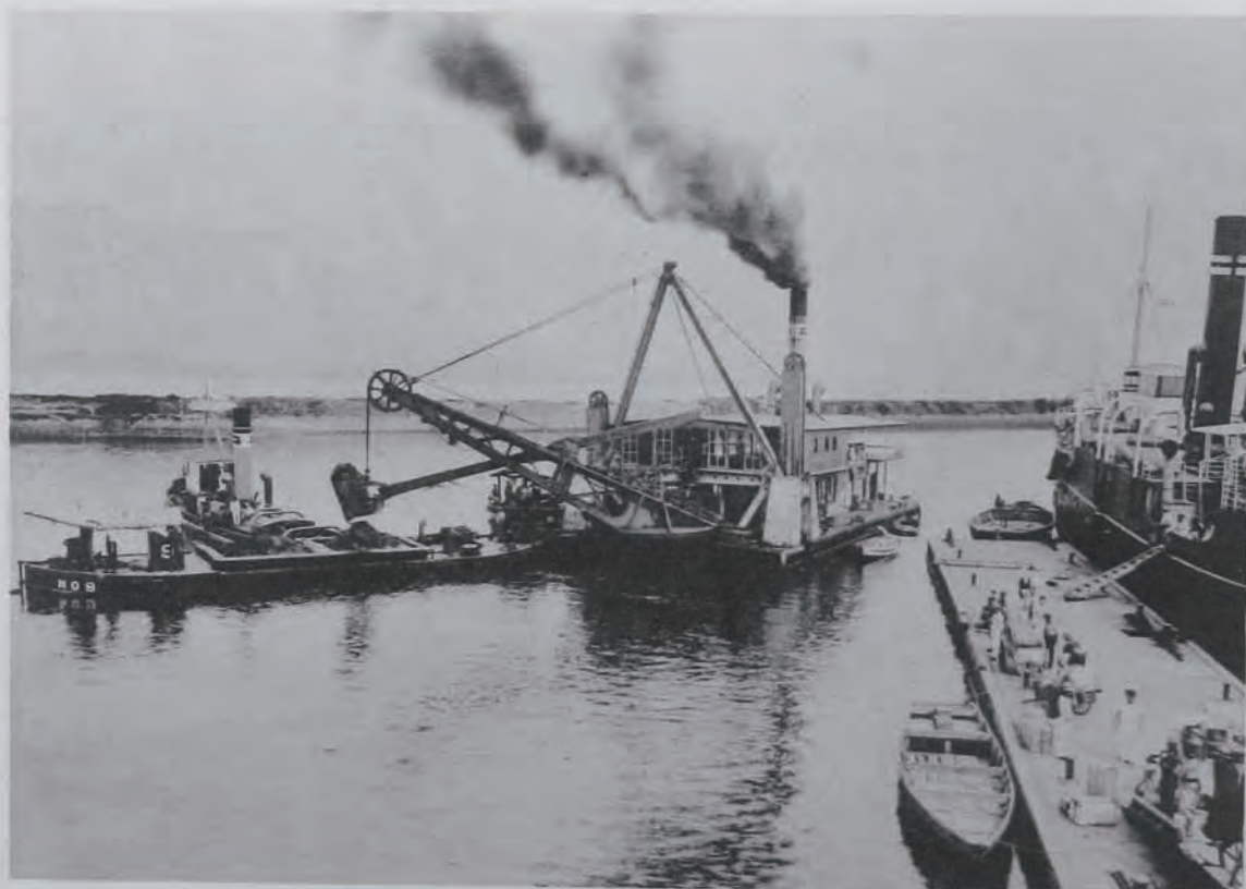
(27) 鹿兒島港修築工事機械浚漂 杓揚浚漂船能力一時間百立方米・長三十米・幅十一米五・ 船首深二米六・船尾深二米三・前方ニ見ニルハ櫻島ナリ
