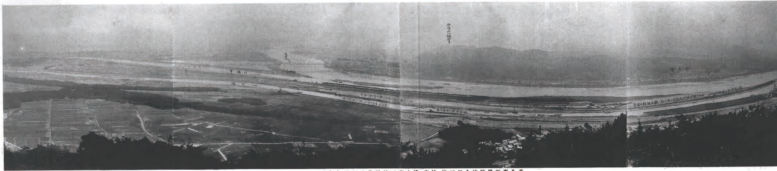
(1) 淀川改修増補工事木津、宇治、桂三川合流、附換工事全景 大山崎天王山ヨリ對岸橋本町八幡山及其上流ヲ望ム
