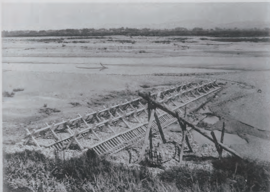
(9) 富士川改修工事藤田水制 (山梨縣中巨摩郡藤田村地先) 鐵筋混凝土材合掌杵二列布設・水制長三十二米
