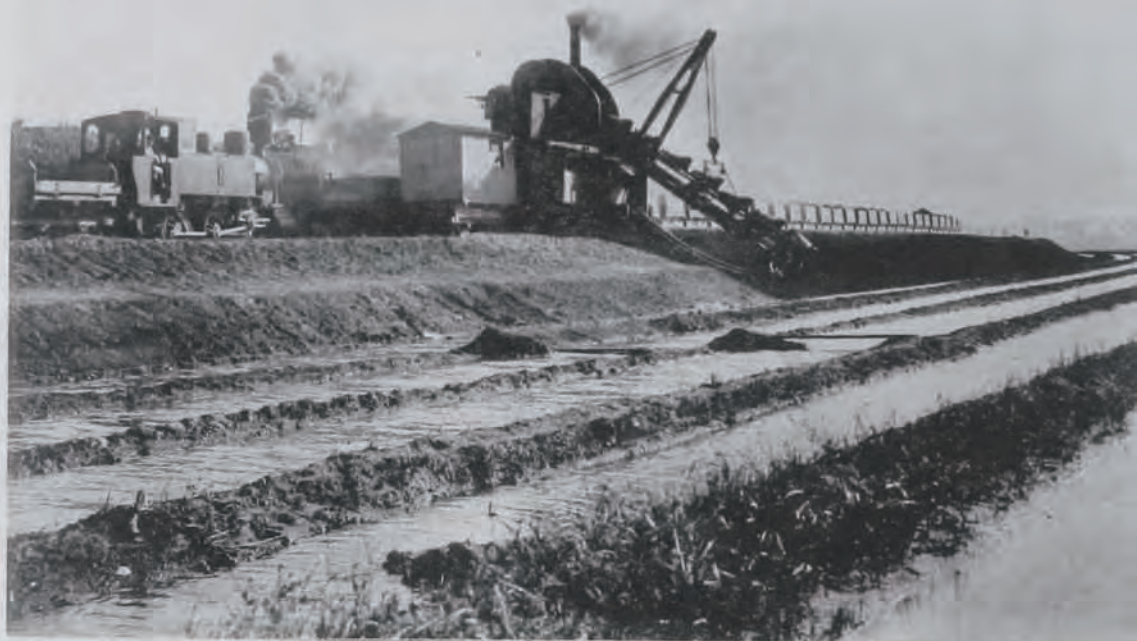
(12) 筑後川改修工事機械掘鑿 (福岡縣三潁郡安武村地先) 掘鑿機能力一時間百二十立方米・二十瓩機關車 ヲ使用シ三立方米積土運車三十臺餘ヲ牽引ス
