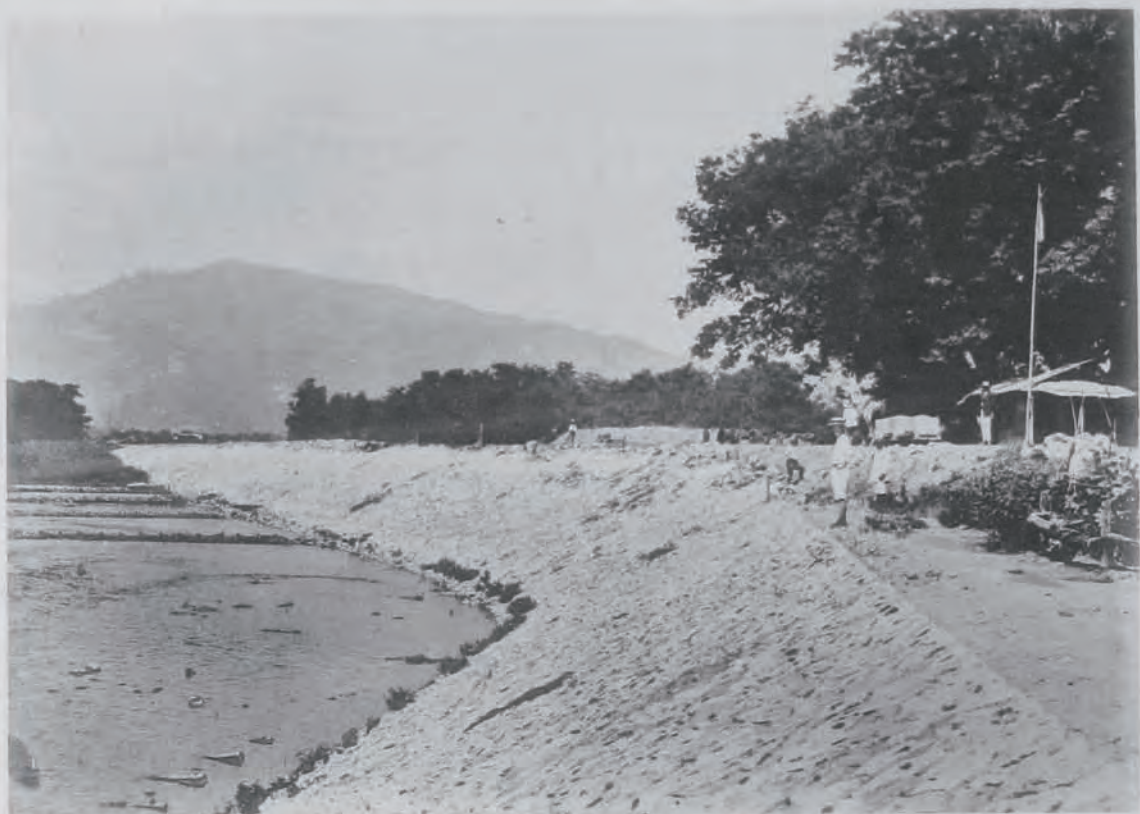
(8) 千曲川改修工事石張護岸 (長野縣更級郡鹽崎村地先) 築堤ノ一部ハ河身内ニ築設スルタメ 木工沈床・杭柵水制及石張ヲ施行ス
