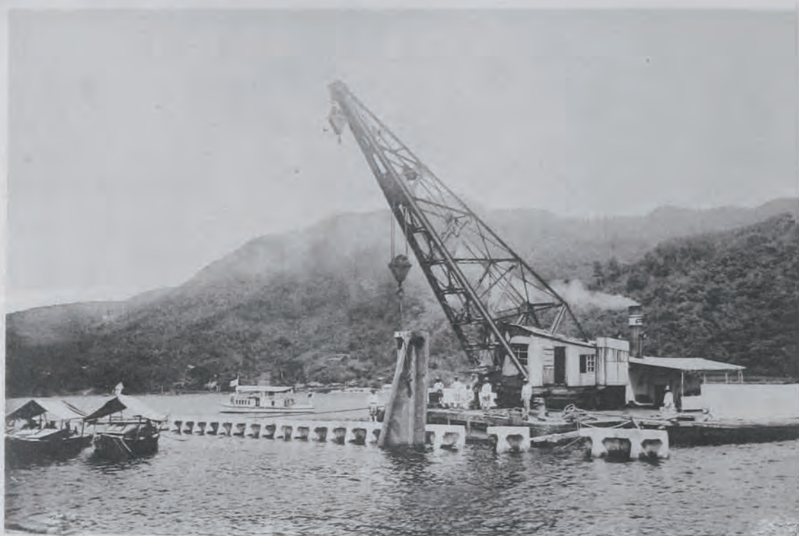
(26) 境港修築工事五米五岸壁用塊据付 塊高七米三・長一米五・底幅四米三・塊天端干潮位上一米五
