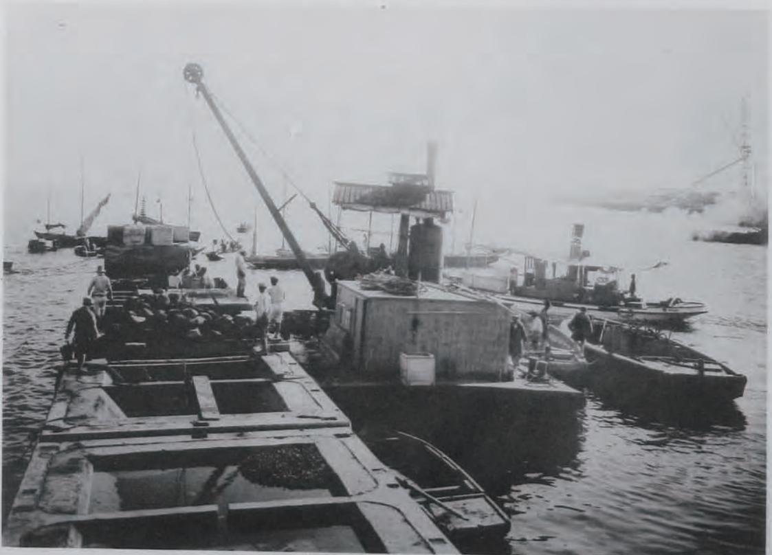
(28) 鹿兒島港修築工事北防波堤ケーソン混凝土填充作業
