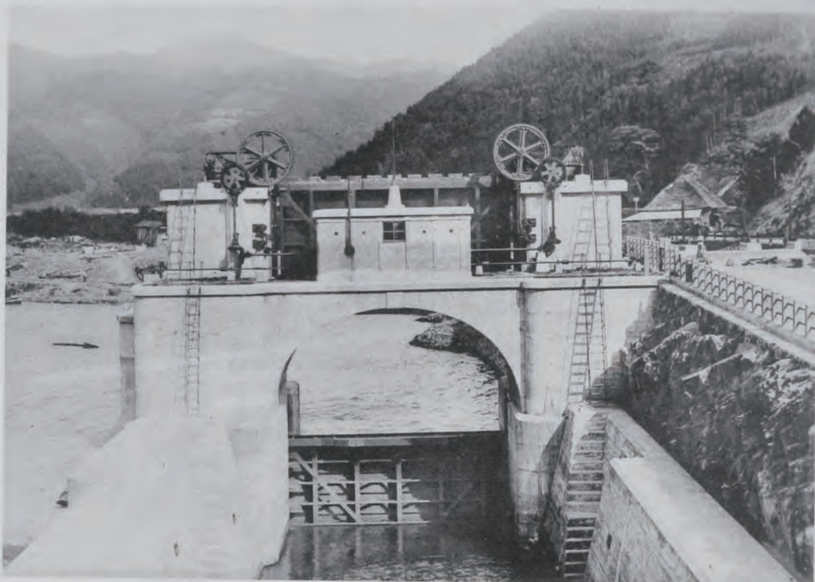
(5) 北上川改修工事協谷閘門
