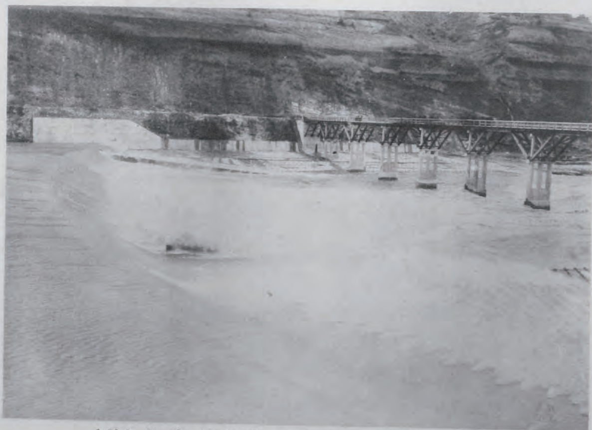
(30) 信濃川補修工事第二床固阻柱 (新潟縣西蒲原郡國上村字渡部地先) 昭和六年三月二十一日出水狀況
