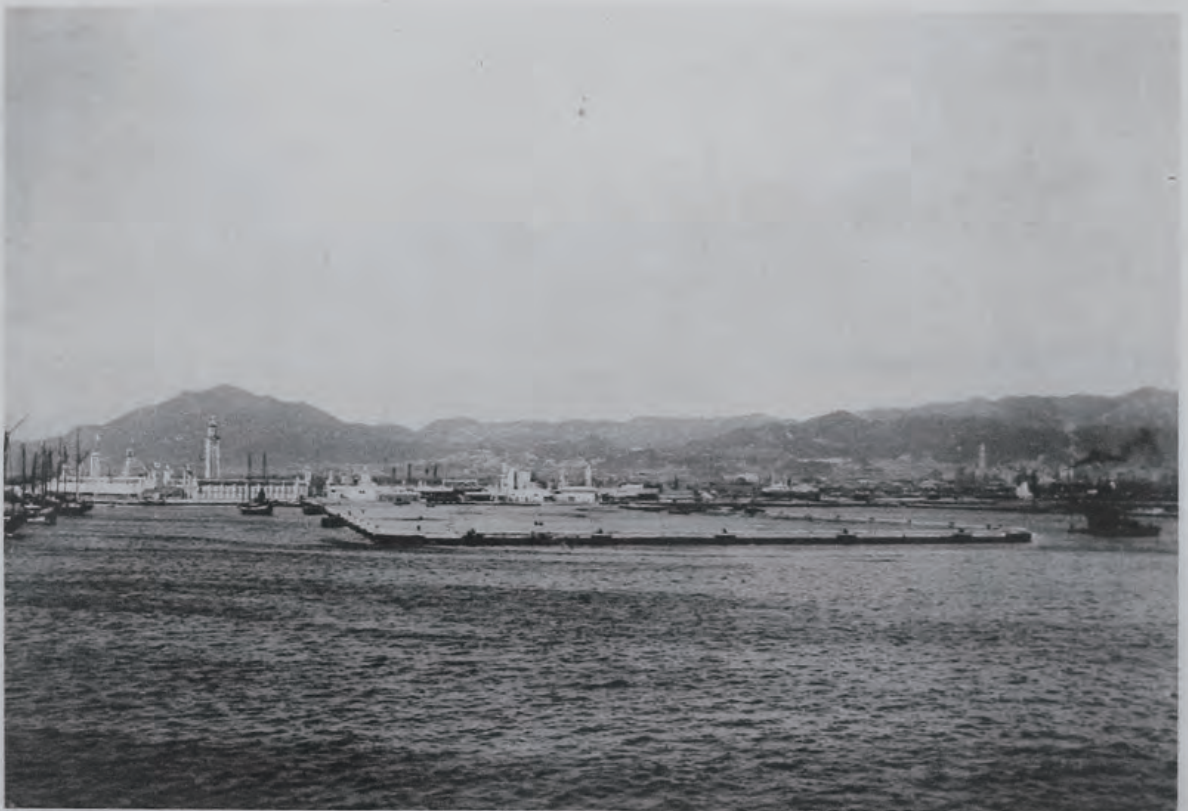
( 24 ) 神戶港修築工事兵庫第二突堤
