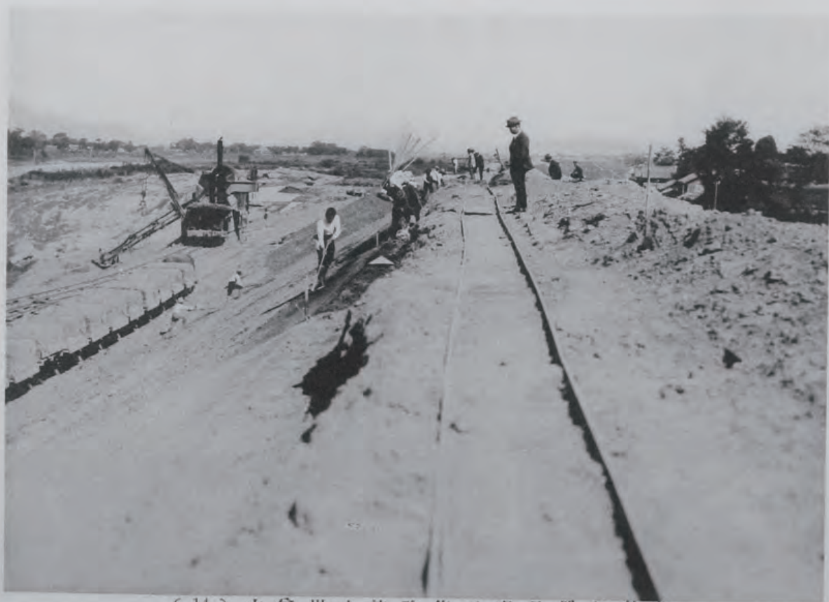
(14) 木曾川上流改修工事日置江築堤 (岐阜縣稻葉郡日置江村地先)
