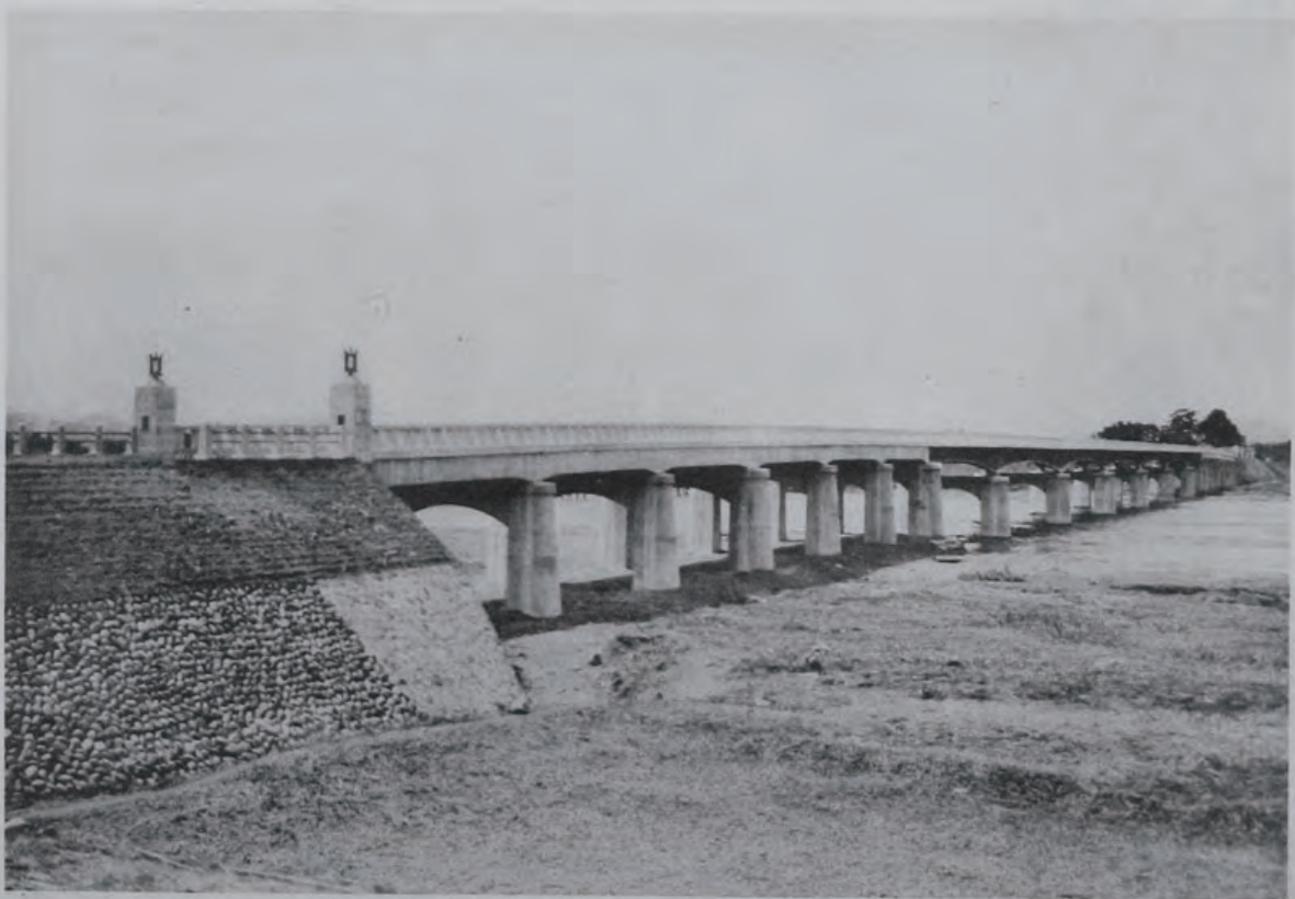
( 10 ) 最上川改修工事支川赤川筋三川橋 (山形縣鶴岡市大字大寶寺地先)
