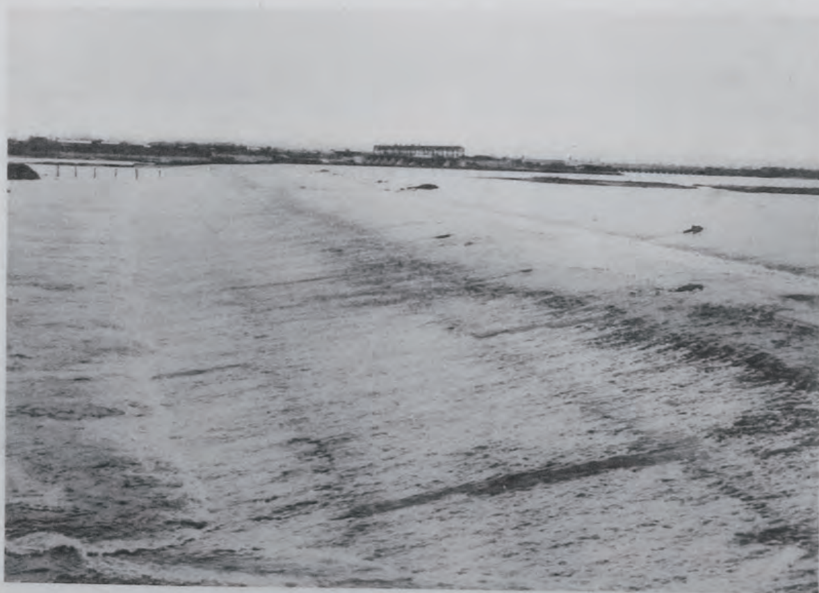
(28) 信濃川補修工事固定堰 (新潟縣三島郡大河津村大字川津地先)
