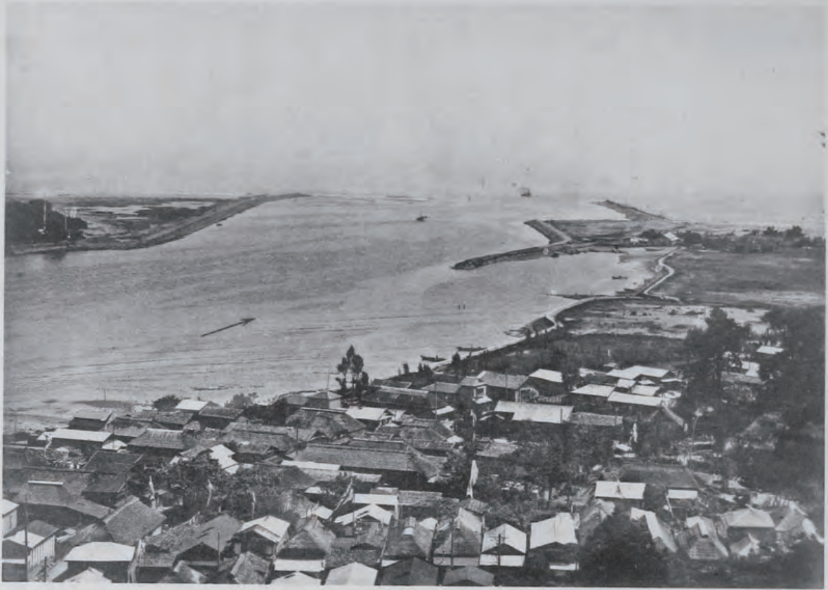
( 7 ) 北 上 川 改 修 工 事 河 口 突 堤 (宮城縣牡鹿郡石巻町地先)
