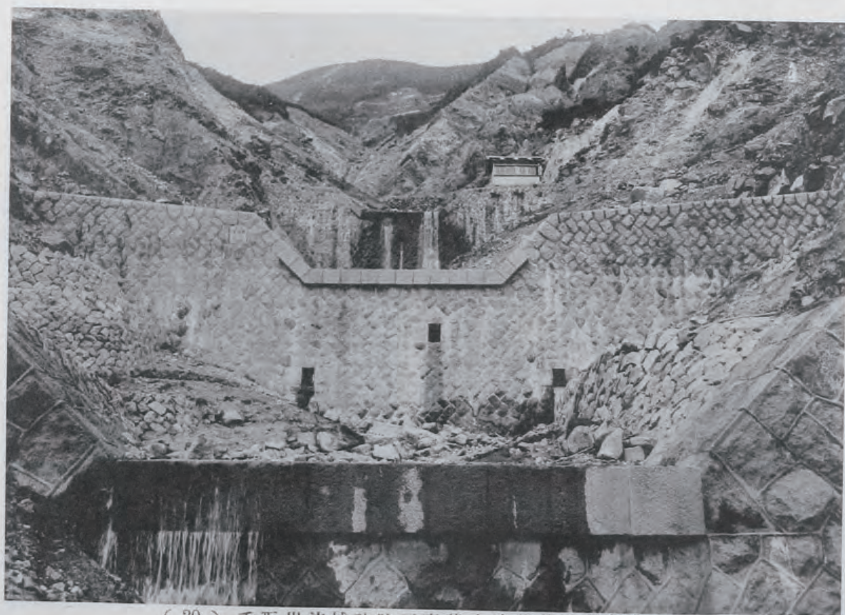
( 20 ) 手取川流域砂防工事甚之助谷第九號堰堤 (石川縣能美郡白峰村地先) 全長三十二米、立積六百九十立方米
