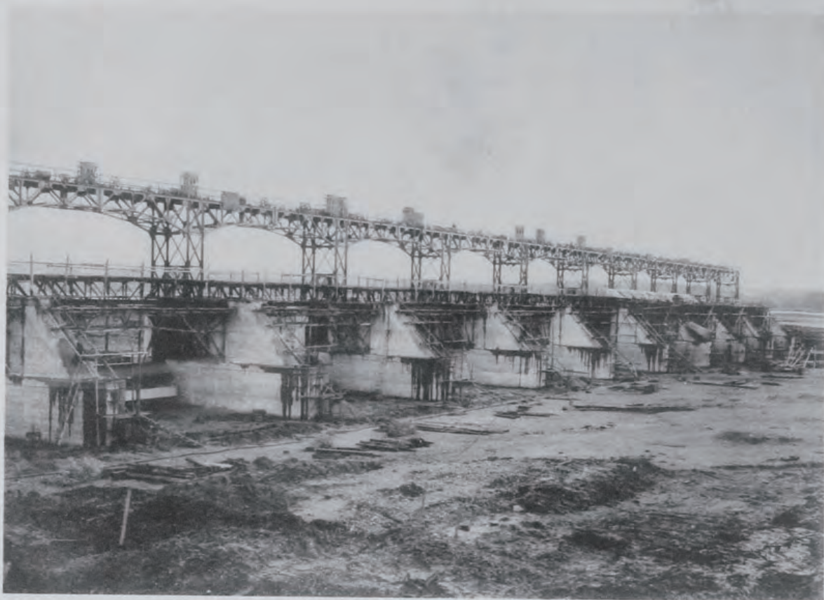
(27) 信濃川補修工事可動堰 (新潟縣三島郡大河津村大字川津地先)
