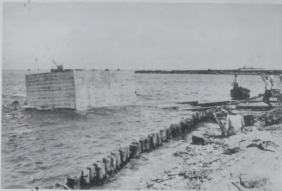
(11) 神通川改修工事東突堤頭部用浮函ノ進水 (富山縣上新川郡東岩瀬町地先) 浮函長七米、幅三米五、高二米五
