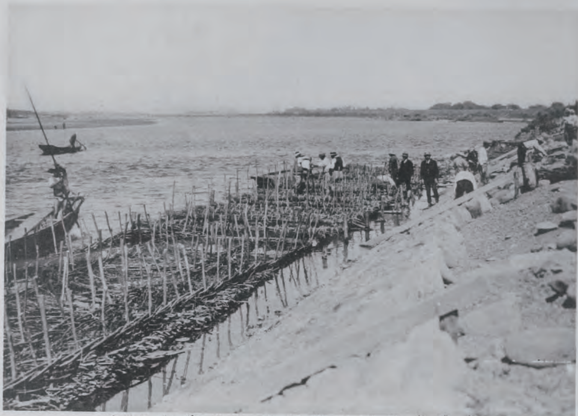
(13) 木曾川上流改修工事福壽護岸 (岐阜縣羽島郡福壽村地先) 法面石張、根固單床
