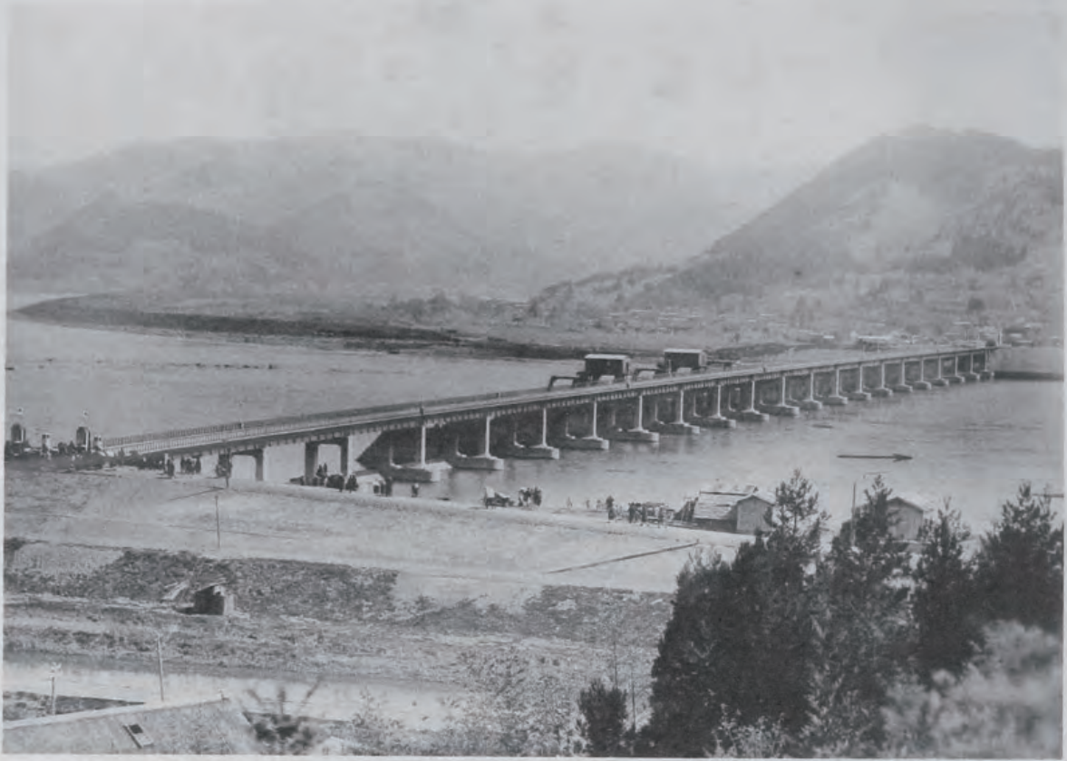
( 3 ) 北上川改修工事飯野川可動堰全景
