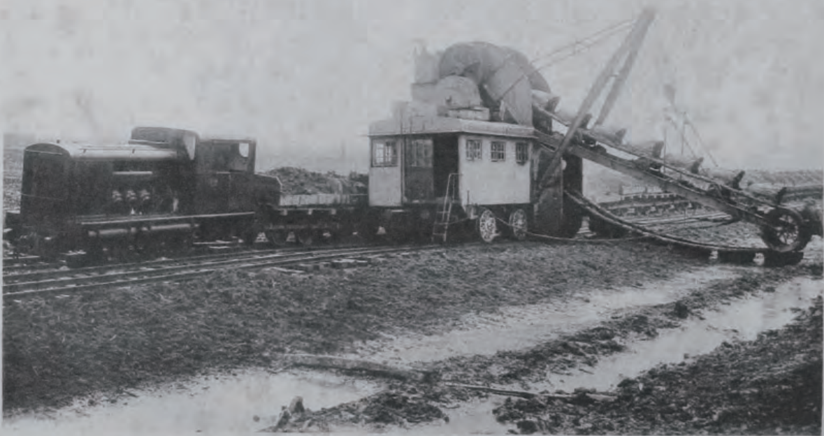
( 2 ) 荒川上流改修工事ディーゼル掘鑿機及機關車操業狀況
