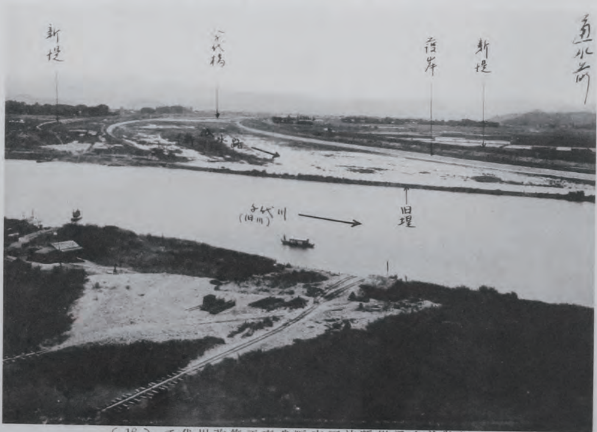
(16) 千代川改修工事鳥取市下流新川通水前狀況
