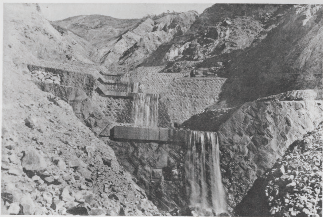
( 11 ) 手取川流域砂防工事甚之助谷堰堤 (石川縣能美郡白峯村地先)
