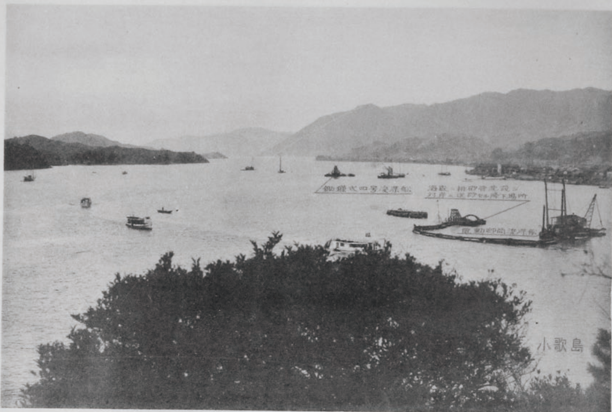
( 19 ) 尾道港修築工事浚渫作業 (小歌島ヨリ西方ヲ望ム)
