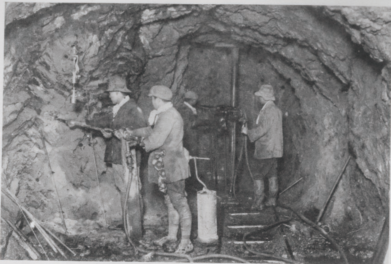
( 5 ) 木曾川上流改修工事忠節用水路隧道掘鑿 ( 岐 阜 縣 岐 阜 市 地 先 )
