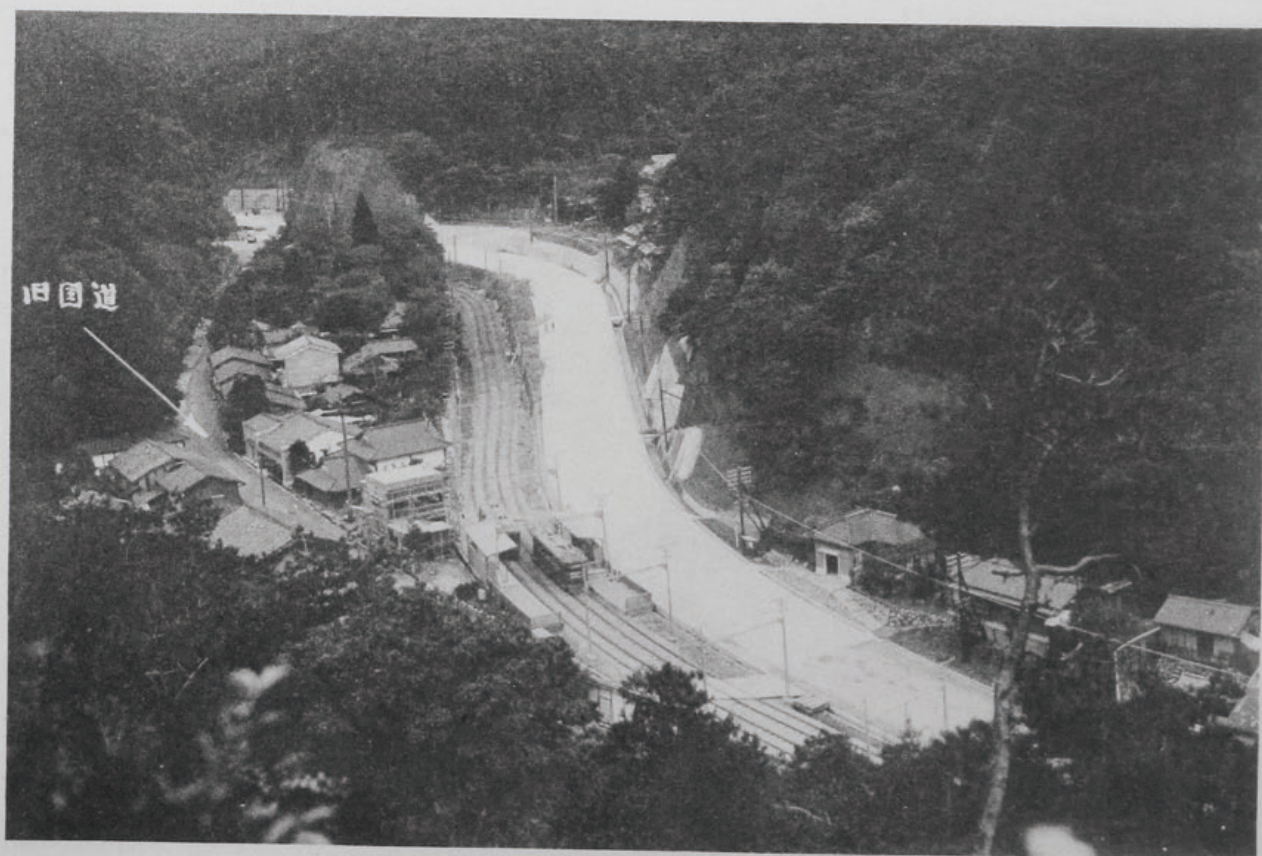
( 26 ) 國道二號線(滋賀)改良工事新設道路 (滋賀縣大津市大谷町地内)
