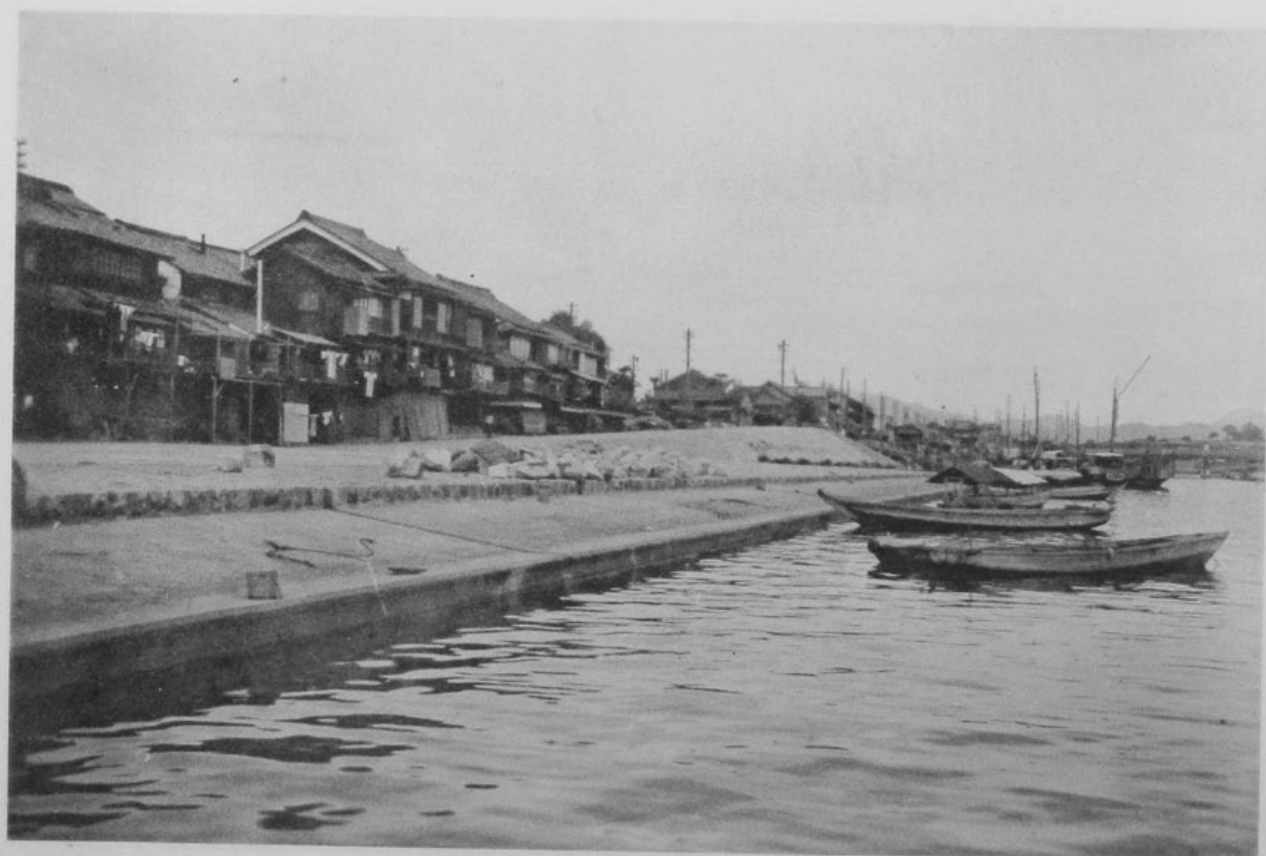
( 8 ) 旭川改修工事護岸及物揚場 (岡山市京橋下流) 鐵筋混凝土矢板長五米五、幅二十五呎、厚二十呎
