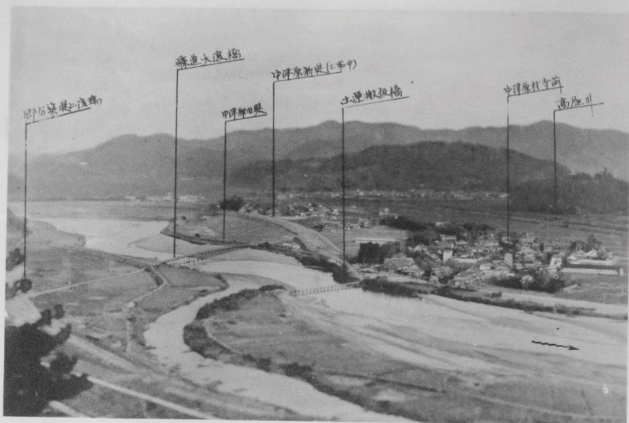
( 7 ) 蘆田川改修工事中津原築堤 (廣島縣深安郡中津原村地先)
