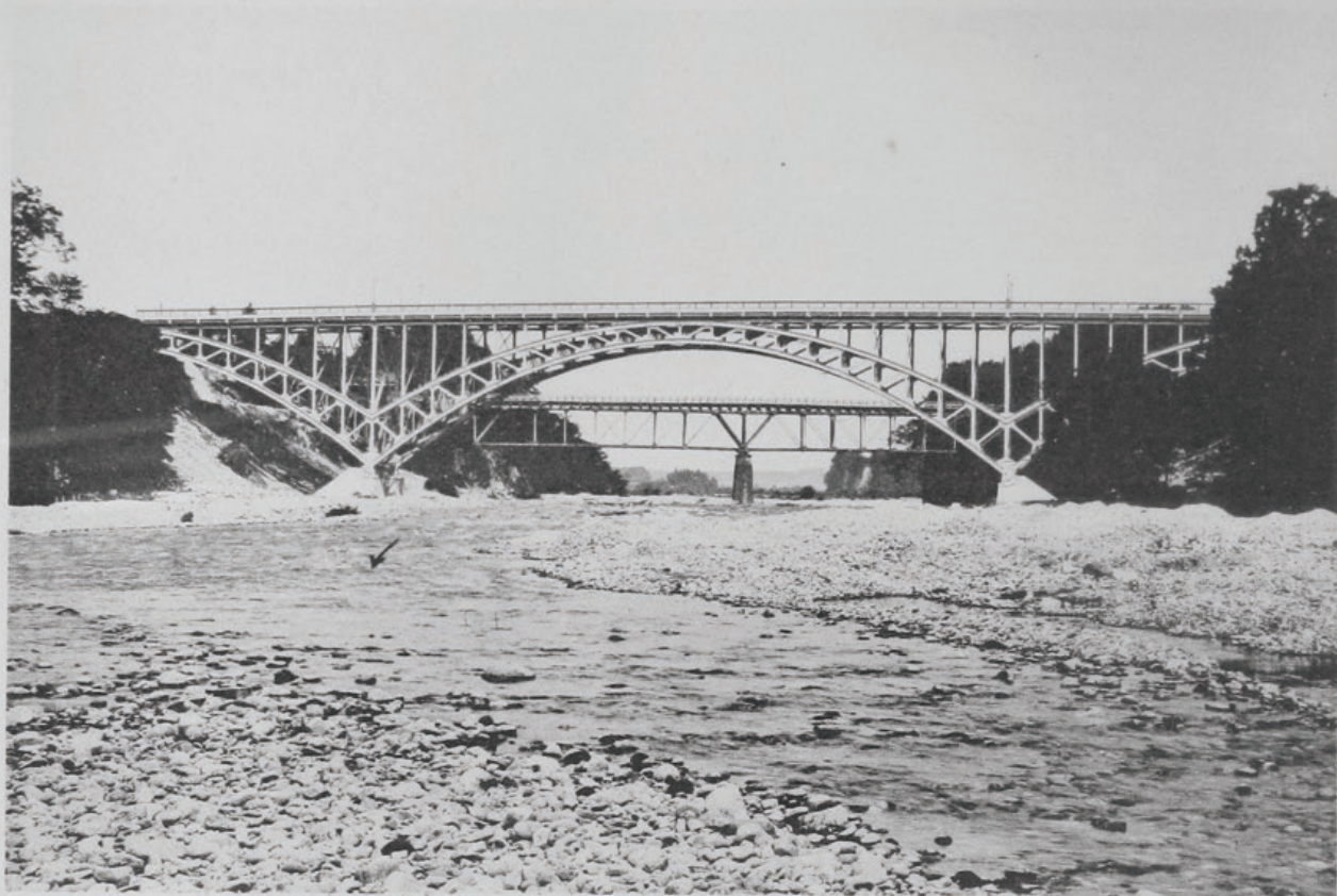
( 31 ) 國道四號線(黑磯)改良工事晚翠橋 (栃木縣那須郡黑磯町地内)
