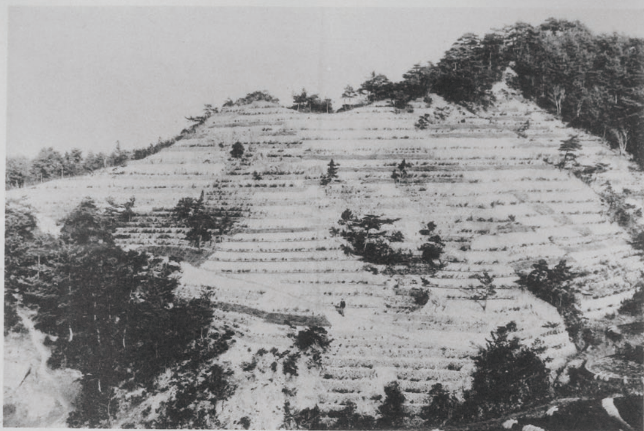
( 13 ) 木 津 川 流 域 砂 防 工 事 ( 三 重 縣 名 賀 郡 藏 持 村 大 字 短 野 字 西 浦 地 先 ) 積 苗 工、粗 梁 伏 工、筋 工、植 樹
