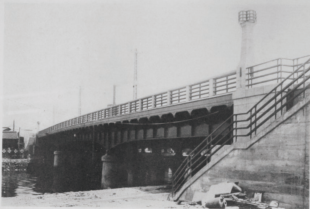
( 37 ) 國道十六號線(大阪)改良工事 堅川橋 (大阪府堺市大濱通及吾妻橋通地内) 三徑間中央吊桁付鋼鈹突桁橋、橋長七十七米、有効幅員二十七米三
