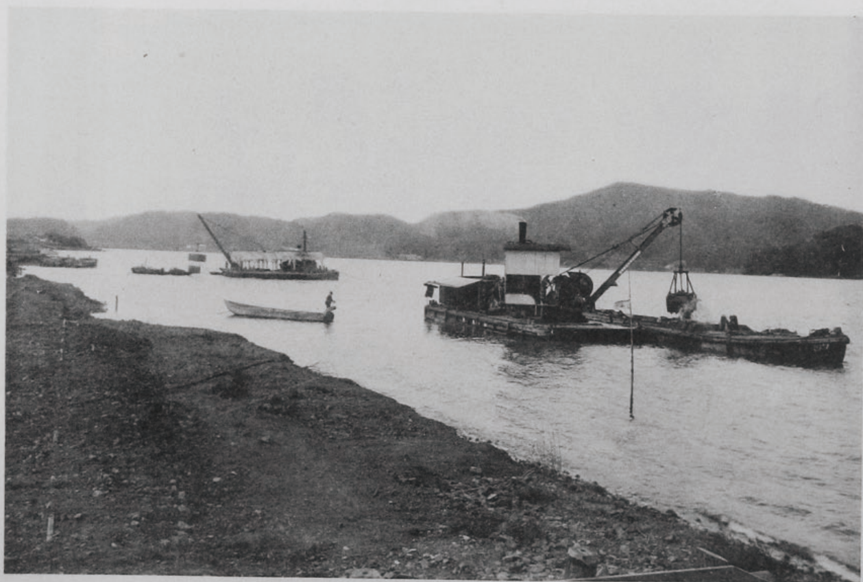
( 20 ) 舞鶴港修築工事埋立地前面護岸床掘作業 (京都府舞鶴町大字西字大野邊地先) 昭和六年十一月十六日舞鶴要塞司令部検閲済
