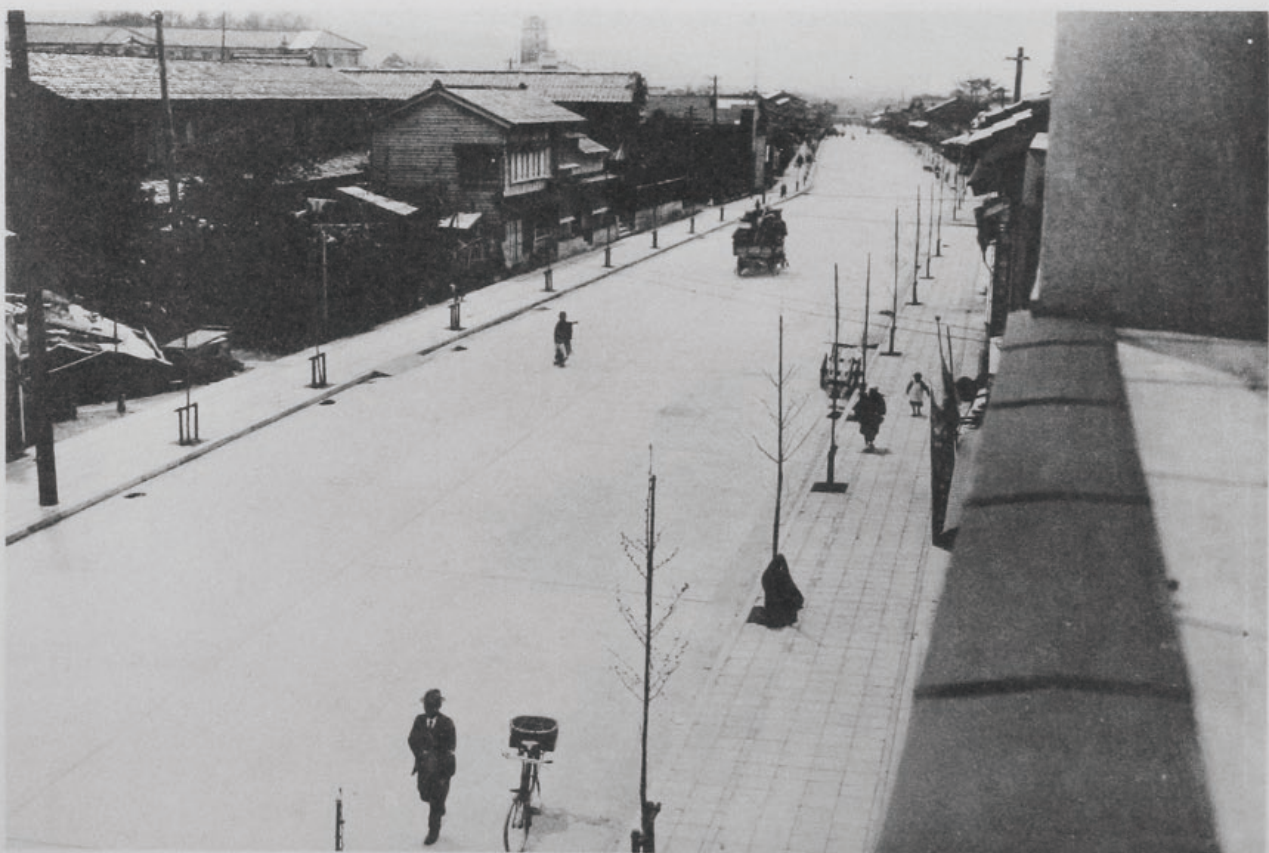
( 36 ) 國道十二號線(金澤)改良工事膠石鋪裝 (金澤市蘆中町地内) 幅員十九米一、車道十三米一、歩道三米宛
