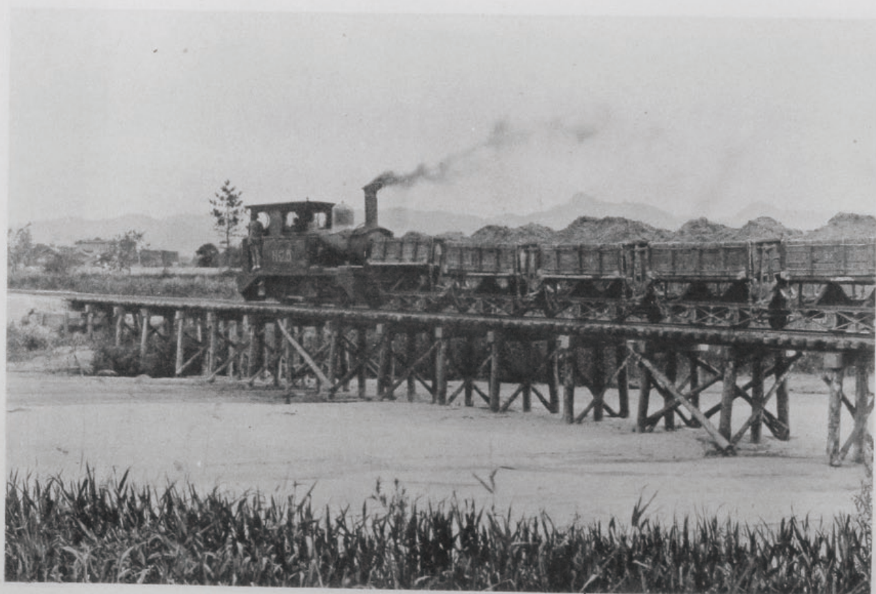
( 6 ) 斐伊川改修工事灘分機械掘鑿機關車運搬 ( 島 根 縣 簸 川 郡 灘 分 村 地 先 )
