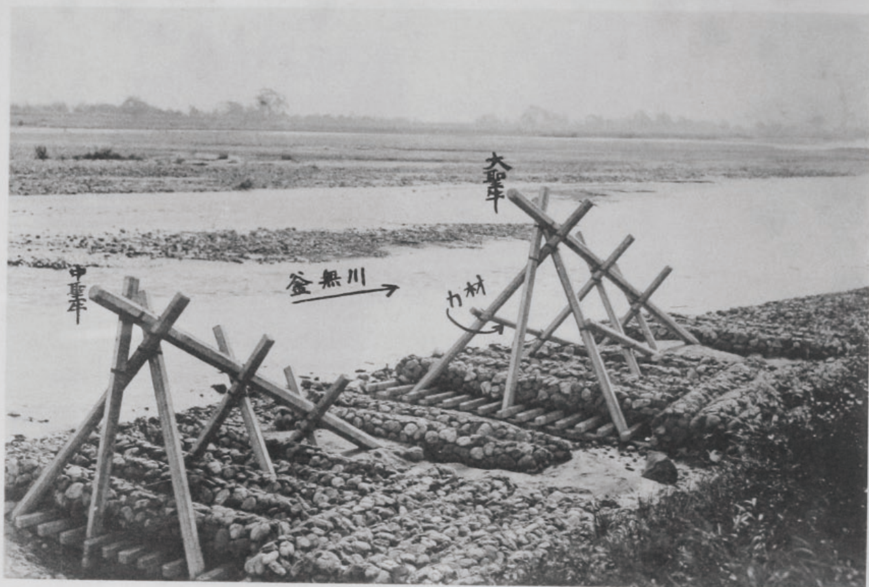
( 1 ) 富士川上流改修工事今諏訪水制 (山梨縣中巨摩郡今諏訪村地先)
