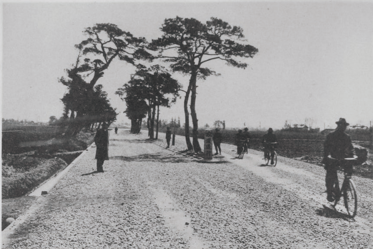
( 35 ) 國道九號線(新町)改良工事新國道 (群馬縣群馬郡會賀野町佐野町地内) 欂木ヲ存置シテ復道ト爲ス
