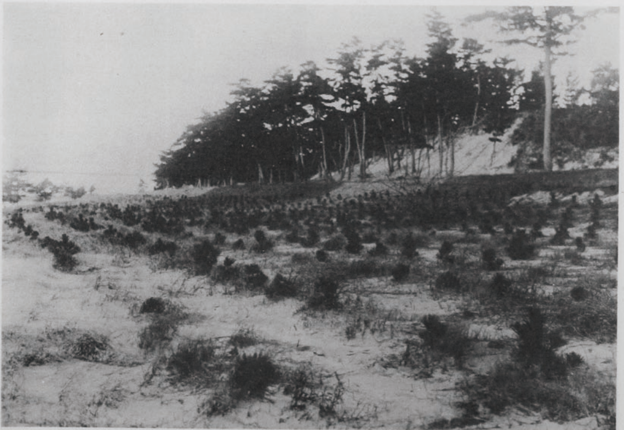
( 4 ) 木曾川上流改修工事長岡人力掘鑿 (愛知縣中島郡長岡村地先) 堤防前面ニ川砂堆積スルヲ防グ爲メ砂防工ヲ施ス
