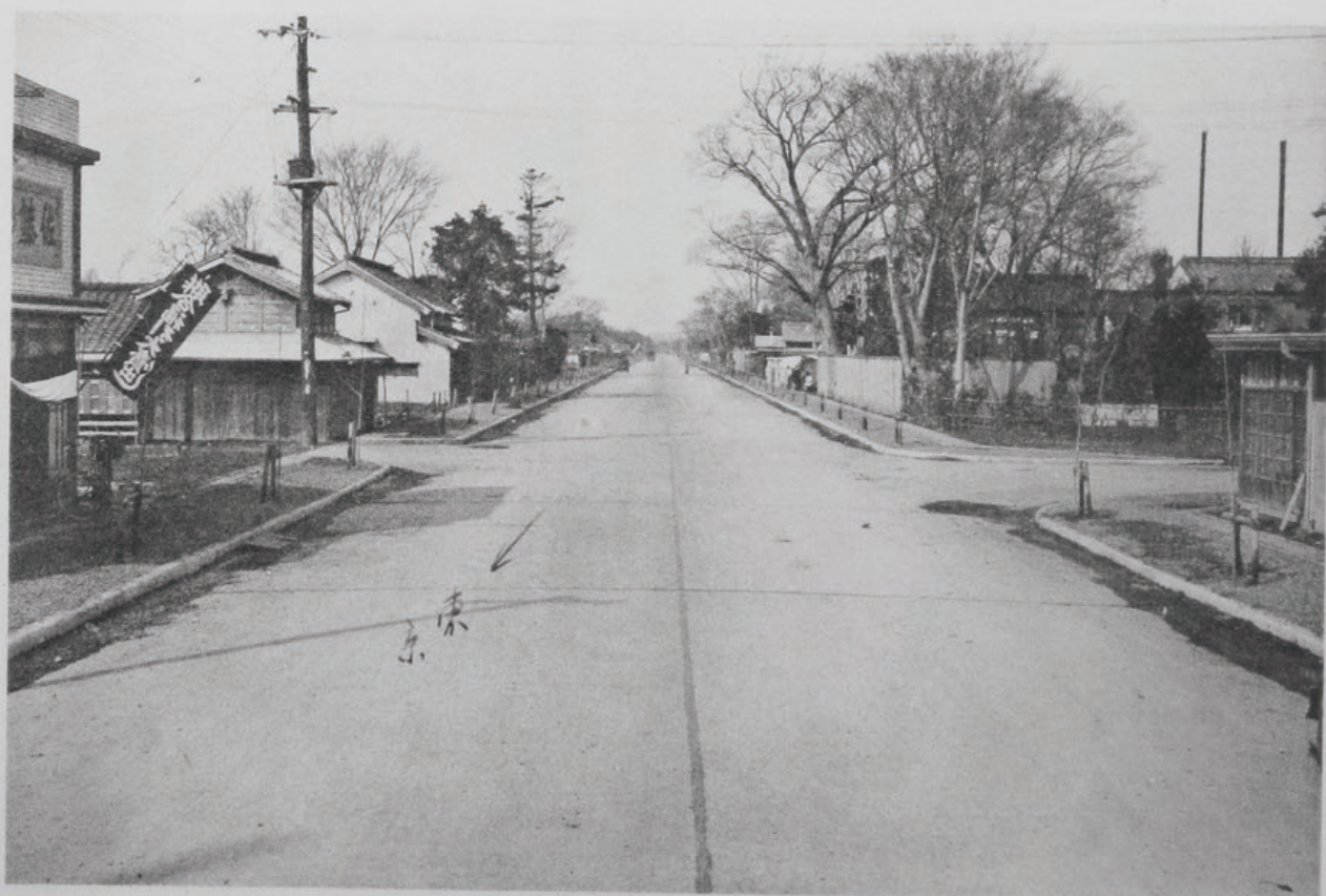
( 34 ) 國道九號線(戸田)改良工事鋪裝
