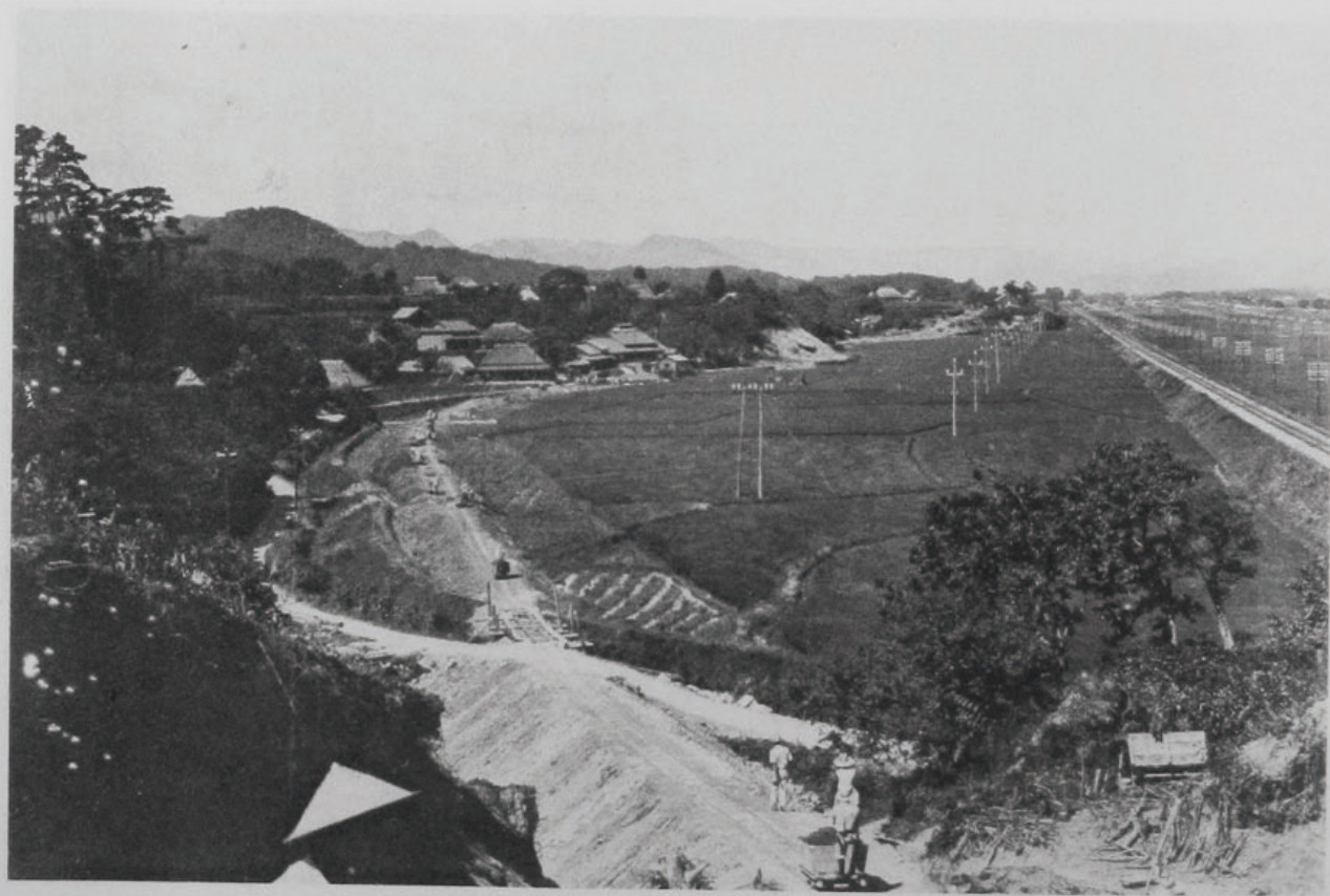
( 38 ) 國道十七號線(山口)改良工事 盛土 (山口縣吉敷郡小郡町大字下仁保津地内)
