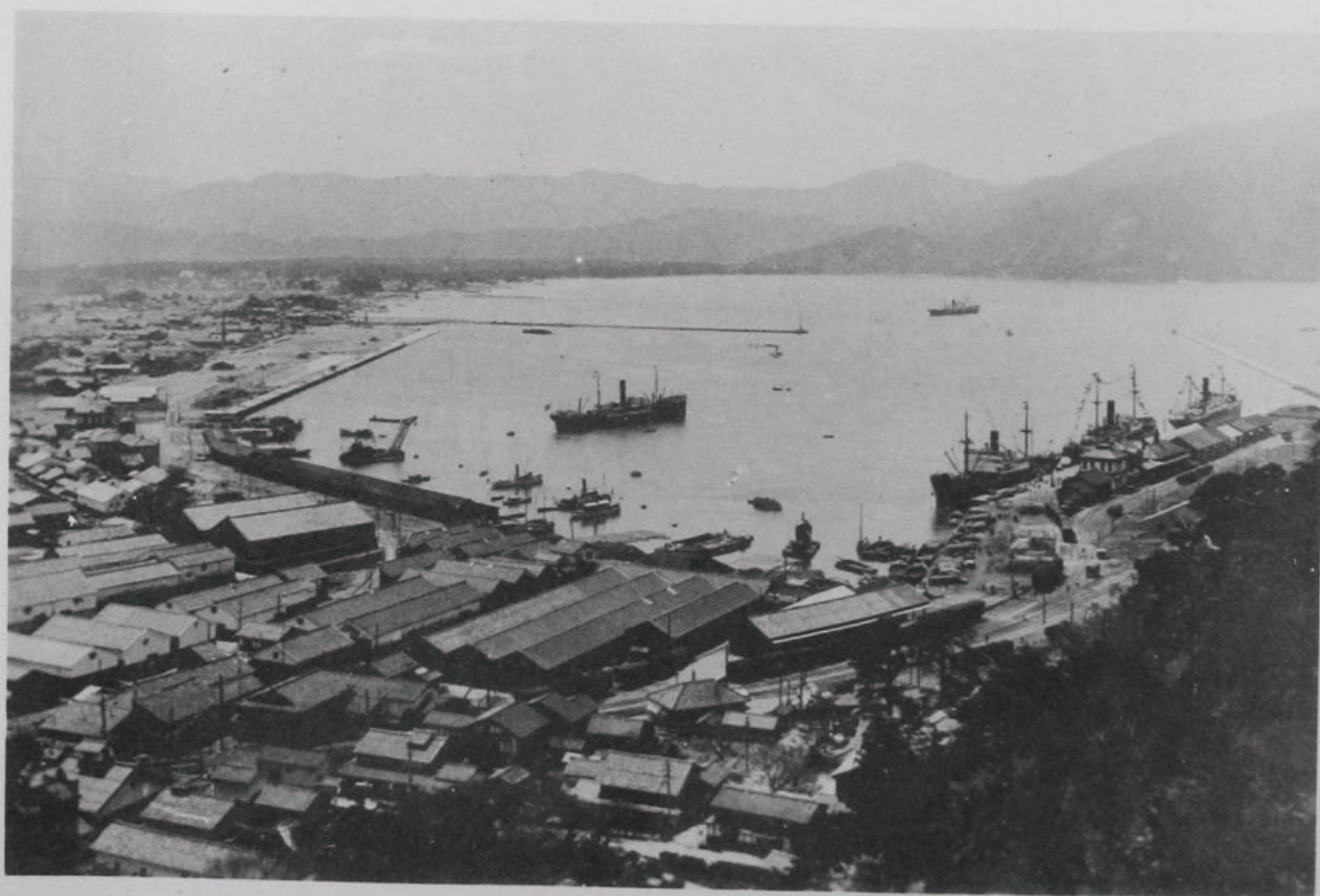
( 16 ) 敦賀港修築工事全景 防波堤延長五百十一米、防砂堤延長三百八十米、 港内水面積四十萬七千二百六十平方米
