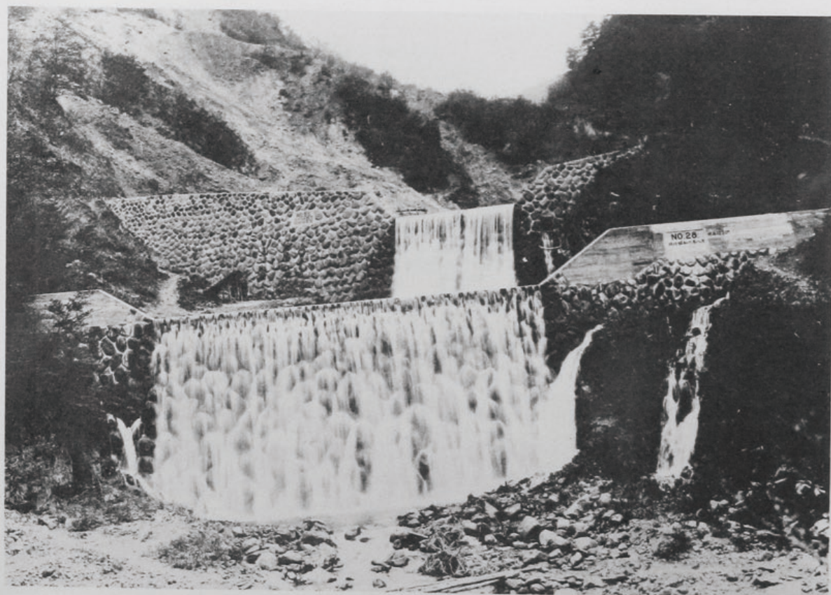
( 10 ) 千曲川流域砂防工事堰堤 (長野縣下高井郡平穩村地先)
