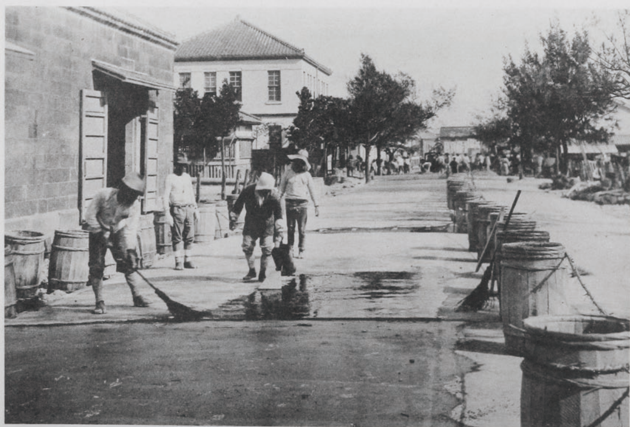
( 40 ) 二十六號國道(沖繩)改良工事鋪裝 (沖繩縣那霸市内)
