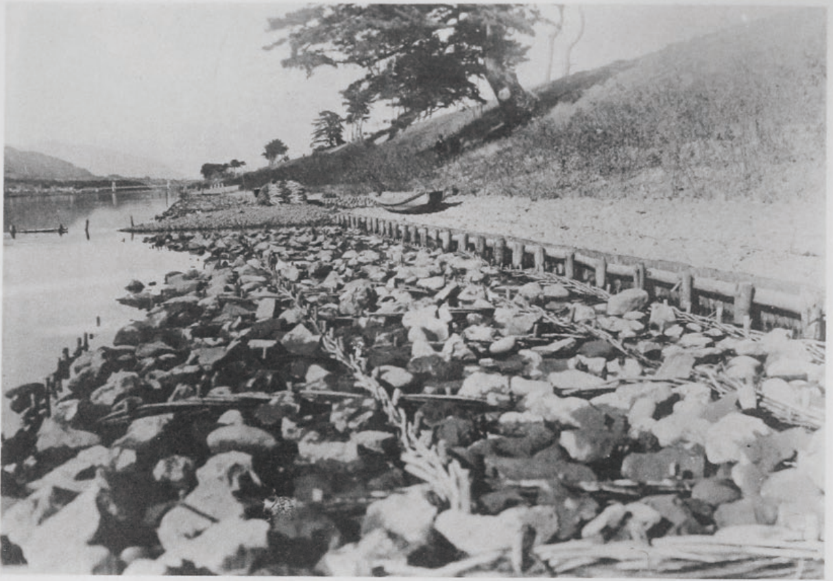
( 3 ) 木曾川上流改修工事西江護岸 (岐阜縣海津郡西江村地先)
