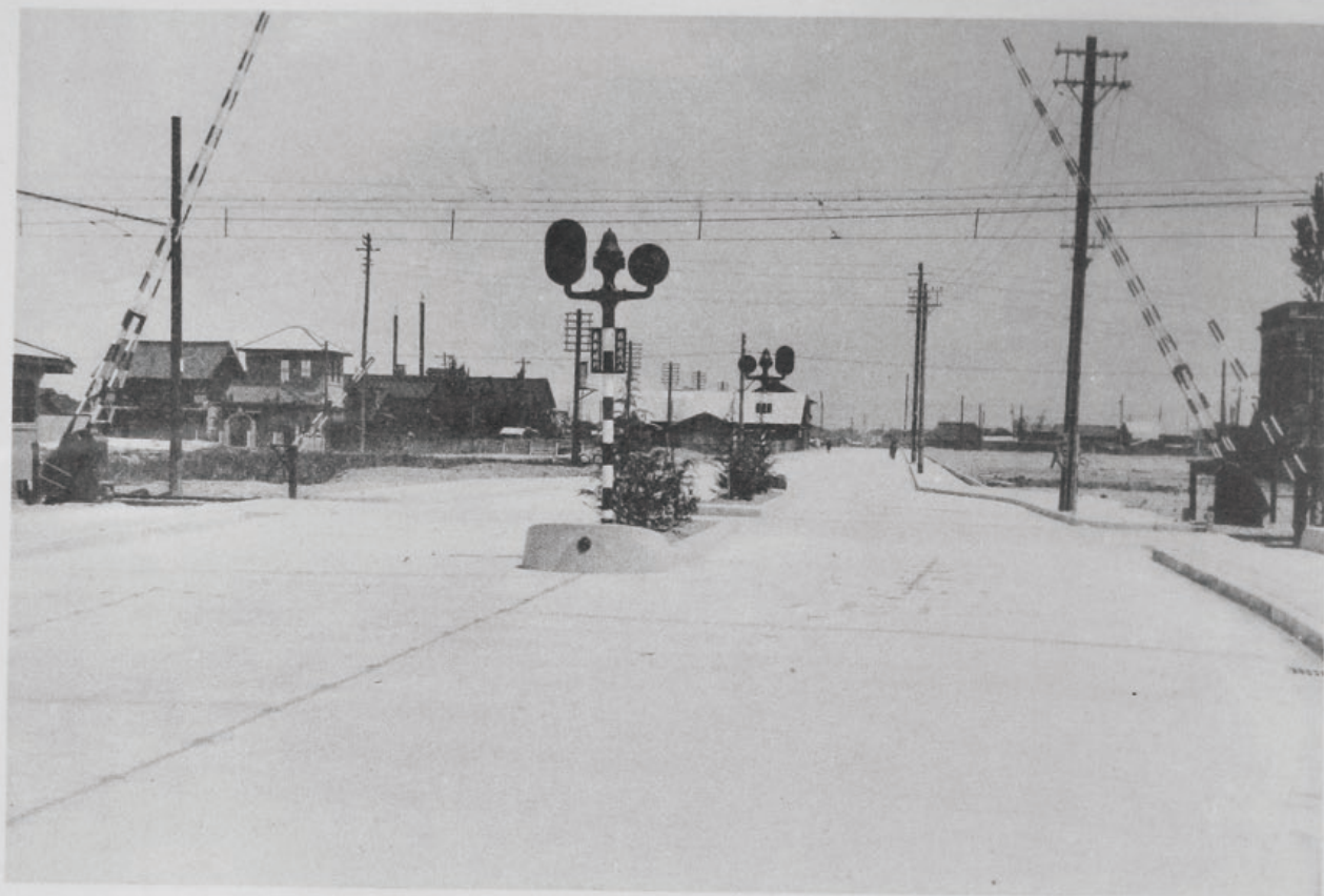
( 25 ) 國道一號線(桑名)改良工事北勢鐵道交叉路遮斷機裝置 (三重縣桑名郡西桑名町地内)
