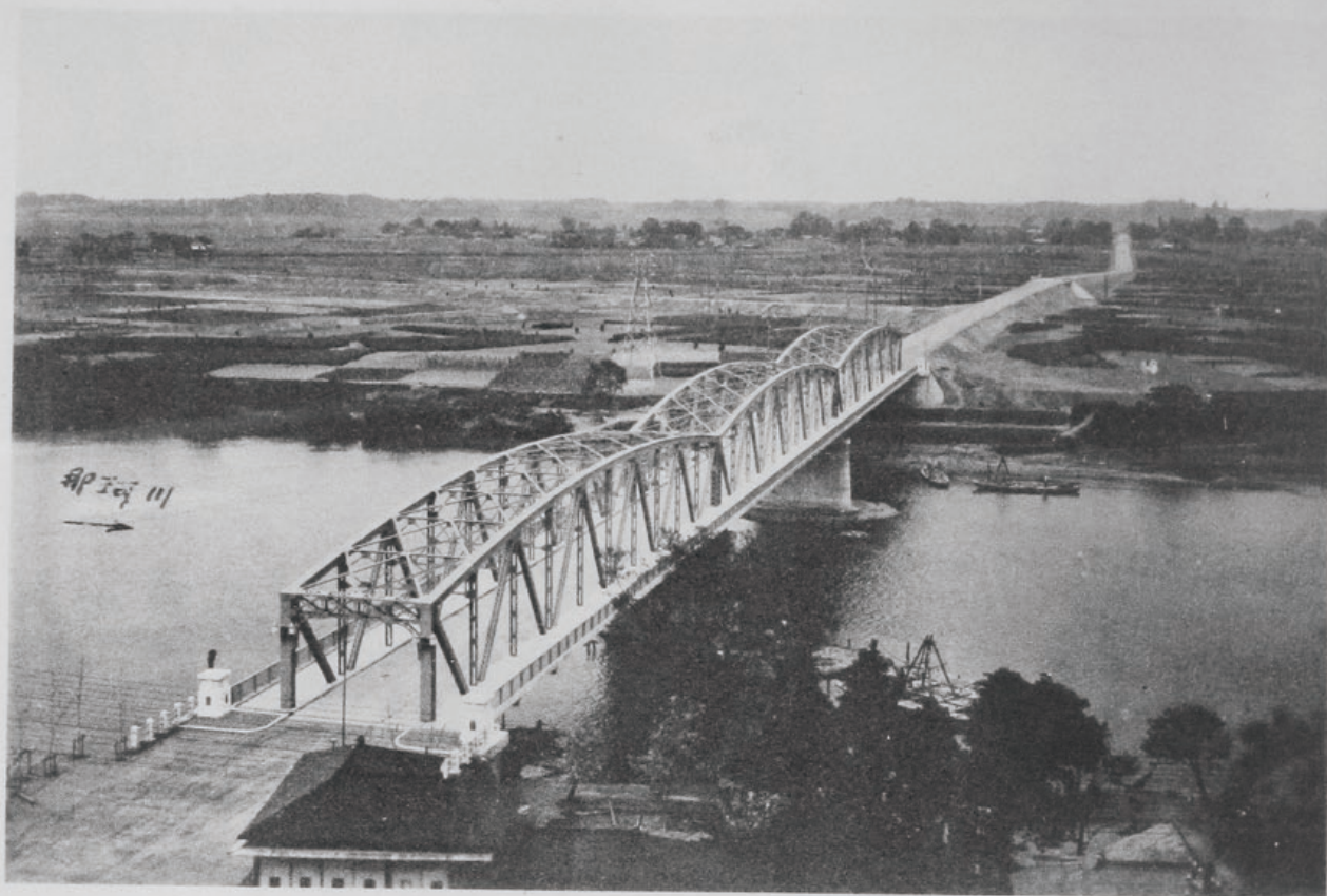
( 33 ) 國道六號線(水戸)改良工事水府橋
