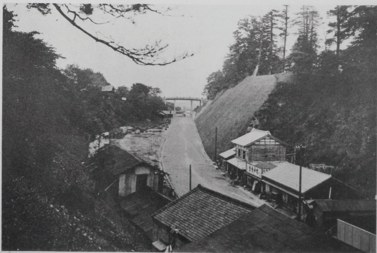
( 32 ) 國道六號線(水戸)改良工事新國道 (水戸市大字上市舊城内)
