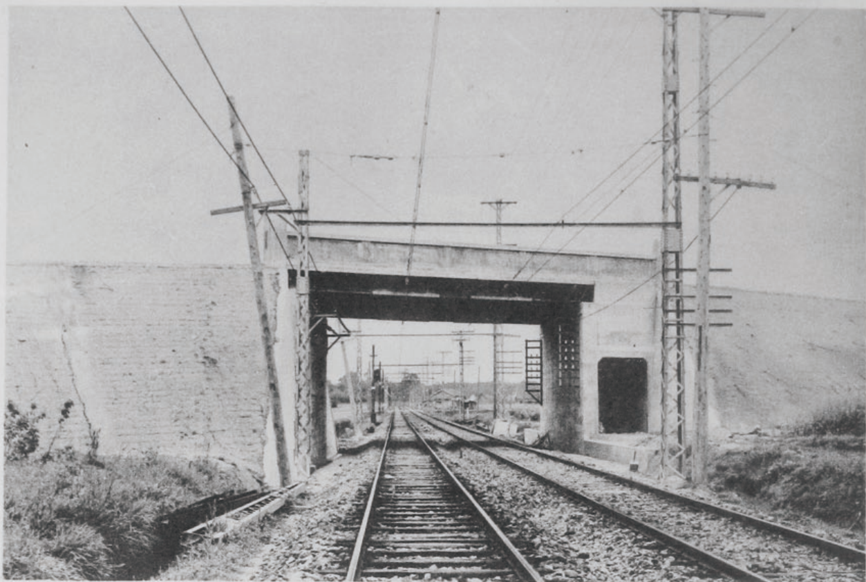
( 27 ) 國道二號線(二日市)改良工事古川橋 (福岡縣筑紫郡水城村地内)
