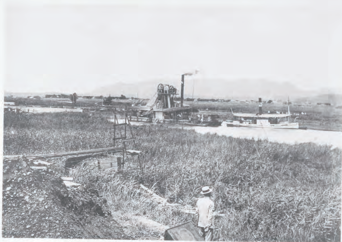
(21) 斐伊川改修工事機械浚渫及機械掘鑿 (島根縣簸川郡灘分村地先)
