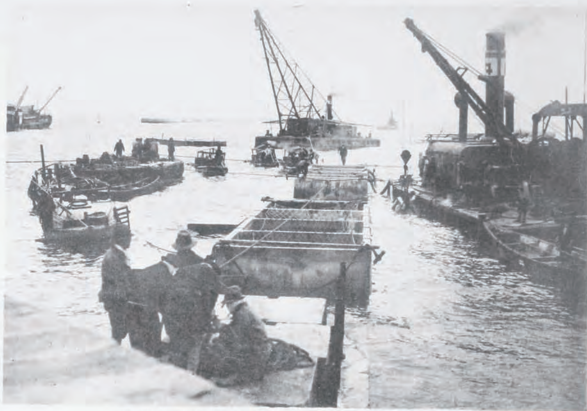
(43) 神戸港修築工事南防波堤函塊据付
