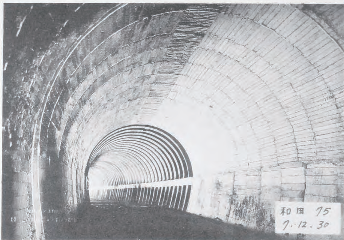
(91) 國道十四號線(長野)改良工事和田嶺隧道及雪覆 (長野縣小縣郡和田村地内)
