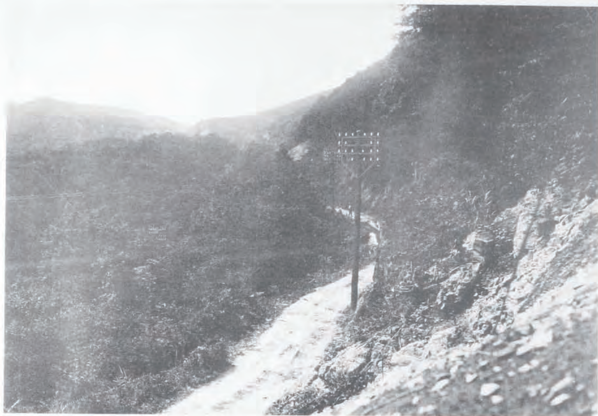
( 87 ) 國道十號線(碓氷)國道改良工事改良前ノ狀況 (群馬縣碓氷郡坂本町地内)
