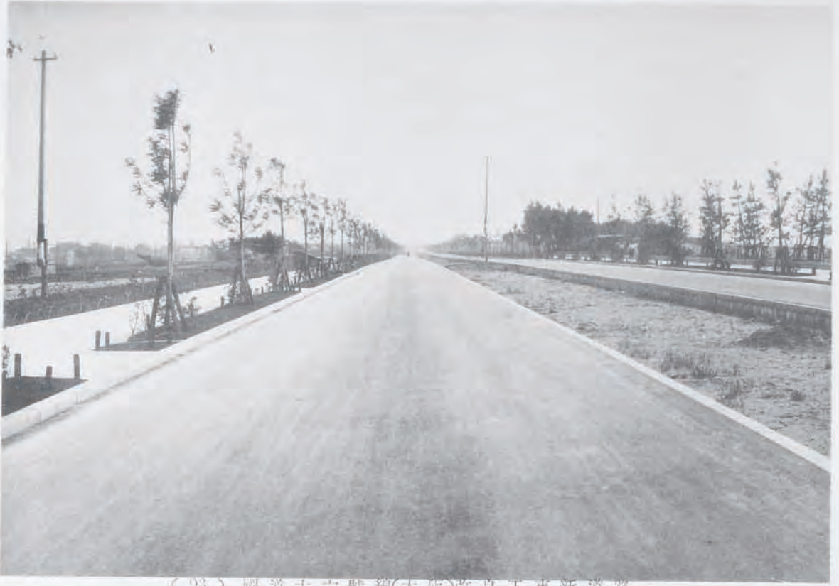
(93) 國道十六號線(大阪)改良工事新道路 (大阪府泉北郡濱寺町地内) 道路幅員二十七米、歩道四米五
