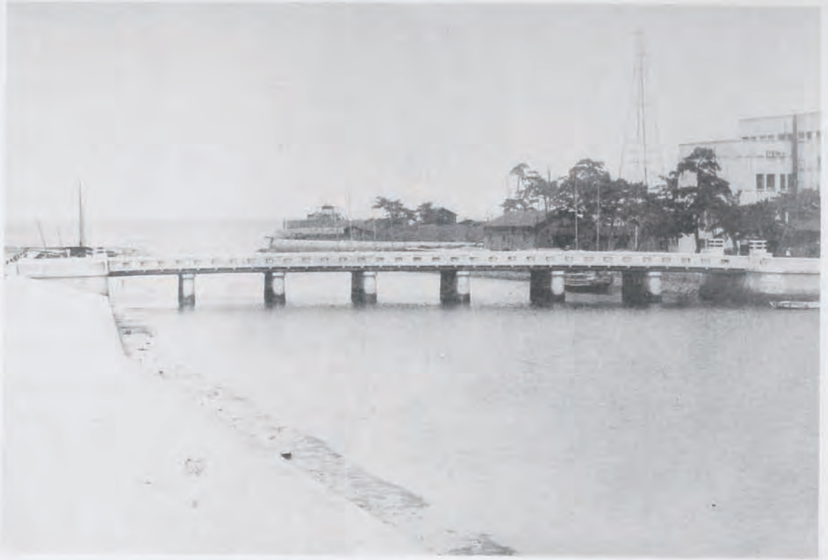
( 51 ) 今 治 港 修 築 工 事 貯 木 場 橋 梁
