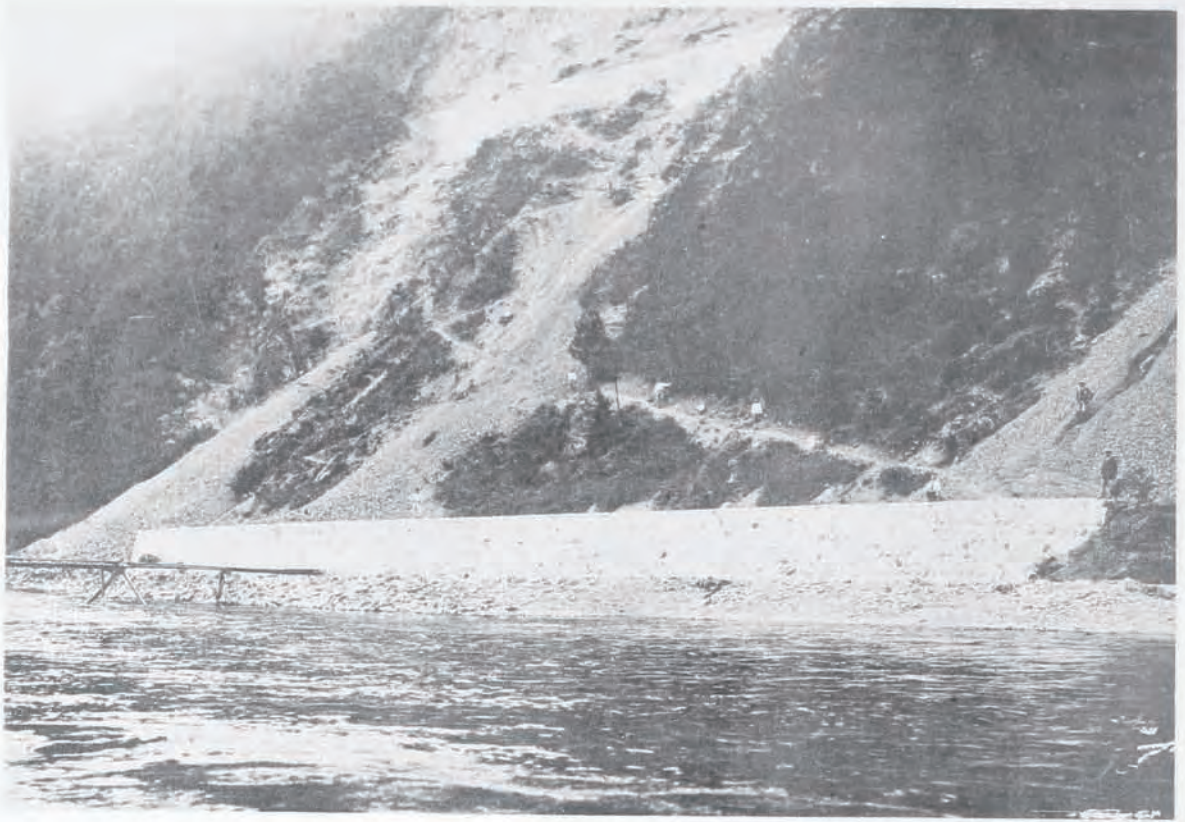
(35) 掛斐川流域砂防工事黒山護岸 (岐阜縣本巢郡根尾村大字板所地先) 護岸高五米、延長百二米、上部＝見ニルハ山腹石積工ナリ
