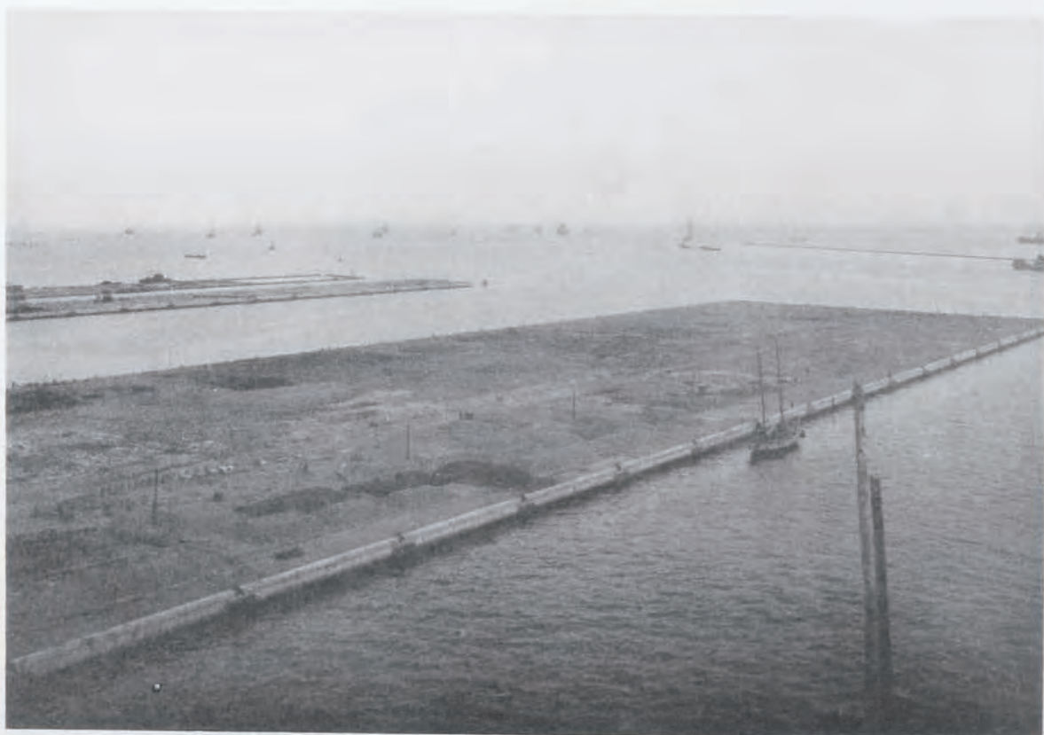
(40) 神戸港修築工事濱邊通第五突堤全景
