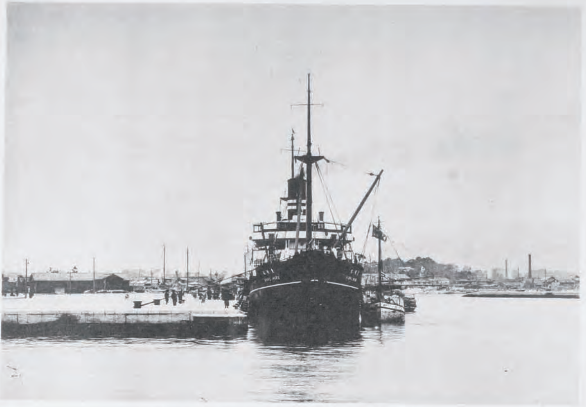
(49) 今治港修築工事壁繫船狀況
