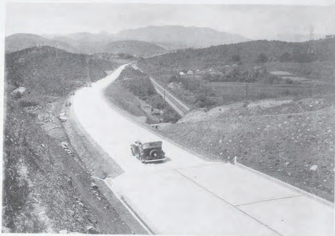
( 97 ) 國道二十五號線(長崎)改良工事混凝土鋪裝 (長崎縣北高來郡諫早町地内)
