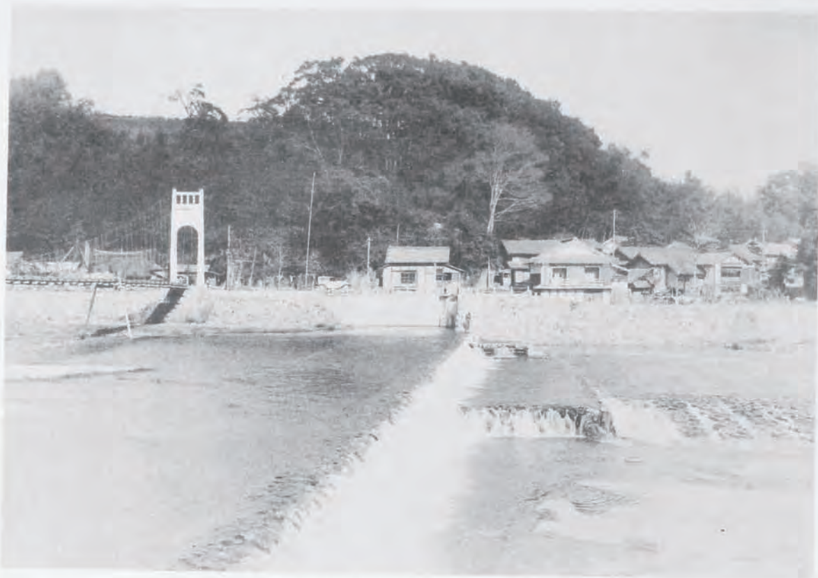
(19) 木曾川上流改修工事附帶粕川改修床固 (岐阜縣揖斐郡小島村地先) 床固長九十八米、玉石混凝土造兩岸＝用水取入樋門各一箇所アリ
