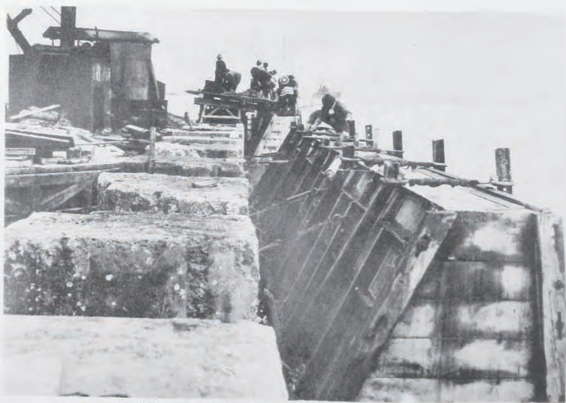
(44) 神戸港修築工事東防波堤胸壁築造
