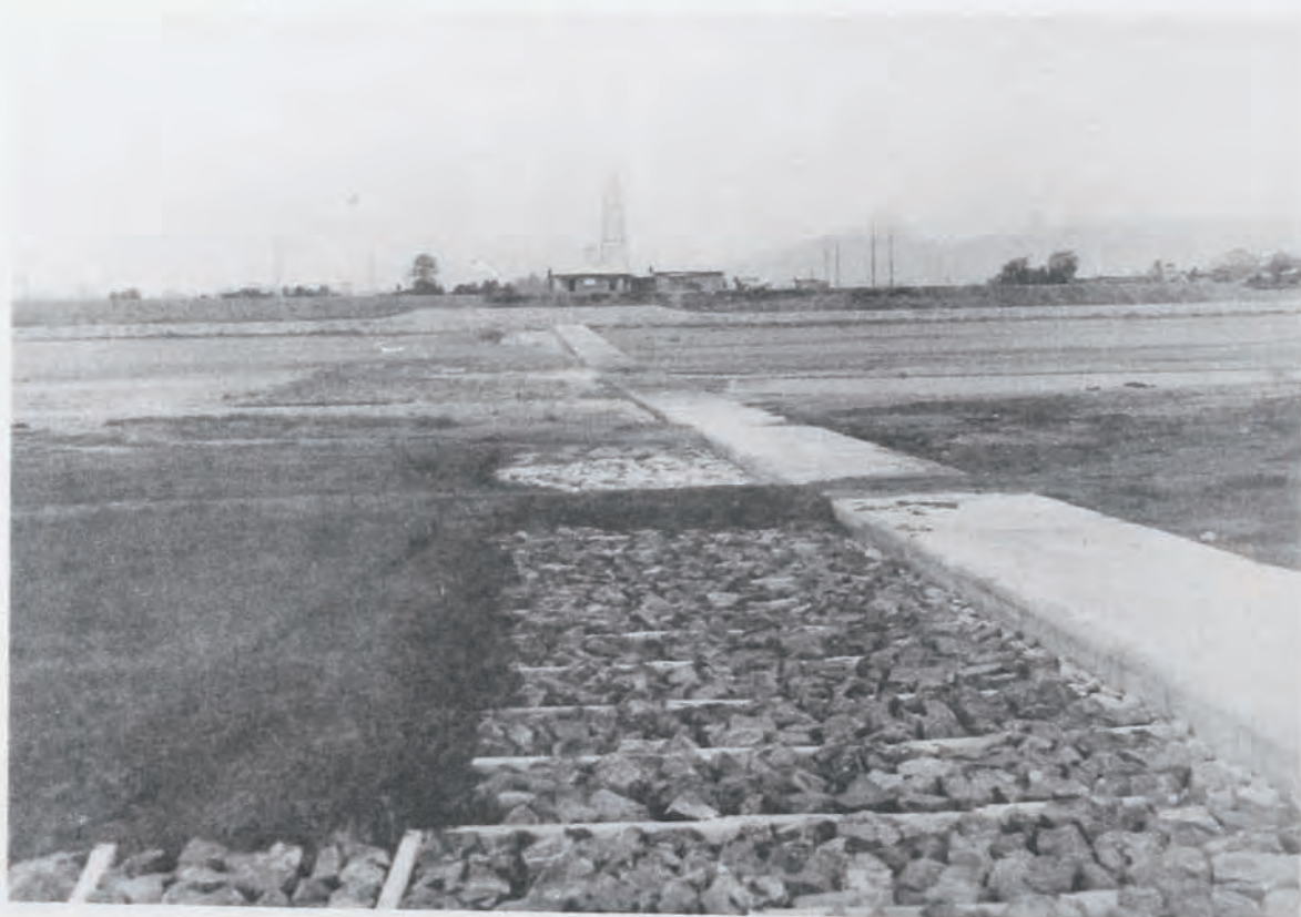
(16) 木曾川上流改修工事藪川床固 (岐阜縣揖斐郡川合村及本巢郡彈正村地先) 本體混凝土幅四米、水叩改良木床幅六米乃至十八米
