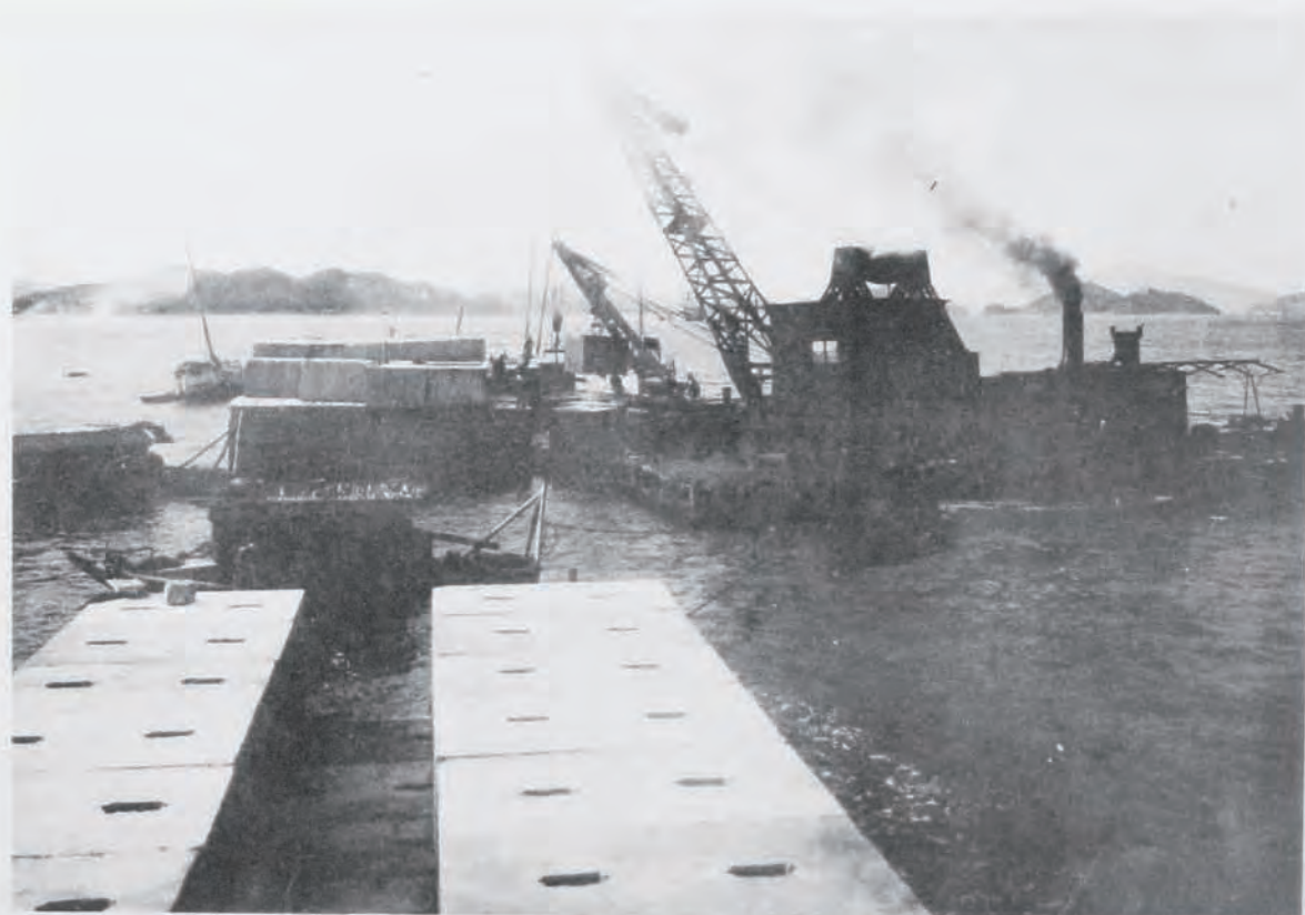
(48) 今治港修築工事防波堤築造荷重施行
