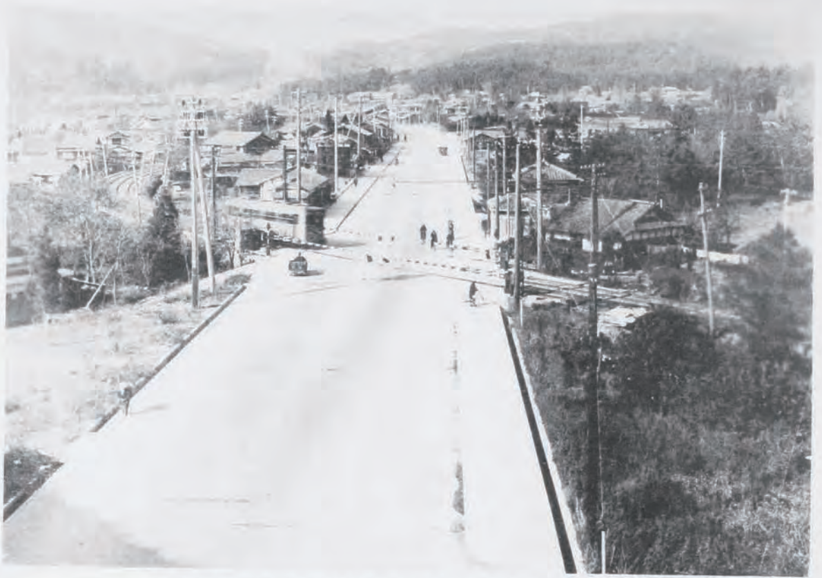
(73) 國道二號線(京都)改良工事新道路 其二 (京都市東山區山科御陵地内)
