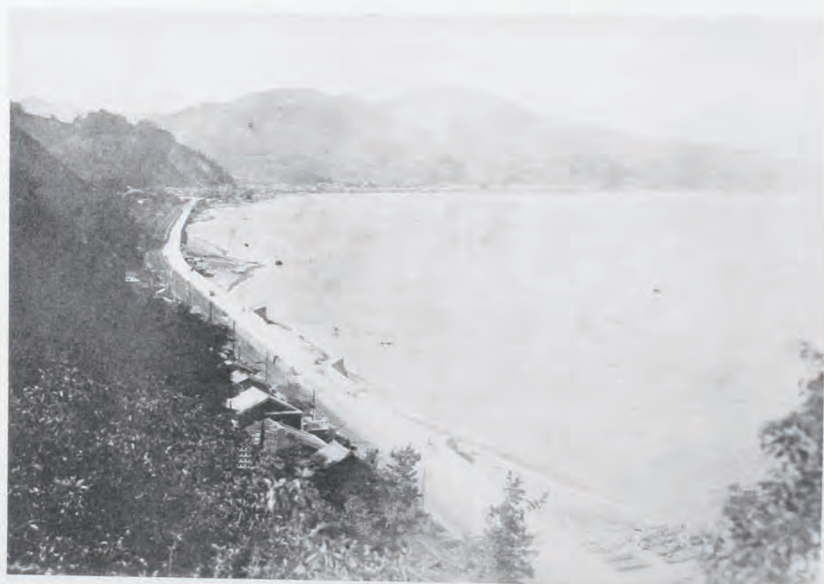
( 62 ) 國道一號線(由比)改良工事新國道 其一 (静岡縣庵原郡由比町西倉澤今宿地内) 薩埵峠ヨリ國道ヲ望ム
