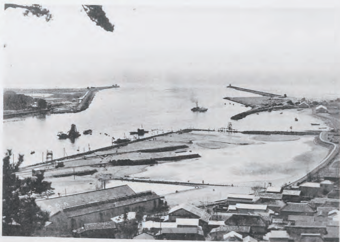
(6) 北上川改修工事石巻河口突堤全景 (宮城縣牡鹿郡石巻市地先)
