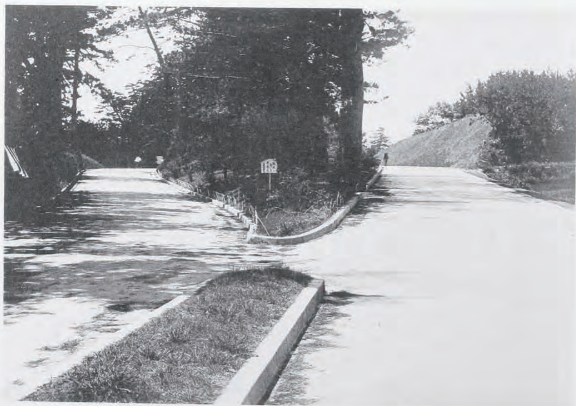
( 60 ) 國道一號線(戸塚)改良工事複線道路 其 二 (神奈川縣鎌倉郡戸塚町戸塚地内)
