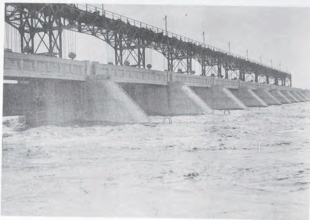
(25) 信濃川維持工事洪水時全扉開放ノ可動堰 (新潟縣三島郡大河津村五千石地先)
