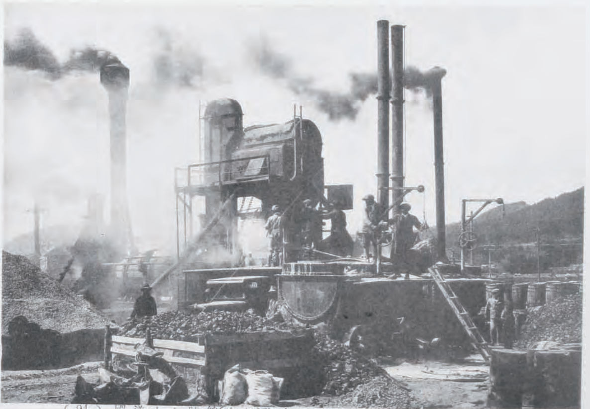
(94) 國道十七號線(山口)改良工事アスファルトプラント (山口縣吉敷郡小郡町地内)
