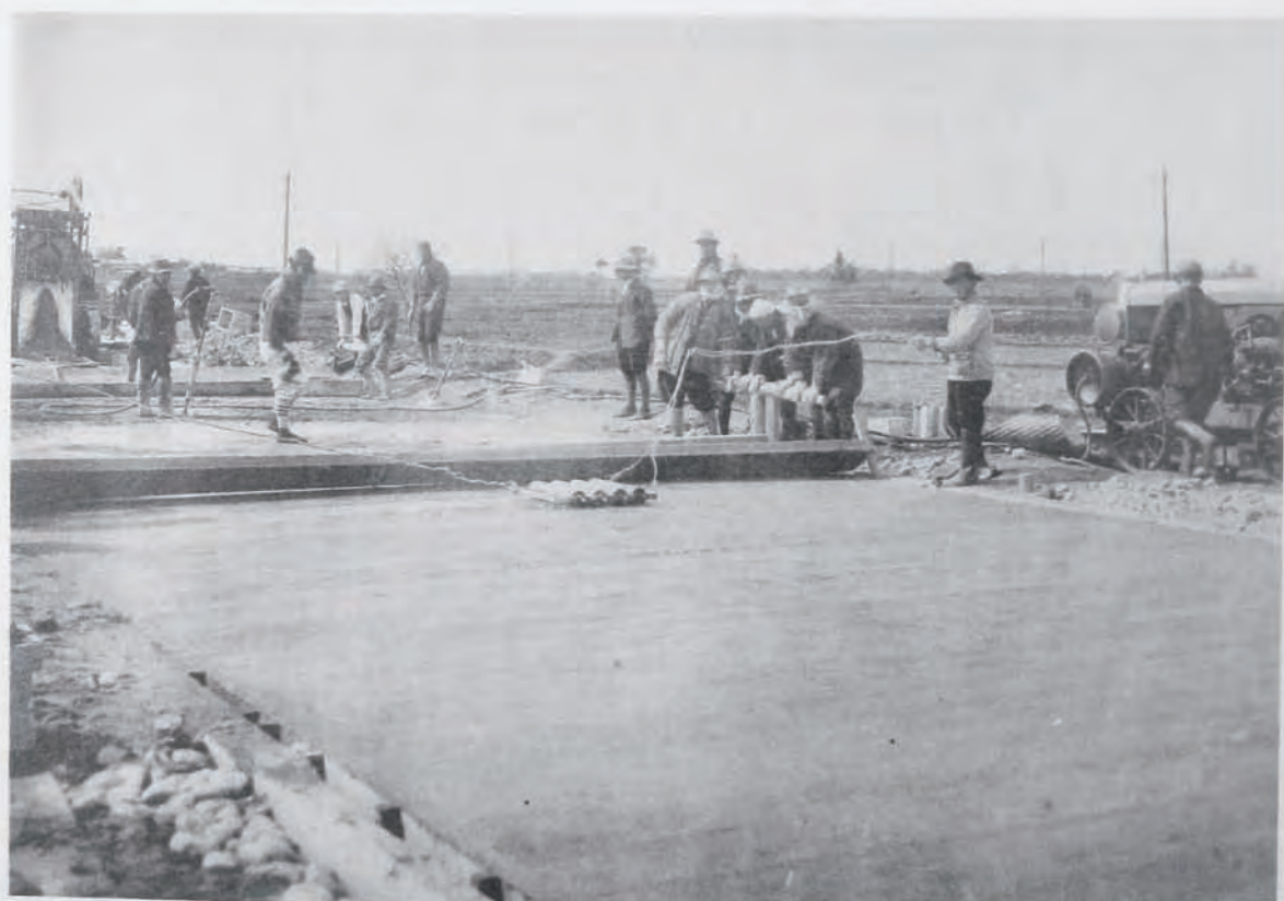
( 90 ) 國道十二號線(岐阜)改良工事混凝土鋪裝 (岐阜縣羽島郡笠松町錢龜地内)
