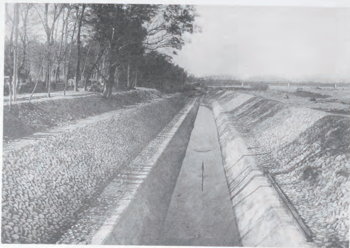
(17) 木曾川上流改修工事忠節用水堤外水路 (岐阜縣岐阜市地先)
