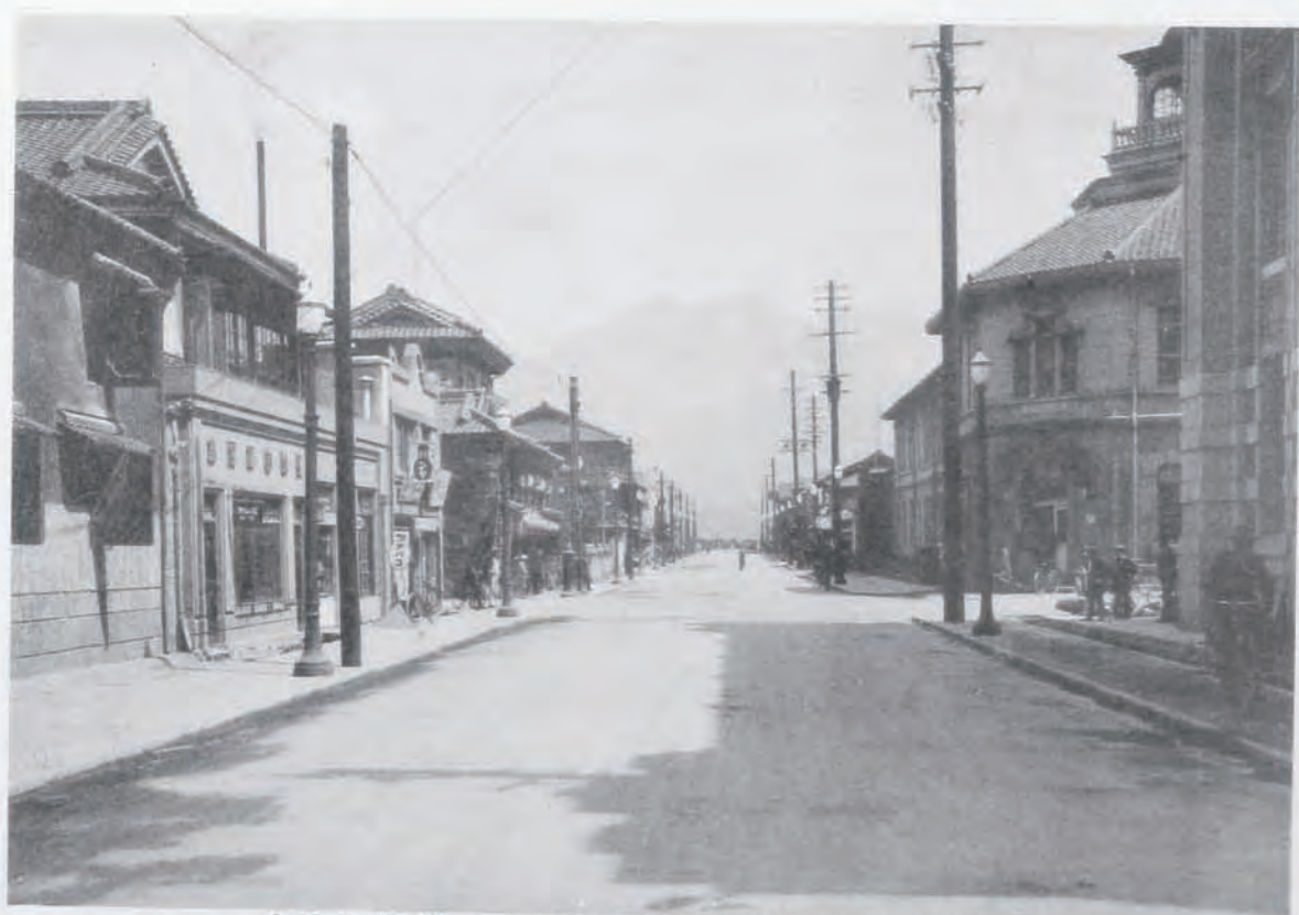
( 98 ) 國道二十六號線(鹿兒島)改良工事鋪裝 (鹿兒島市金生町地内)
