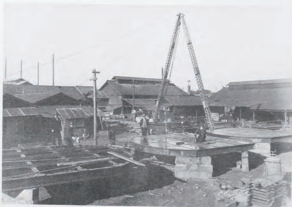
(14) 木曾川上流改修工事境川樋門扉製作 扉幅五米五、高七米、一枚重量八千貳
