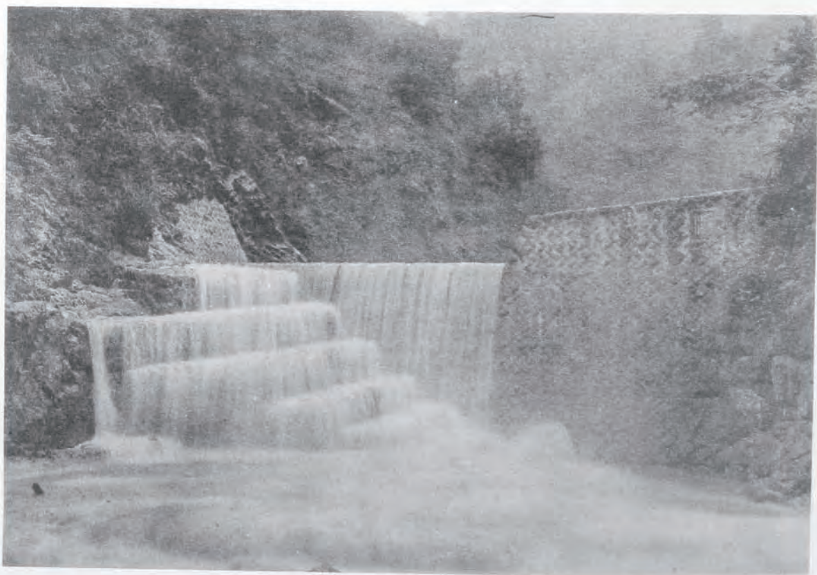
(58) 相模川流域震災復舊砂防工事中津川筋「朴木」堰堤 (神奈川縣愛甲郡宮ヶ瀬村地先) 本堰堤高十米、長三十四米、副堰堤高四米、長十五米
