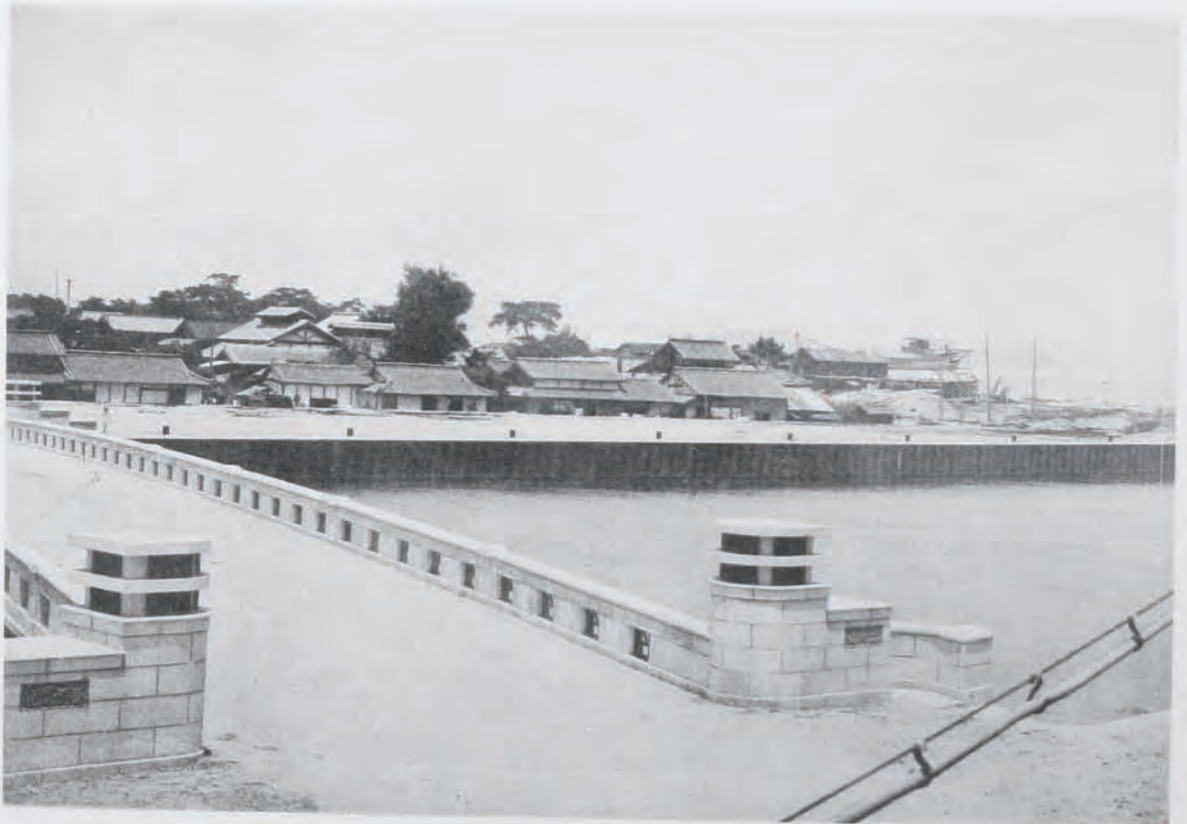
(50) 今治港修築工事貯木場矢板護岸
