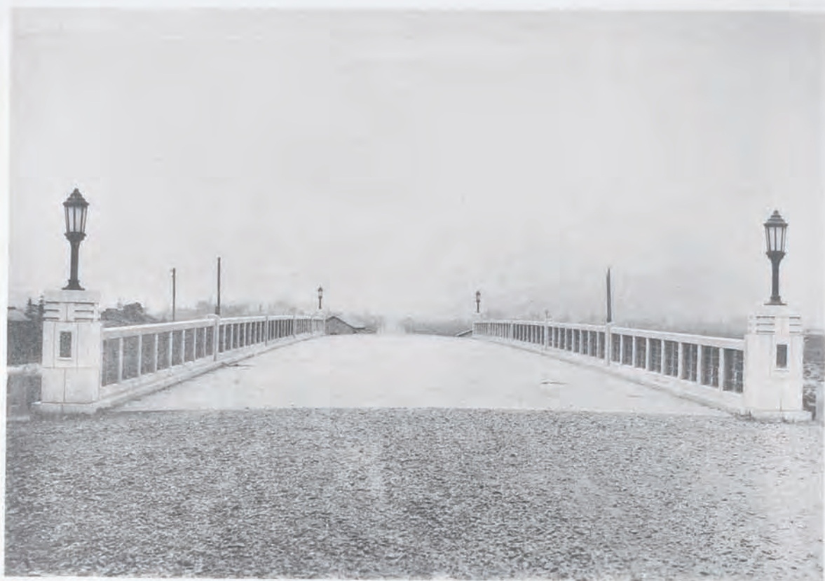
( 75 ) 國道二號線(岡山)改良工事撫川橋 (岡山縣吉備郡撫川町地内)
