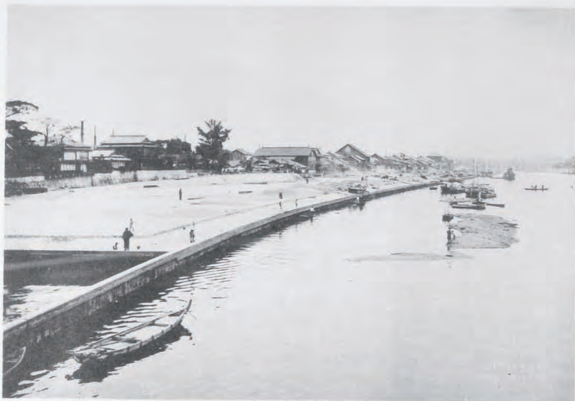
(23) 旭川改修工事鐵筋混凝土矢板護岸 (岡山縣岡山市地先)
