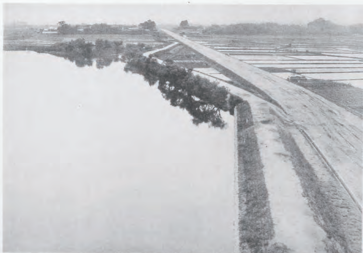
(92) 國道十五號線(奈良)改良工事路床工 (奈良縣添上郡明治村地内)
