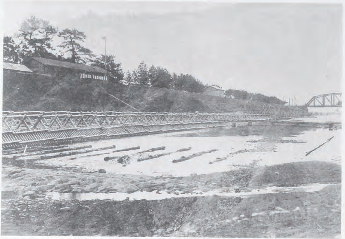
(11) 富士川下流改修工事護岸根固
