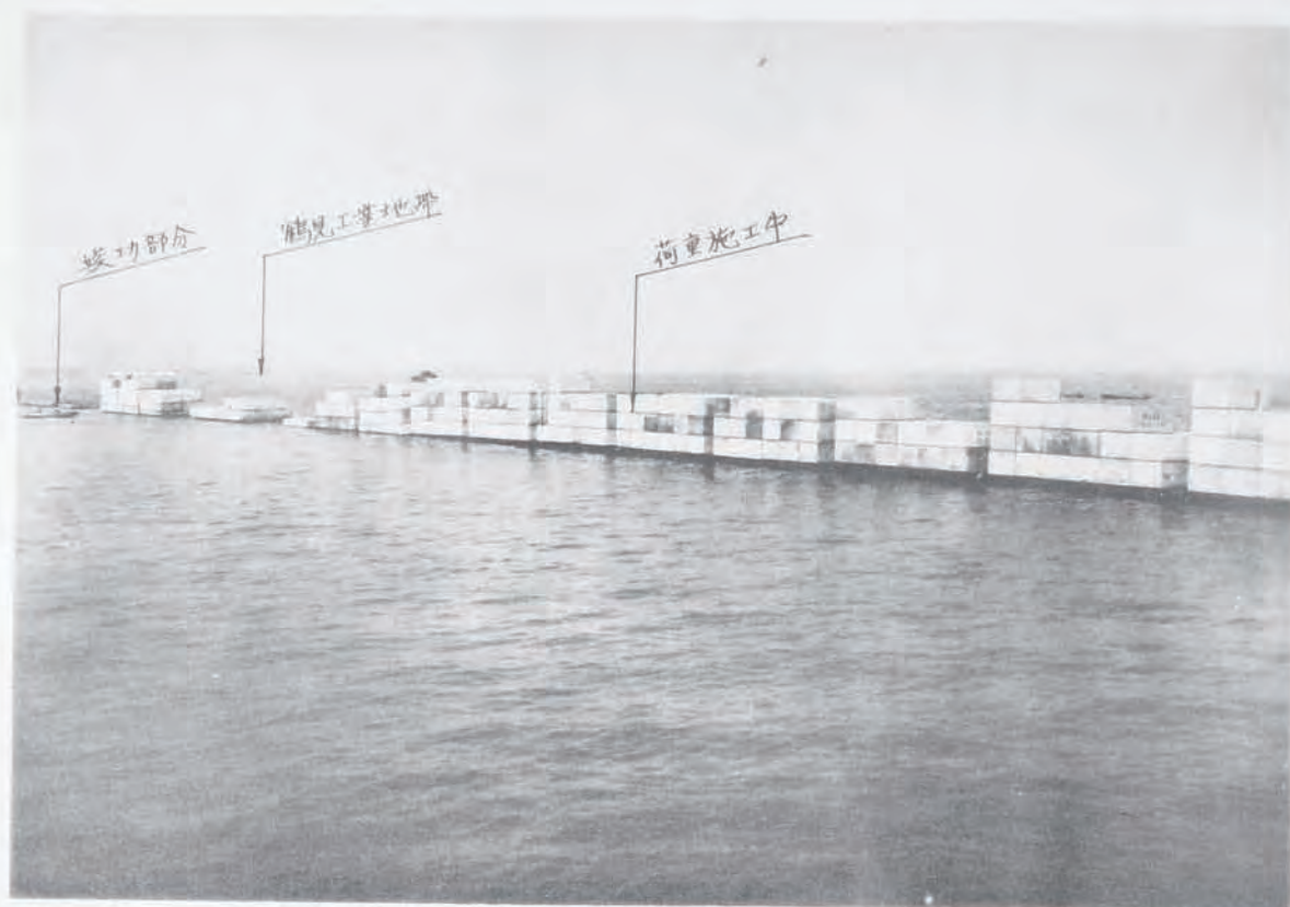
(45) 横濱港修築工事外防波堤荷重施行
