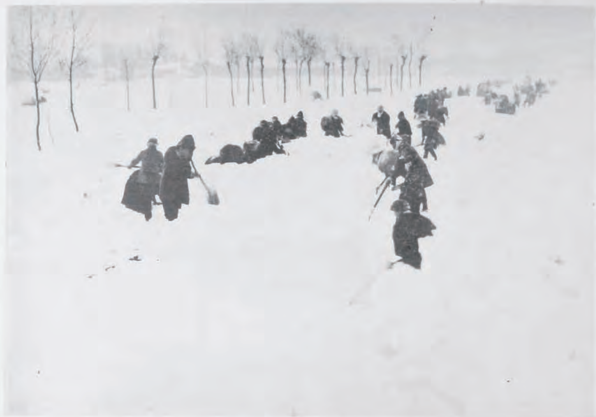
( 89 ) 國道十號線(新潟)改良工事猿橋道路除雪作業 (新潟縣北蒲原郡猿橋村地内)
