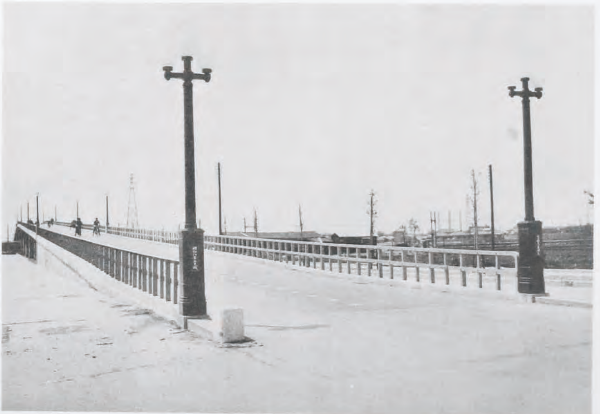
( 78 ) 國道四號線(梅島)改良工事梅島橋 (東京市足立區梅田町千住末廣町、千住彌生町地内) 高速車道分離式高架橋、鋼鈑桁九連、工型鋼桁六連、 全長四百三十二米九、有効幅員六米五
