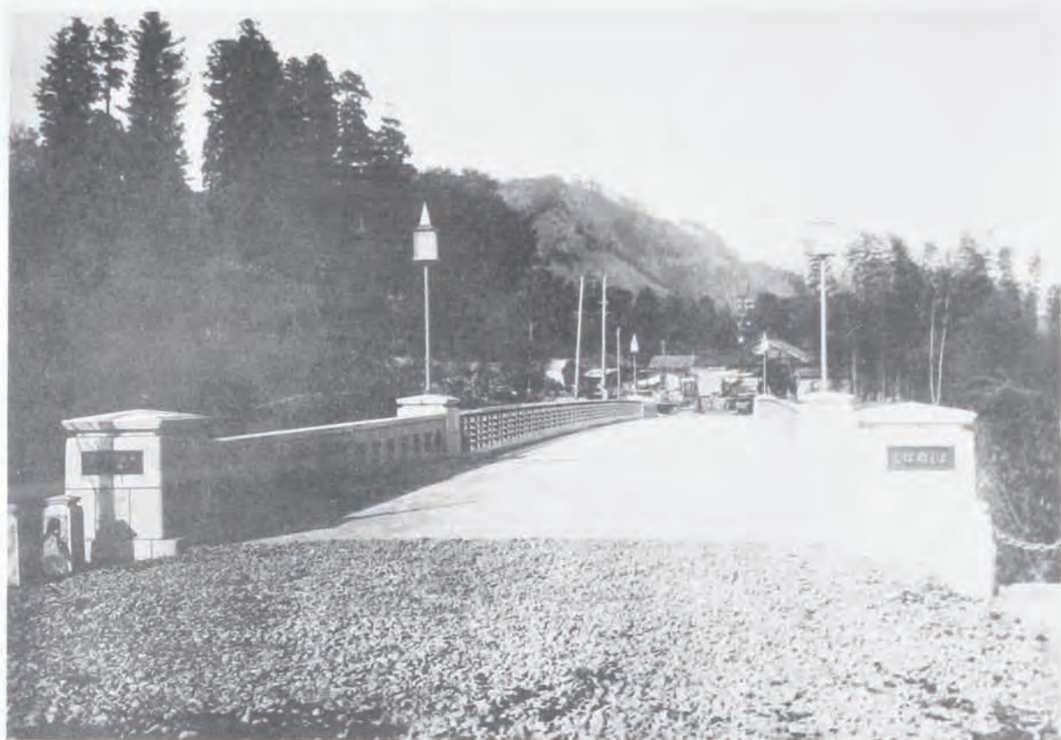
( 85 ) 國道八號線(奥瀬)改良工事吉野橋 其二 (神奈川県津久井郡吉野町宇新町地内)
