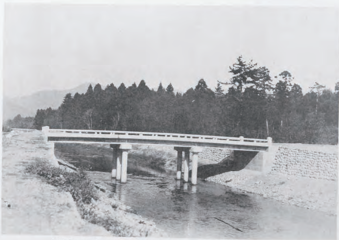
(20) 木曾川上流改修工事附帶三水川改修新水路 (岐阜縣揖斐郡豊木村地先)
