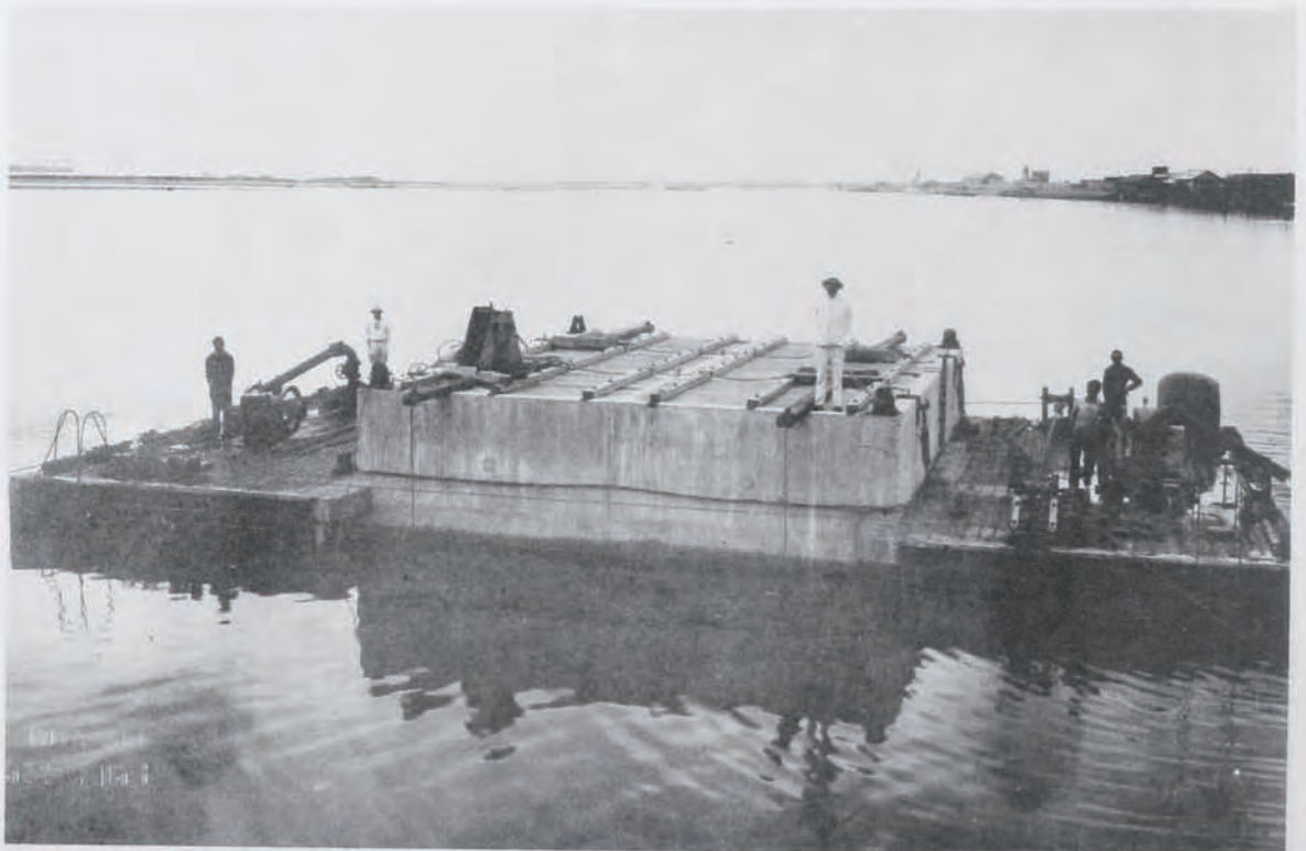
( 52 ) 土 崎 港 修 築 工 事 突 堤 用 函 運 搬 其 一 函長十米、幅七米五、高五米五、吃水三米五、フロート 長十二米、幅四米六、高四米一、排水用ポンプヲ備フ
