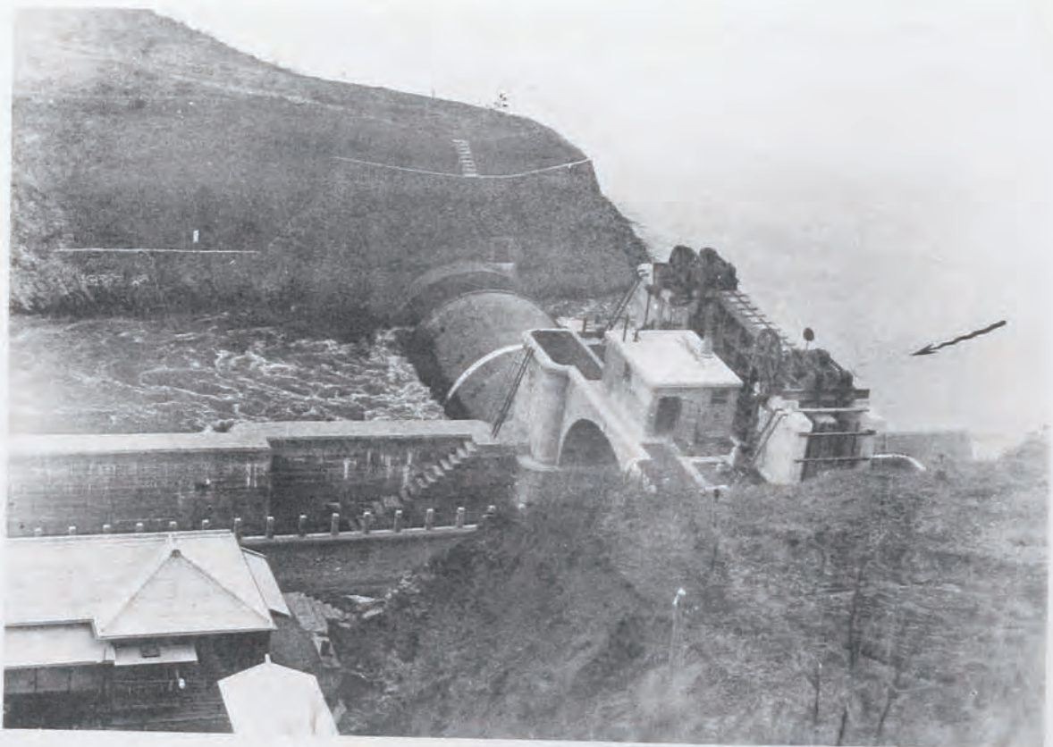
( 10 ) 北上川改修工事 脇谷 閘門 及 洗堰 (宮城縣桃生郡桃生村地先) 閘門幅七米九、長五十八米、引揚扉使用洗堰ハ高一米六五、幅二米 三五ノ暗渠六連及其上部長二十二米ノ溢流部ヨリ成ル
