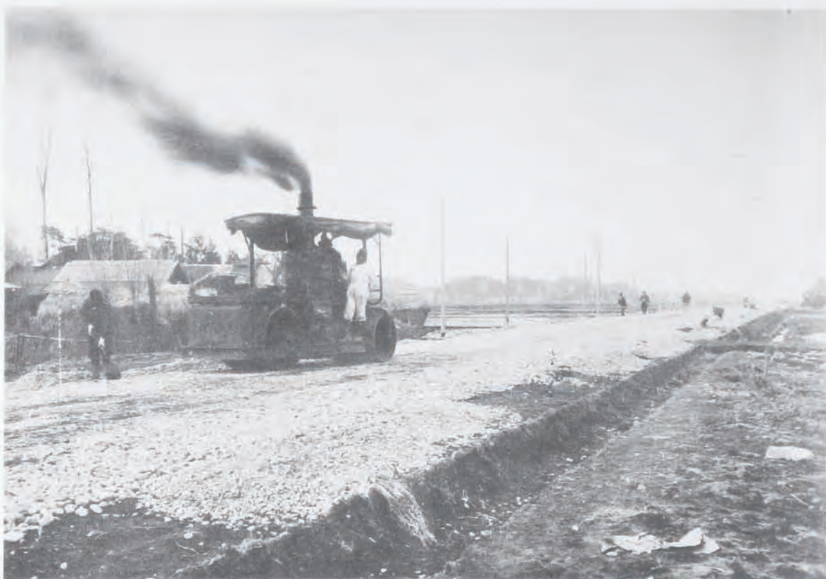
( 79 ) 國道四號線(宮城)改良工事路床輾壓作業 (宮城縣名取郡館腰村本郷大門地内)
