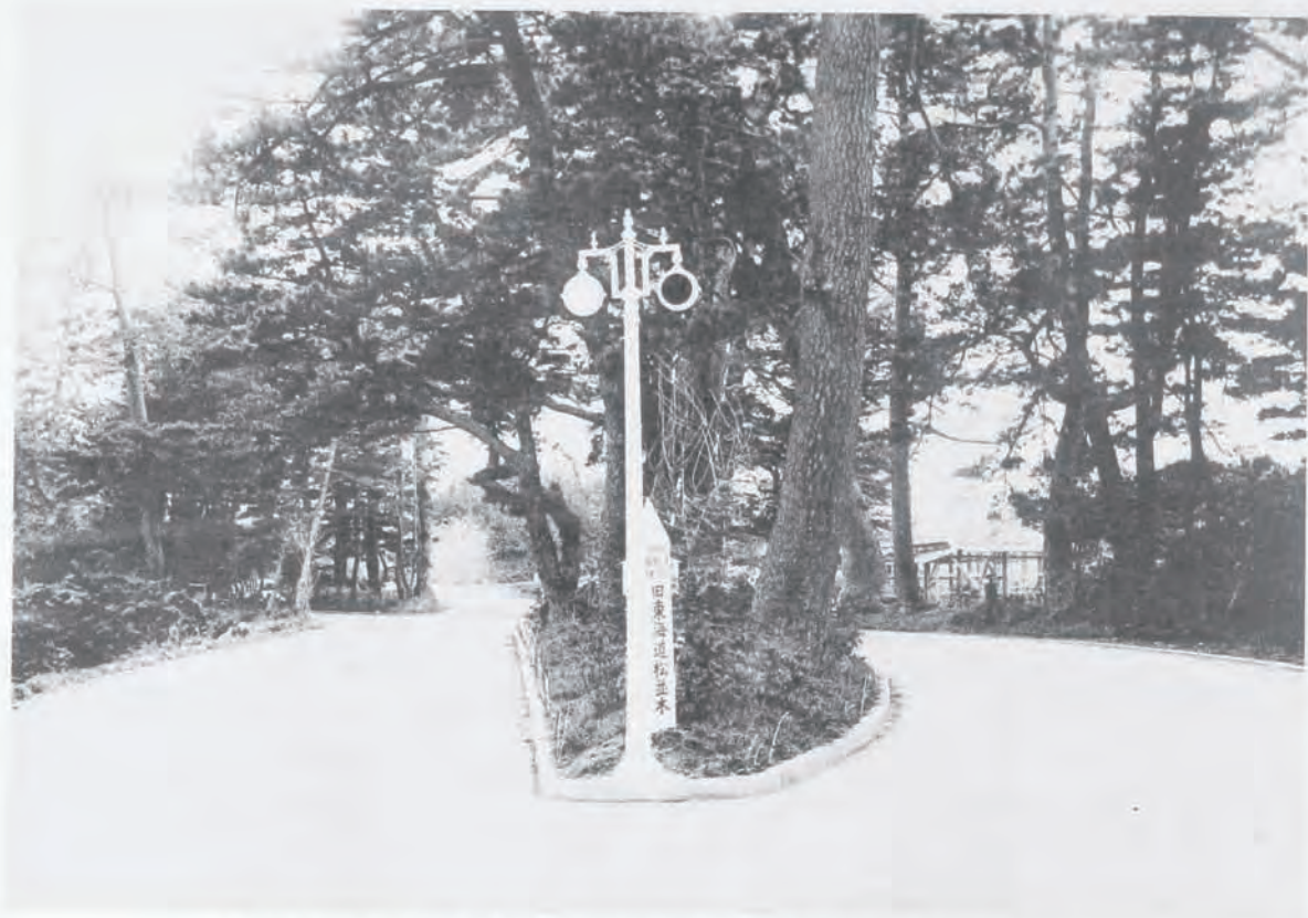
( 59 ) 國道一號線(戸塚)改良工事複線道路 其 一 (神奈川縣鎌倉郡戸塚町戸塚地内) 有効幅員各六米、混凝土舗装
