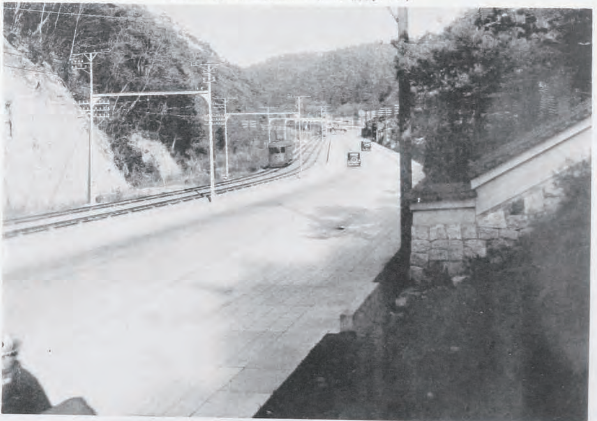
( 70 ) 國道二號線(滋賀)改良工事新道路 其一 (滋賀縣大津市一里町地内)
