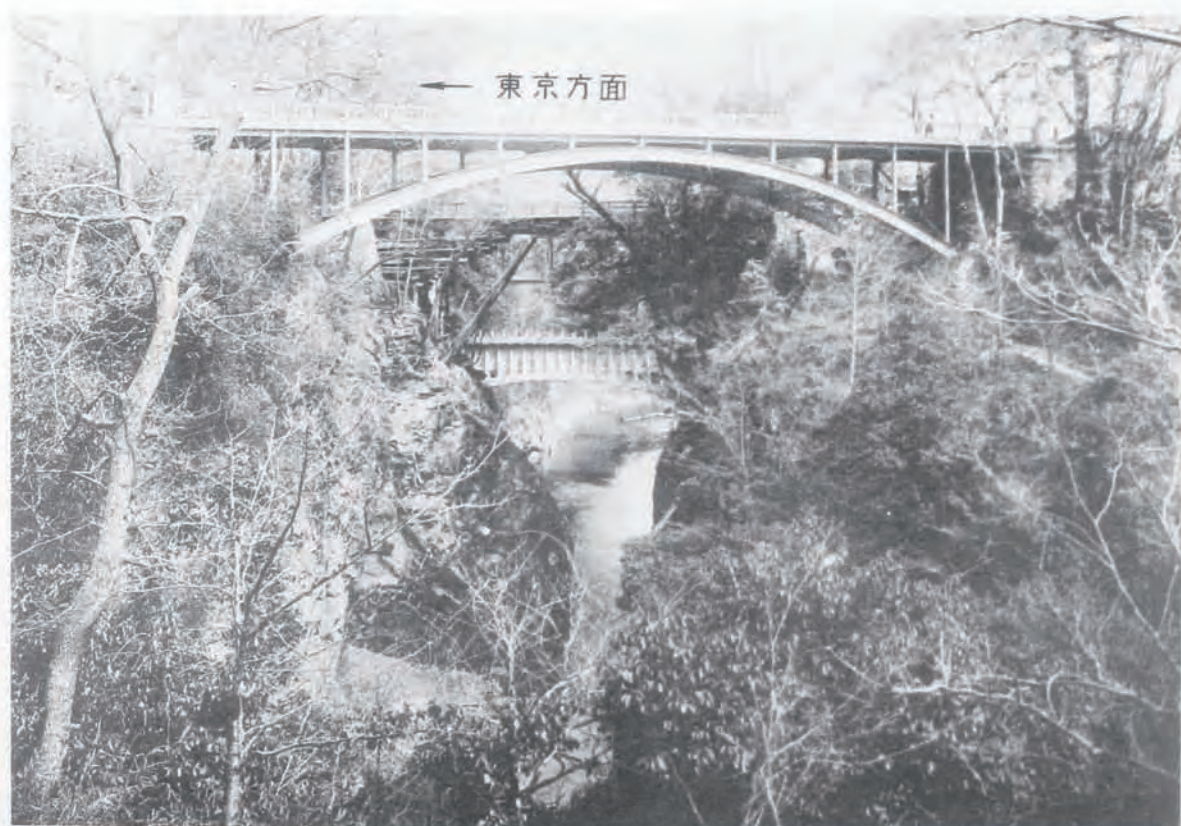
( 86 ) 國道八號線(猿橋)改良工事新猿橋 (山梨縣北都留郡大原村地内)
