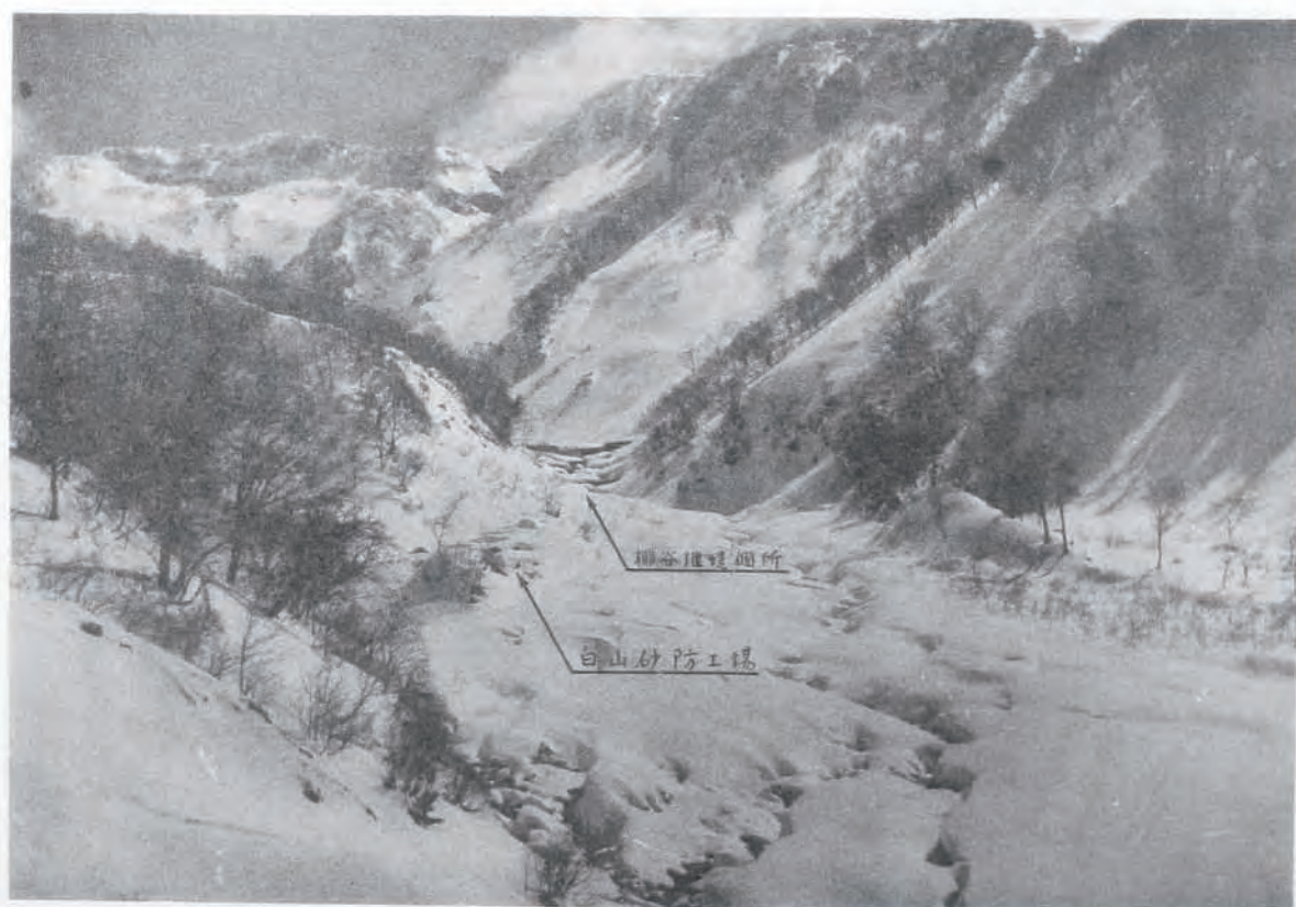
(32) 手取川流域砂防工事柳谷堰堤箇所及崩壊地ノ遠望 (石川縣能美郡白峯村地先)
