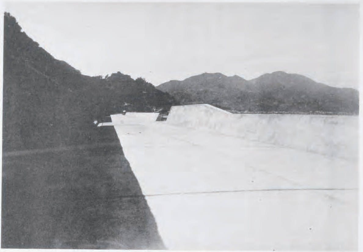
( 63 ) 國道一號線(由比)改良工事新國道 其二 ( 靜岡縣庵原郡由比町西倉澤地内 ) 有効幅員七米五
