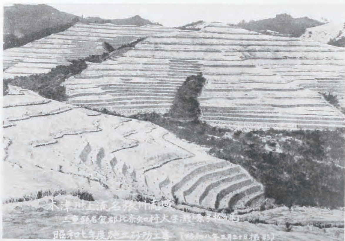
(38) 木津川流域砂防工事名張川筋山腹工 (三重縣名賀郡比奈知村地先)
