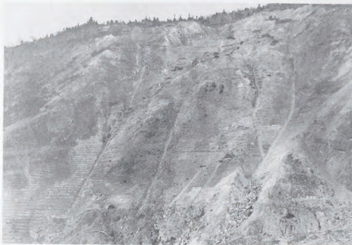
(37) 手取川流域砂防工事甚之助谷山腹工 (石川縣能美郡白峰村地先)
