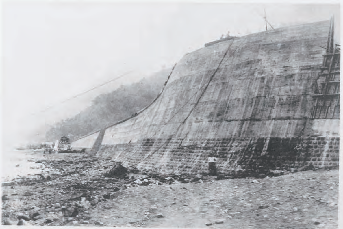
( 64 ) 國道一號線(由比)改良工事跨線橋附近海岸防波壁 ( 靜岡縣庵原郡由比町寺尾地内 ) 防波壁直高最高十二米三
