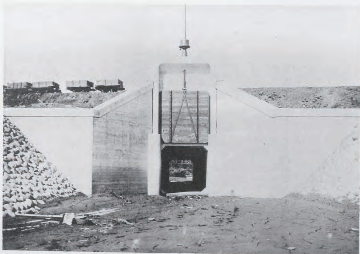
(4) 最上川改修工事小出本田下樋門
