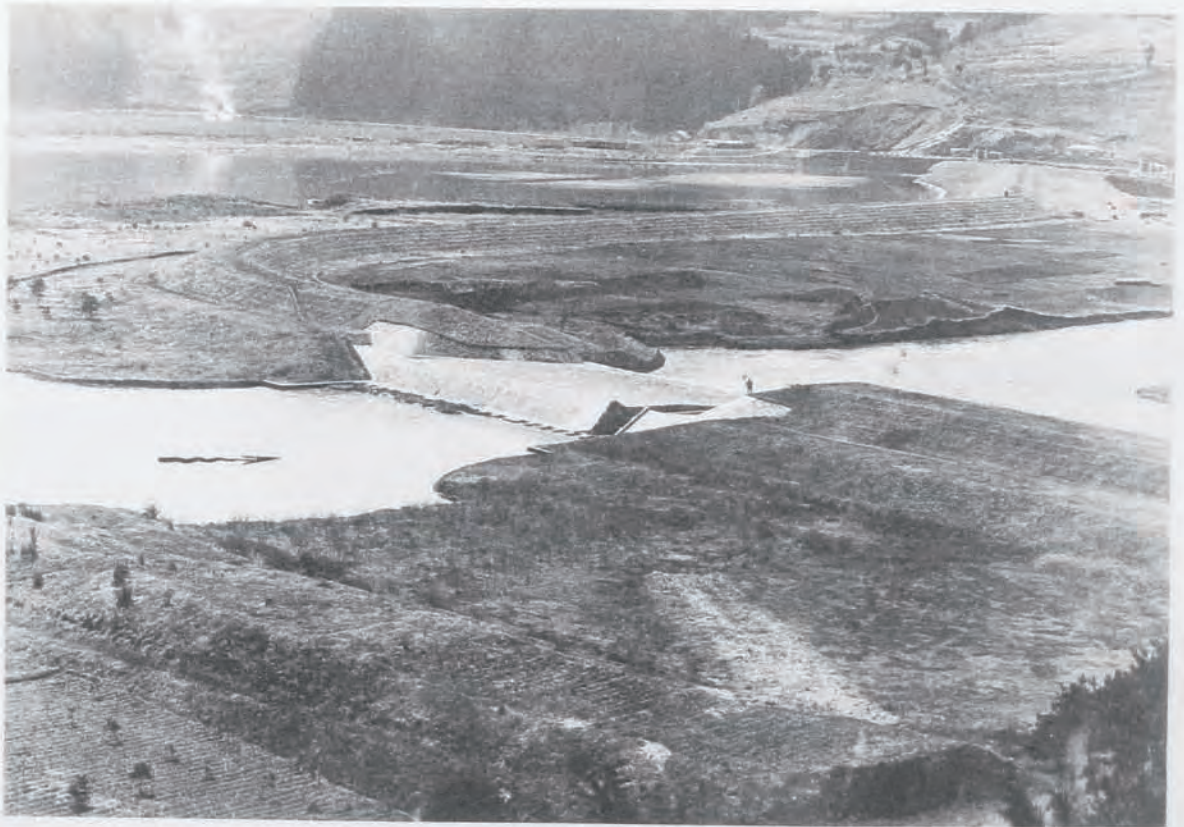
( 8 ) 北上川改修工事鴉波洗堰 (宮城縣遠田郡豊里村地先) 洗堰ハ高一米三、幅九十糎ノ暗渠十八連 及其上部長五十一米ノ溢流部ヨリ成ル
