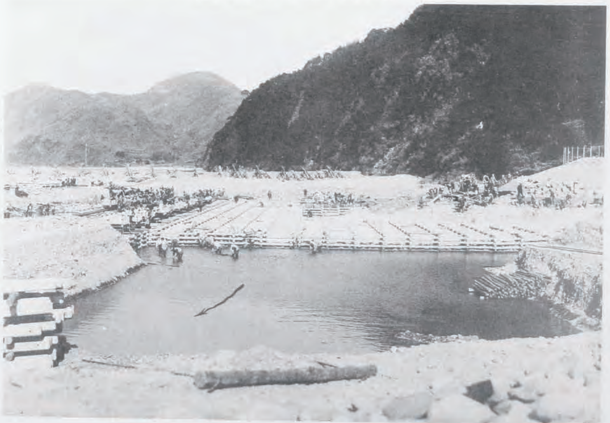
(12) 富士川下流改修工事岩本水制根固方格枠
