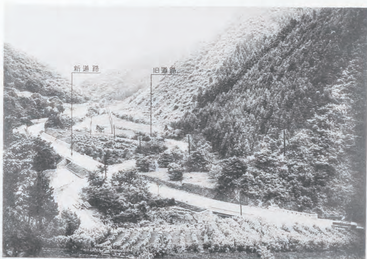
(82) 国道八號線(淺川)改良工事新道路
