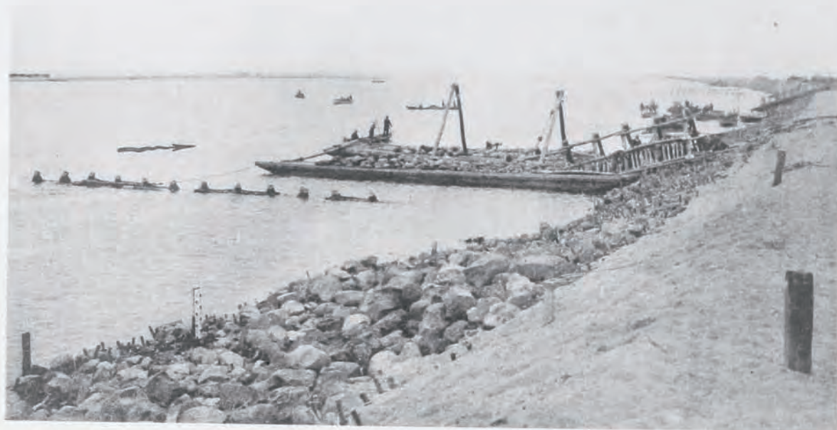
(5) 最上川改修工事宮野浦護岸合掌枿沈設 (山形縣西田川郡袖浦村大字宮野浦地先)
