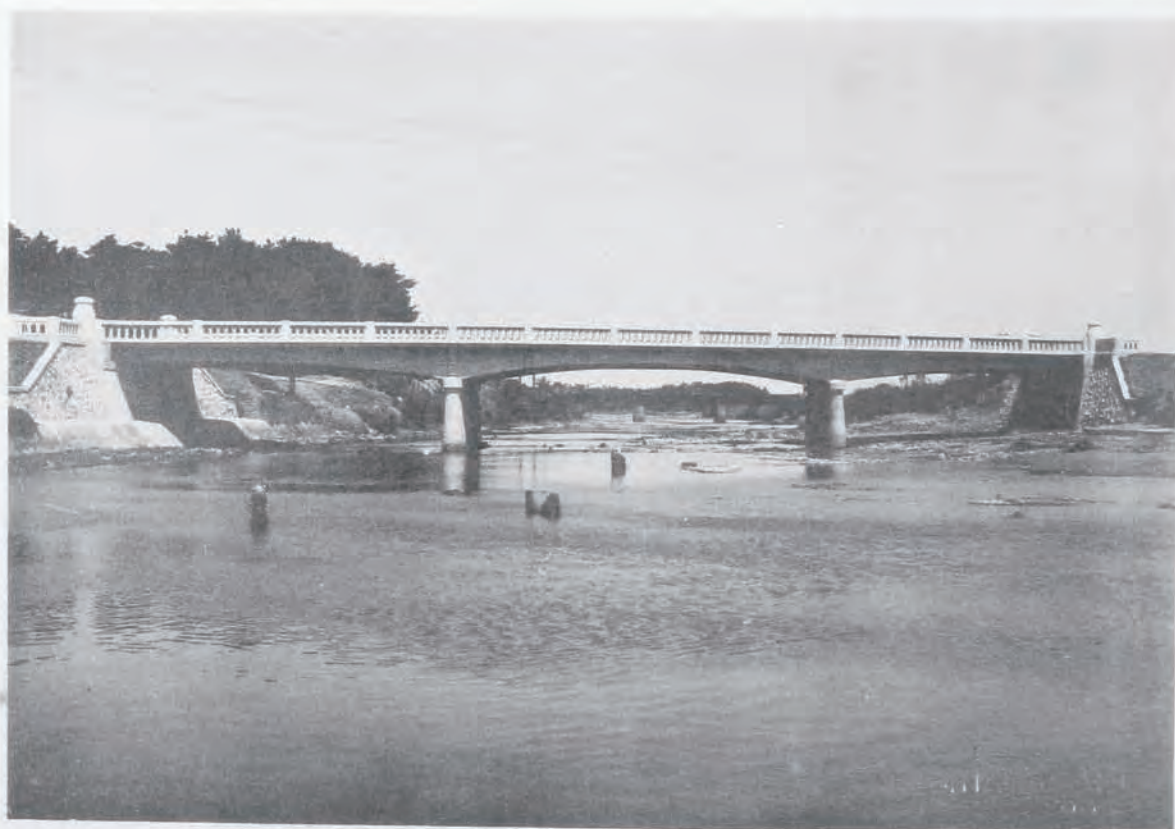
( 76 ) 國道二號線(古賀)改良工事花鶴橋 (福岡縣糟屋郡席内村大字古賀地内)
