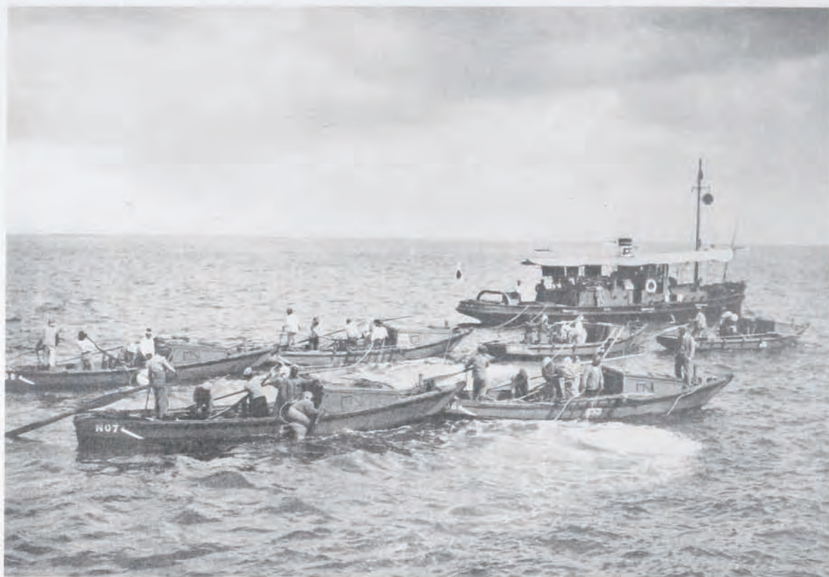
(39) 關門海峽改良工事金伏丸鑽孔作業 (昭和八年十二月二十八日下關要塞司令部檢査済)
