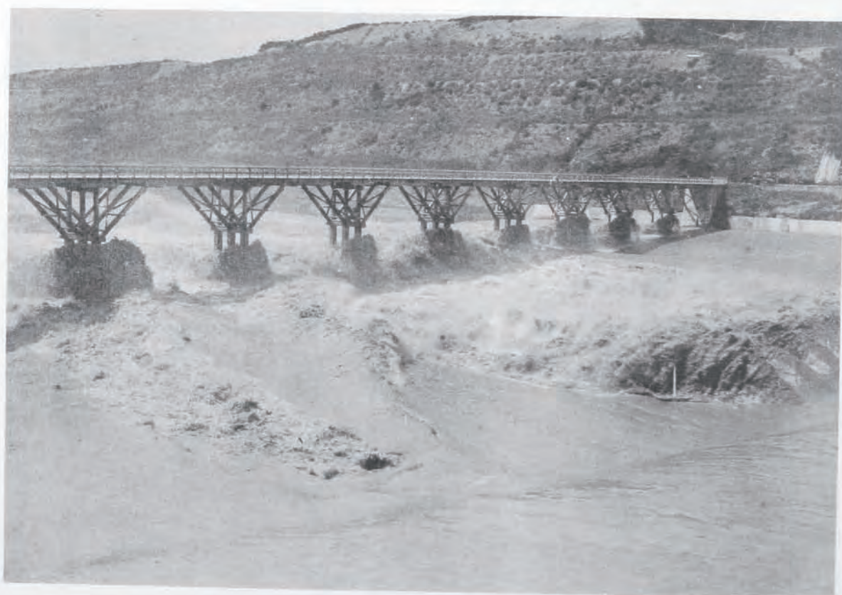
(26) 信濃川維持工事洪水時可動堰全扉開放ノ第二床固 (新潟縣三島郡寺泊町野積地先)
