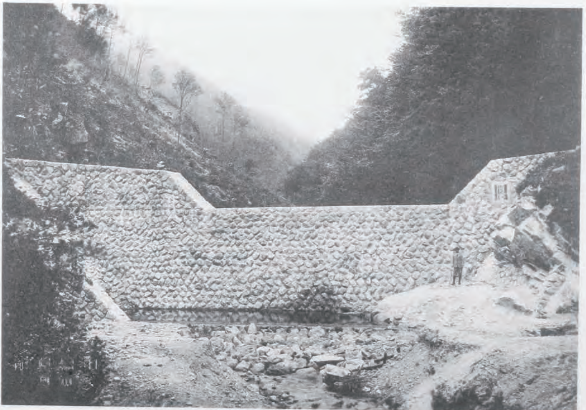
(28) 鬼怒川流域砂防工事男鹿川左支大鹽澤筋琵琶窪堰堤 (栃木縣鹽谷郡三依村地先)
