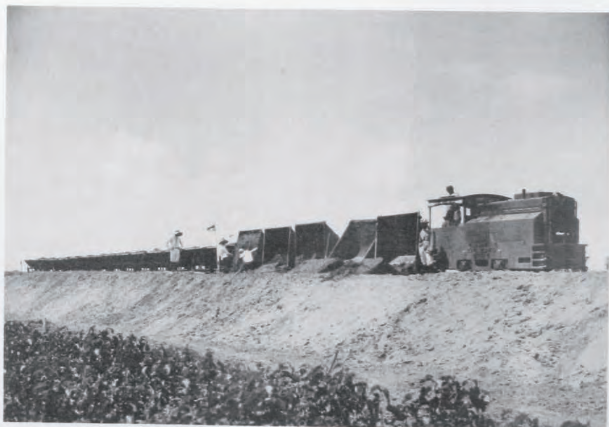
(24) 大淀川改修工事城ヶ崎築堤土運搬 (宮崎縣宮崎郡赤江町城ヶ崎地先)
