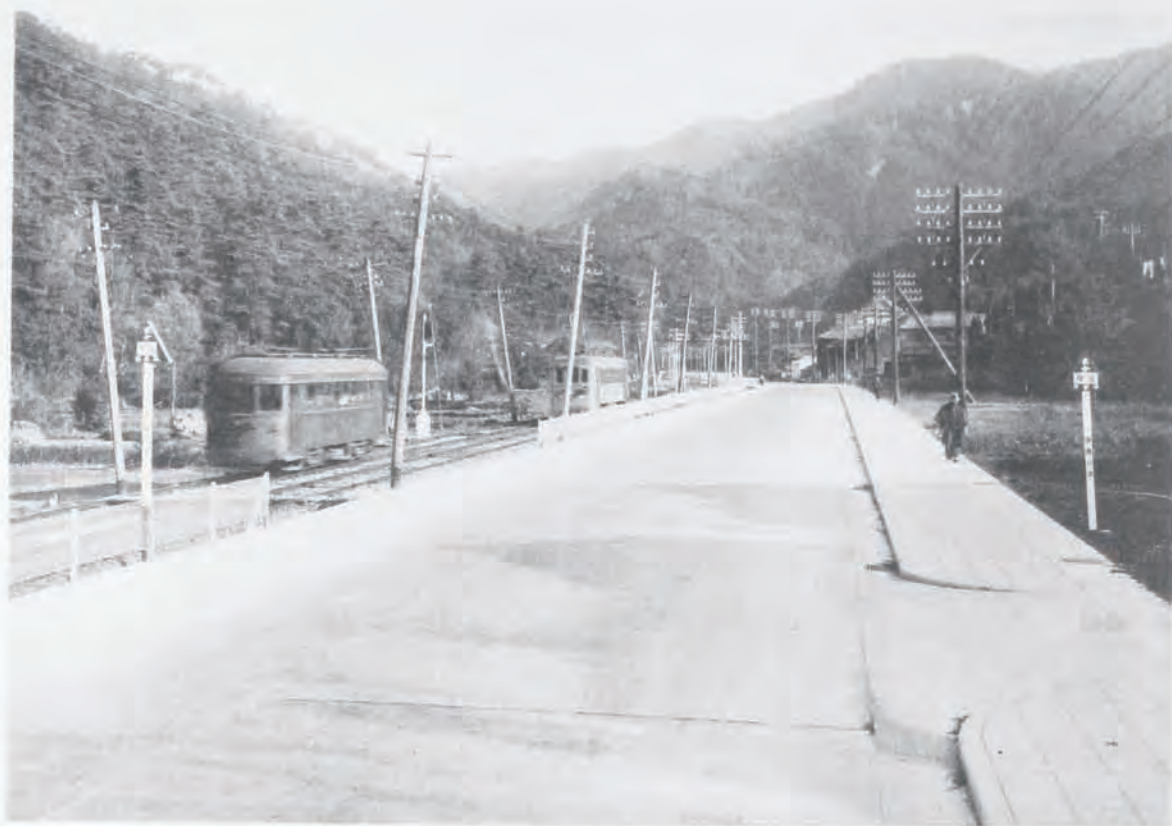
(71) 國道二號線(滋賀)改良工事新道路 其二 (滋賀縣大津市藤尾町地内)
