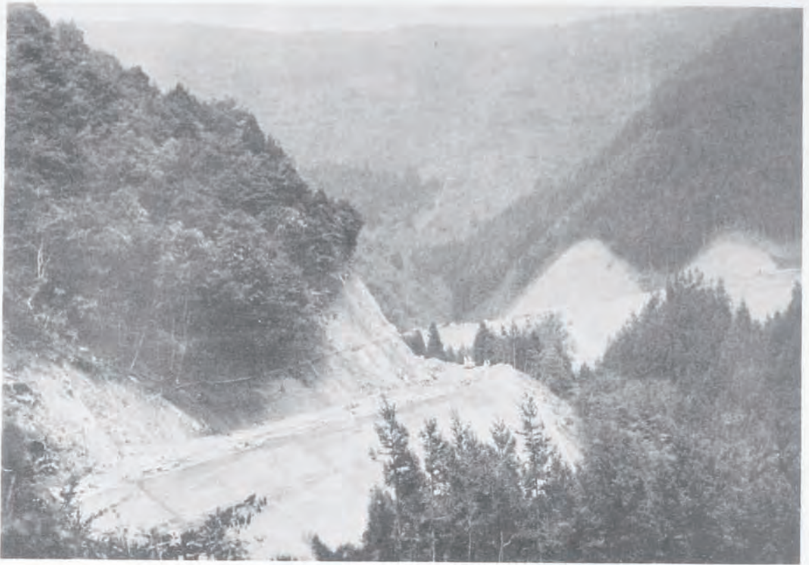
(83) 國道八號線(與瀬)改良工事中ノ新國道 (神奈川縣津久井郡千木良村尾花山地内)
