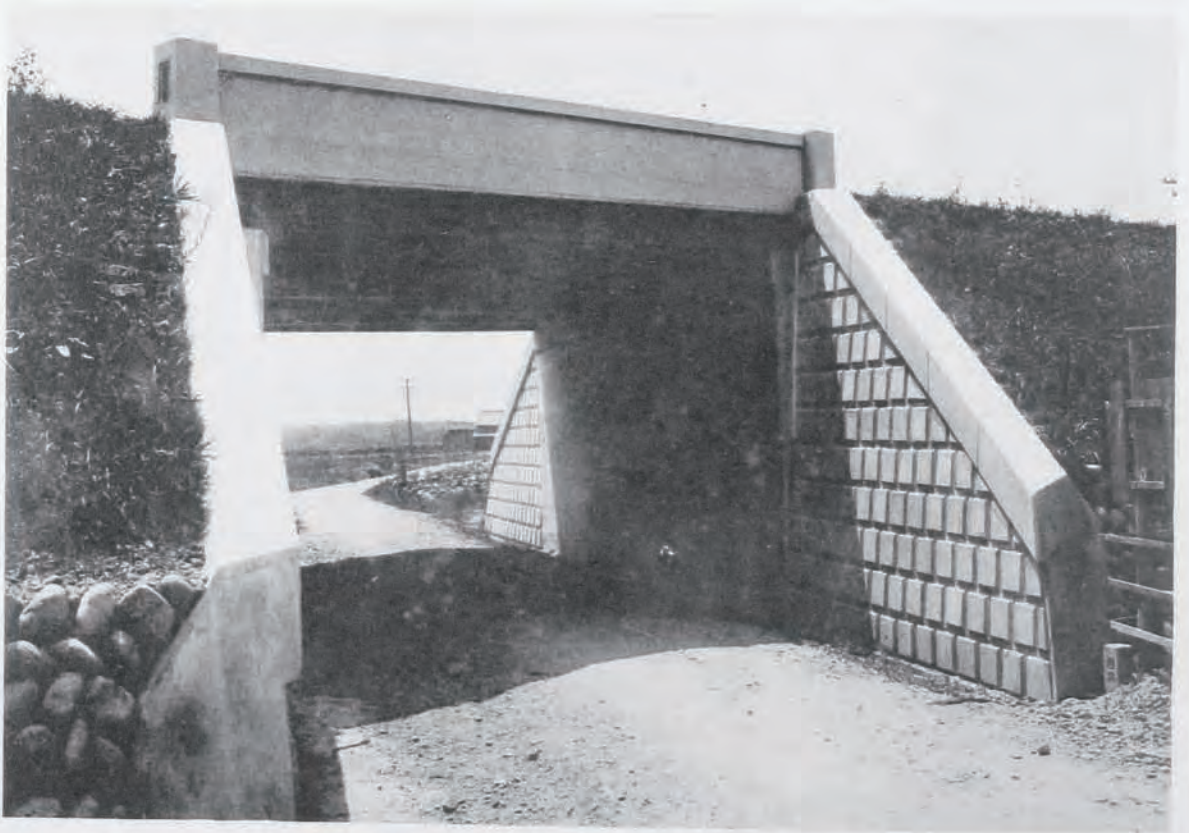
( 68 ) 國道一號線(桑名)改良工事架道橋 (三重縣桑名郡城南村大字和泉地内) 全長五米九、有効幅員九米
