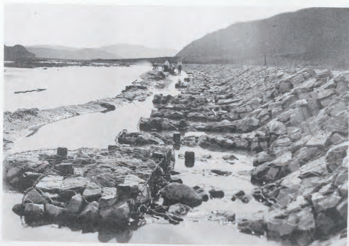
(22) 蘆田川改修工事郷分護岸 (廣島縣沼隈郡郷分村地先)
