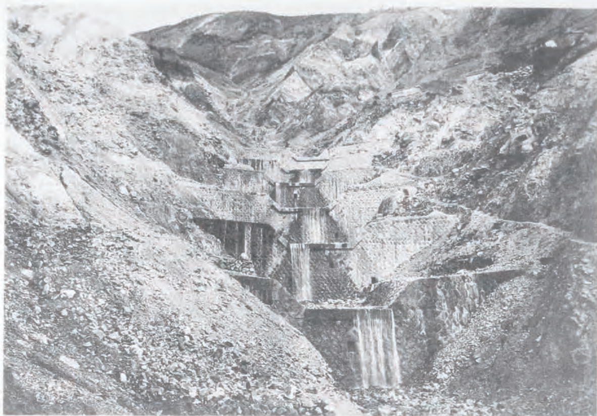
(33) 手取川流域砂防工事甚之助谷上流部階段堰堤 (石川縣能美郡白峰村地先)
