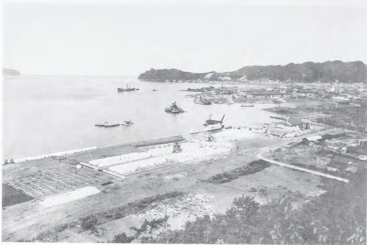
(57) 舞鶴港修築工事埋立地内方塊製作 (昭和七年十月十三日舞鶴要塞司令部検査済)
