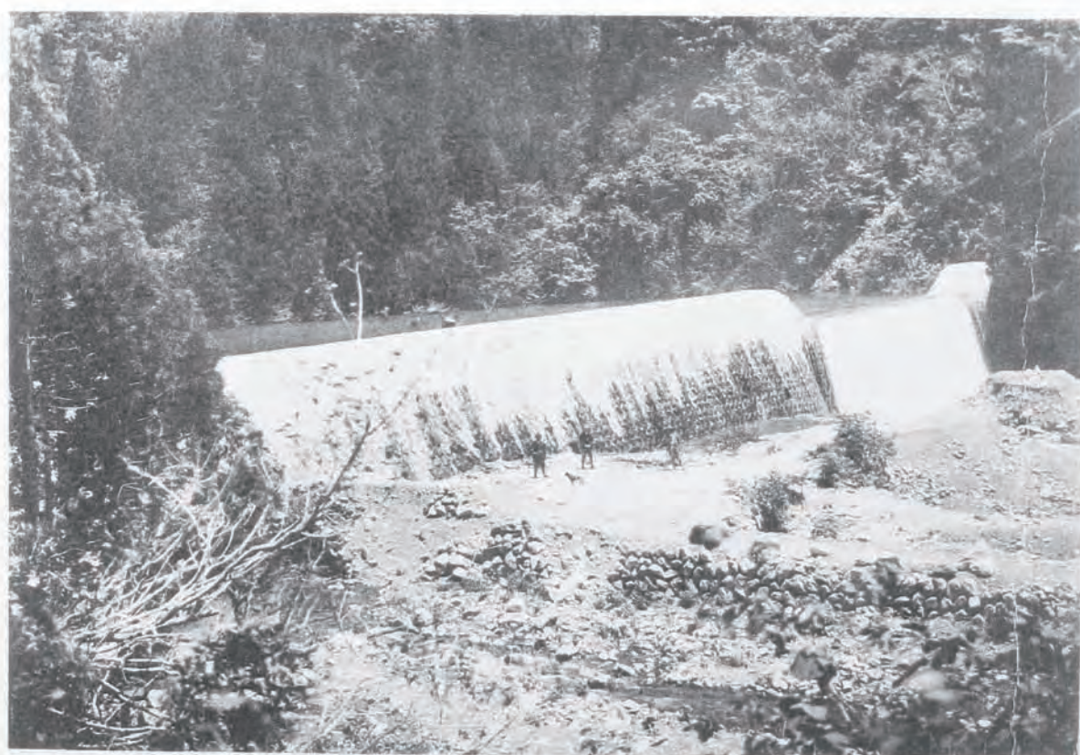
(34) 掛斐川流域砂防工事禮野堰堤
