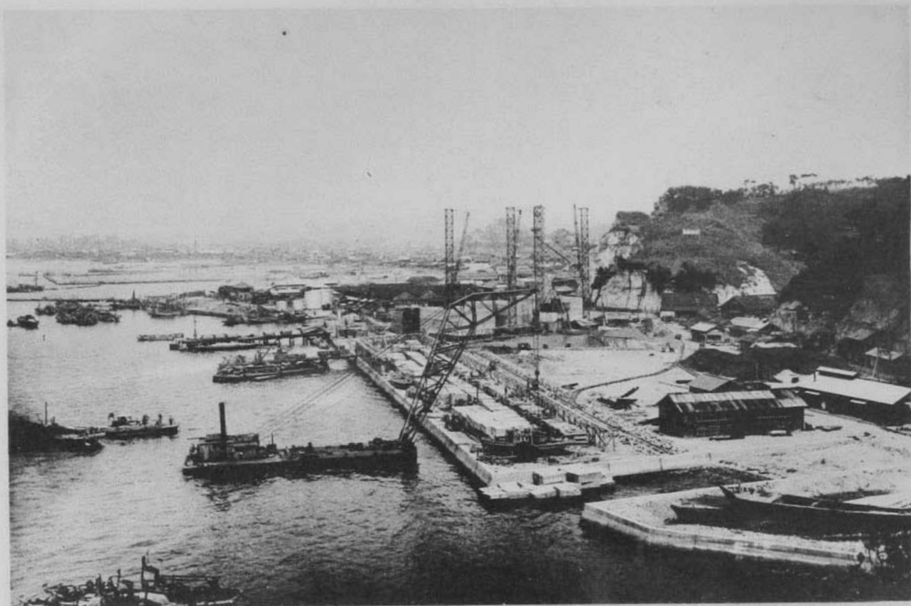
( 25 ) 小名濱港修築工事函塊、方塊製造場及護岸 (三崎ヨリ工事場及埋立地護岸ヲ望ム)
