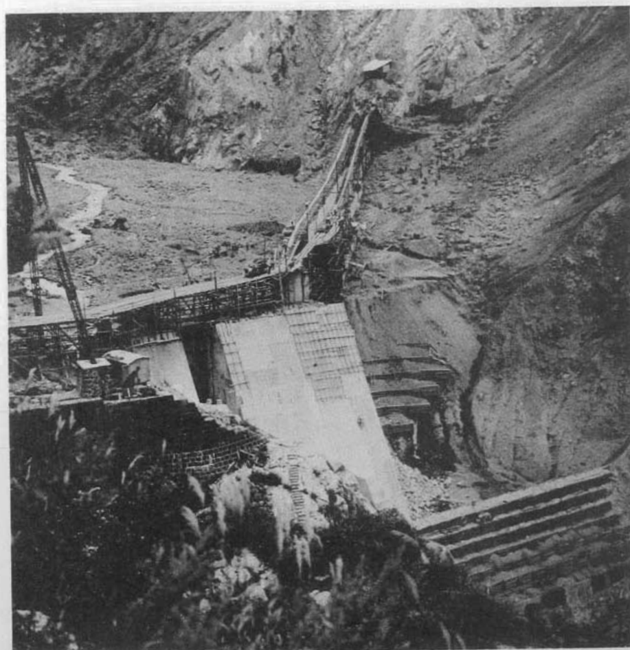
(13) 信濃川水系砂防工事坂巻上山腹工 (法留工、谷留水路張石、山腹石積、左岸ヨリ望ム)
