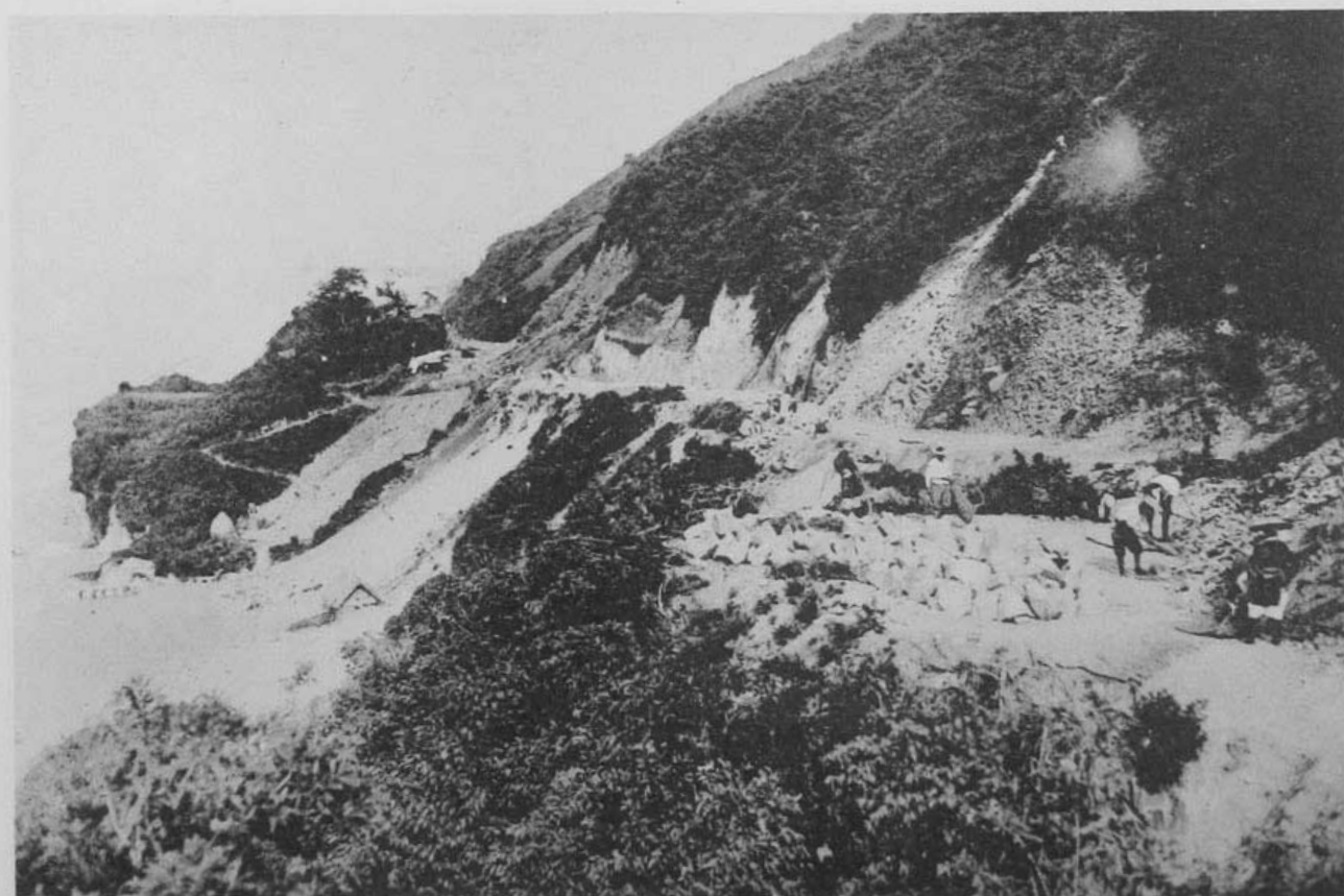
(48) 國道十一號線(新湯)改良工事切取工 (新湯縣西頸城郡青海道路工事落水附近)
