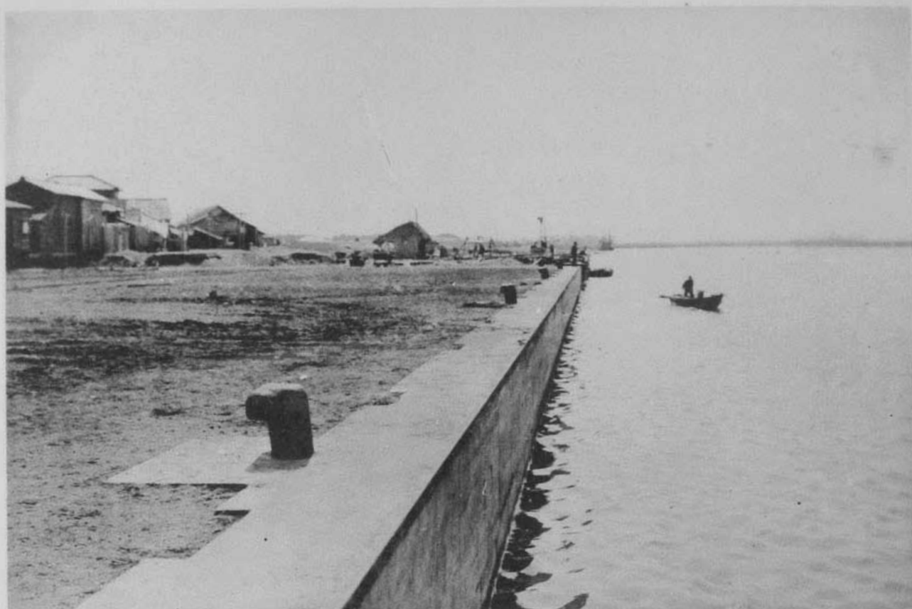
( 1 ) 最上川改修工事第一酒田護岸 (酒田市船場町地先、水深四米五)
