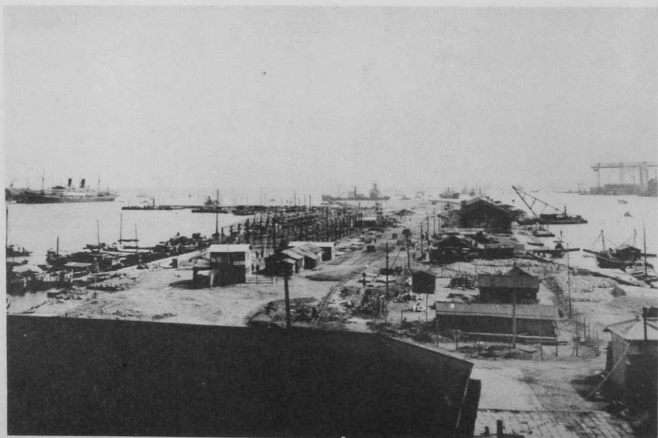
( 18 ) 神戸港修築工事海岸通突堤全景 (根元ヨリ望ム)
