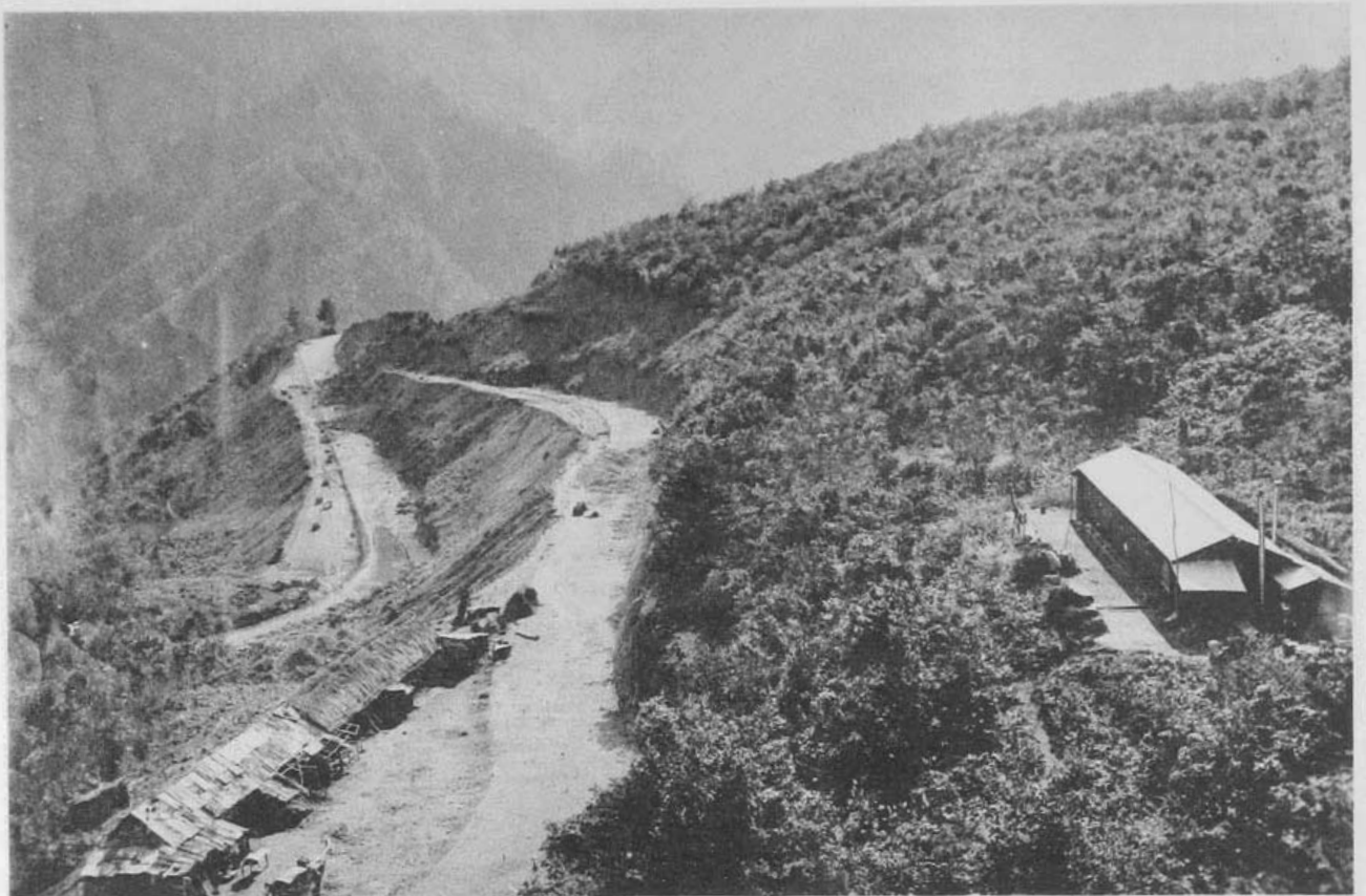
(41) 國道五號線(福島)改良工事新設國道 (福島縣信夫郡中野村地内、有効幅員六米)
