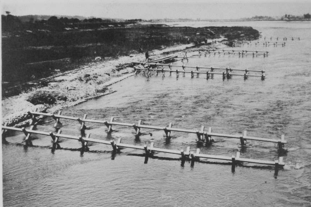
( 5 ) 神通川改修工事有澤高水敷護岸水制 (富山縣婦負郡神明村有澤地先、法止蛇籠据付作業)
