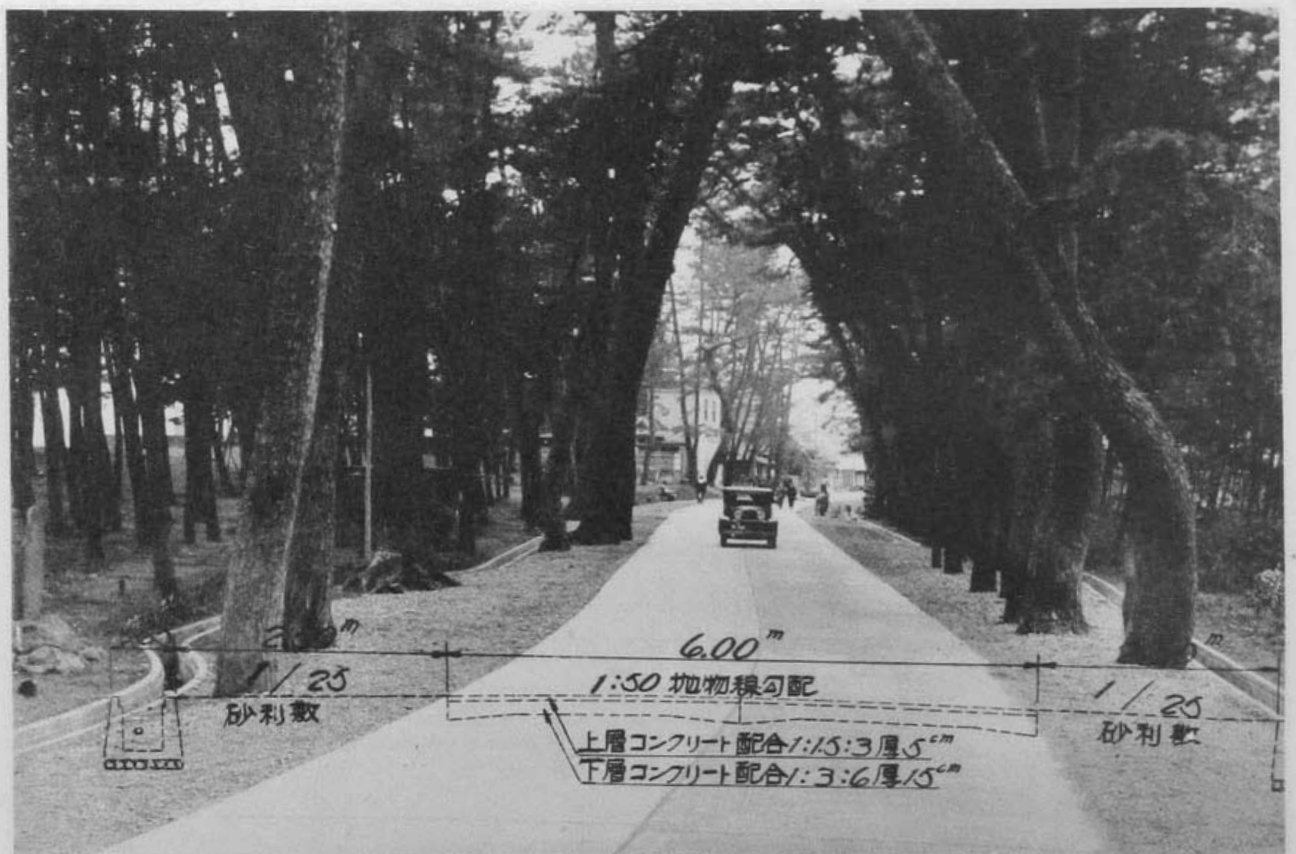
( 32 ) 國道一號線(酒匂)改良工事竣成道路 (神奈川県足柄下郡酒匂村大字小八幡地内)
