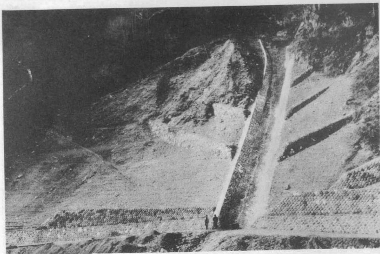
(13) 信濃川水系砂防工事坂巻上山腹工 (法留工、谷留水路張石、山腹石積、左岸ヨリ望ム)
