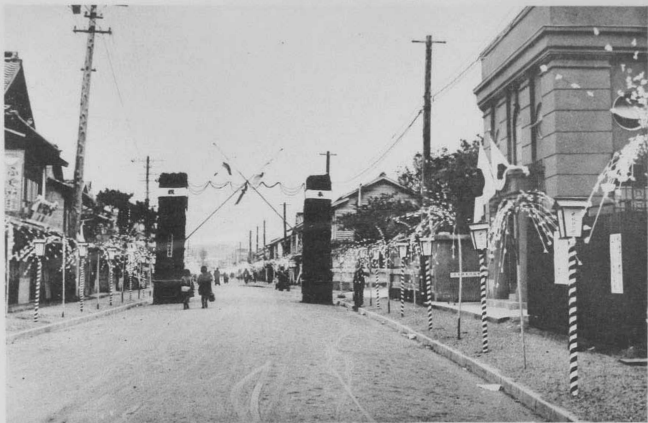
( 35 ) 國道二號線(東鄉)改良工事竣功道路 (宗像郡東鄉村大字東鄉測點二十號乃至三十號附近)
