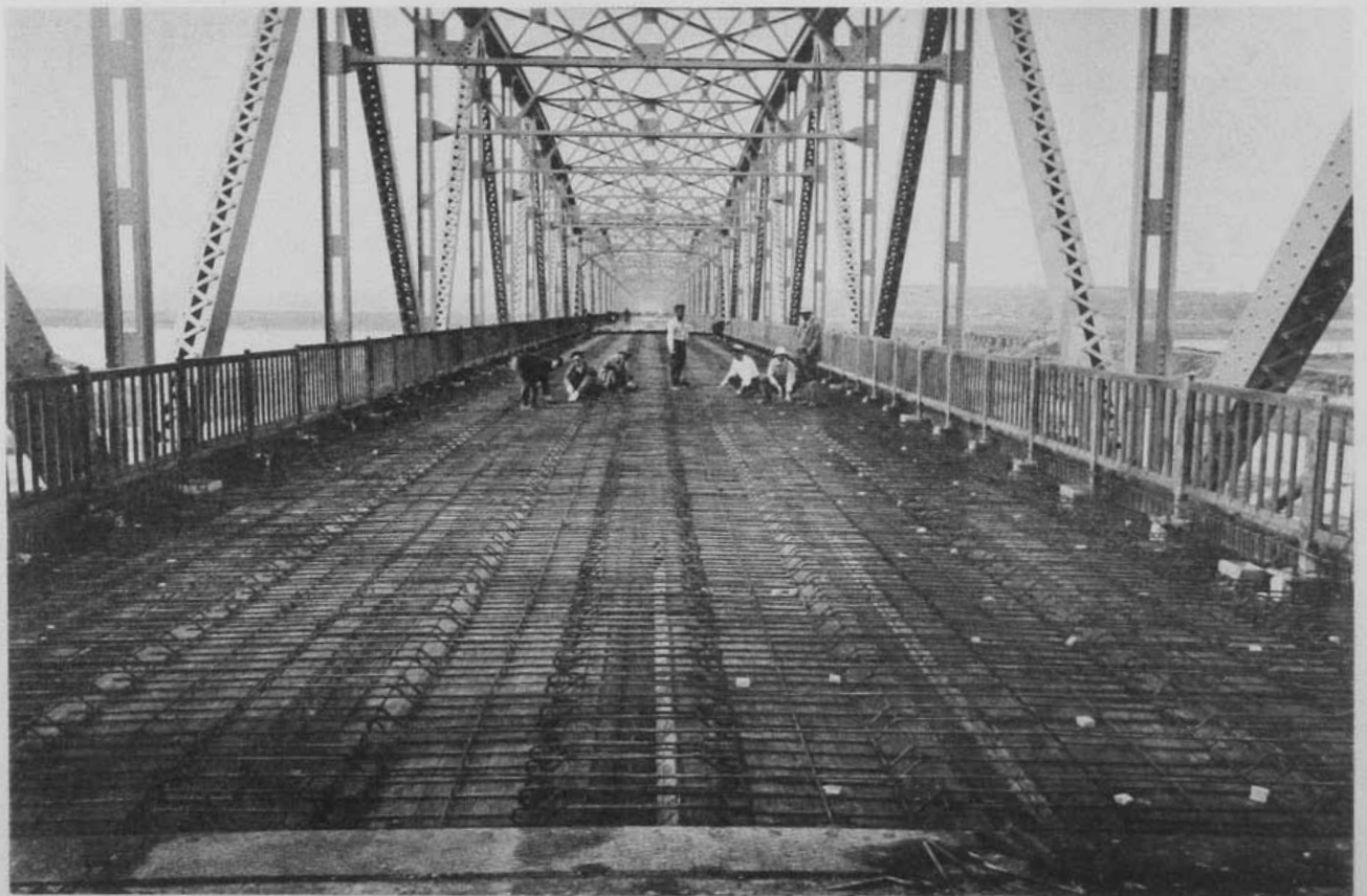
( 46 ) 國道十號線(秋田)改良工事雄物川橋床版鐵筋組立工 (秋田市牛島町及河邊郡新屋町百三段新屋地内)
