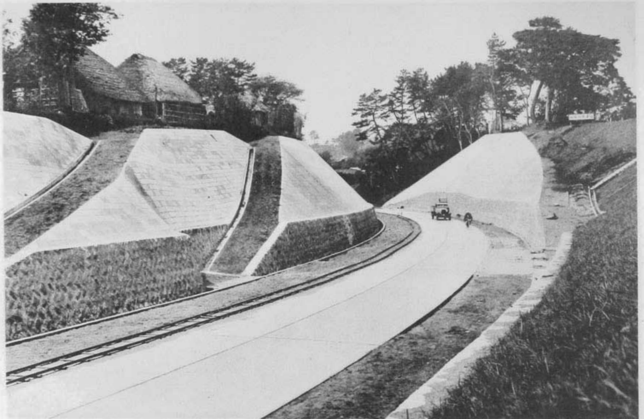
( 31 ) 國道一號線(吾妻)改良工事略竣工セル道路現況 (神奈川県中郡吾妻村大字川勾地内)
