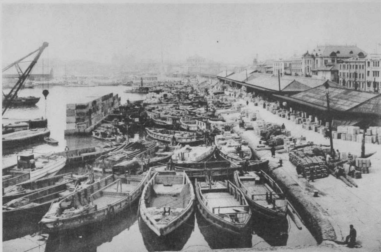
(19) 神戸港修築工事第二波止場 (物揚場工事作業)
