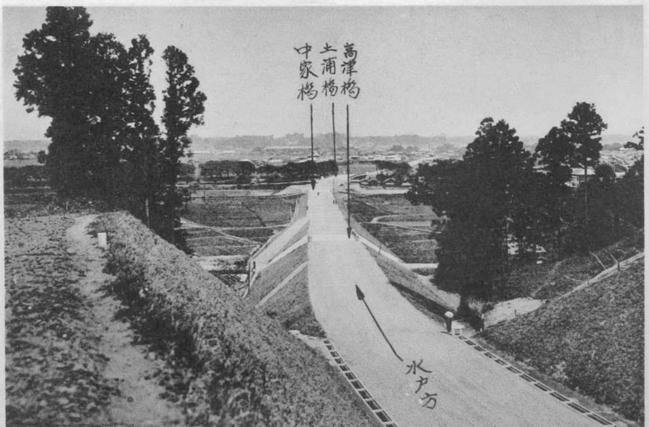
(42) 國道六號線(土浦)改良工事竣成道路全望 (茨城縣新治郡土浦町、中家村地内)
