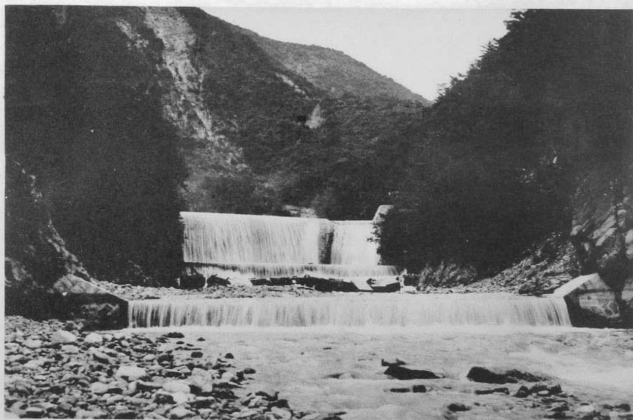
( 30 ) 相模川流域震災復舊砂防工事玄倉川筋立間堰堤補修工事 ( 神奈川縣足柄上郡三保村大字玄倉地先、第二副堰堤下流ヨリ望ム )
