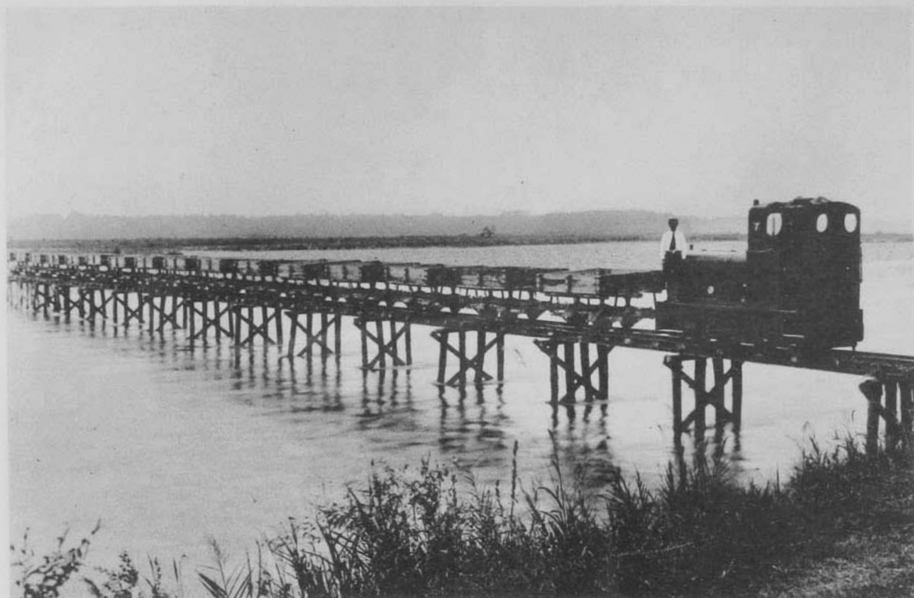
( 9 ) 鬼怒川改修工事岡本築堤自搬土運搬 栃木縣河内郡古里村大字下岡本地先、築堤延長一千六百二十八米二
