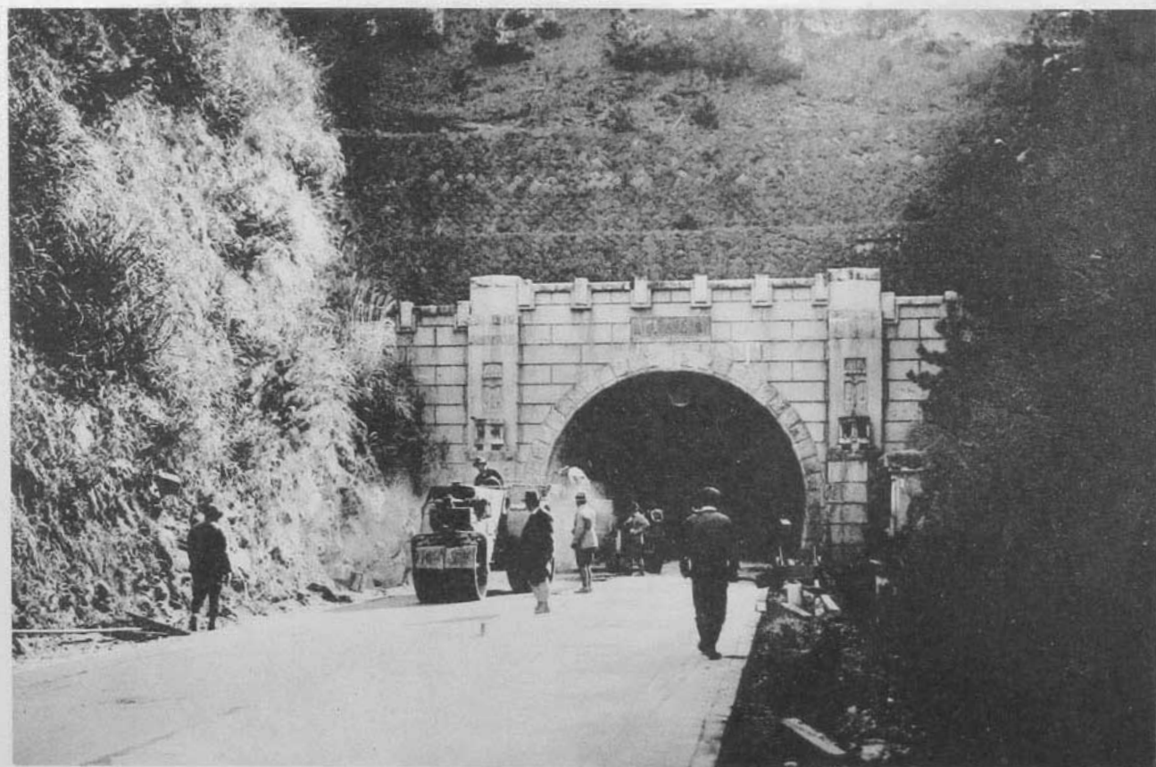
( 50 ) 國道二十五號線(長崎)改良工事鋪裝 (日見隧道南口トロカ式瀝青施工ノ狀況)
