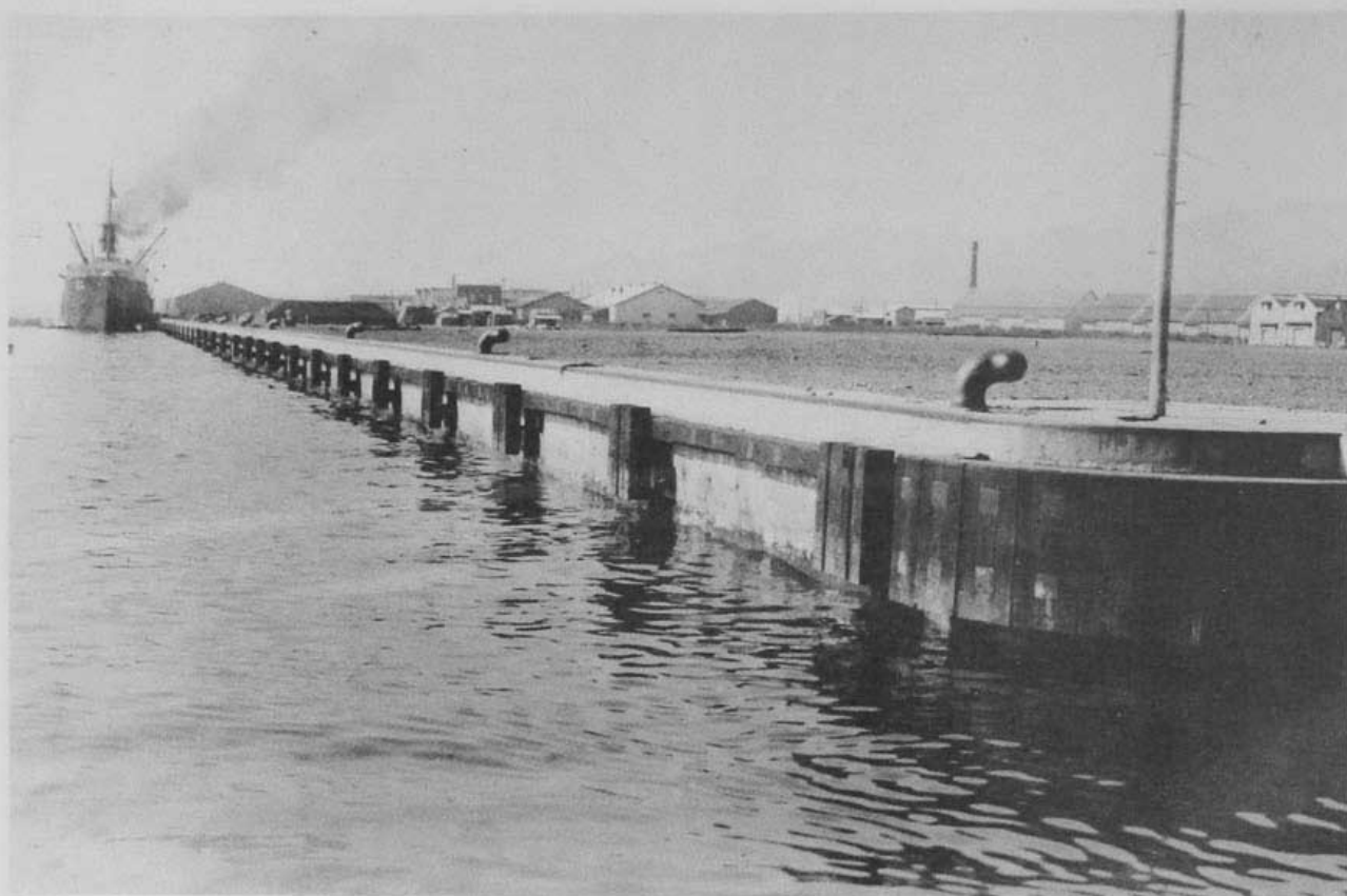
(21) 清水港修築工事岸壁 (竣功セル追加岸壁)
