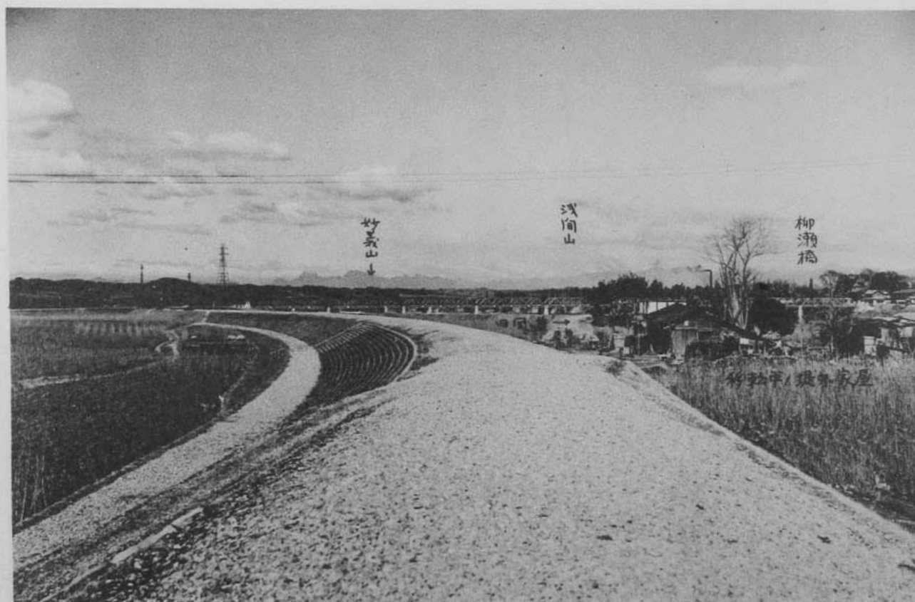
( 10 ) 烏、神流川改修工事烏川右岸堤防 (群馬縣多野郡小野村大字中島地先、上流ヲ望ム)
