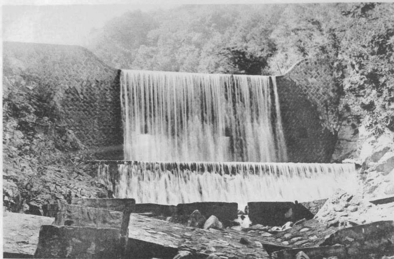
( 29 ) 相模川流域震災復舊砂防工事道志川筋大瀬戸堰堤 ( 神奈川縣津久井郡青地村地先、延長三十七米、 高十六米、堰堤及床固工事ヲ下流ヨリ望ム )
