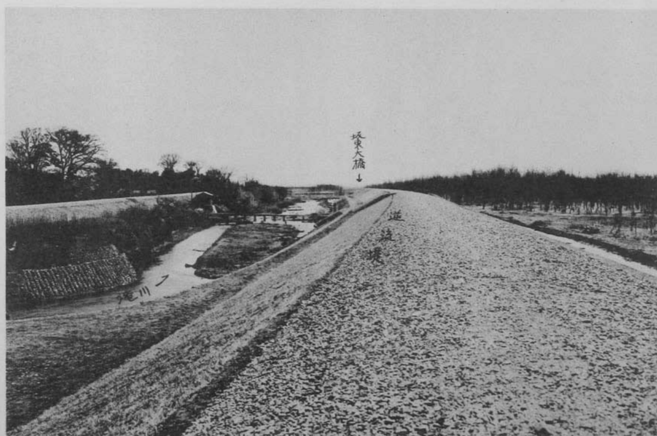
(12) 烏、神流川改修工事下茂木築堤 (群馬縣佐波郡芝根村地先、延長九百十米、瀧川落口ヨリ下流ヲ望ム)
