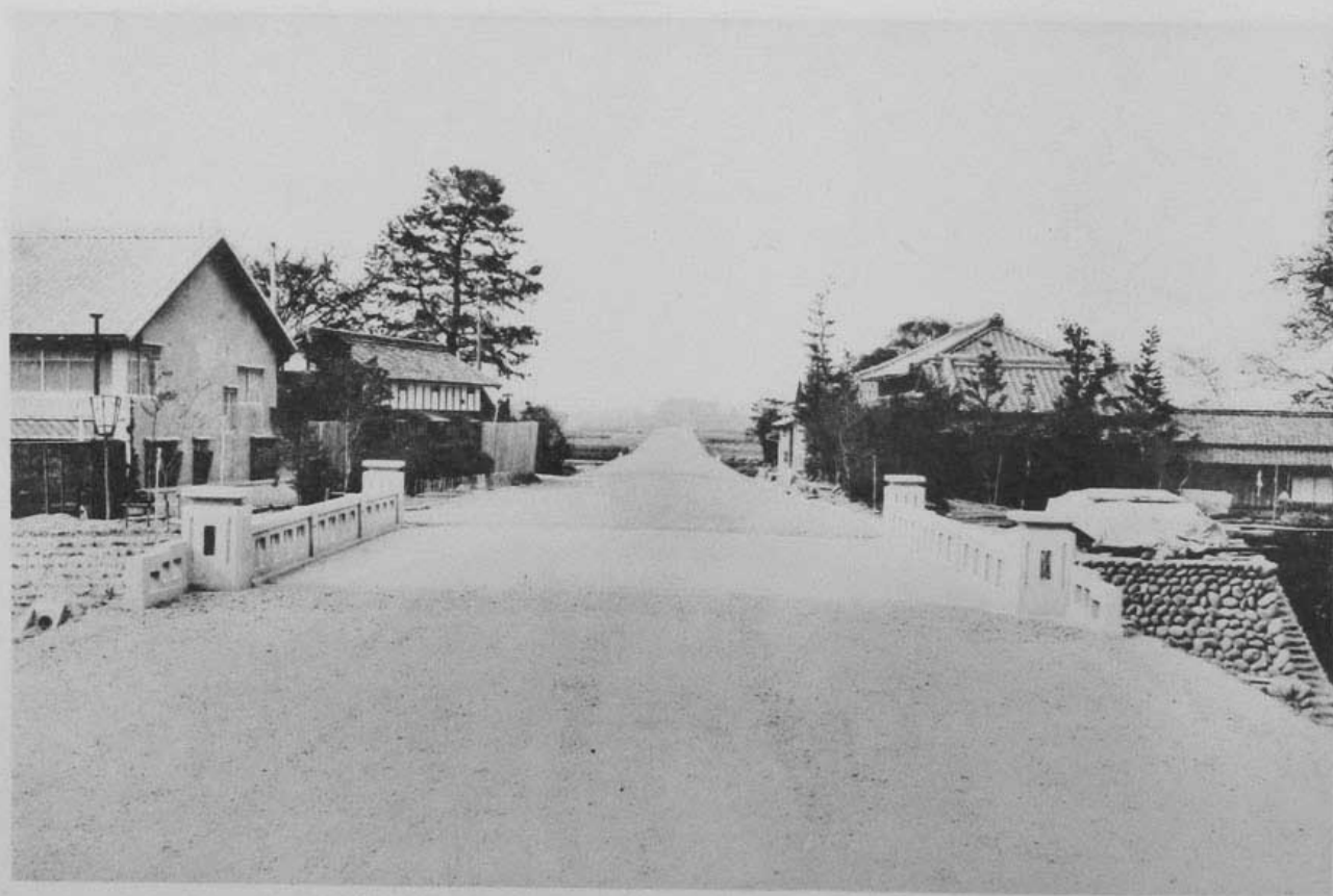
( 34 ) 國道一號線(長島)改良工事長島橋 (二號橋長島橋ヨリ起點タル木曾川方面ヲ望ム)
