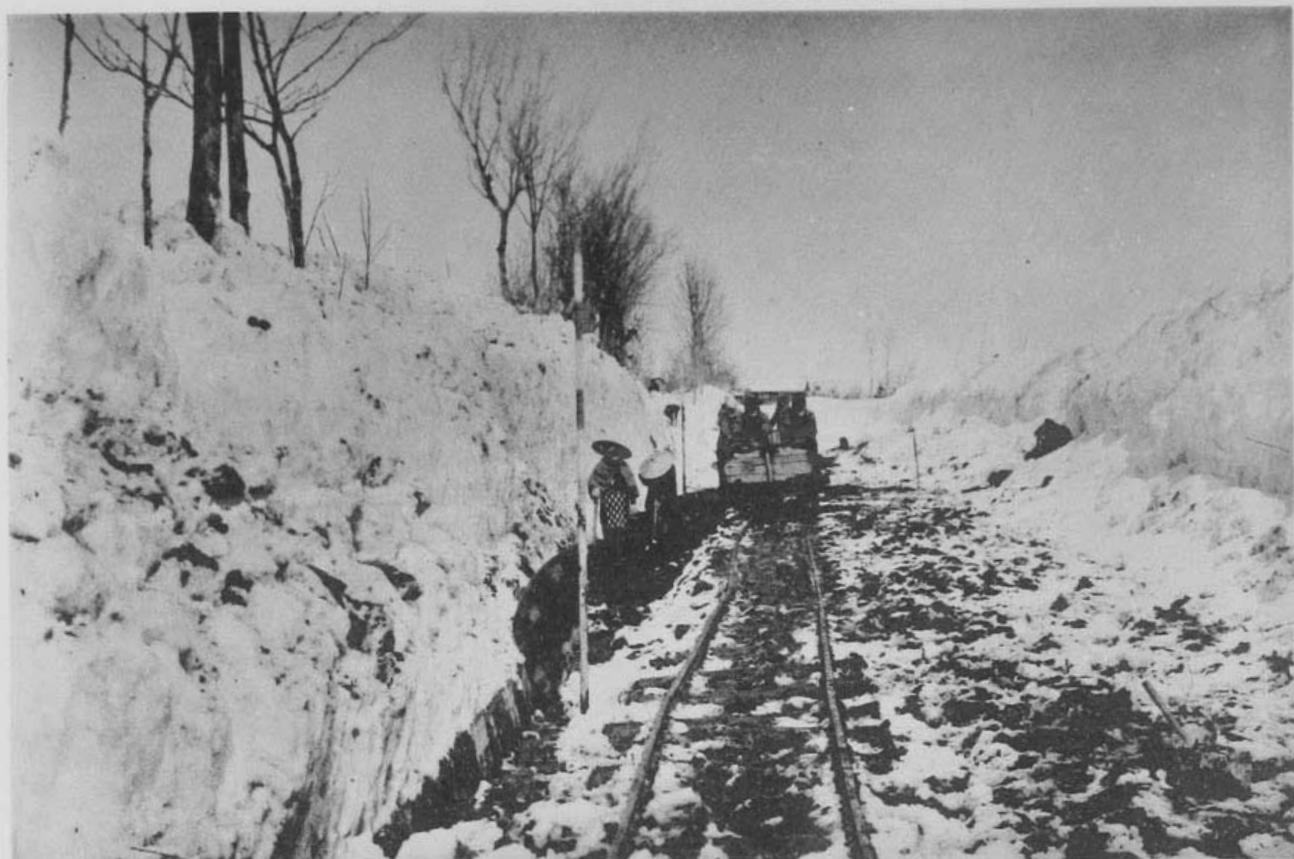
(47) 國道十號線(新湯)改良工事雪中作業 (新湯縣南蒲原郡中之島村地内)
