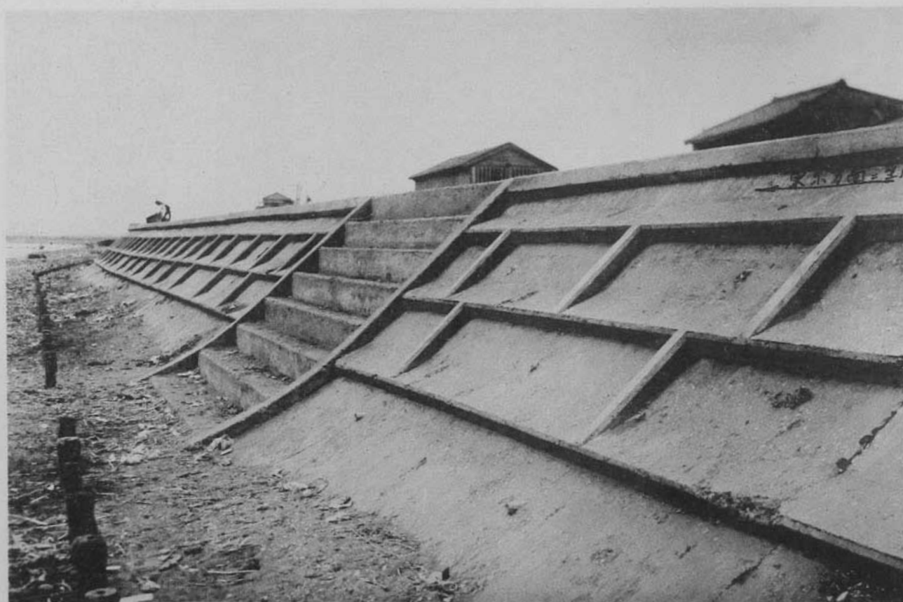
(44) 國道七號線(千葉)改良工事法固工 (千葉縣千葉郡檢見川町地先ノ海岸=施工ス)
