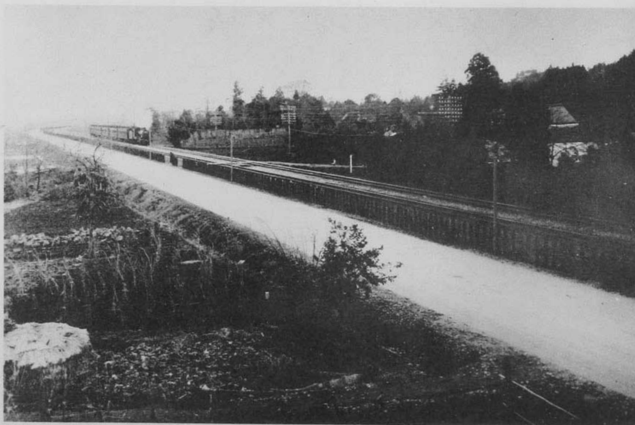
( 40 ) 國道四號線(宮城)改良工事混凝土鋪裝 (宮城縣名取郡館腰村地内、鋪裝幅員六米)
