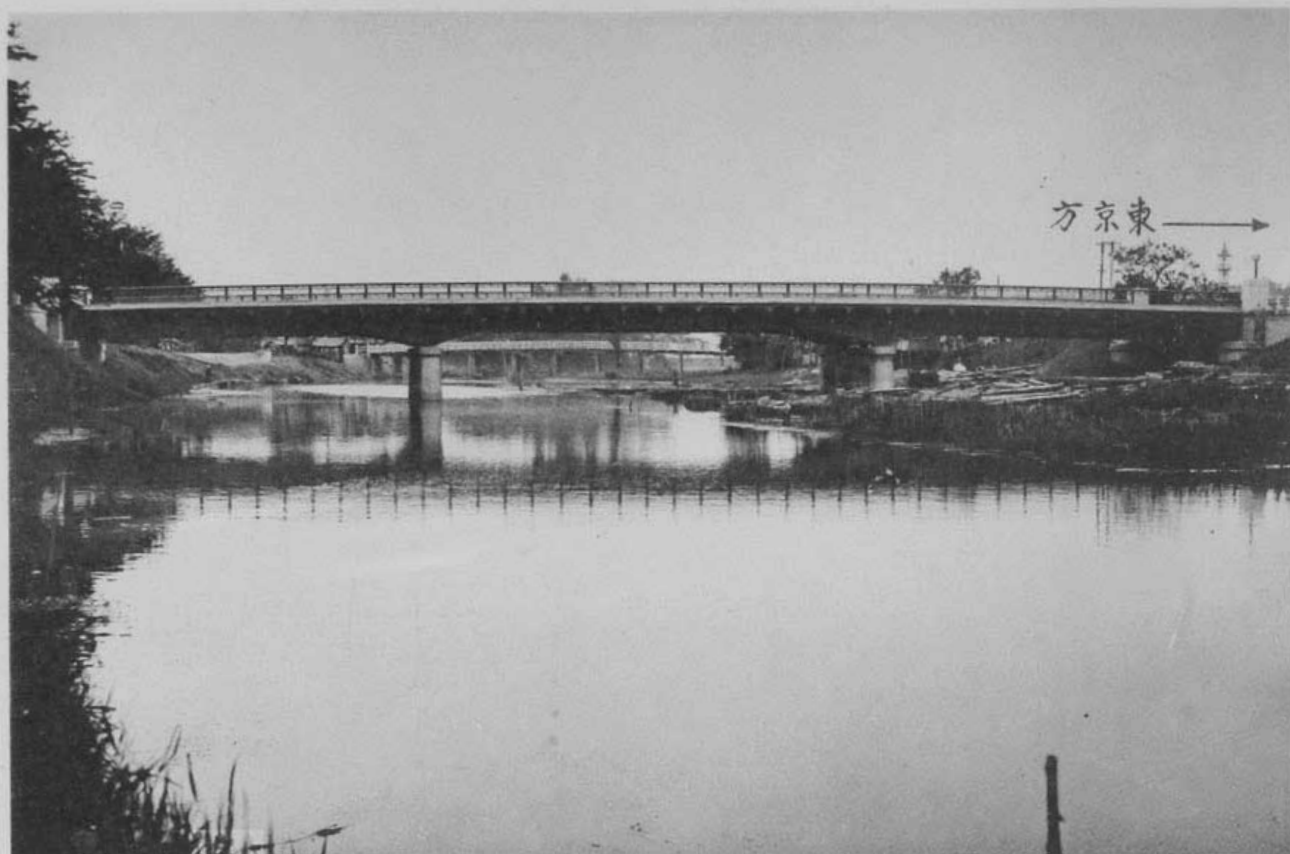
(43) 國道六號線(土浦)改良工事土浦橋 (茨城縣新治郡土浦町、中家村地内、ゲルバー 型鋼板桁橋、長六十五米、有効幅員十二米)
