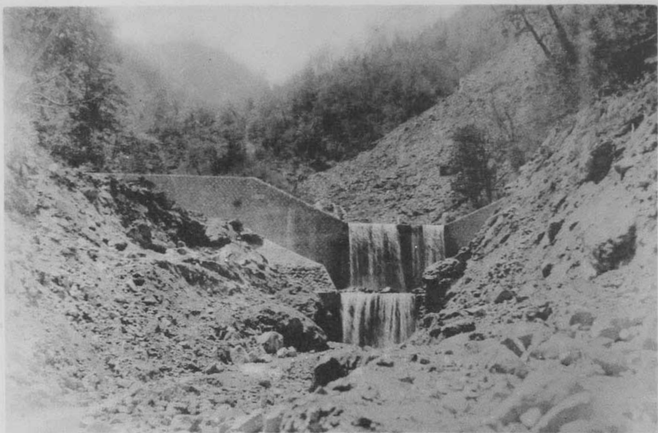
( 17 ) 神通川砂防工事足洗谷第一號堰堤 (岐阜縣吉城郡上寶村大字中尾地内)
