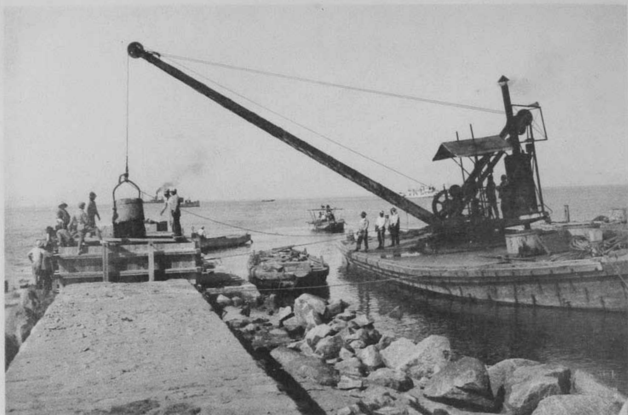
(3) 雄物川改修工事南突堤 (場所詰コンクリート作業)
