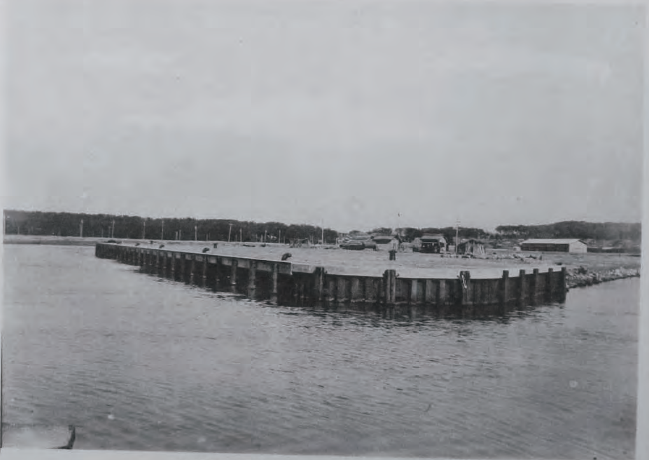
(35) 酒田港修築工事岸壁工事 (酒田市光ヶ丘地先) 岸壁長百二十五米、取付護岸三十四米
