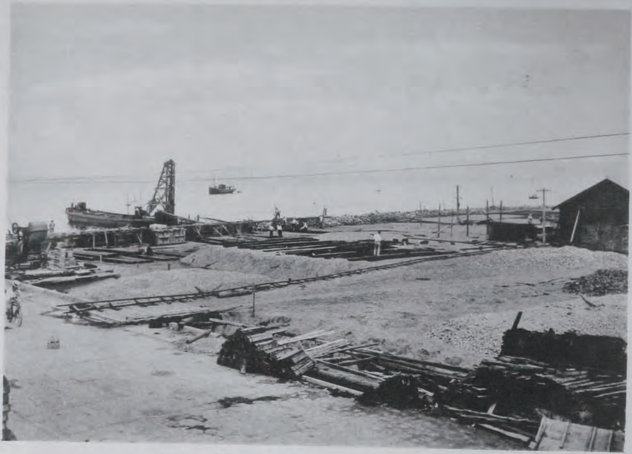
(34) 青森港修築工事埋立及物揚場護岸 鋼矢板打込、既設東防波堤上ヨリ望ム
