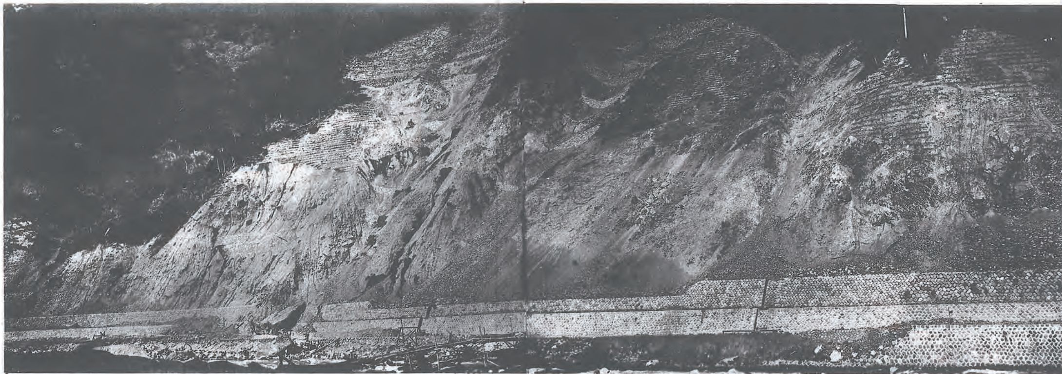
(13) 信濃川水系砂防工事保田小屋法留工及山腹工 (長野縣南安曇郡安曇村地内) 右岸下流ヨリ望ム
