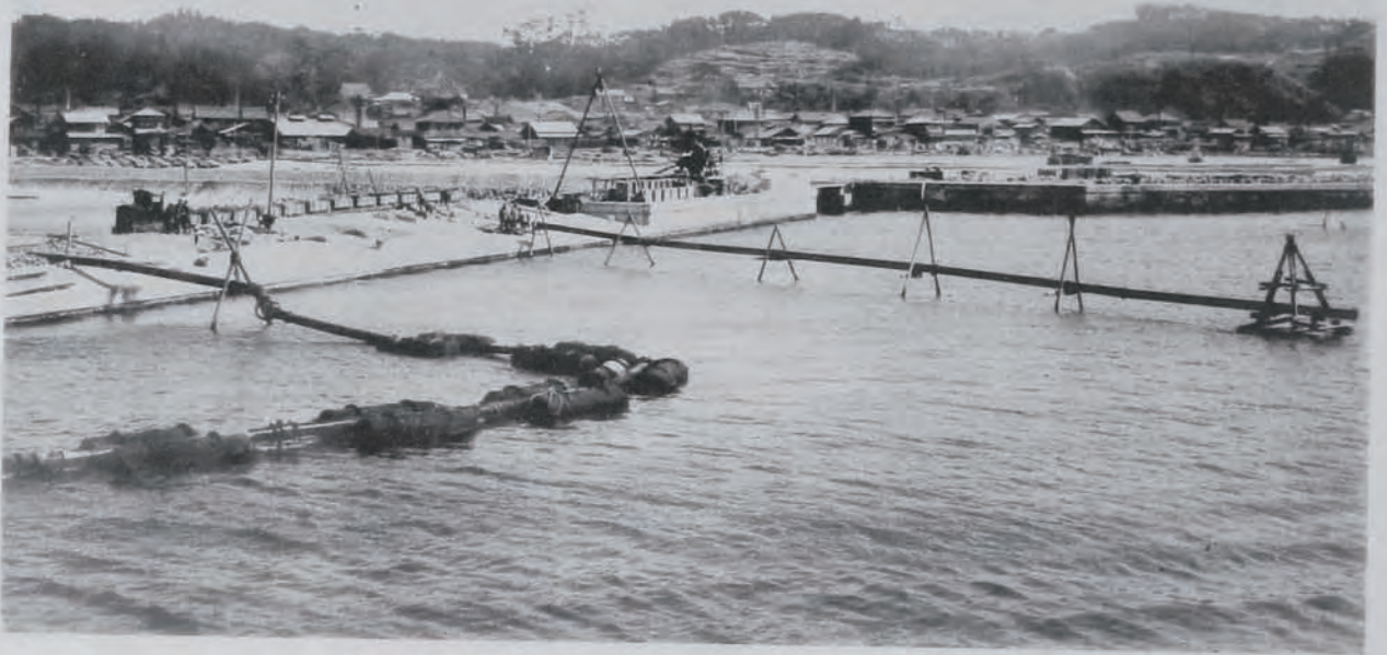
( 28 ) 小名濱港修築工事護岸及埋立工事 L型扶壁體物揚場護岸水深二米五、箇所及埋立 地ヲ岸壁ノ方ヨリ望ム
