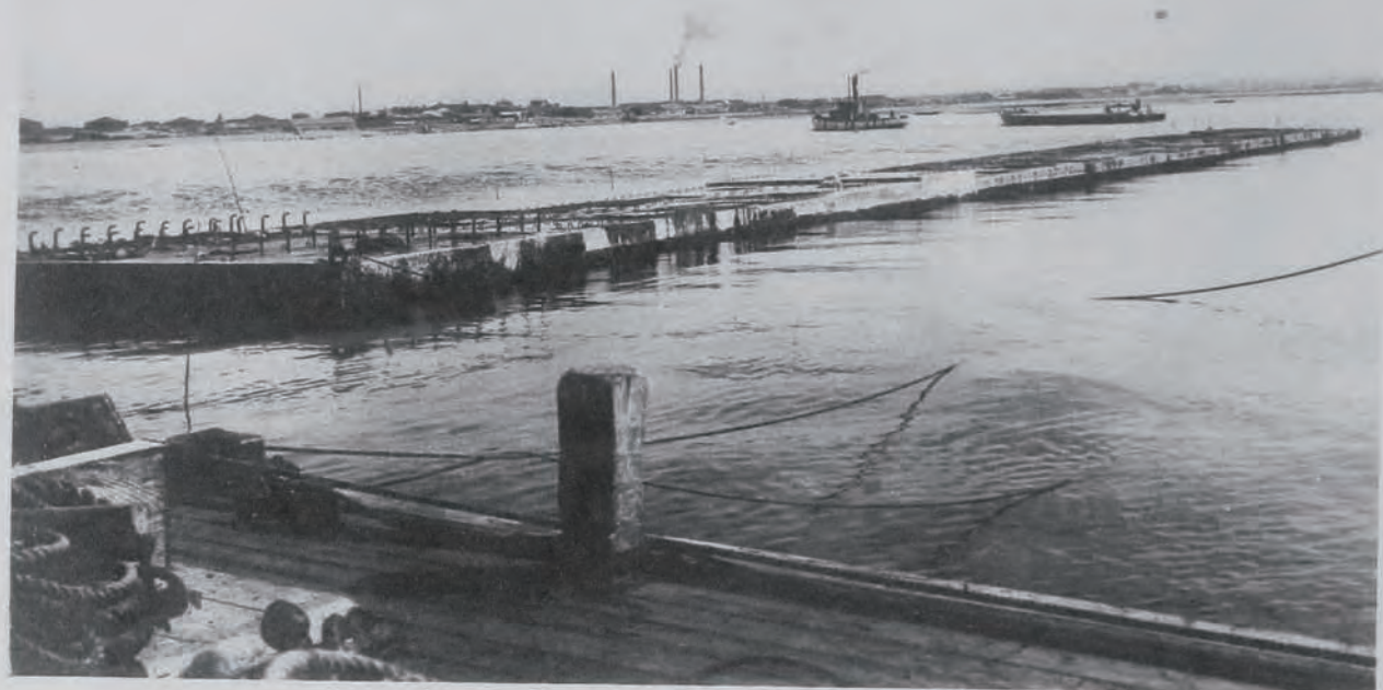
(26) 土崎港修築工事突堤 突堤函塊据付中詰後港外ヨリ望ム、遙ニ見ユルハ土崎港町
