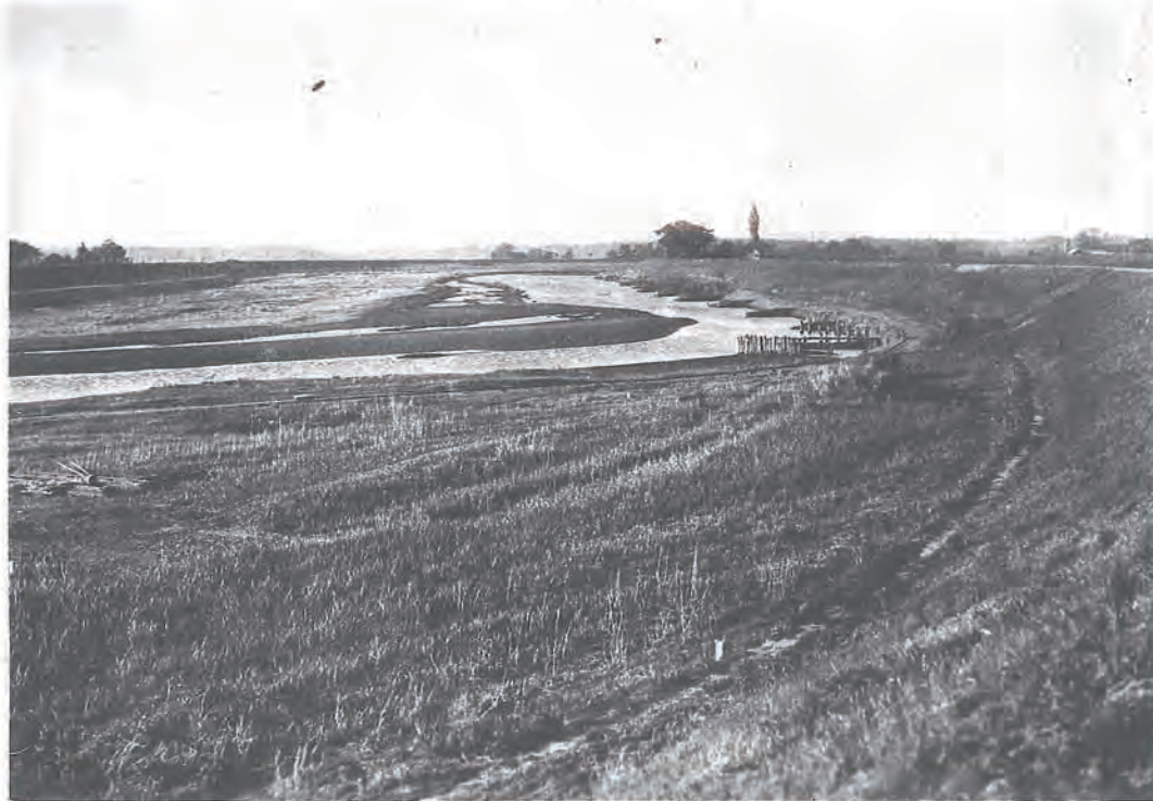
(11) 小貝川改修工事相馬水制 (茨城縣北相馬郡相馬町地先) 右岸ヨリ下流ヲ望ム、合掌杵五箇所五十四米、杭打上置五箇所七十米
