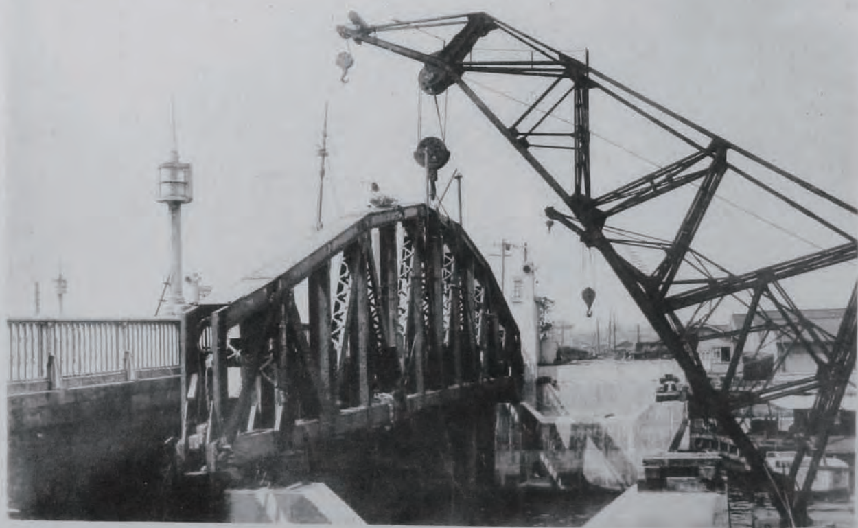
(25) 橫濱港修築工事橋梁架設作業 瑞穂橋、鐵道橋架設
