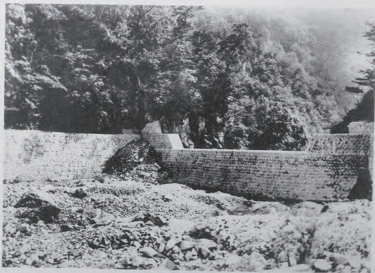
( 17 ) 相模川外四箇川流域震災復舊砂防工事東澤堰堤
