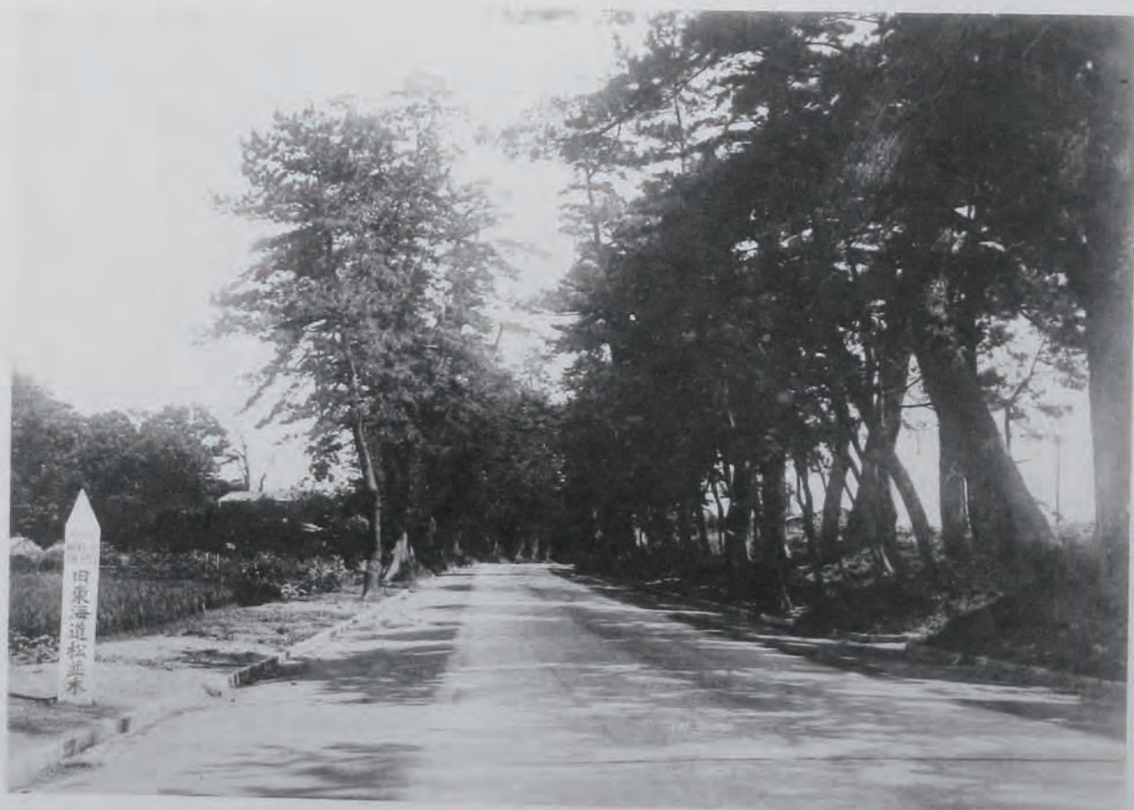
( 37 ) 国道一號線(藤澤)改良工事竣成道路 神奈川県高座郡藤澤町大字大鋸遊行寺坂 上ヨリ大正村方面ニ向フ山谷、藤澤間
