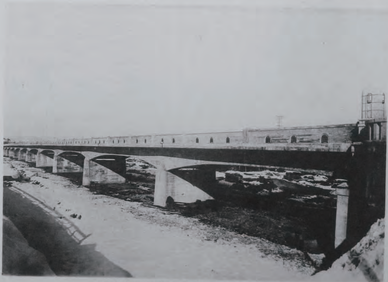
( 45 ) 國道四號線(岩手)改良工事竣成セル再巡橋
