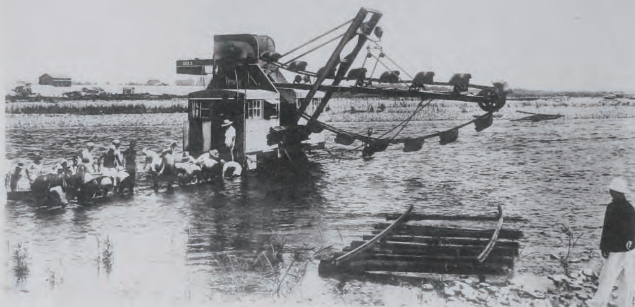
(9) 鬼怒川改修工事柳田築堤 (栃木縣河内郡平石村大字柳田地先) 掘鑿機河中運搬作業
