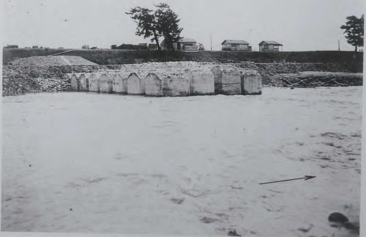
( 8 ) 富士川改修工事宮下水制増補 ( 静岡縣富士郡富士町大字宮下地先 ) 延長二十四米五、昭和十年三月末日竣功
