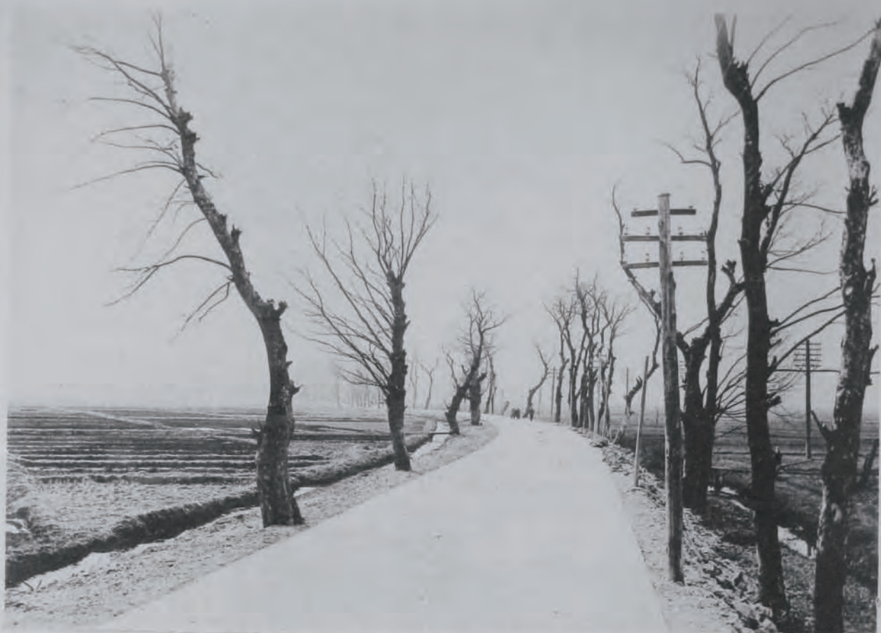
( 44 ) 國道四號線(宮城)改良工事混凝土鋪裝
