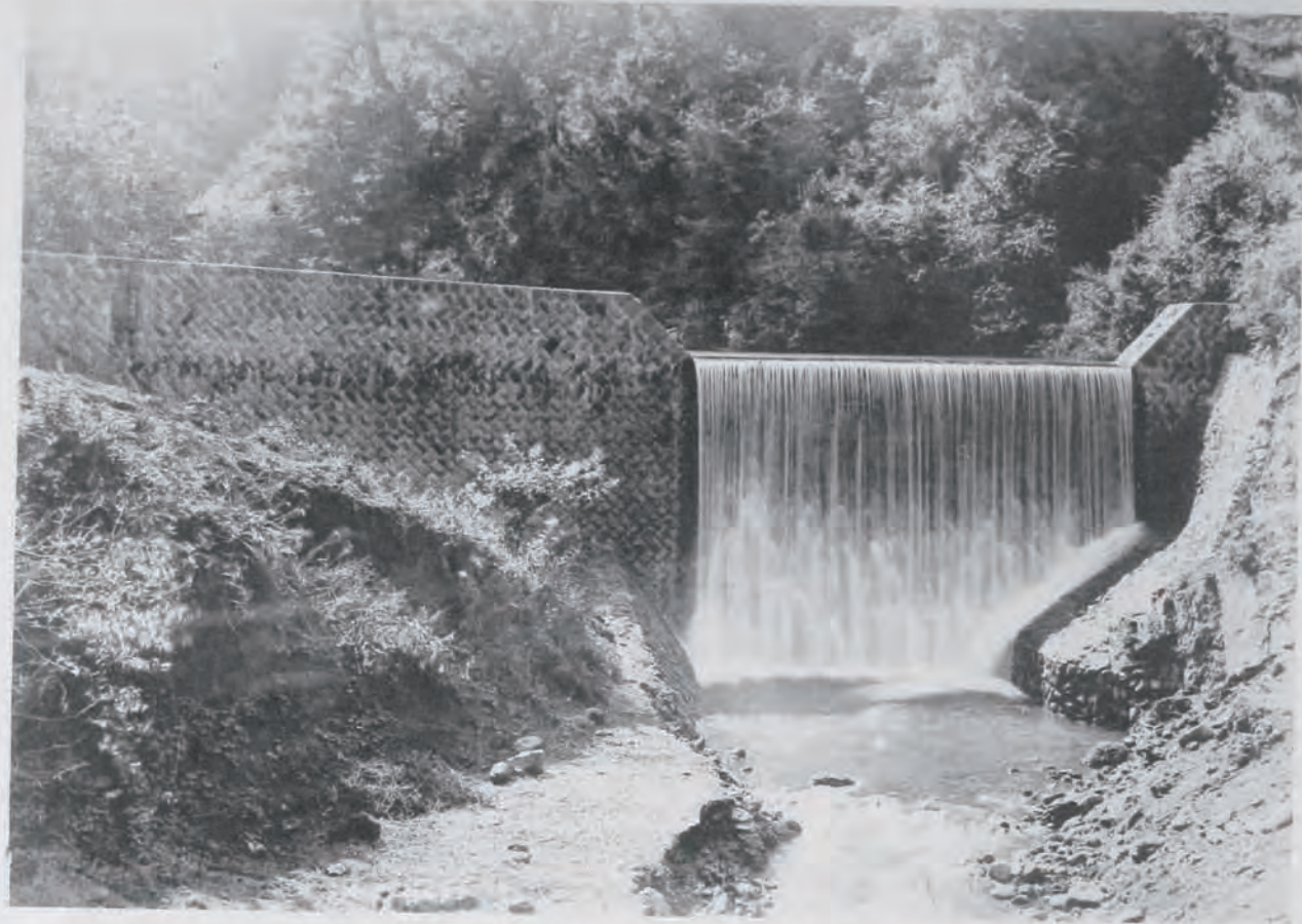
( 16 ) 相模川外四箇川流域震災復舊砂防工事唐澤堰堤
