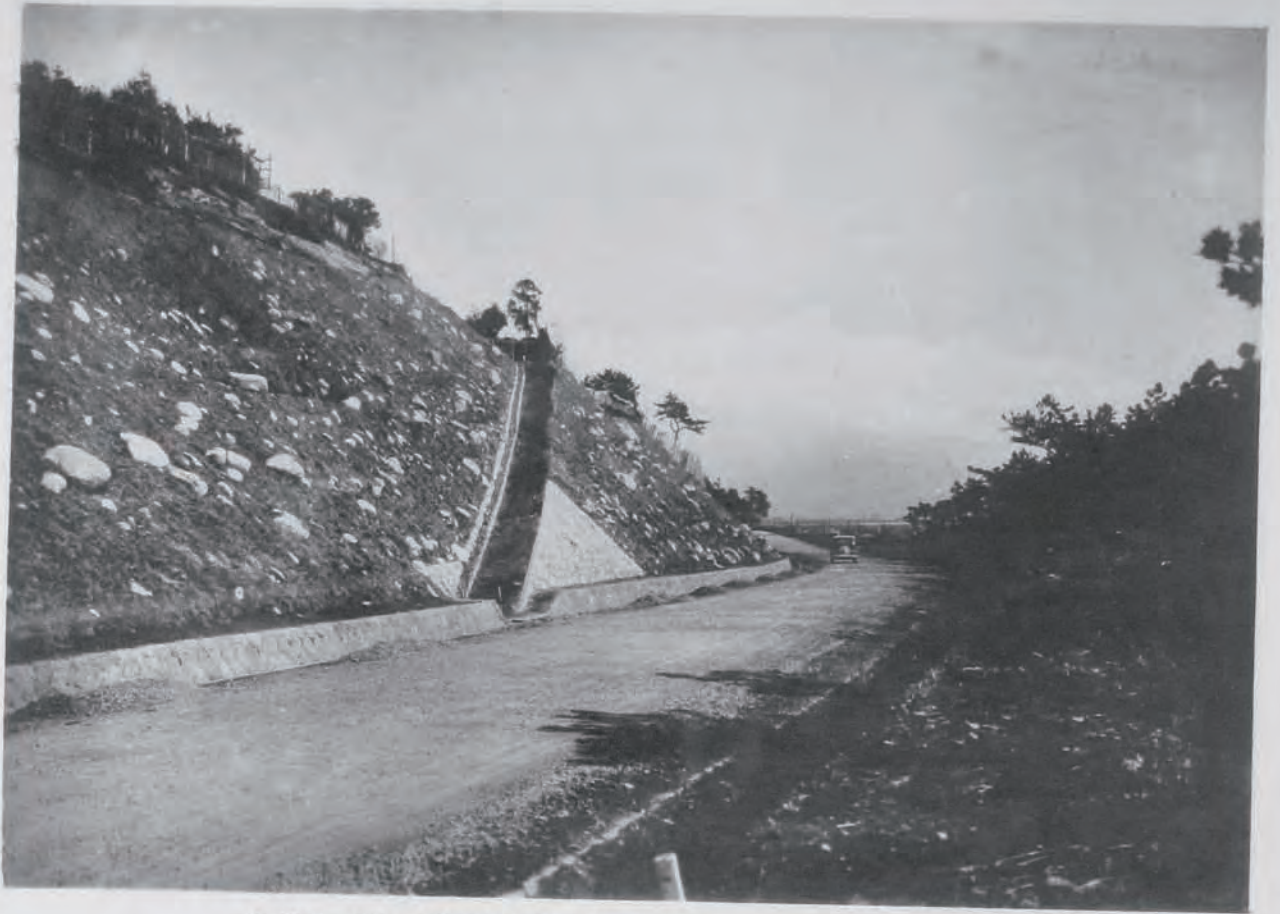
( 40 ) 國道一號線(蒲原)改良工事竣功セル山間部法面保護工 (静岡縣庵原郡蒲原町大字蒲原地内)
