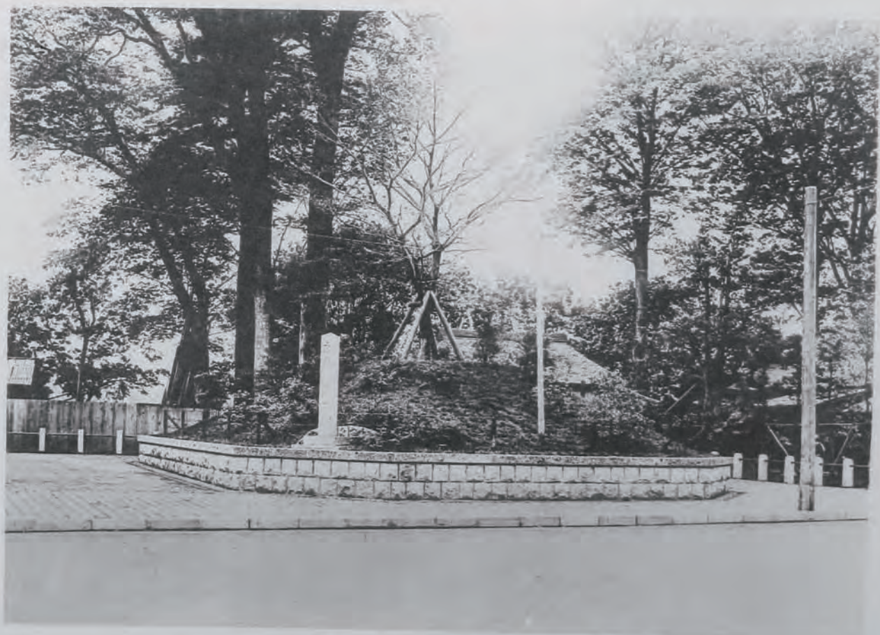
(51) 國道九號線(志村)改良工事一里塚 (東京市板橋區志村町地内) 道路兩側ニ一里塚跡ヲ存置セリ
