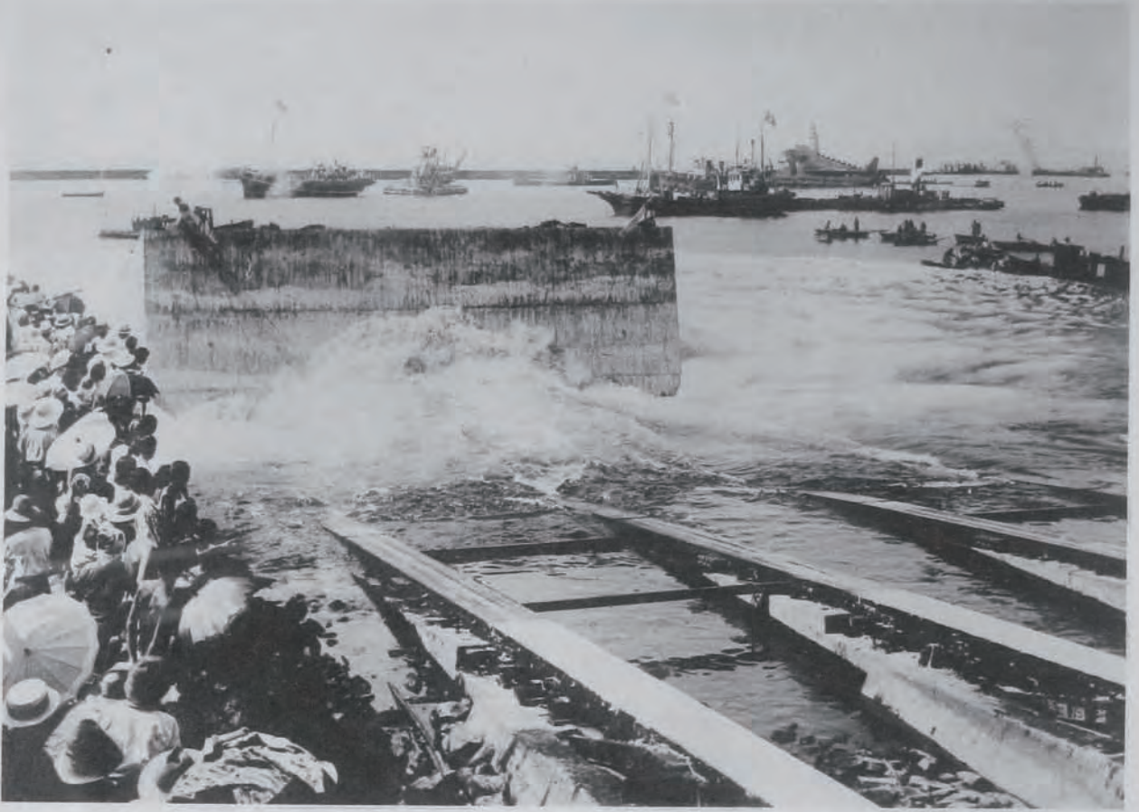
( 30 ) 小名濱港修築工事防波堤用函塊進水 陸上ヨリ望メル進水状況、函塊長十八米七五、 幅十一米一、高七米七
