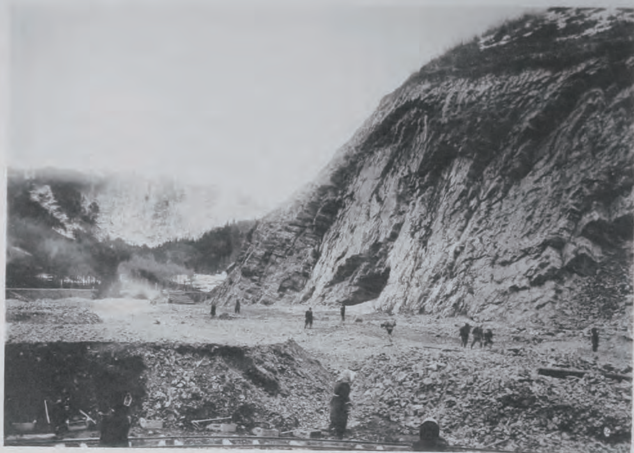
( 32 ) 青森港修築工事用割石採取場爆破前ノ狀況 ( 青森縣東津輕郡野内村地内 )
