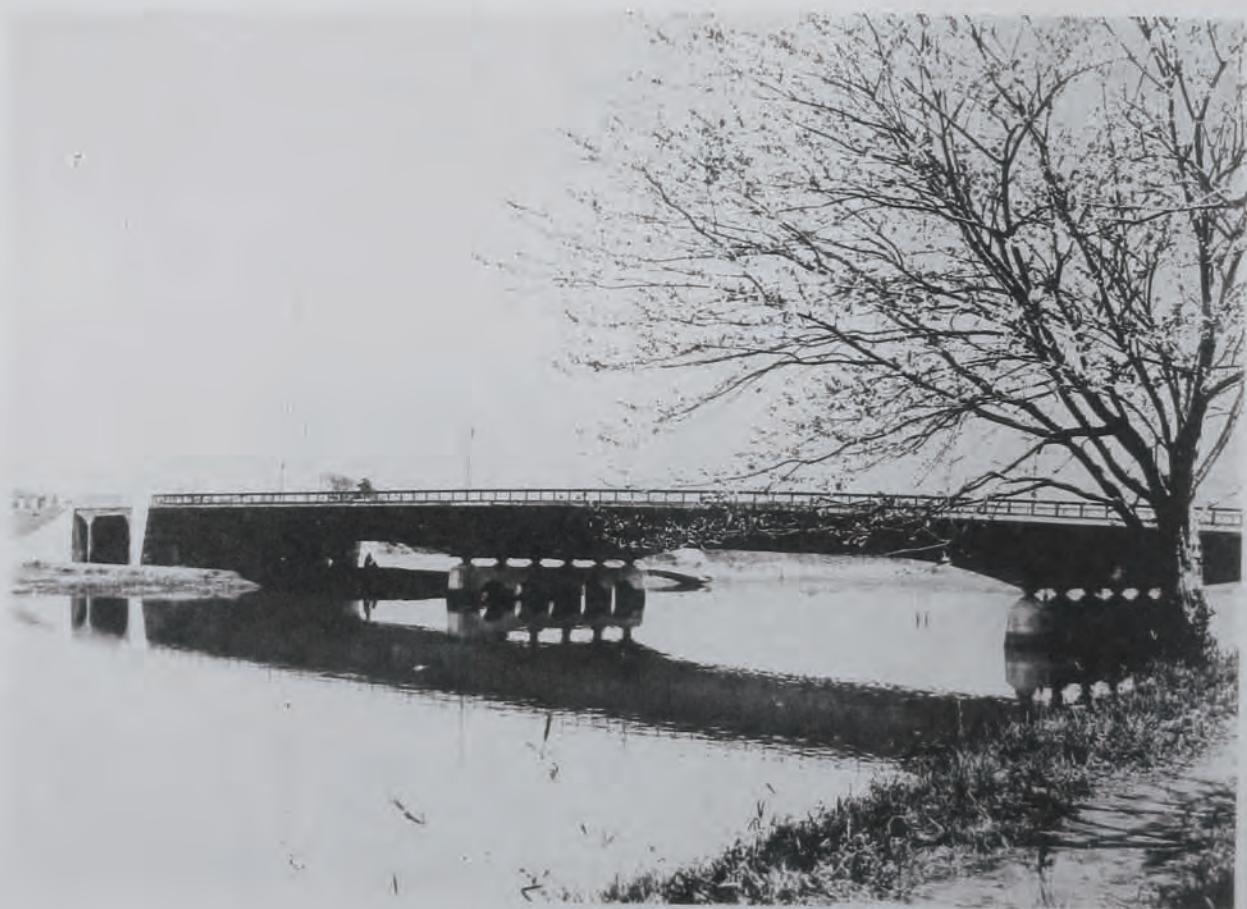
( 49 ) 國道六號線(金町)改良工事竣功セル中川大橋 (東京市葛飾區右岸青戸町、左岸新宿町地先) ゲルバー式鋼鈑桁橋、全長百十六米七、有効 幅員車道十六米、左右歩道二米七
