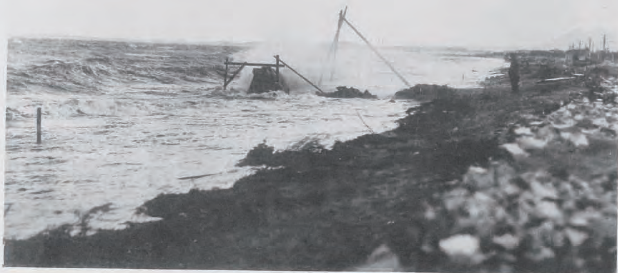
( 42 ) 國道二號線(博多)改良工事海岸岸壁工事 (福岡市大字金平測點四十七號附近)
