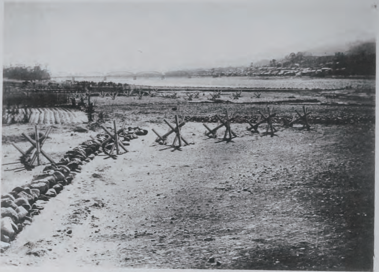
( 7 ) 富士川改修工事下河原水制 ( 静岡縣富士郡岩松村大字岩本地先 ) 延長九十九米、昭和九年一月末日竣功
