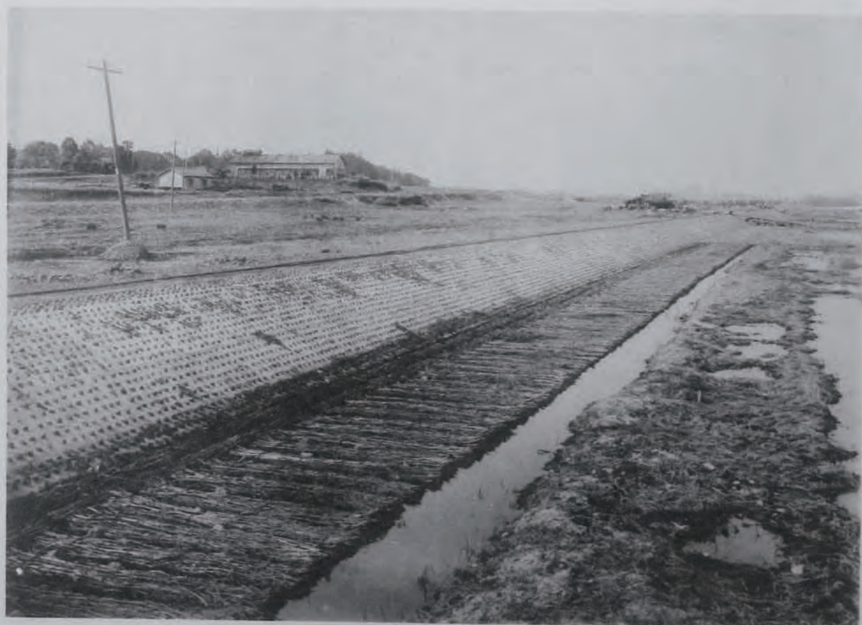
(10) 鬼怒川改修工事低水路護岸 (茨城縣結城郡大形村大字鎌庭地先) 右岸施工延長一千七百七十五米
