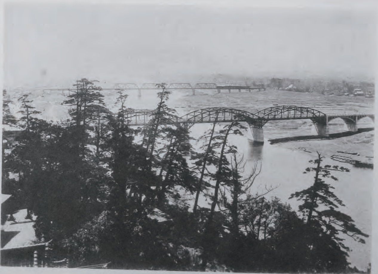
( 2 ) 多摩川改修工事下流展望 總甲山ヨリ望ム
