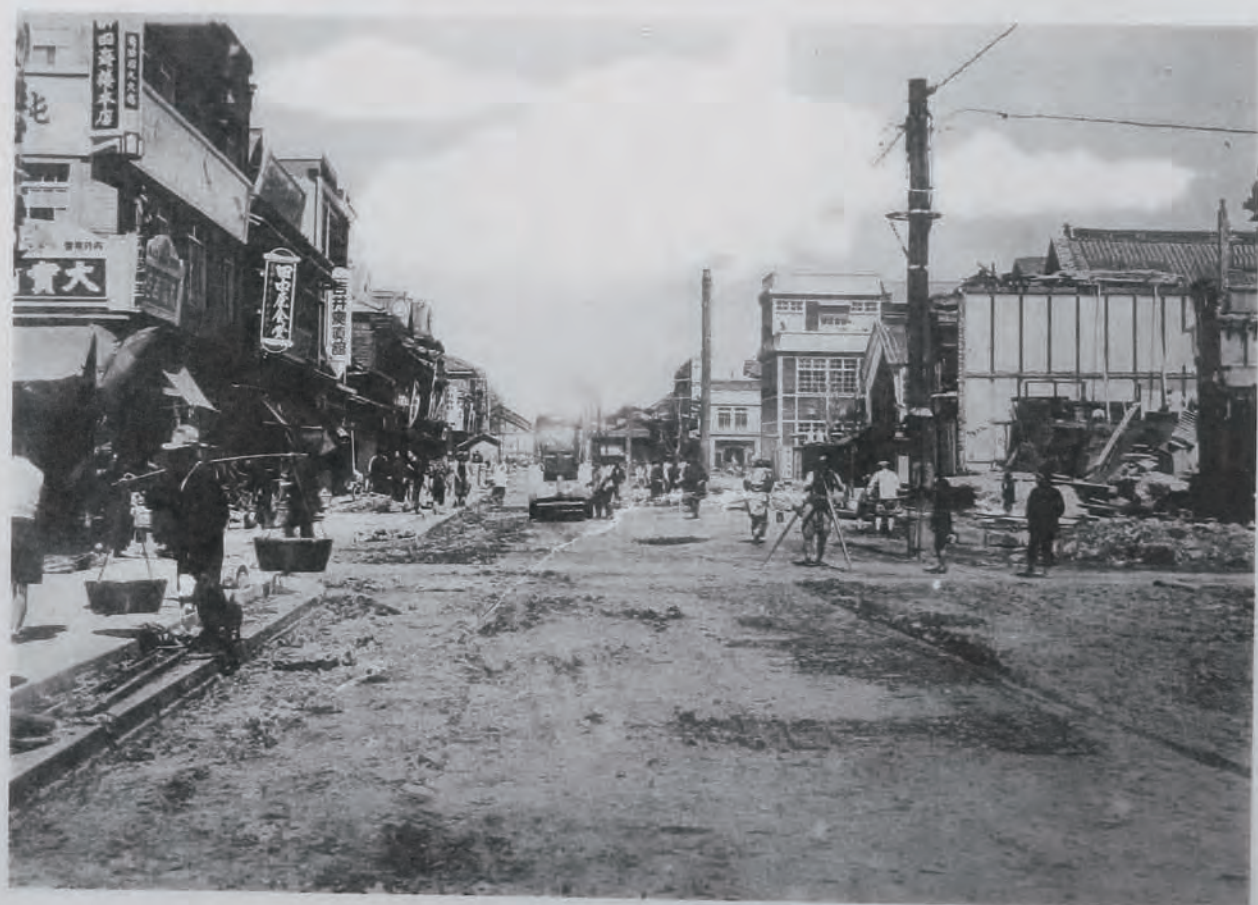
( 55 ) 國道三十三號線(長崎)改良工事車道路盤敷壓 (佐世保市上京町測點百三十五號附近)
