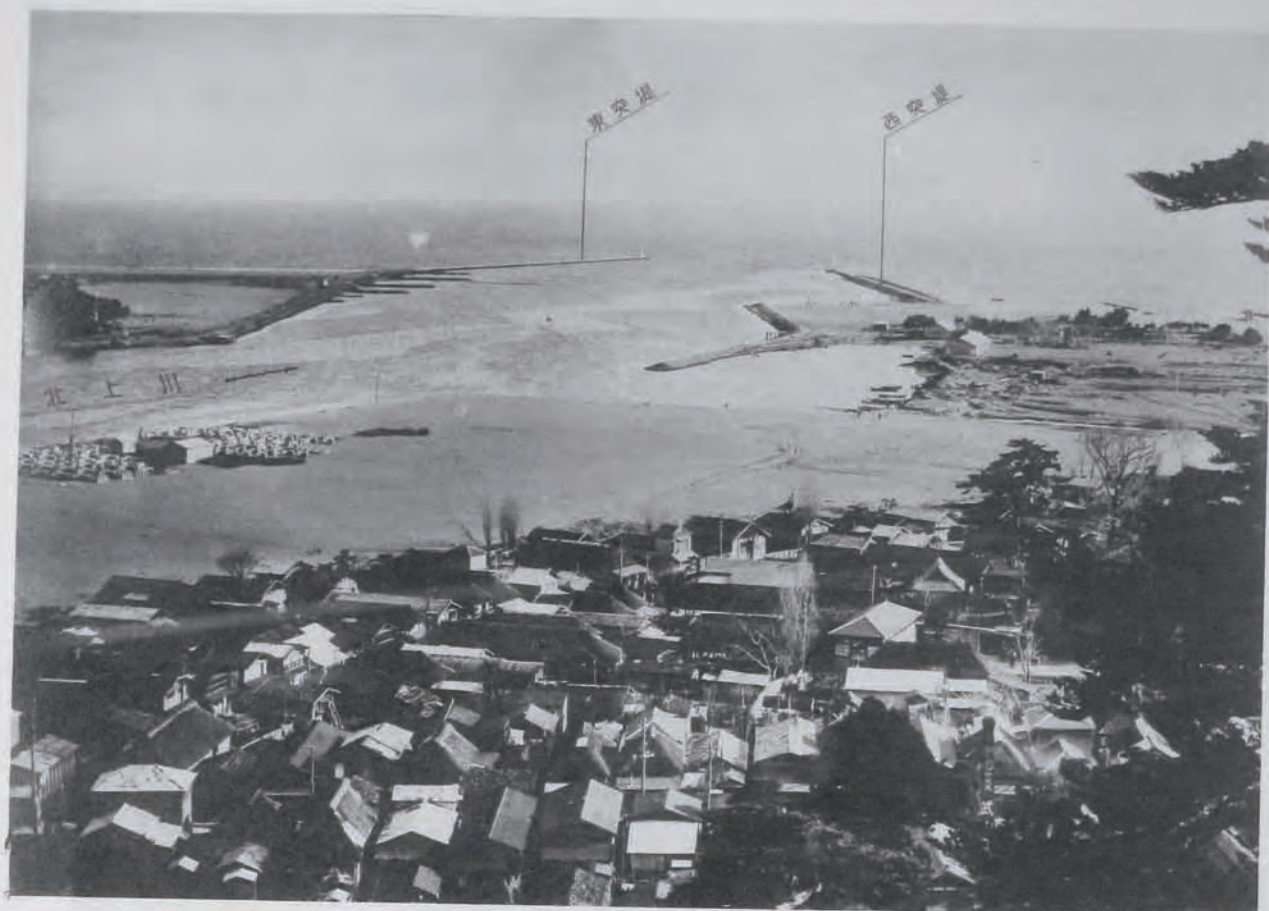
(5) 北上川改修工事北上川河口突堤 (石巻市地先) 東突堤延長一千四十七米、西突堤延長九百 米、水深維持ノ爲メ東突堤ニ直角ニ數箇所ノ水制ヲ設ク
