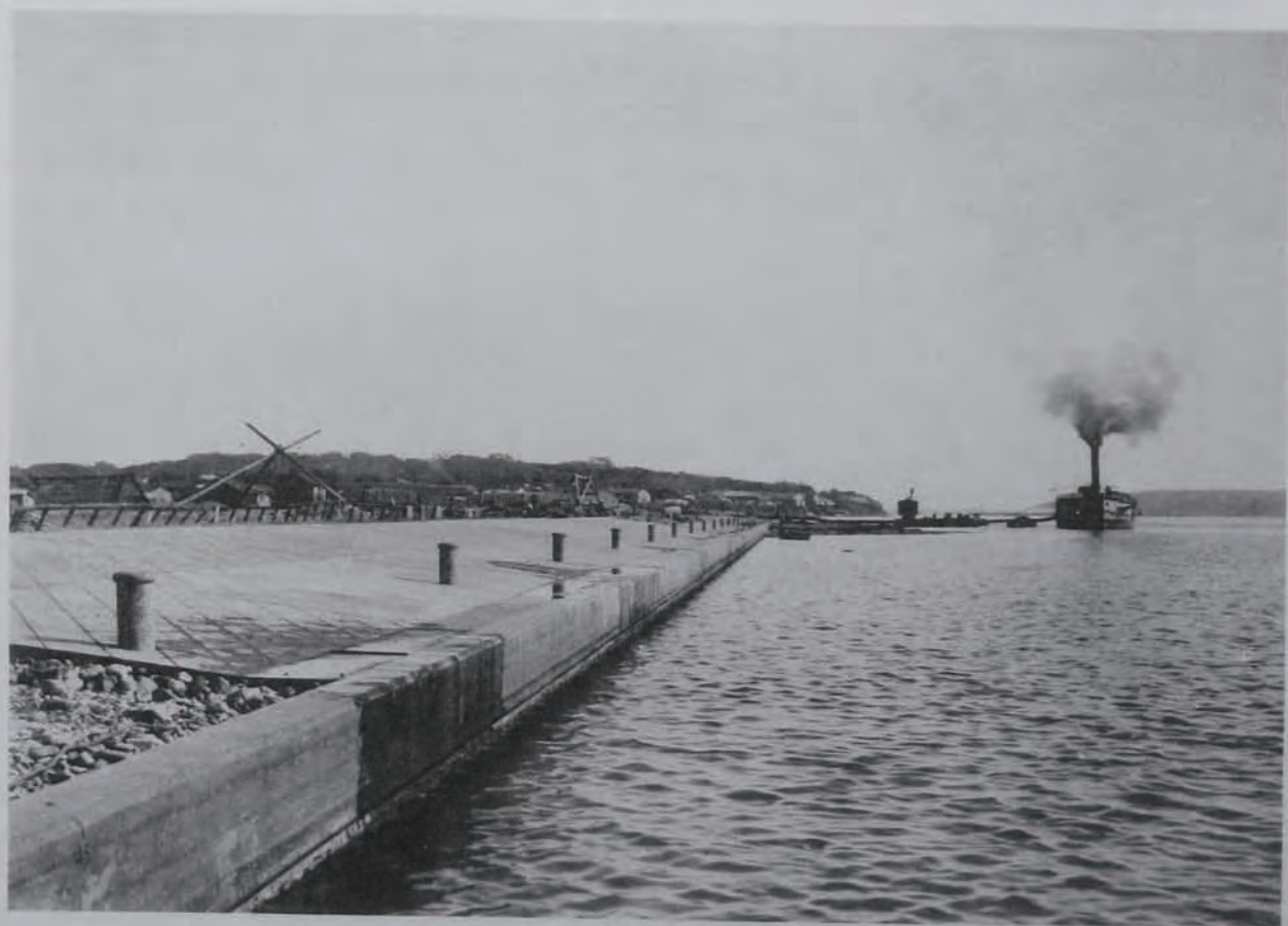
(23) 土崎港修築工事物揚場 南埠頭附近ヨリ上流ヲ望ム、二米物揚場ニシテ前 方ノ船ハ埋立工事中ノ唧筒式浚渫船第一開北丸
