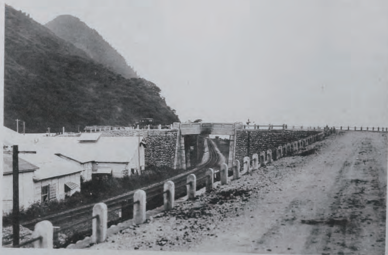
( 53 ) 國道十一號線(親不知)改良工事竣功シタル跨線橋 (新潟縣西頸城郡青海町地内)
