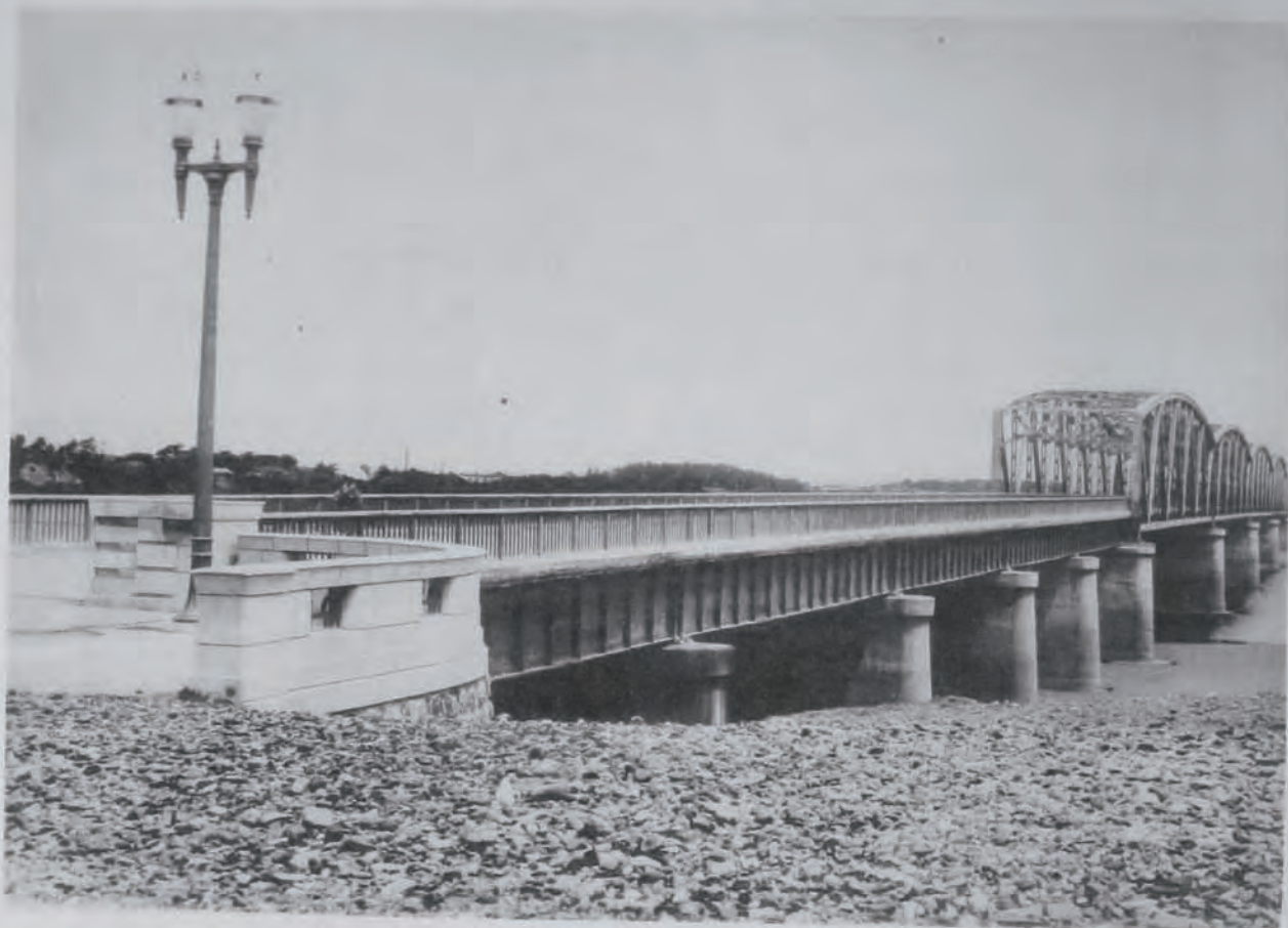
( 52 ) 國道十號線(秋田)改良工事竣成セル雄物川橋 (秋田市牛島町ヨリ河邊郡新屋町大字百三段新屋ニ至ル地内) ワーレン鋼構及鋼板桁、全長五百七十八米、徑間中央六十三米 六連、兩側二十米十連、有効幅員七米五、路面混凝土鋪裝
