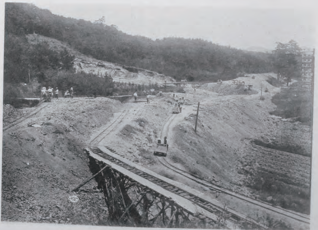
( 41 ) 國道二號線(山口)改良工事盛土狀況 (山口市船木町一丁目附近)
