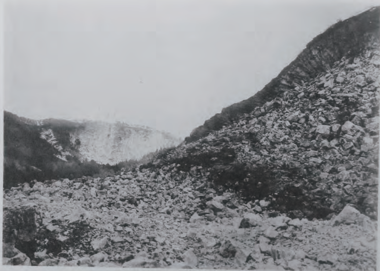
( 33 ) 青森港修築工事用割石採取場爆破後ノ狀況 ( 青森縣東津輕郡野内村地内 )
