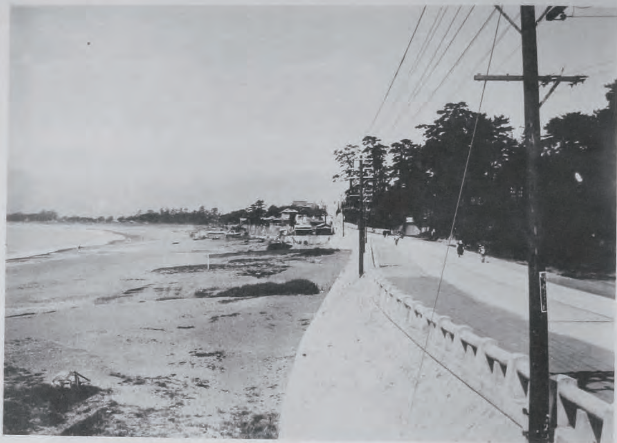
( 38 ) 國道一號線(國府津)改良工事竣功セル護岸擁壁及駒止工 (神奈川縣足柄下郡國府津町字唐澤海岸)
