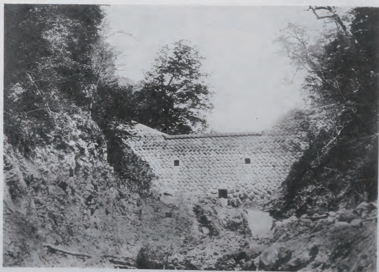
(19) 揖斐川砂防工事岩坪谷第一號堰堤 (岐阜縣古城郡上寶村大字一重ヶ根地内)
