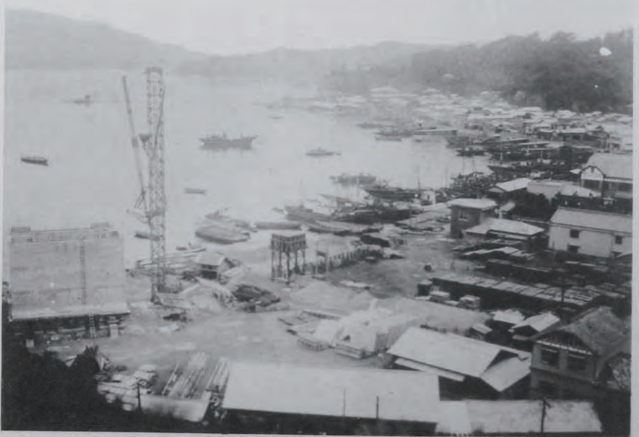
( 31 ) 宮古港修築工事ケーソン製作場附近 ( 鍛ヶ崎ケーソン製作場附近 ) 右方ハ宮古町鍛ヶ崎、前方水平線ハ岸壁ケーソンヲ据付タル景
