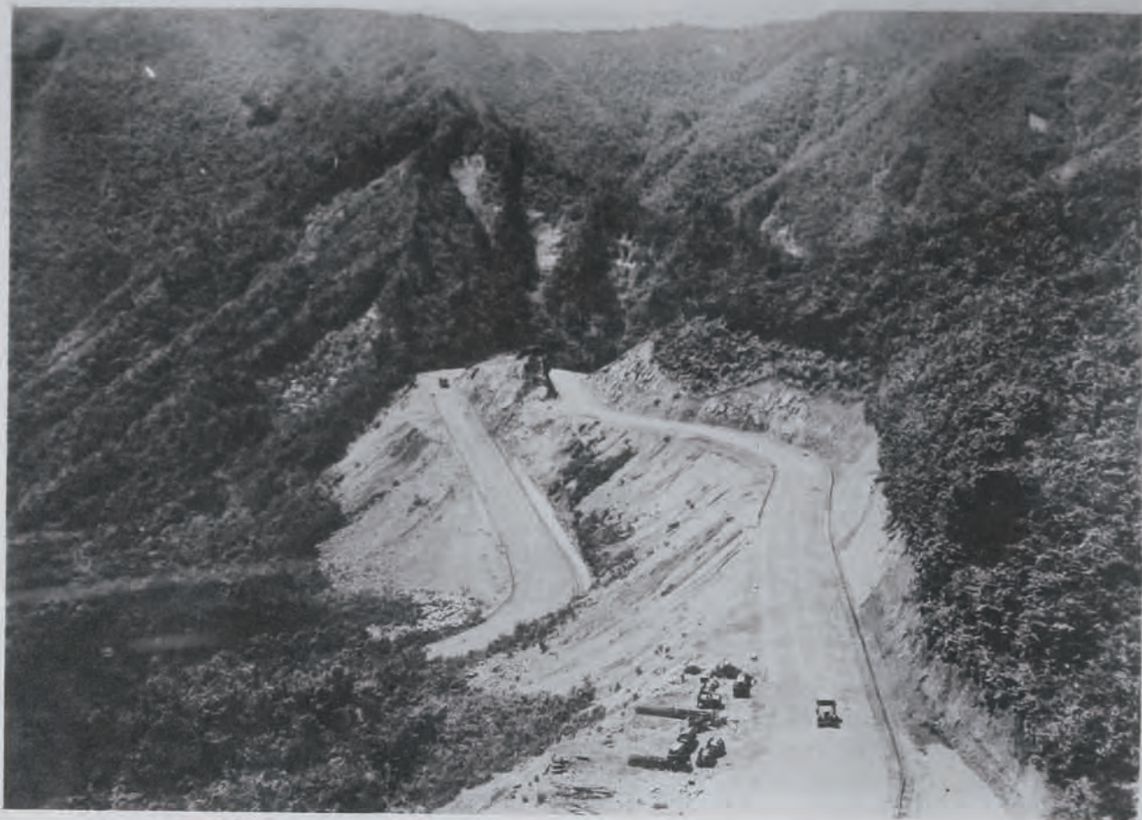
( 48 ) 國道五號線(福島)改良工事同南口取付竣功道路 (福島縣信夫郡中野村地内)
