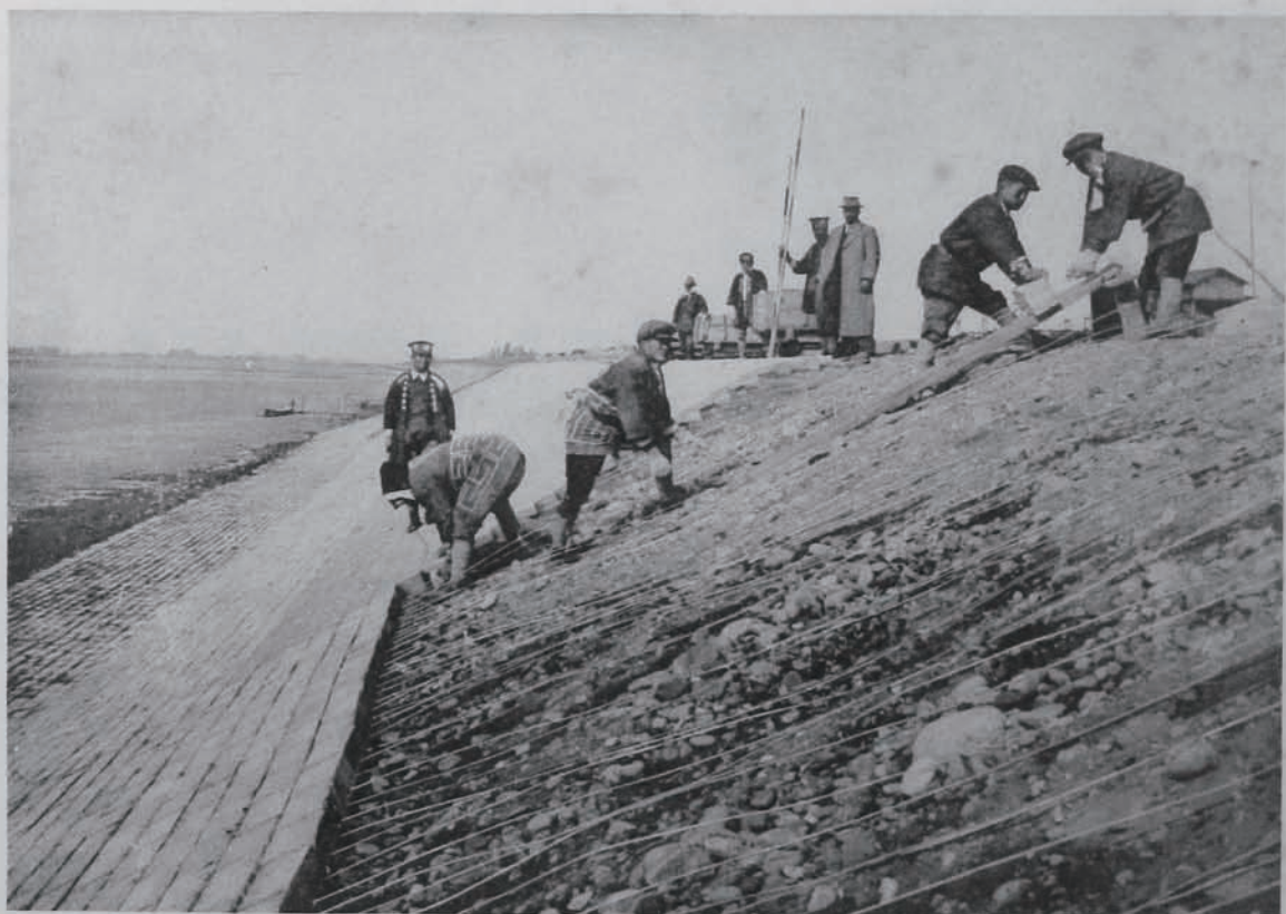
況 狀 ノ 中 業 作 床 單 ク ヲ ロ ブ 土 凝 混 事 工 岸 護
