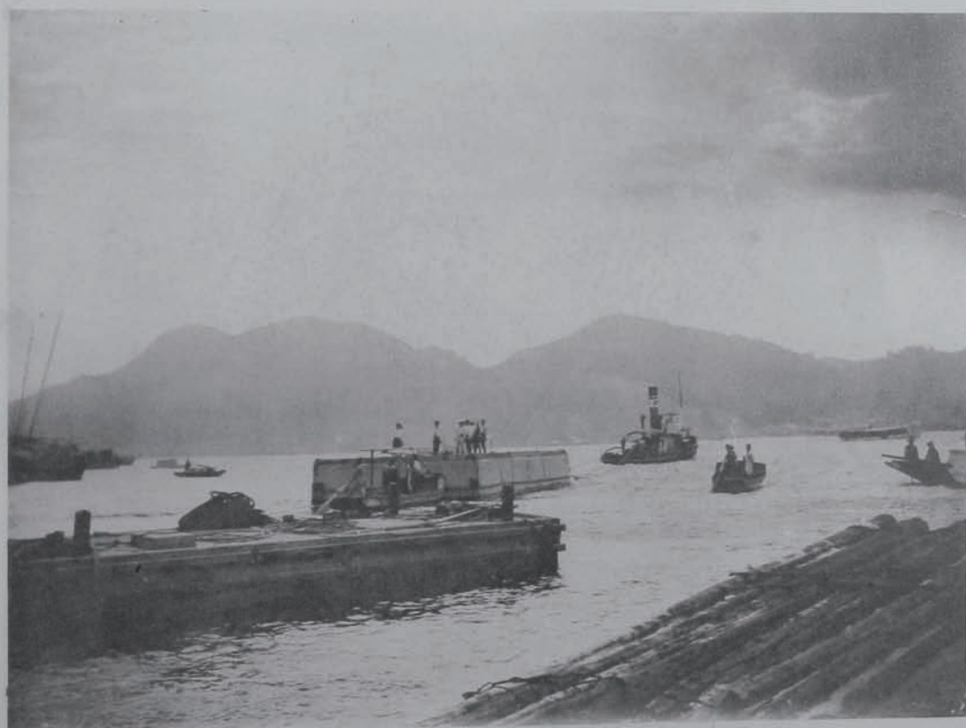
長崎港修築工事曳索中ノケーソ (長崎港)
