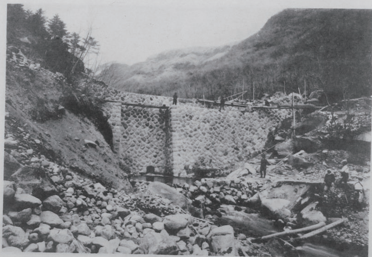
大谷川流域砂防工事堰堤築立作業中ノ状況 (栃木縣上郡日光町地先)
