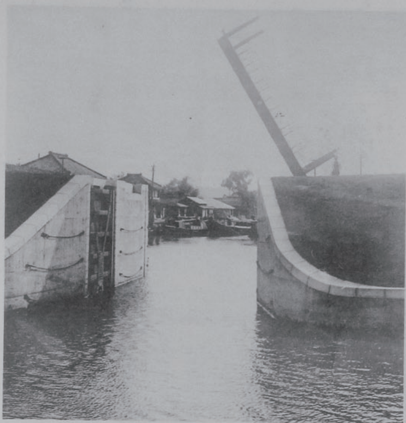
圖功竣門水川野小事工期二第川根利 (先地町原佐郡取香縣葉千)
