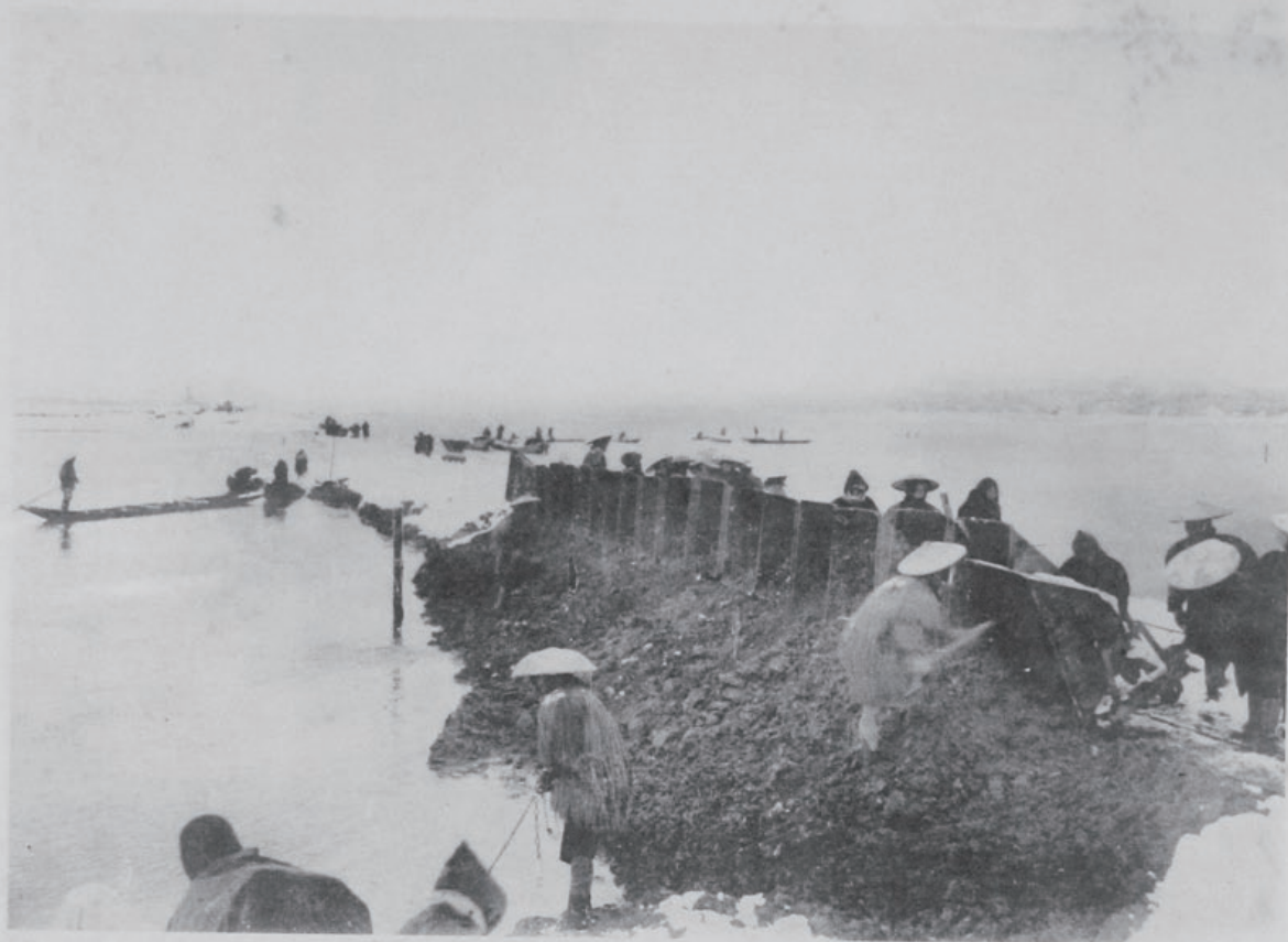
信濃川締切堤防工事雪中作業ノ状況 (新潟縣三島郡大河津村ヨリ對岸ノ島方展望)
