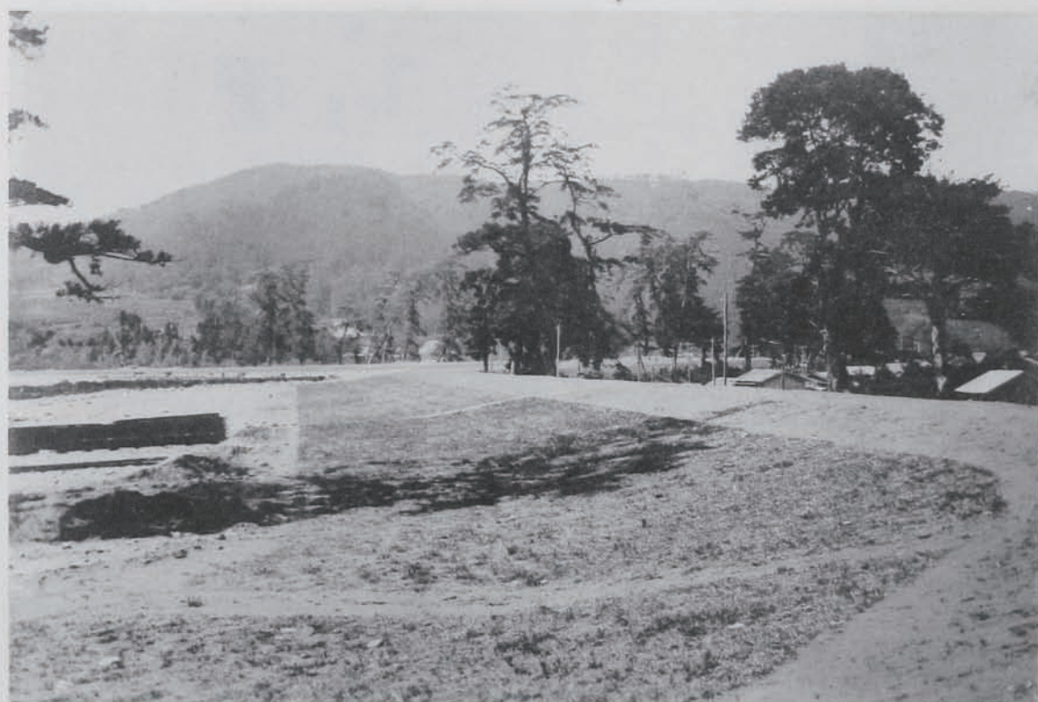
(先地本岩字村松岩郡士富縣岡靜) 堤築本岩事工修改川士富 五米一高直法表・割二法裏・米八踏馬 ク付取=盤地來在テ=割五十二下以リ下テ=割六
