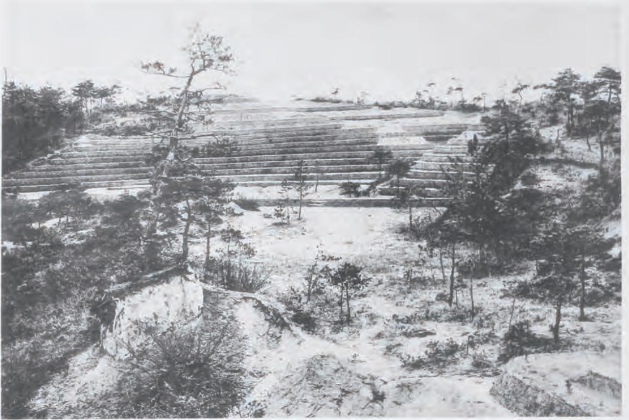
(7) 木津川砂防工事堀抜砂防施工直後
