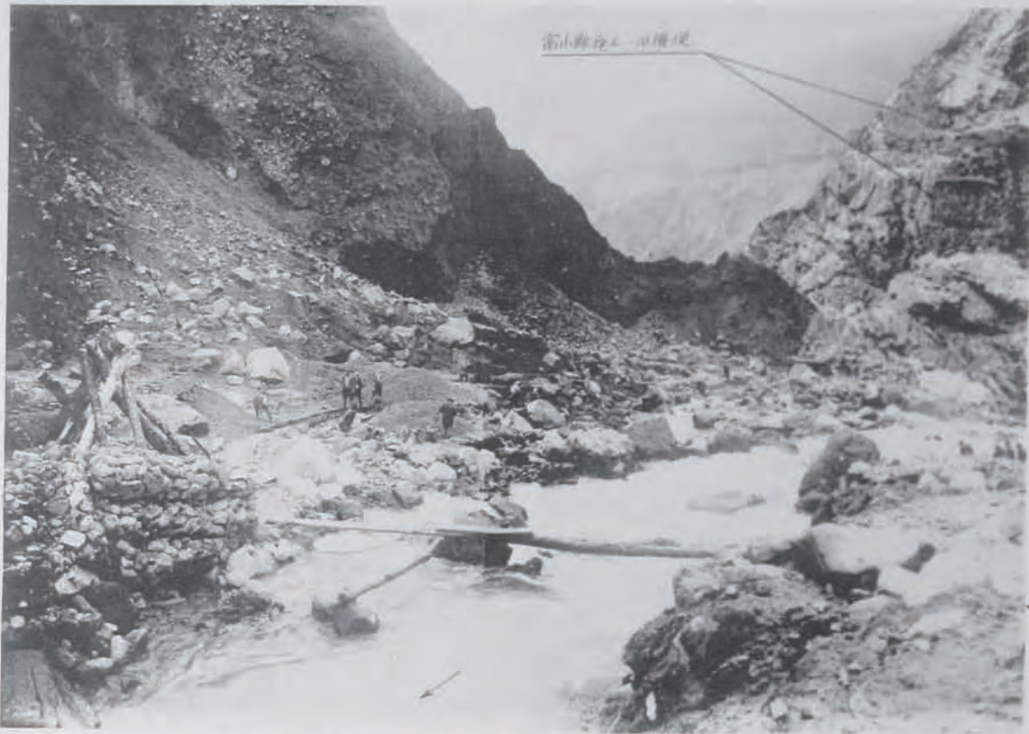
(19) 常願寺川流域砂防工事 白岩堰堤箇所上流左岸崩壊並護岸準備工事 (富山縣上新川郡大山村及中新川郡立山村地先)
