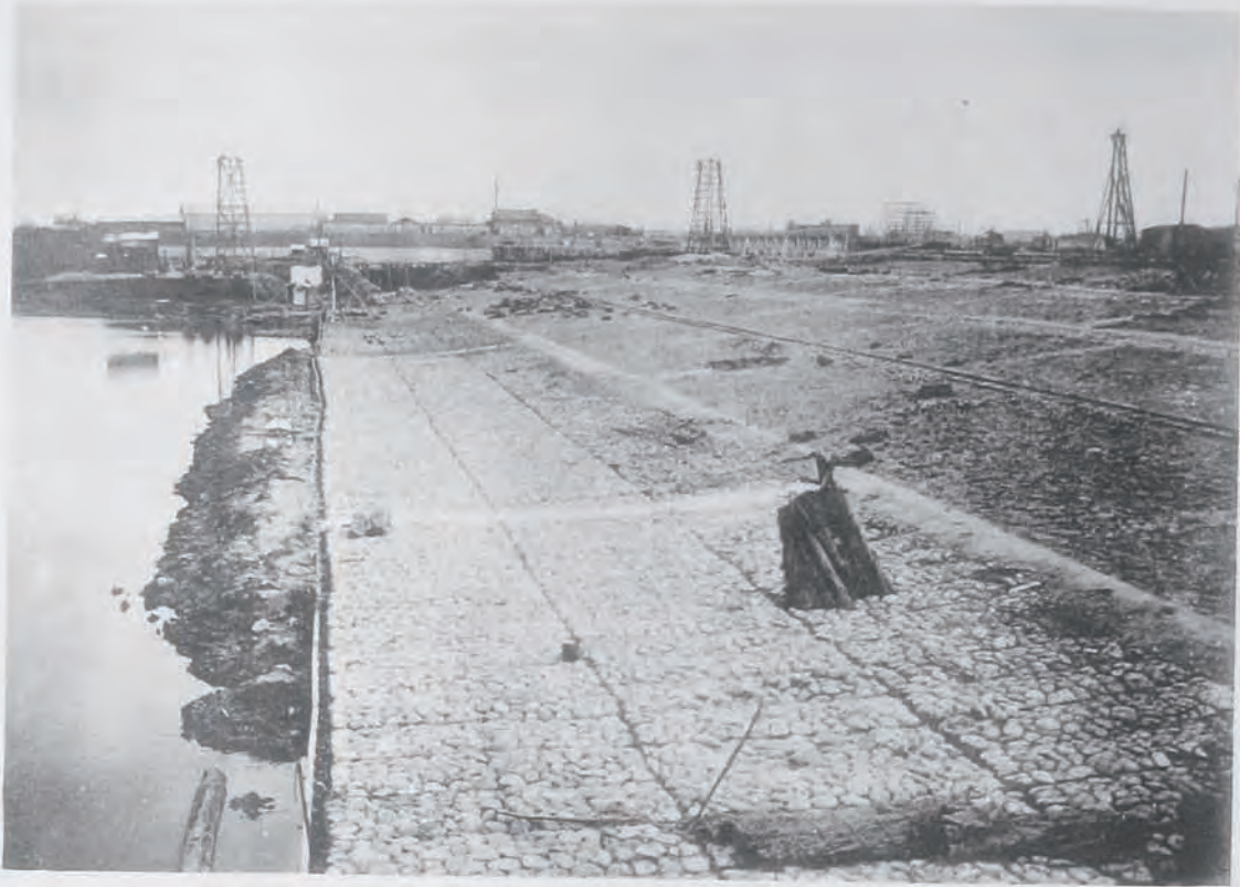
(31) 信濃川補修工事固定堰
