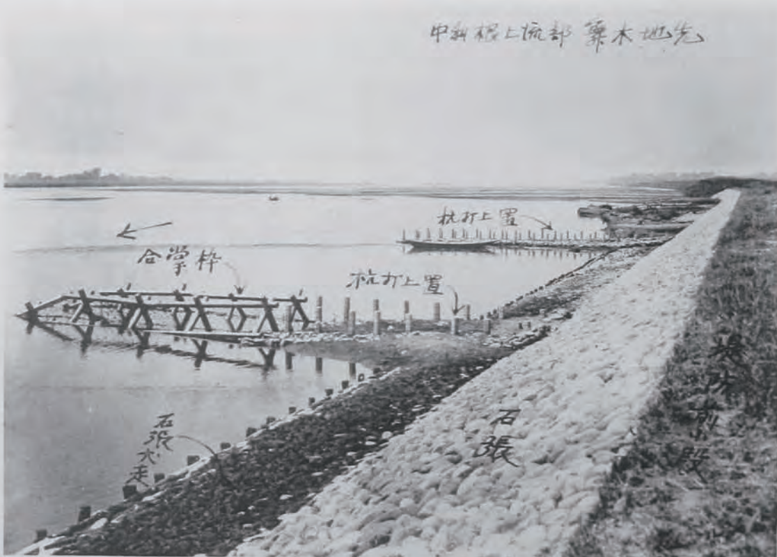
(16) 利根渡良瀨兩川維持工事舞木護岸 (群馬縣邑樂郡永樂村大字舞木地先)
