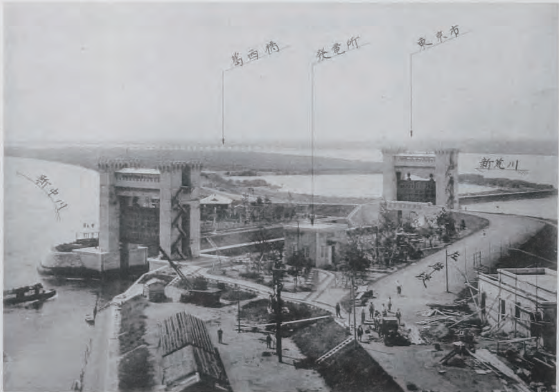
(2) 荒川下流改修工事船堀閘門 (東京府南葛飾郡松江村地先) 扉室幅十一米、閘室幅十四米四、閘室有効長九十一米
