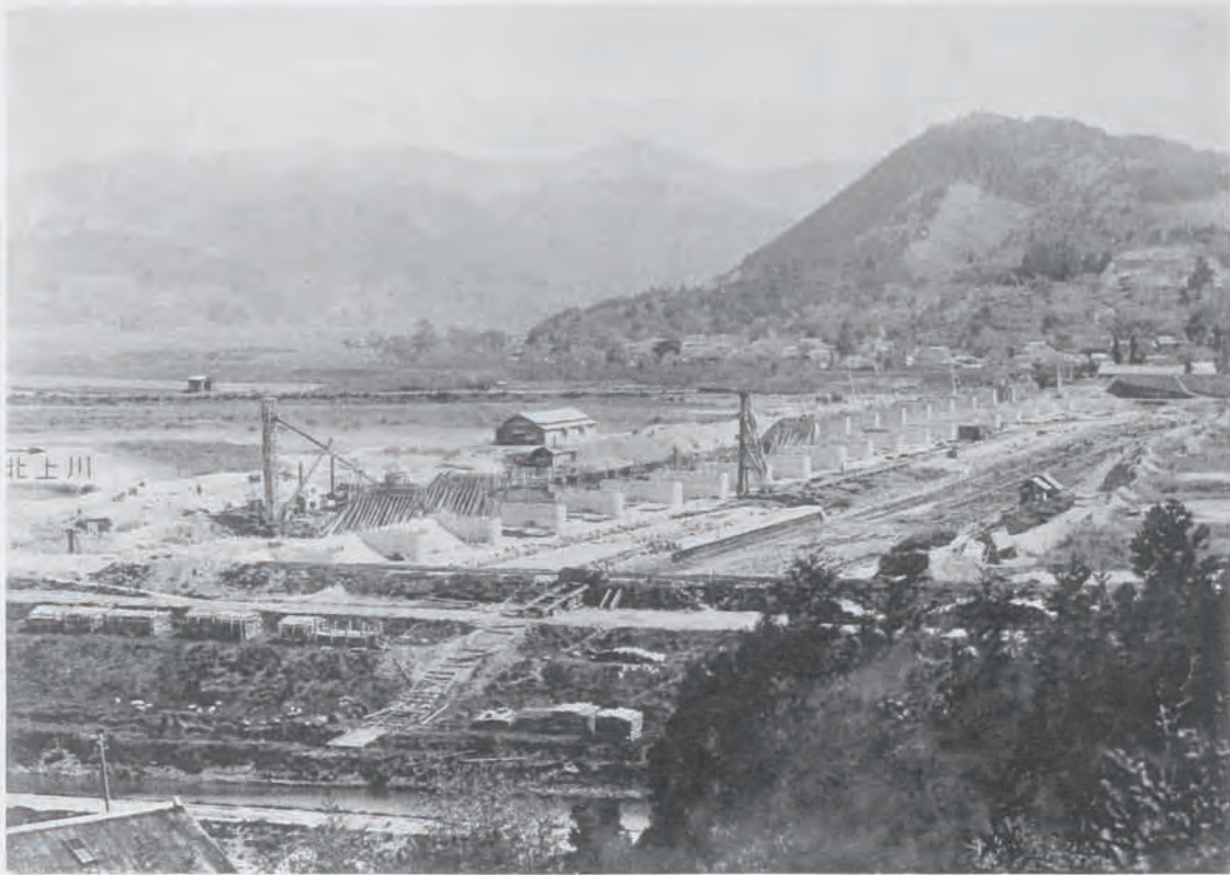
(3) 北上川改修工事 飯野川可動堰
