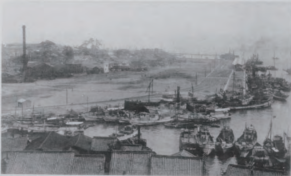
(24) 下關港修築工事西工區埋立地 埋立面積五萬三千八百平方米、五米四岸壁三百四十 四米、二米七岸壁百三十九米、護岸二百一十一米 (昭和五年二月下關要塞司令部承認済)
