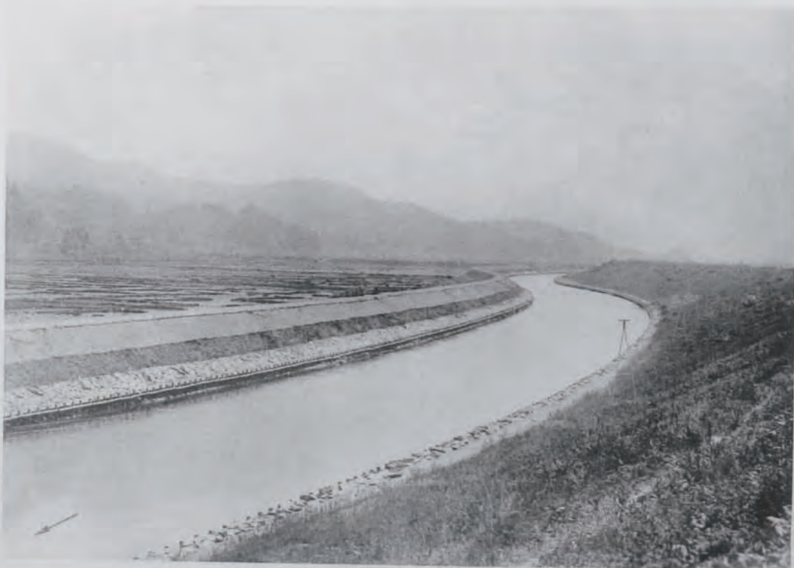
(8) 北上川改修工事二俣水路 (宮城縣牡鹿郡二俣村及大川村地先)
