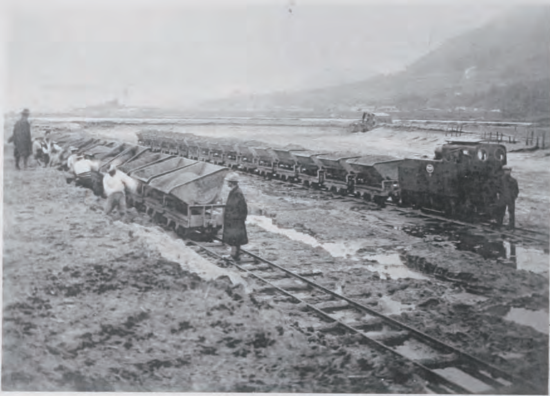
(15) 蘆田川改修工事土取場 (廣島縣沼隈郡草戸村地先) 六噸重油機關車使用
