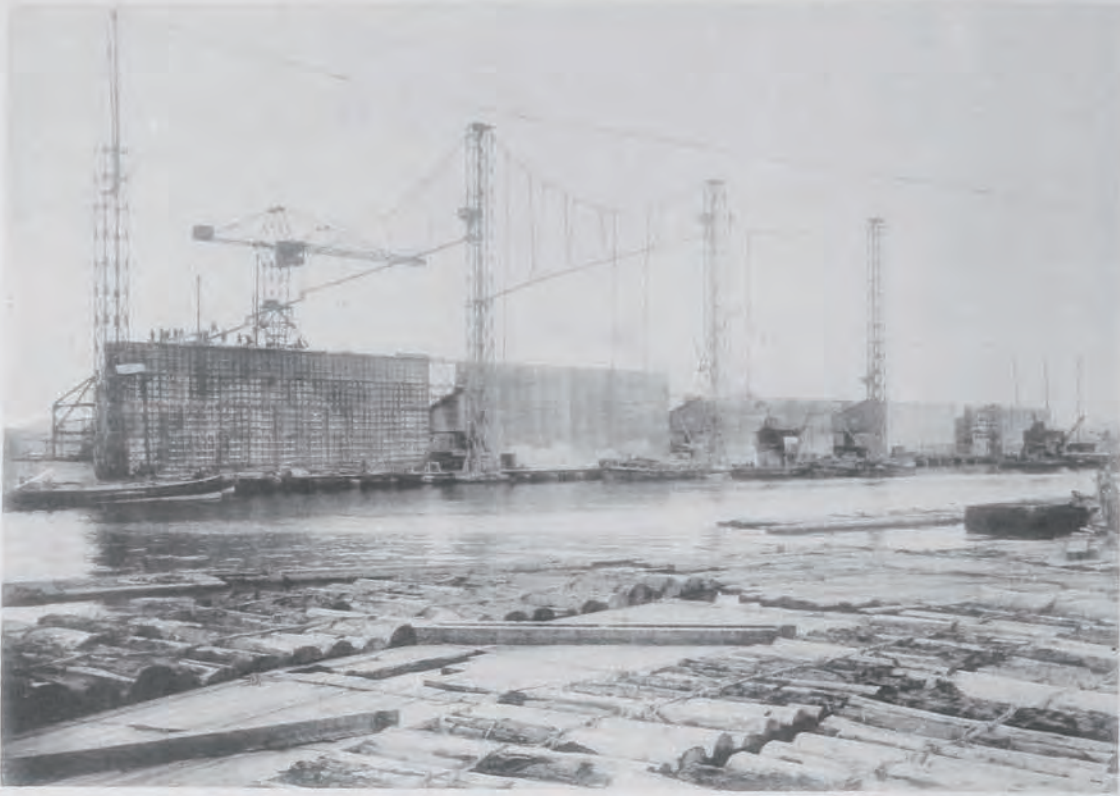
(21) 神戸港修築工事岸壁築造用鉄筋混凝土函製造
