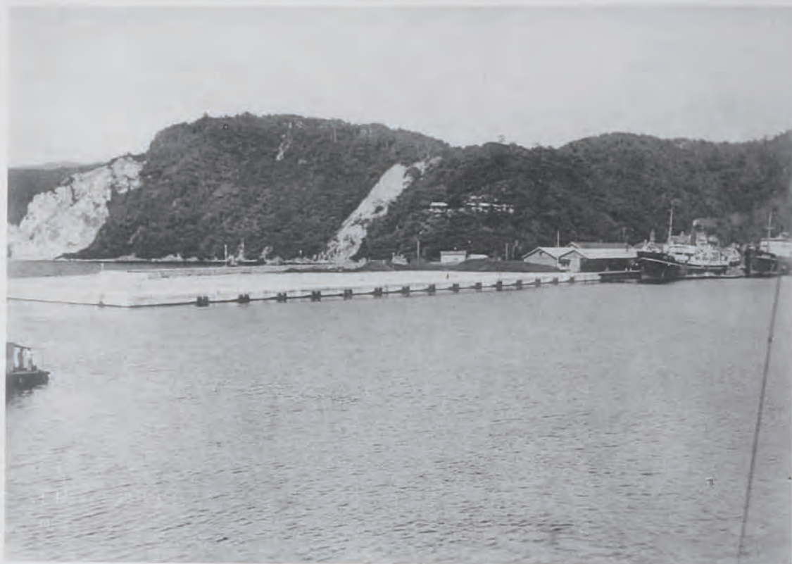
(25) 敦賀港修築工事鐵道省委託八米五岸壁 延長百六十四米
