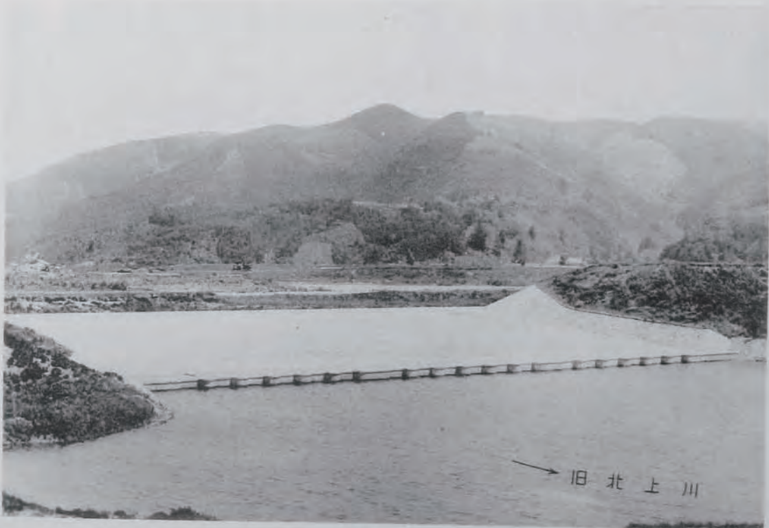
(6) 北上川改修工事挽波洗堰 (宮城縣遠田郡豊里村地先)
