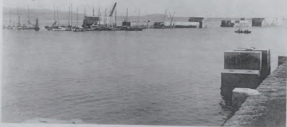
(28) 鹿兒島港修築工事南防波堤築造 基礎捨石沈壓作業並ケーソン及方塊据付
