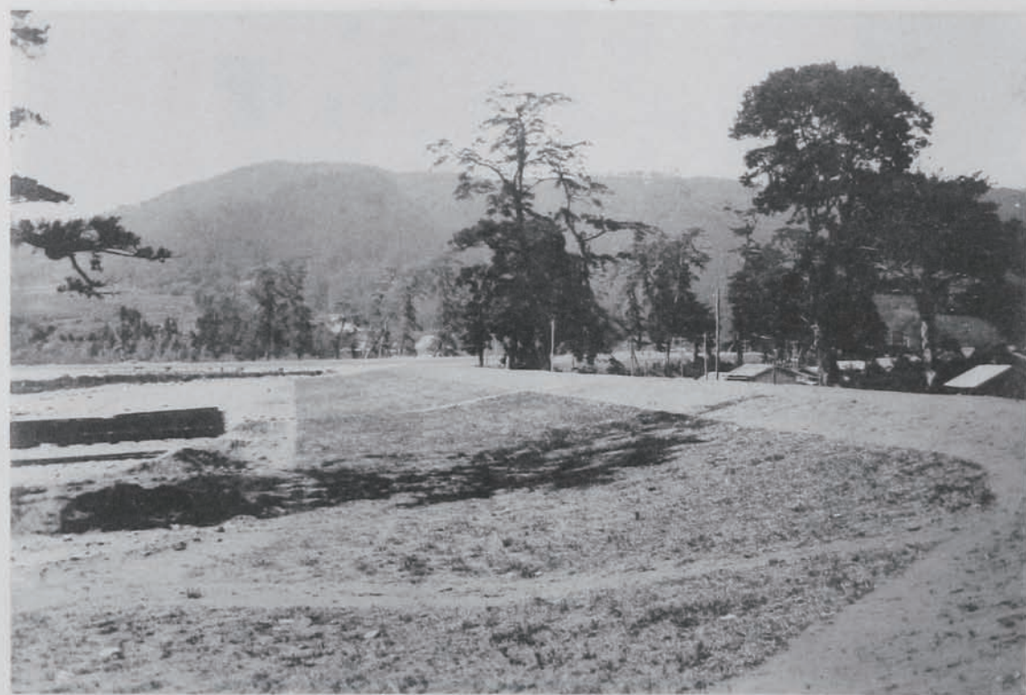
(先地木岩字村松岩郡士富縣岡靜) 堤築本岩事工修改川士富 五米一高直法表・割二法裏・米八踏馬 ク付取=盤地來在テ=割五十二下以リ下テ=割六
