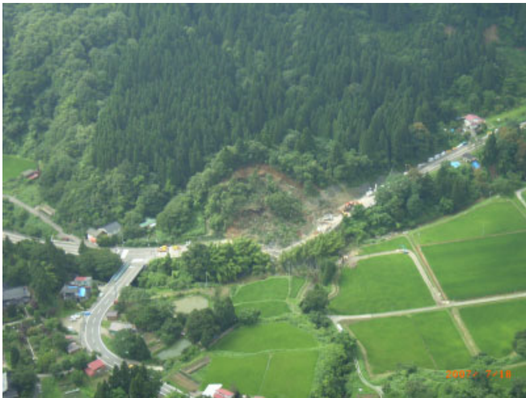
写真 - 国道 8 号線の河道閉塞状況。
