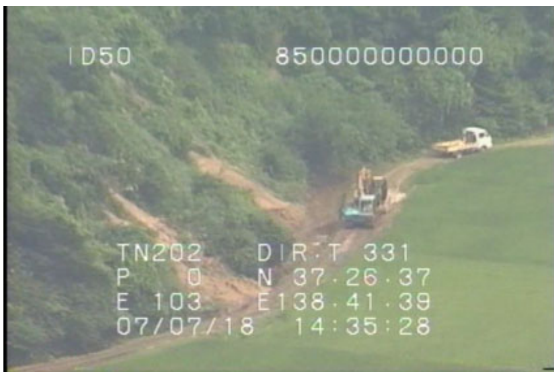
写真 - 物見山周辺の斜面崩壊
