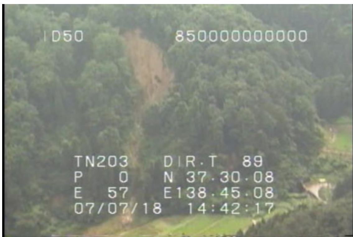
写真 - 中永周辺の斜面崩壊
