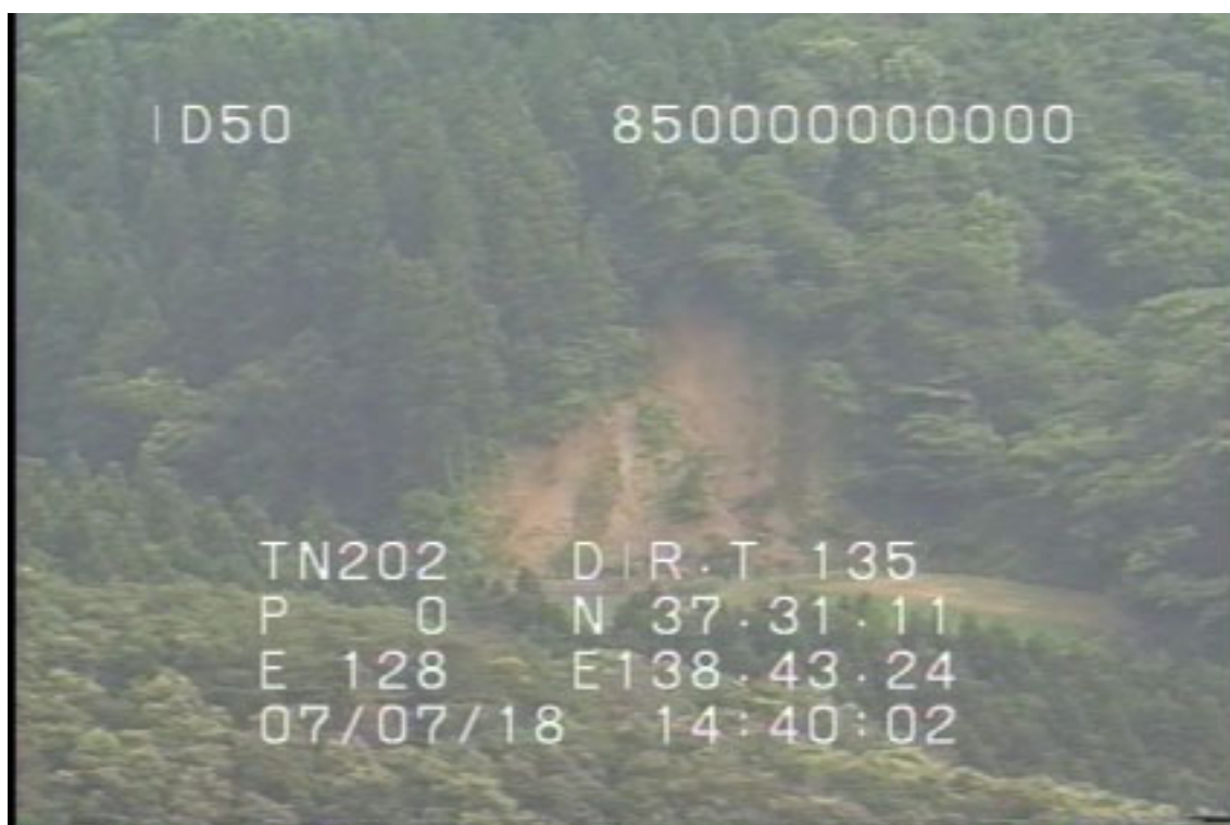
写真 - 西山町石地周辺の斜面崩壊
