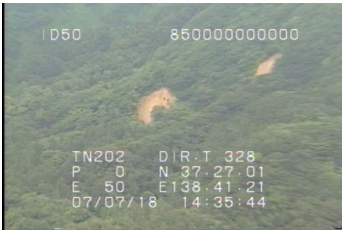
写真 - 物見山周辺の斜面崩壊
