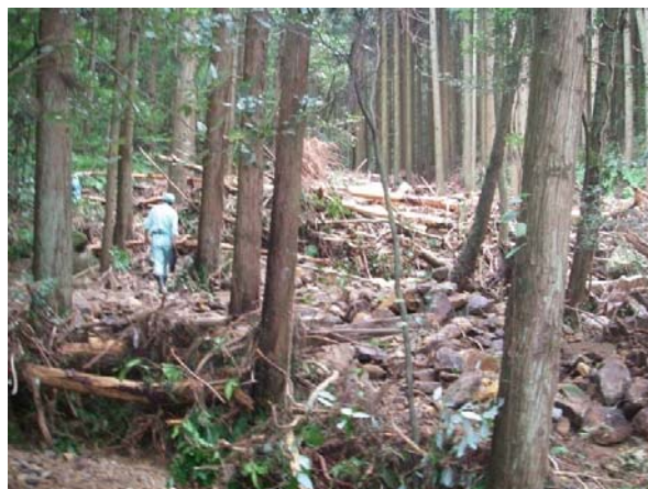
写真－２ 上西川右支溪１の保全人家より 200m上流の不安定堆積土砂
