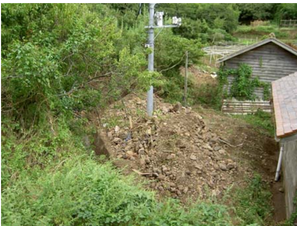
写真－９ 本郷谷川，西ノ谷川の 合流点の土砂堆積
