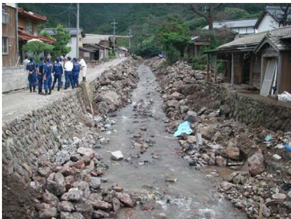
写真－１ 油井川下流の左支合流点付近 (多量の堆積土砂を除去した後)
