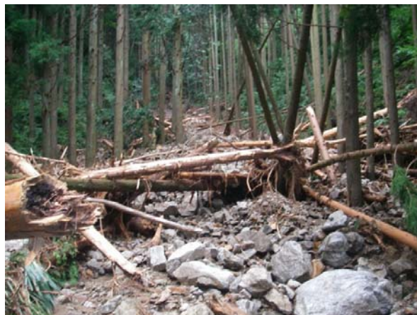
写真－４ 卯敷真谷上流域の堆積土砂と 流木
