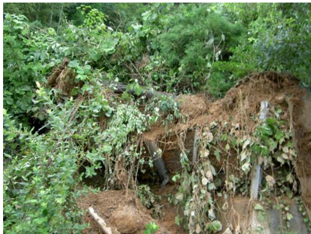
写真－１ 佐崎地区の急傾斜地の崩壊 擁壁工（治山施設）を越えて 土砂が流下
