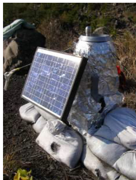
写真1 自動降灰量計の外観
