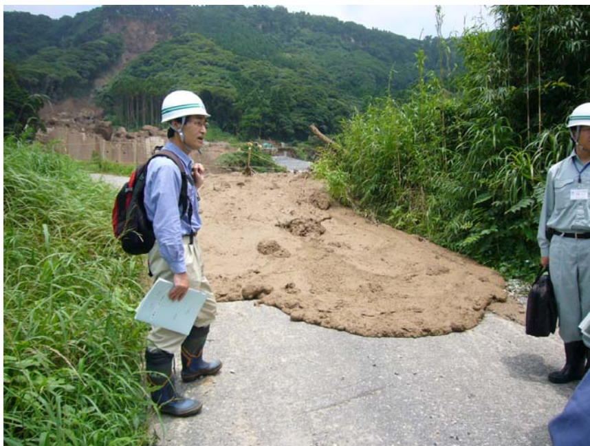
写真－５ １号砂防堰堤右岸から流出した土砂（平成 22 年 7 月 7 日午後撮影）
