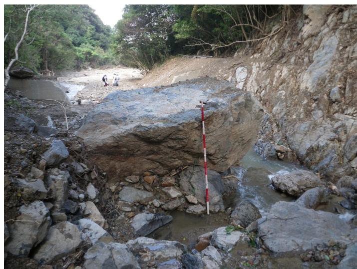
流出した巨礫（床固工上流）
