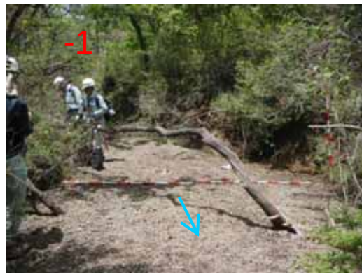
地点の流出土砂の堆積状況
