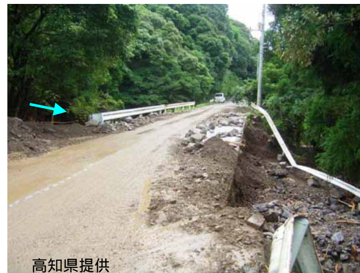
下流の国道493号の状況
