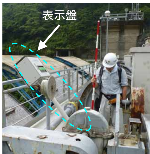
ダム天端上の計器の状況
