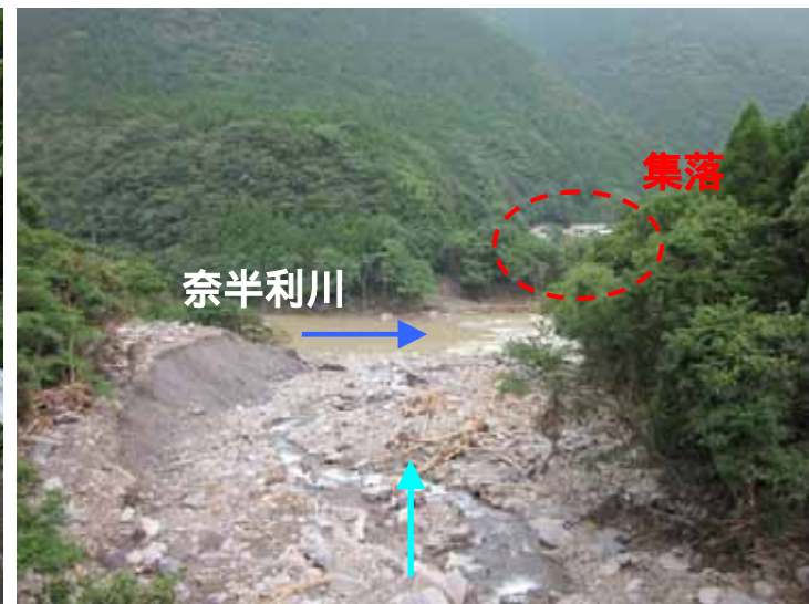
奈半利川との合流点の状況
