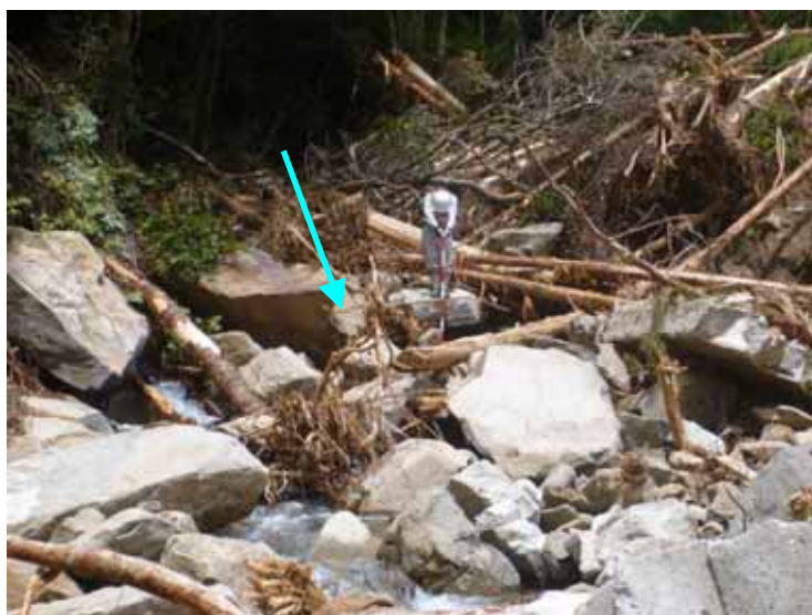
支川との合流点付近の河道の状況
