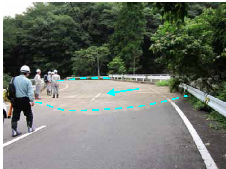
国道493号上で見える土石流の流下痕跡
