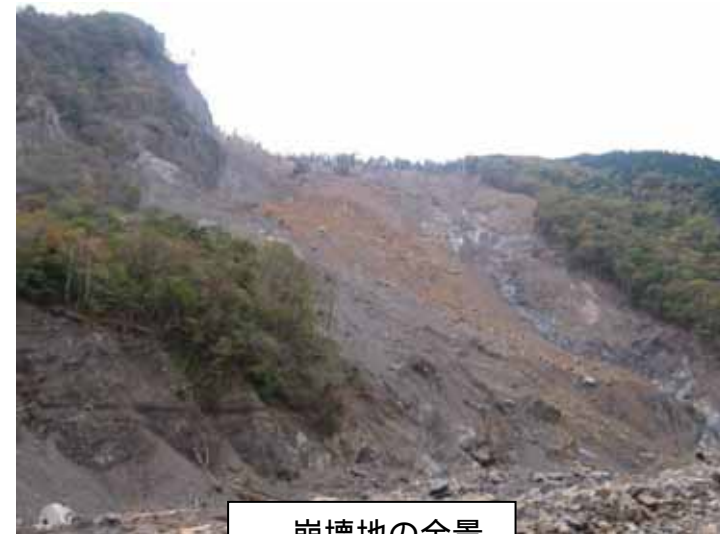
崩壊地の全景
