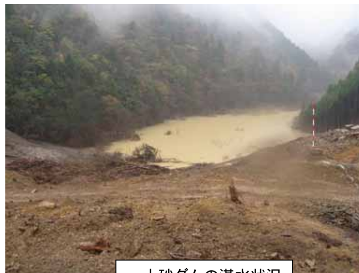
土砂ダムの湛水状況
