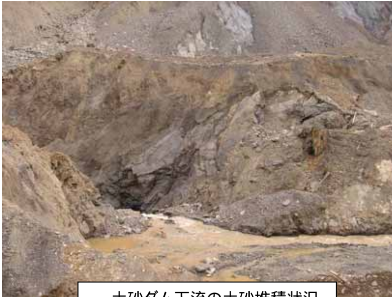
土砂ダム下流の土砂堆積状況
