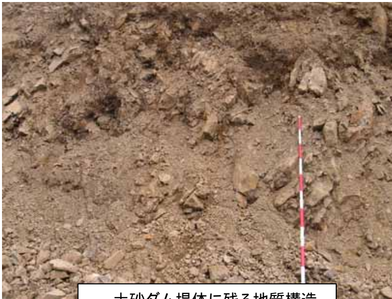
土砂ダム堤体に残る地質構造
