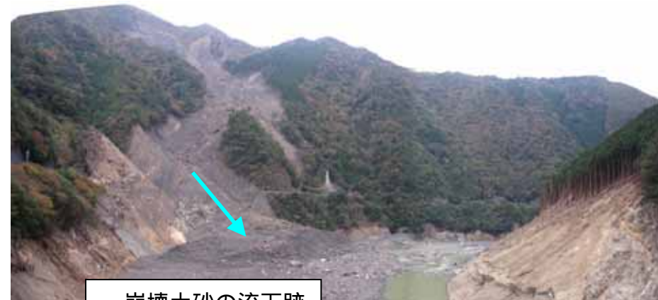
崩壊土砂の流下跡
