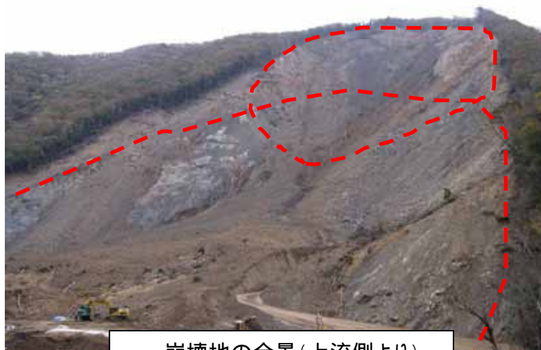
崩壊地の全景(上流側より)
