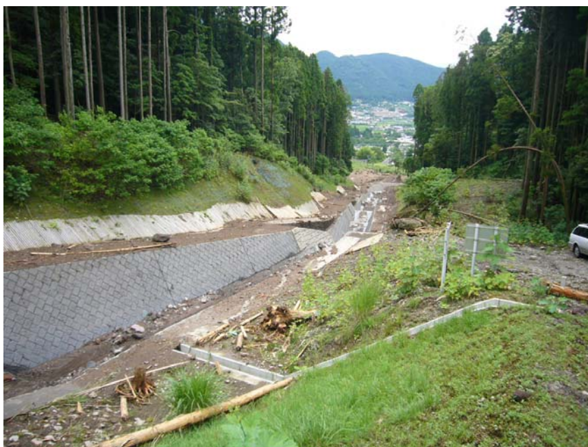
写真 6 2号えん堤下流の溪流保全工。幅約 4m、高さは約 3m 程度。水路勾配は 6\sim 8^\circ 。水路は右岸へ湾曲しており、土石流は湾曲部で左岸側に一部氾濫していた。
