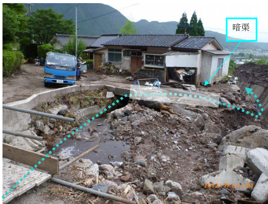
写真 6 2号えん堤下流の溪流保全工。幅約 4m、高さは約 3m 程度。水路勾配は 6\sim 8^\circ 。水路は右岸へ湾曲しており、土石流は湾曲部で左岸側に一部氾濫していた。
