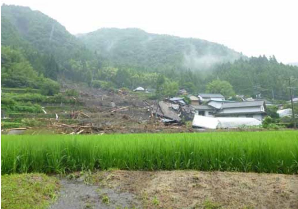
手野①地区の土石流堆積状況。土砂と流木が集落方向へ流出。巨礫は目立たない。
