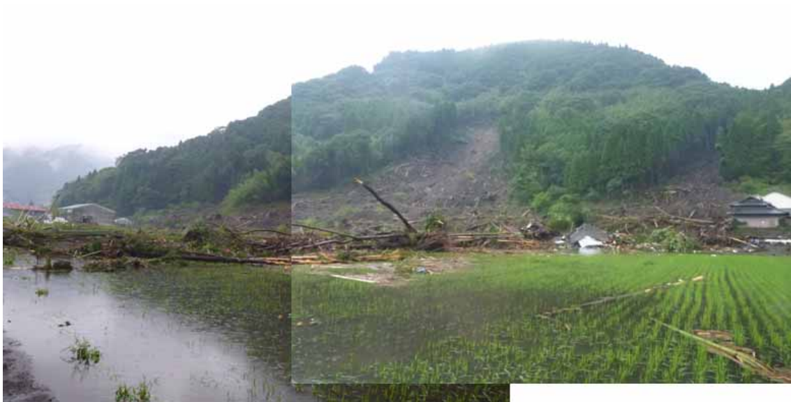
斜面中腹より崩壊が発生。土砂、流木が直線的に下流へ流出、堆積。
