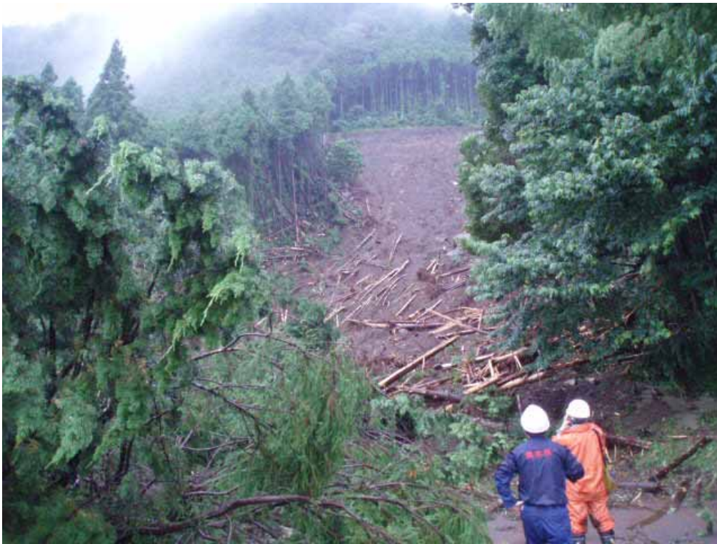
新所地区② 立野地区急傾斜地危険箇所。浅い斜面崩壊が発生し、土砂と流木が流出。高さ 50m 程度。
