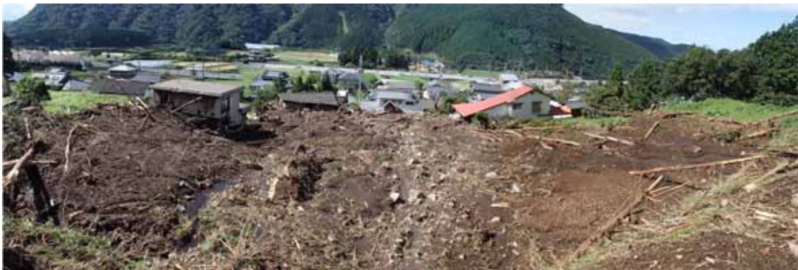
新所地区③ 崩土堆積域の状況（上流から下流を望む）
