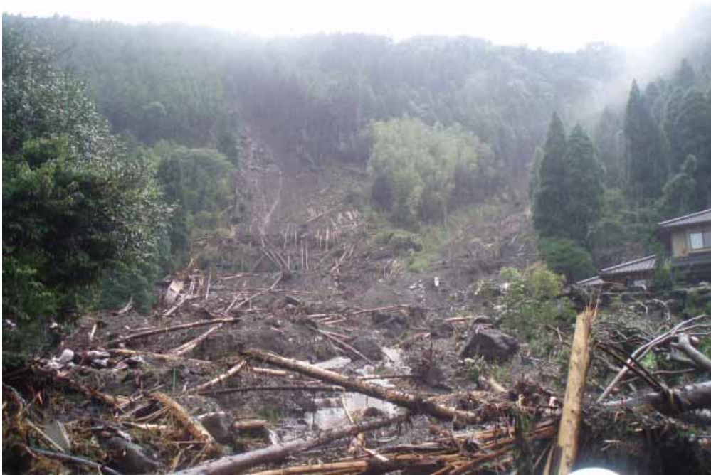
古閑地区斜面崩壊の概観。2 か所の斜面崩壊が発生。
