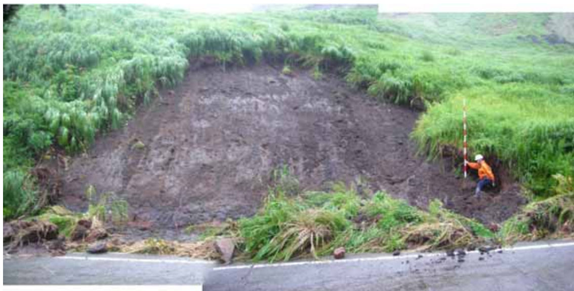
国道 265 沿いの小さな表層崩壊(全景)。
