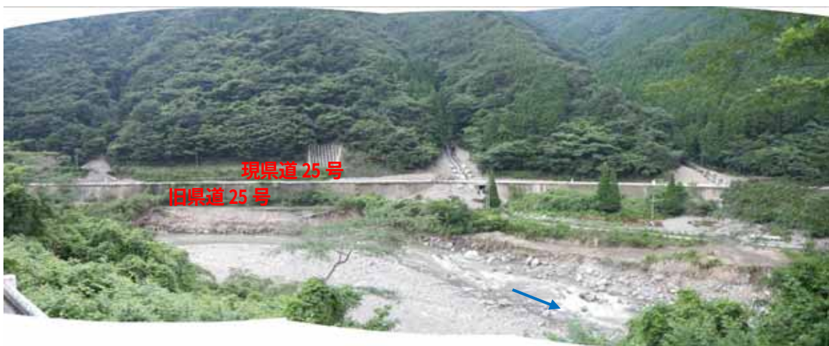
現県道 25 号下部、旧県道 25 号の侵食決壊部
