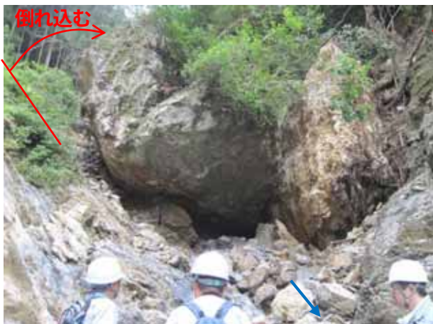
巨岩下流側から見る
