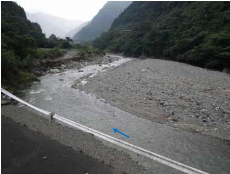
右岸側寄り洲の状況
