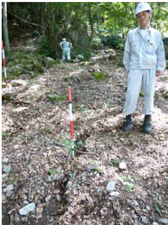
複数の引張り亀裂
