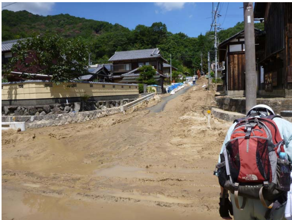
写真7 道路に氾濫した土砂の状況
