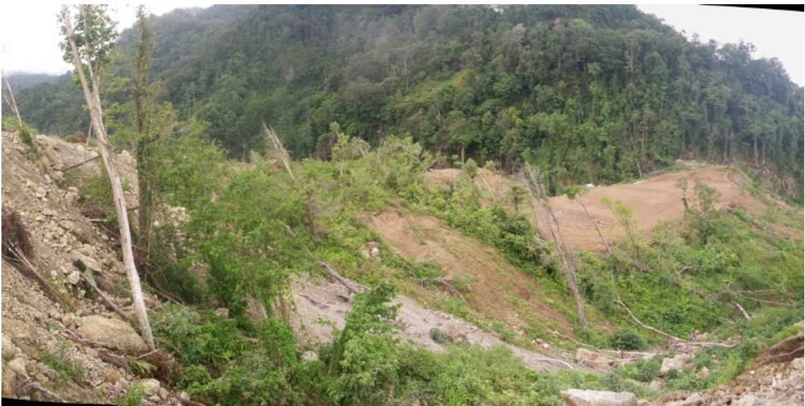
ワイエラ川に形成された天然ダム堤体を右岸下流側から撮影
